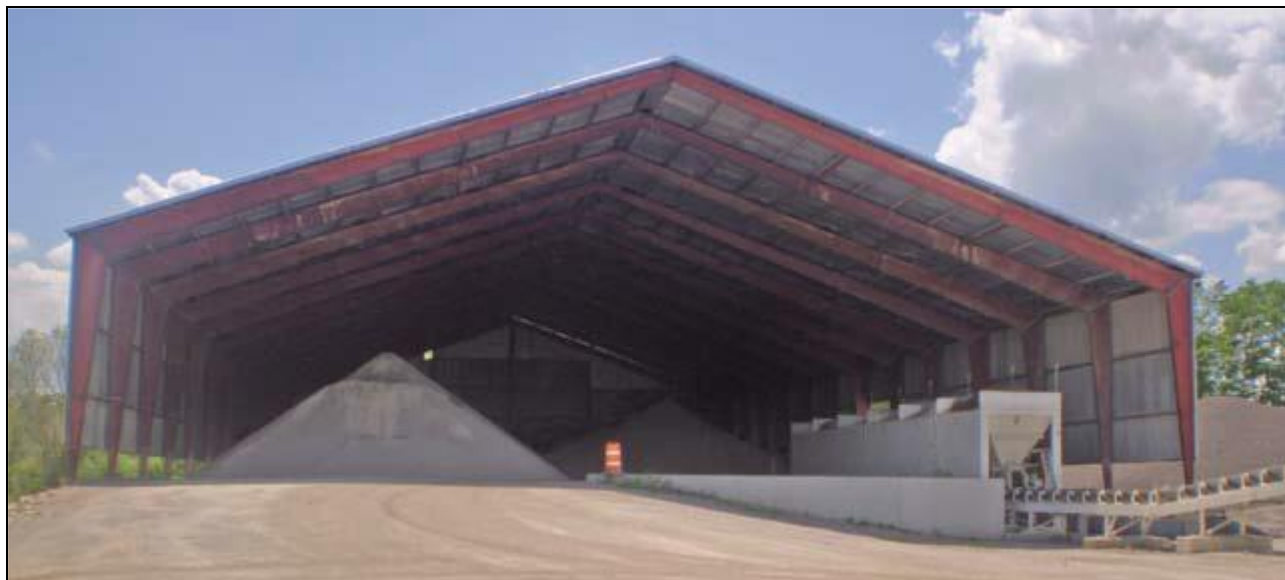
Figura 2 - Exemplo de depósito de agregados coberto (NAPA, 2012)
