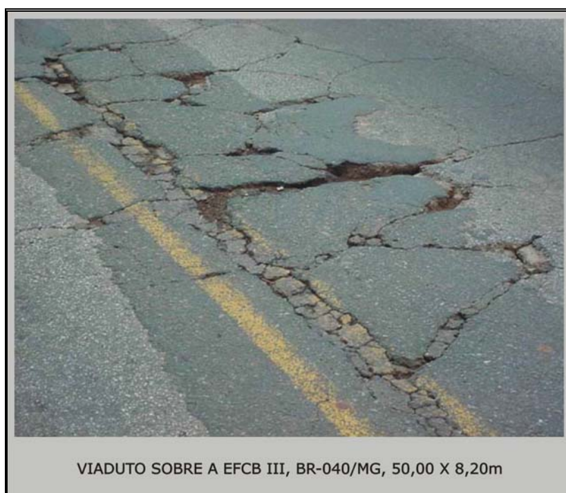
Foto 2 – Manutenção inadequada exigindo recuperação e/ou substituição
