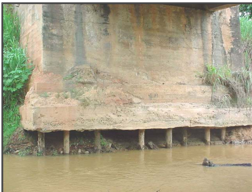
Foto 46 – Fundação em estacas expostas, de pequeno diâmetro
