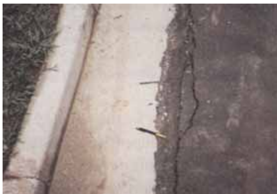
Foto separação entre pista e acostamento
