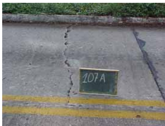
Fissuras Transversais
