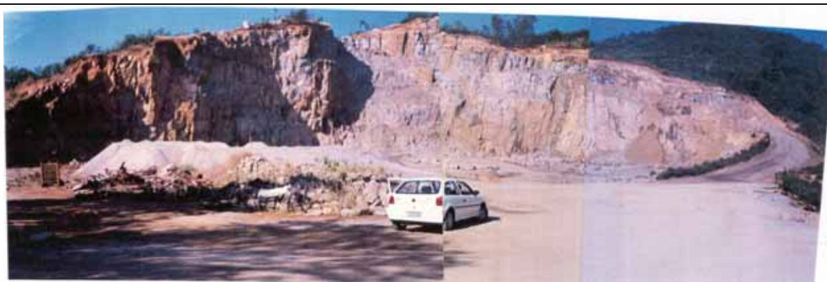
Pedreira em exploração, sem processo de recuperação instalado.
