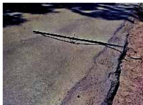
Foto do afundamento por consolidação nas trilhas de roda
