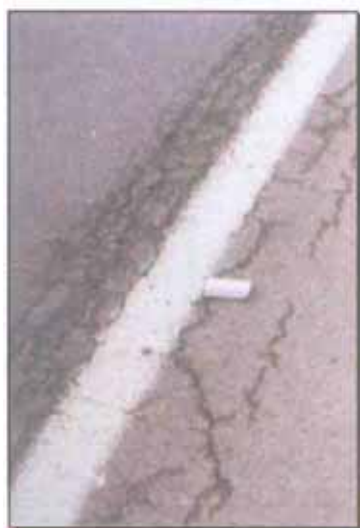
Foto Trinca de Bordo
