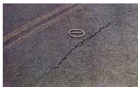
Foto de trincamento longitudinal
