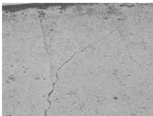
Fissuras Diagonais
