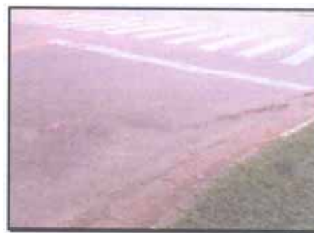
Foto Afundamento Plástico
