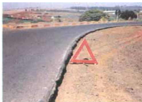
Foto desnível entre pista e acostamento
