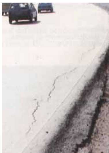
Foto Trinca de Bordo
