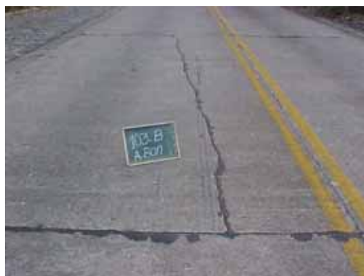
Fissuras Longitudinais
