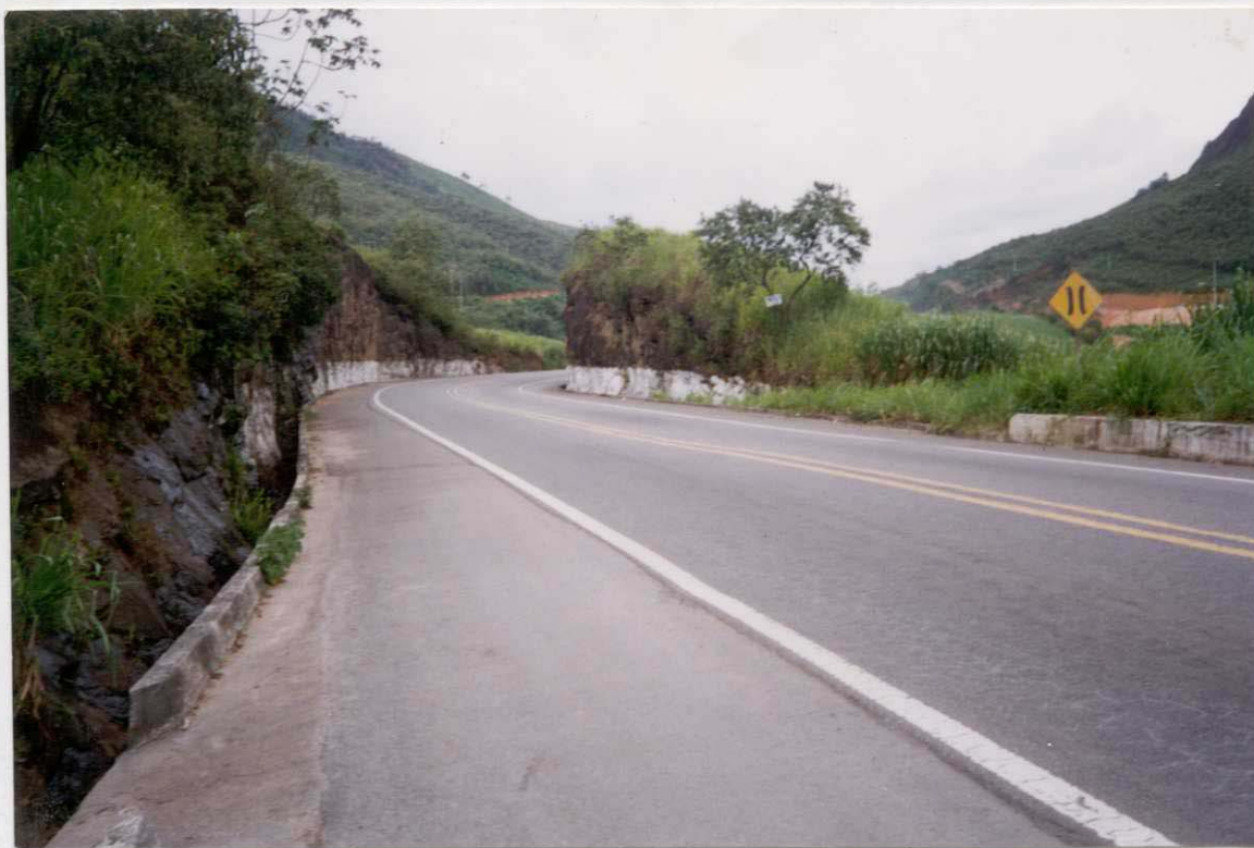
FOTO 2 VISTA GERAL DA CURVA QUE ANTECEDE O VIADUTO MONTE SECO (SENTIDO ES - BA). O CORTE (LD) NÃO PERMITE VER O VIADUTO.
