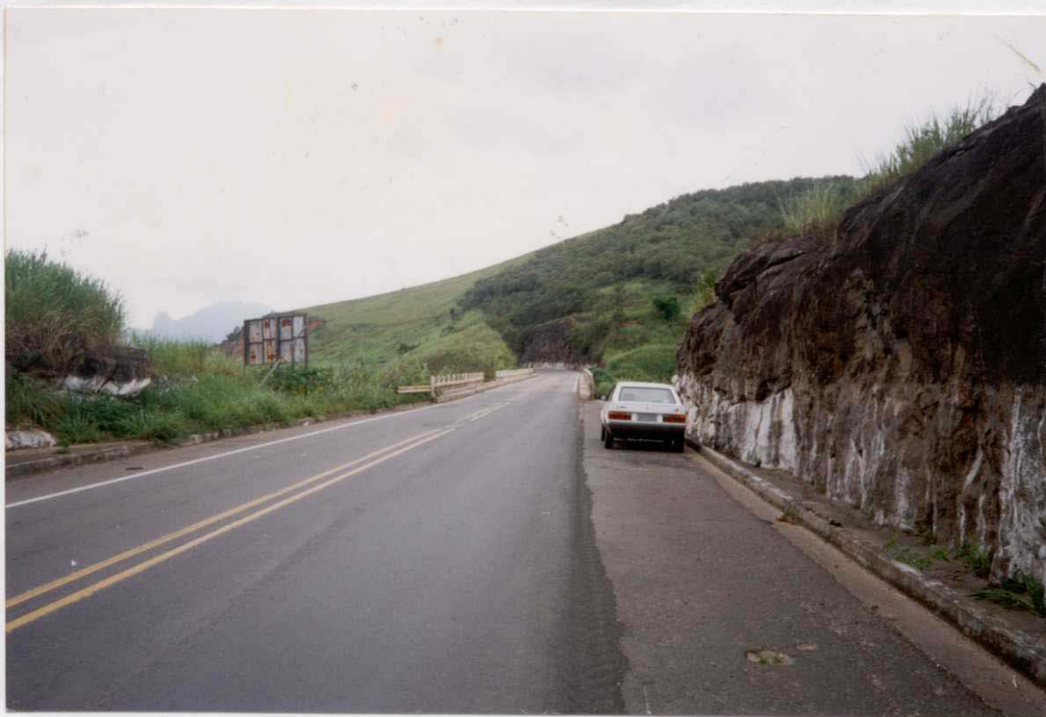
FOTO 1 VISTA GERAL DO VIADUTO MONTE SECO, SENTIDO BA - ES.
