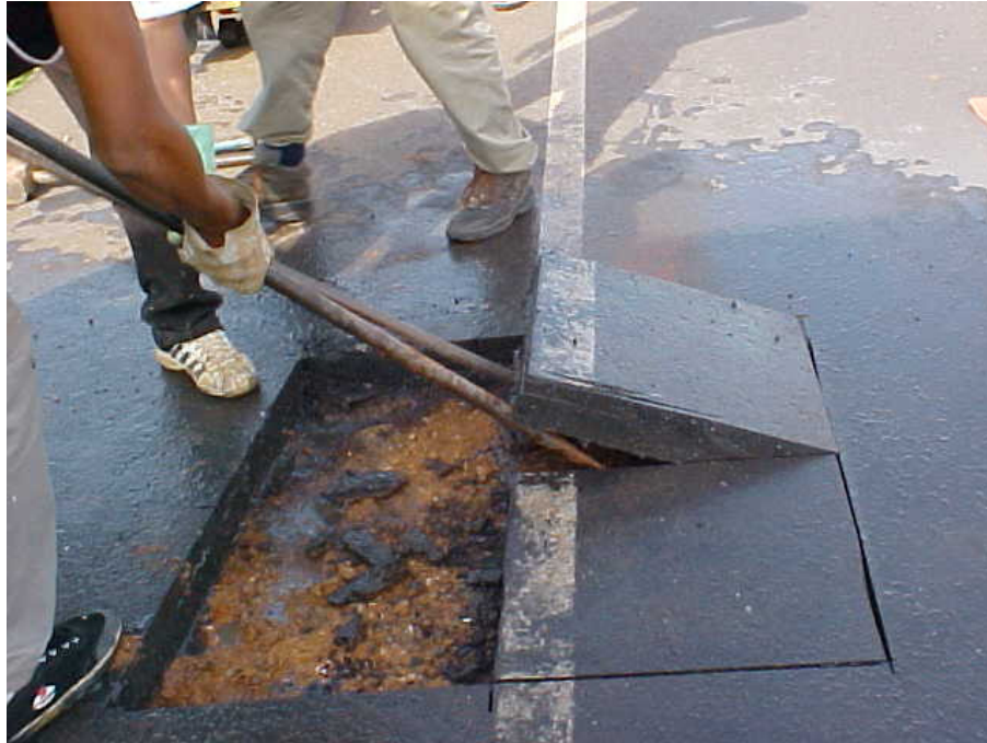
ABERTURA DE POÇO DE SONDAGEM
