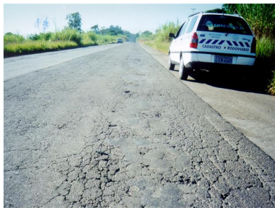
CONDIÇÃO REAL DE PAVIMENTO DE TRECHO DO SGP, SEM CONDIÇÕES DE ATENDIMENTO AOS CRITÉRIOS PARA IMPLANTAÇÃO DE TRECHO-TESTE.
