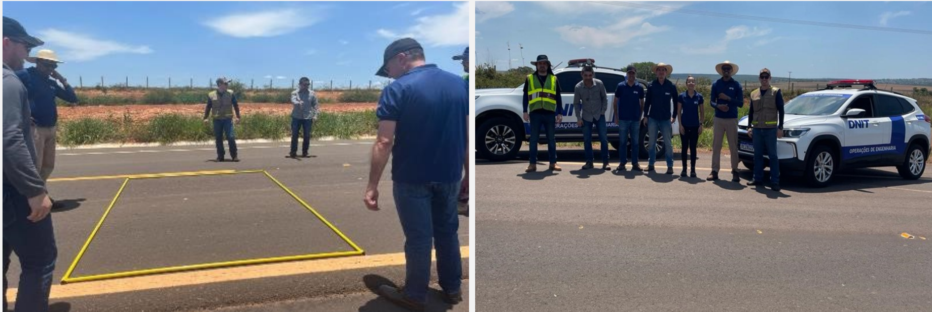
Figura 13: Levantamento de área trincada na BR-419/MS.
