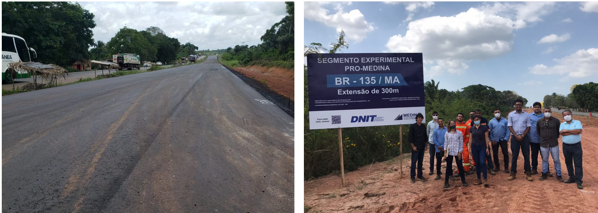
Figura 19: trecho da BR-135/MA com a obra concluída e em fase de monitoramento.
