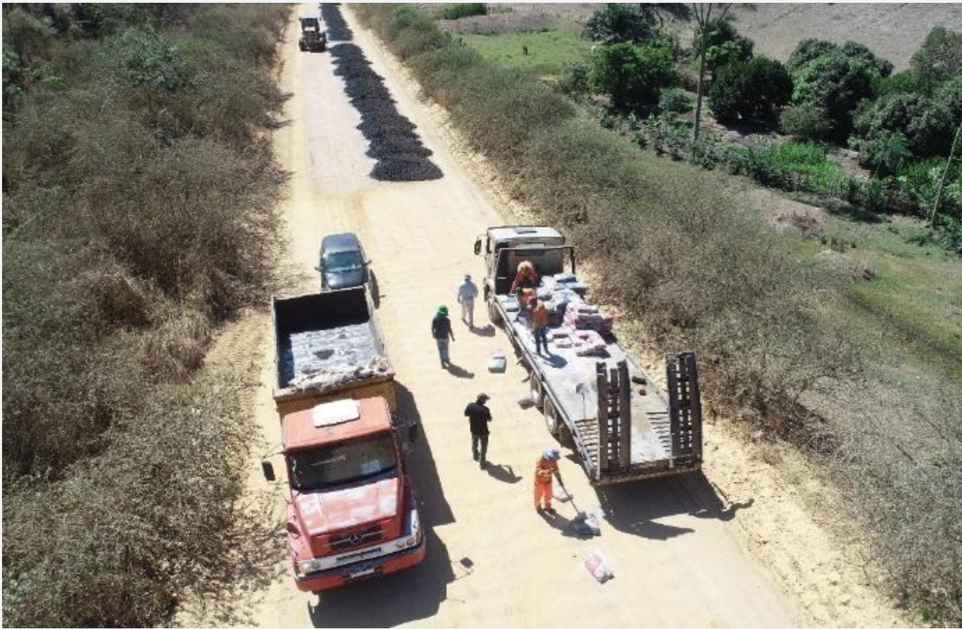
Figura 9: vista aérea de trecho experimental.
