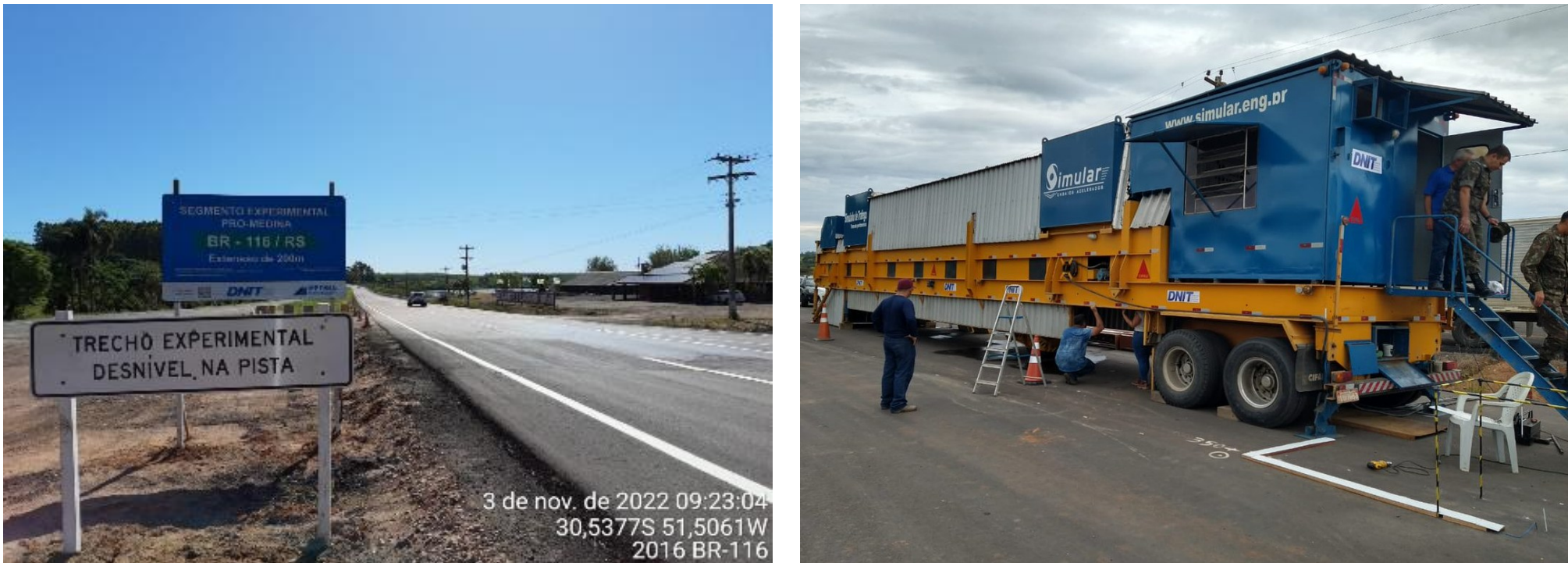
Figura 25: placa do Trecho 1 e Simulador de Tráfego na BR-116/RS.
