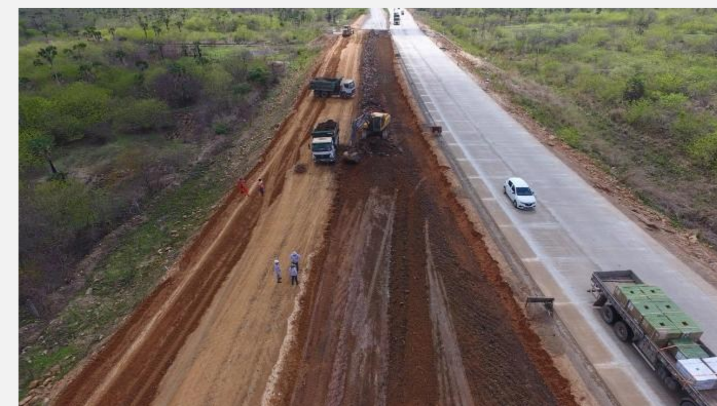
Figura 4: vista aérea de trecho experimental.
