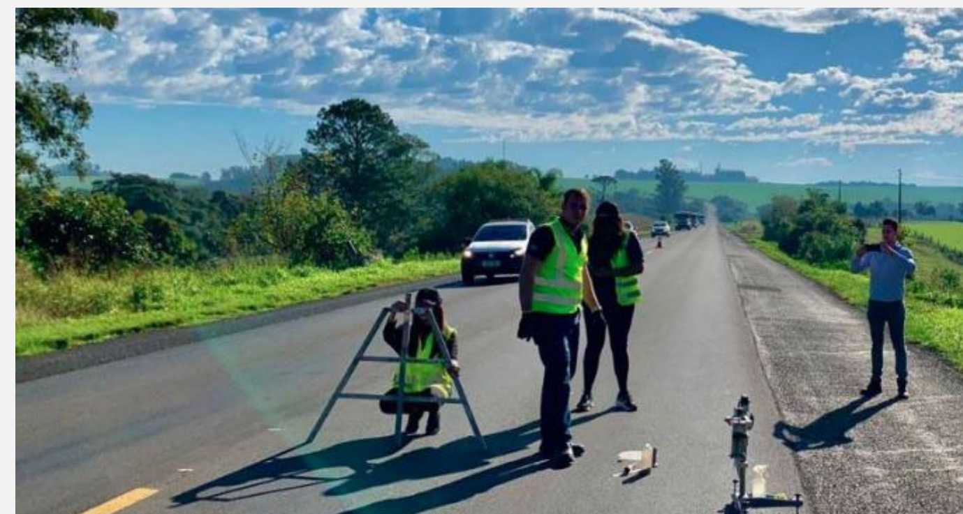
Figura 8: Levantamentos de ATR com treliça metálica.
