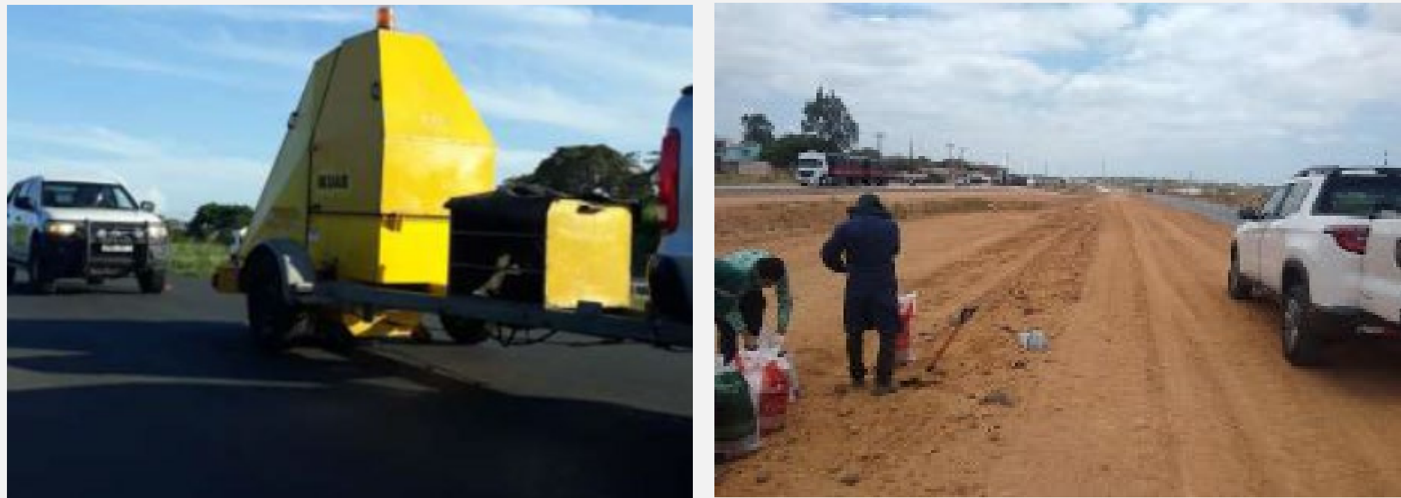
Figura 18: Ensaios no tempo zero na BR-020/CE (4º Anel Viário) e coleta de materiais.
