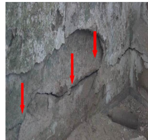
Foto 3. Rachaduras na base estrutural de um prédio lateral a obra
