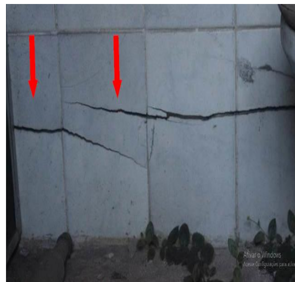
Foto 2. Rachaduras na base estrutural de um prédio lateral a obra
