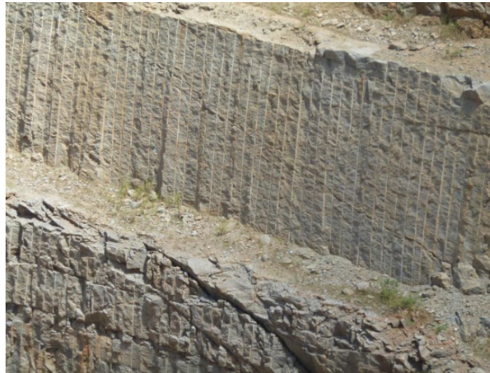
Figura 6 - Pré-fissuramento de material de 3ª categoria
