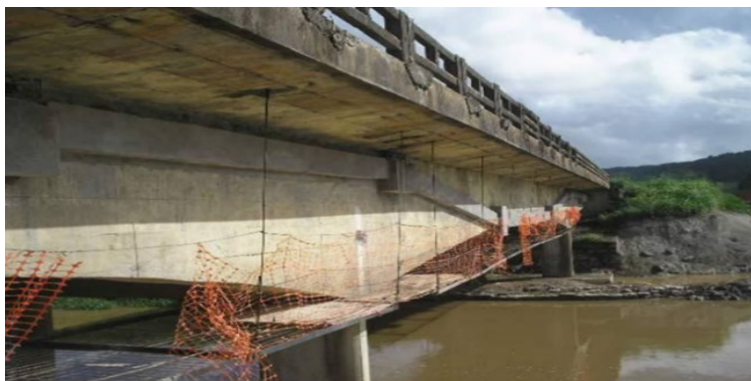
Figura 6 - Cobertura de concreto após protensão
