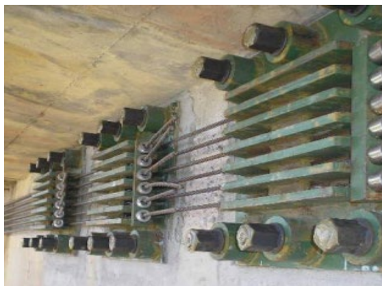
(a) Placa de apoio para ancoragem
