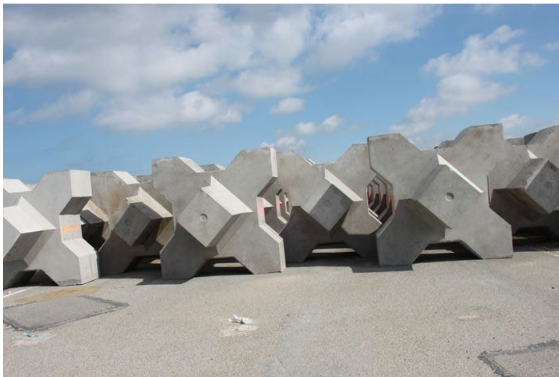
Figura 6 - Xblocks utilizados na carapaça de molhe
