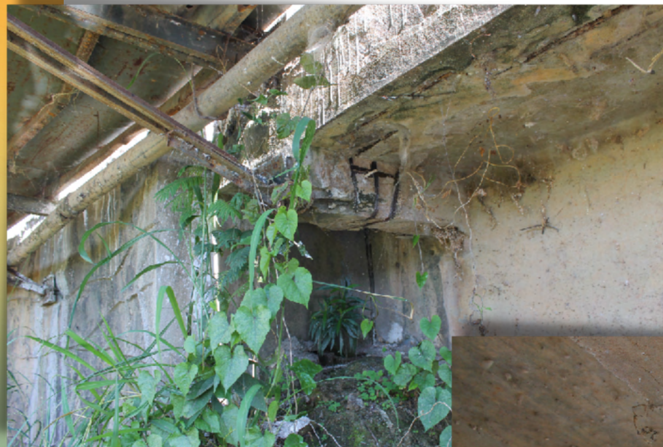
Vista Inferior Patologia: Armadura exposta e corroída
