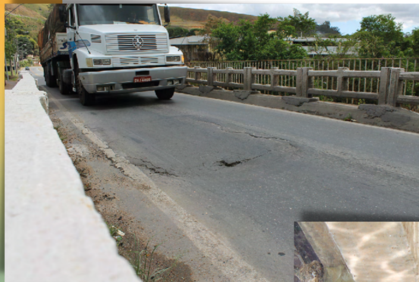
Vista Superior Patologia: Laje Rompida
