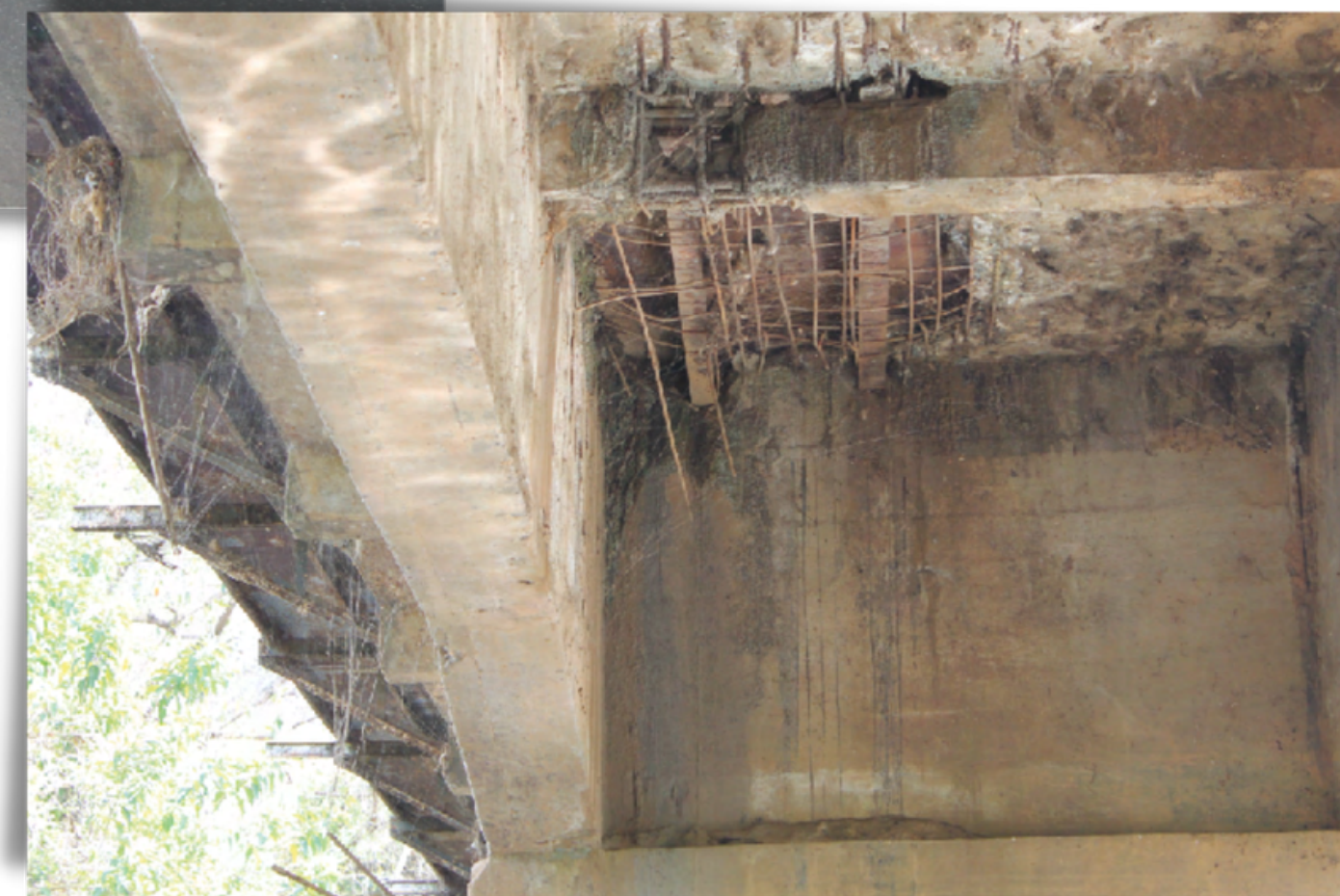
Vista Inferior Patologia: Laje Rompida
