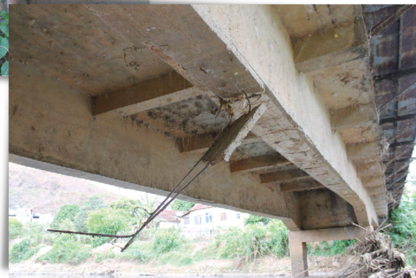
Vista Inferior Patologia: Armadura exposta e corroída
