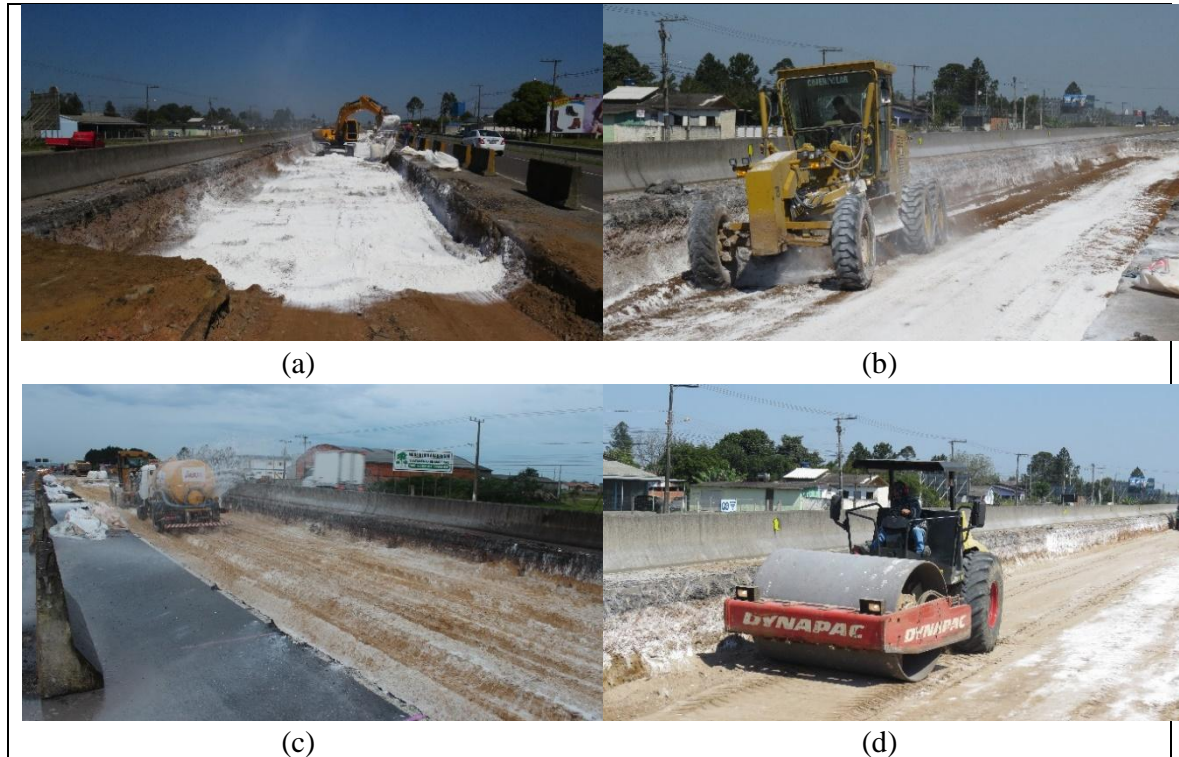
Figura 8 – Reforço do subleito com cal
