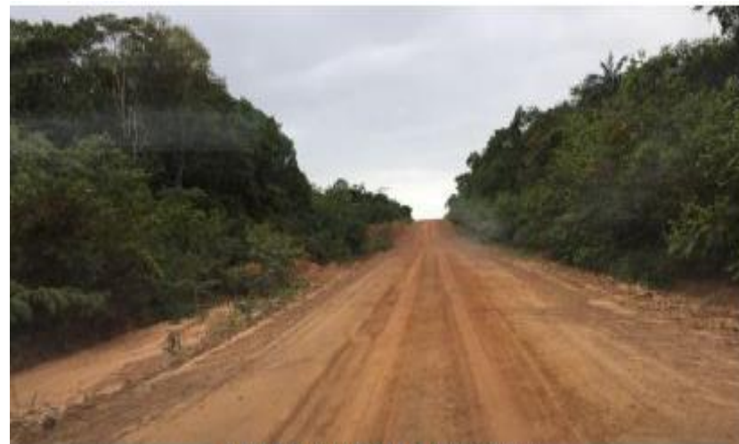
Figura 9: Rodovia com bota-dentro Fonte: Elaboração Própria - Consórcio PROSUL/APPE, 2016
