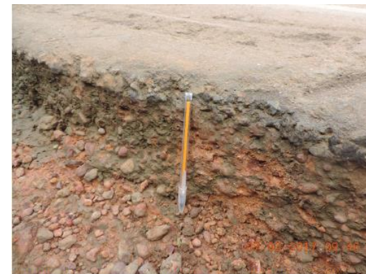
Figura 20. Base do pavimento constituída em cascalho laterítico - km 14+850 (Coordenadas: 12°43'33.93"S; 60° 7'42.79"O). Fonte: Elaboração própria.
