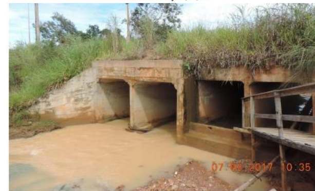
Figura 5. Duas estruturas de Bueiro Duplo Celular de Concreto - km 17+060. (Coordenadas: 12°42'26.58"S; 60° 7'20.79"O) Fonte: Elaboração própria.
