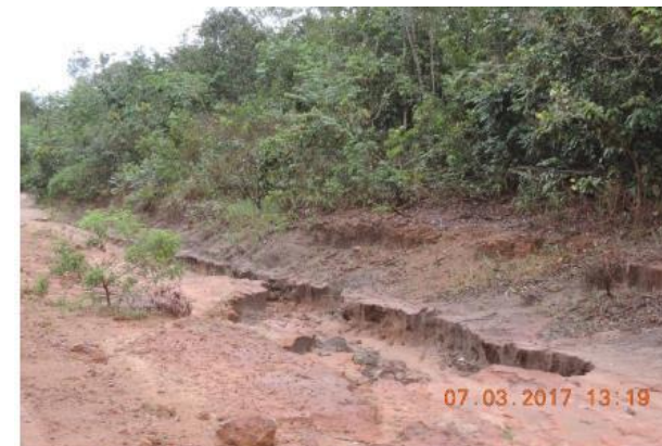
Figura 26. Erosão superficial em solo silto-arenoso LD, km - 75+800 (Coordenadas: 12°19'1.96"S; 59°49'39.71"O) Fonte: Elaboração própria.
