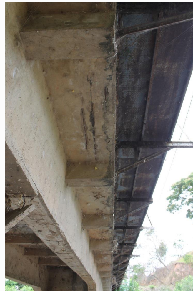
Foto da estrutura existente - sob tabuleiro
