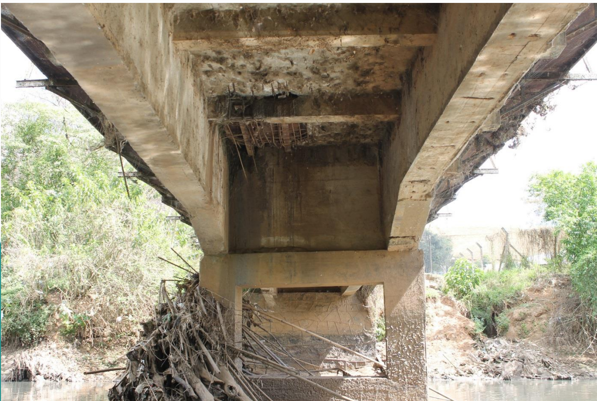
Foto da estrutura existente – sob o tabuleiro
