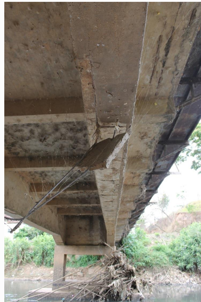
Foto da estrutura existente - sob tabuleiro
