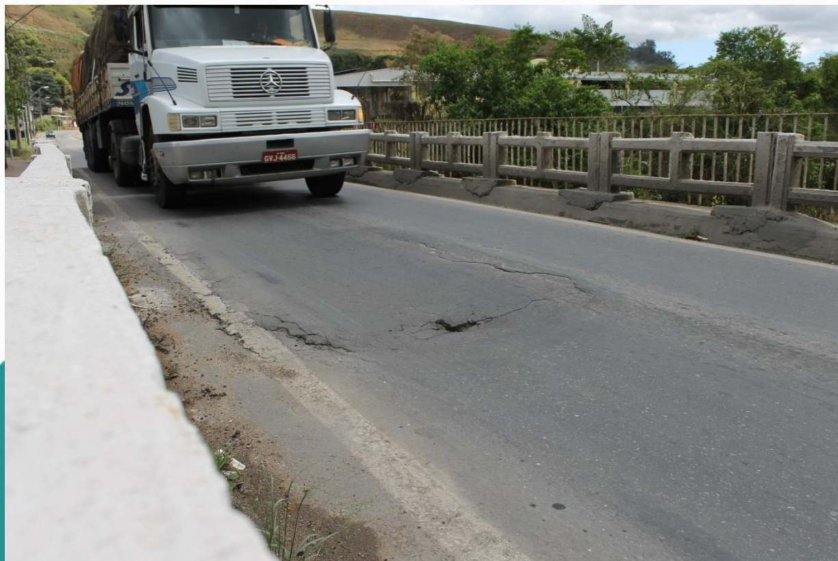
Foto da estrutura existente - tabuleiro
