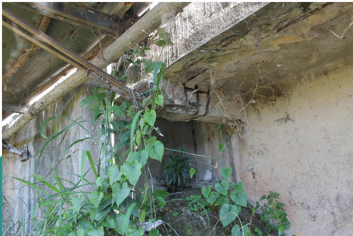
Foto da estrutura existente – sob o tabuleiro
