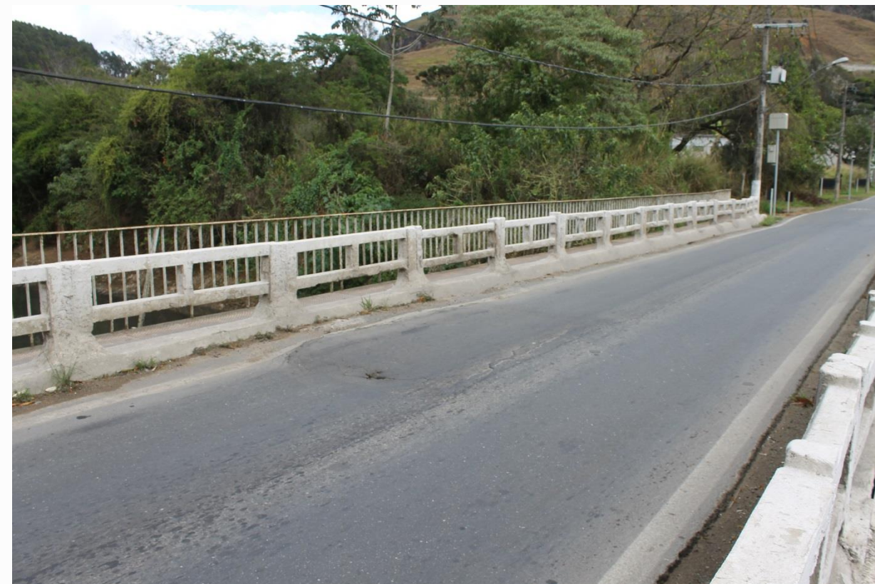
Foto da estrutura existente - tabuleiro
