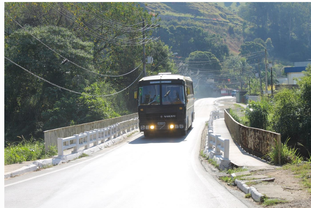
Foto da estrutura existente
