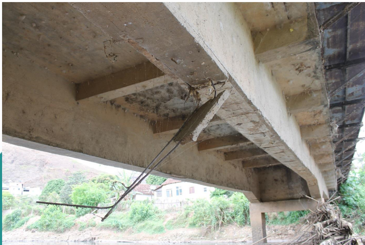
Foto da estrutura existente – sob o tabuleiro
