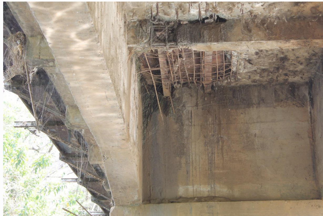
Foto da estrutura existente - sob tabuleiro
