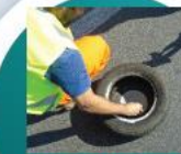
Medição de Macrotextura
