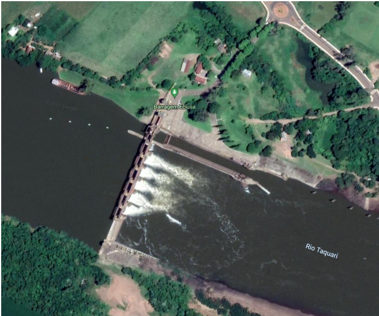
Figura 1: Visão aérea da Barragem Eclusada de Bom Retiro do Sul, no município de Bom Retiro do Sul-RS
