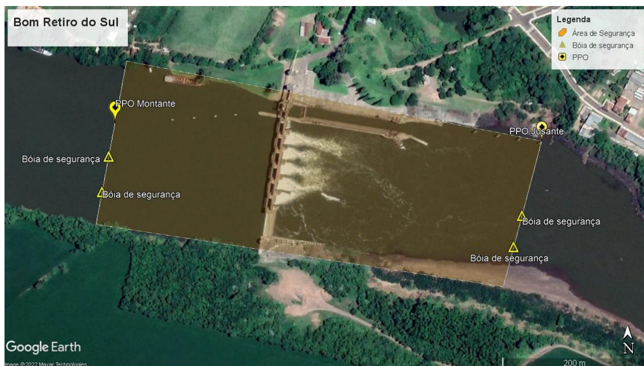
Figura 2: Visão aérea da área de segurança da Barragem Eclusada de Bom Retiro do Sul
