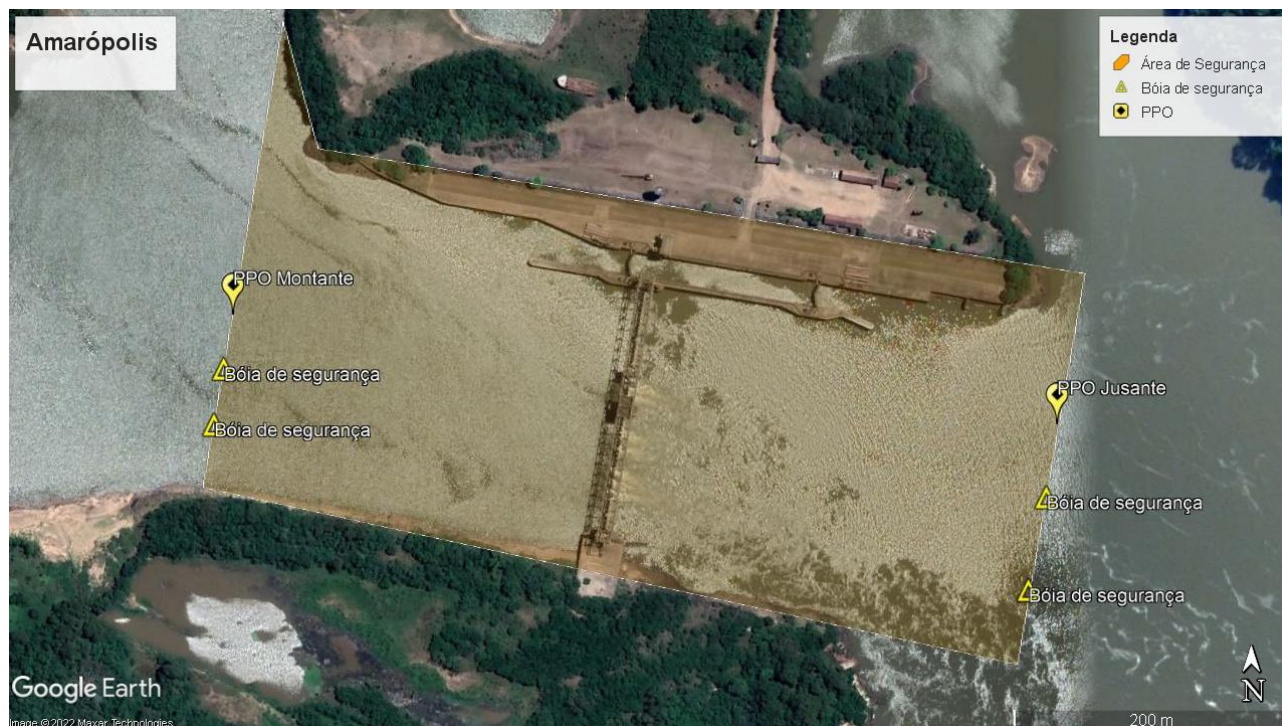
Figura 2: Visão aérea da área de segurança da Barragem Eclusada de Amarópolis
