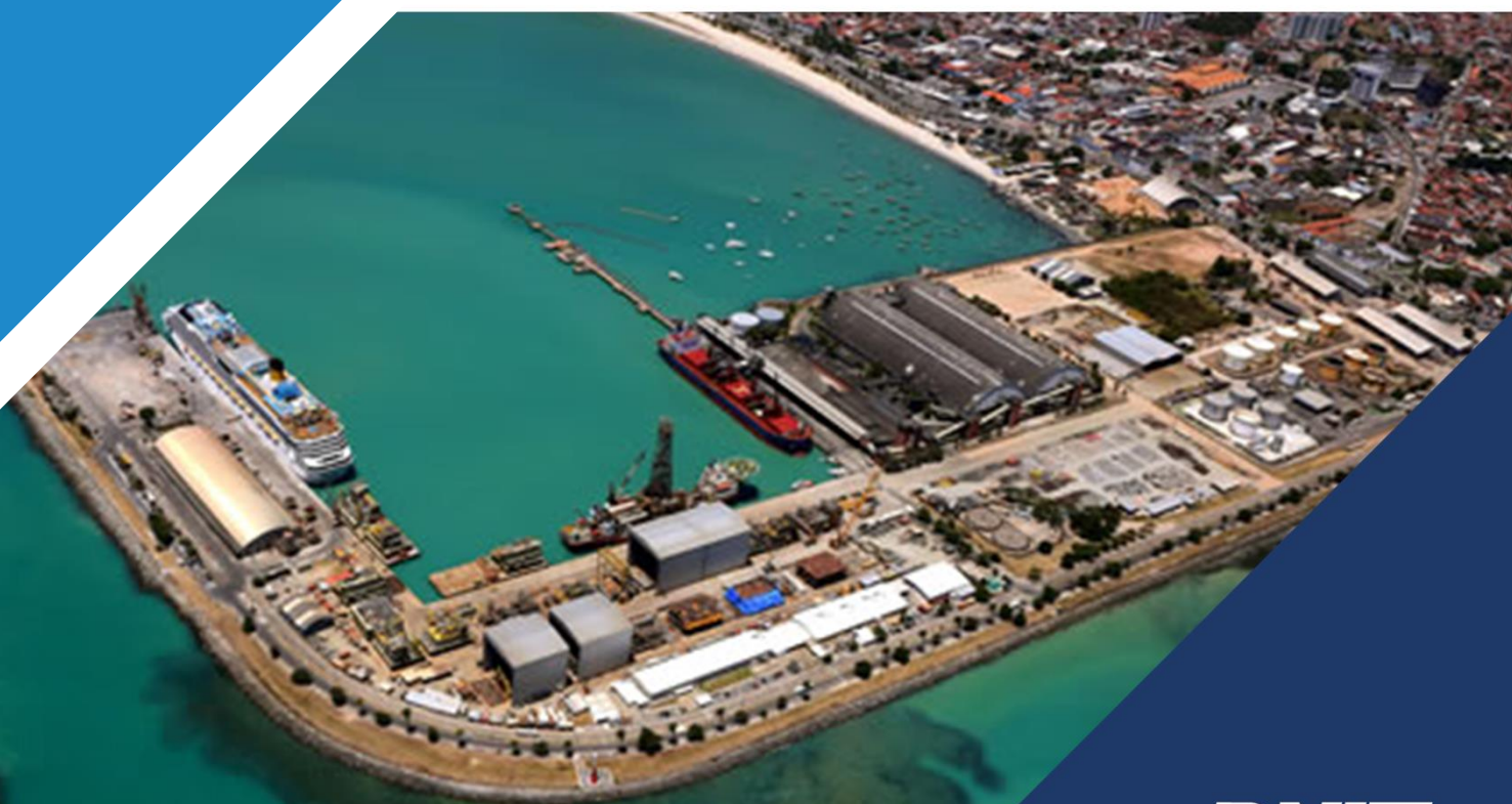
Terminal de Passageiros do Porto de Maceió/AL
