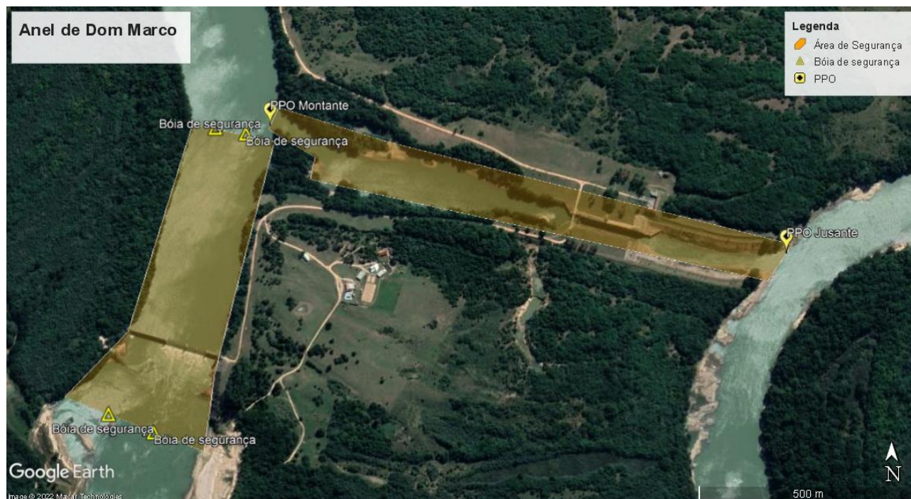
Figura 2: Visão aérea da área de segurança da Barragem e Eclusa do Anel de Dom Marco
