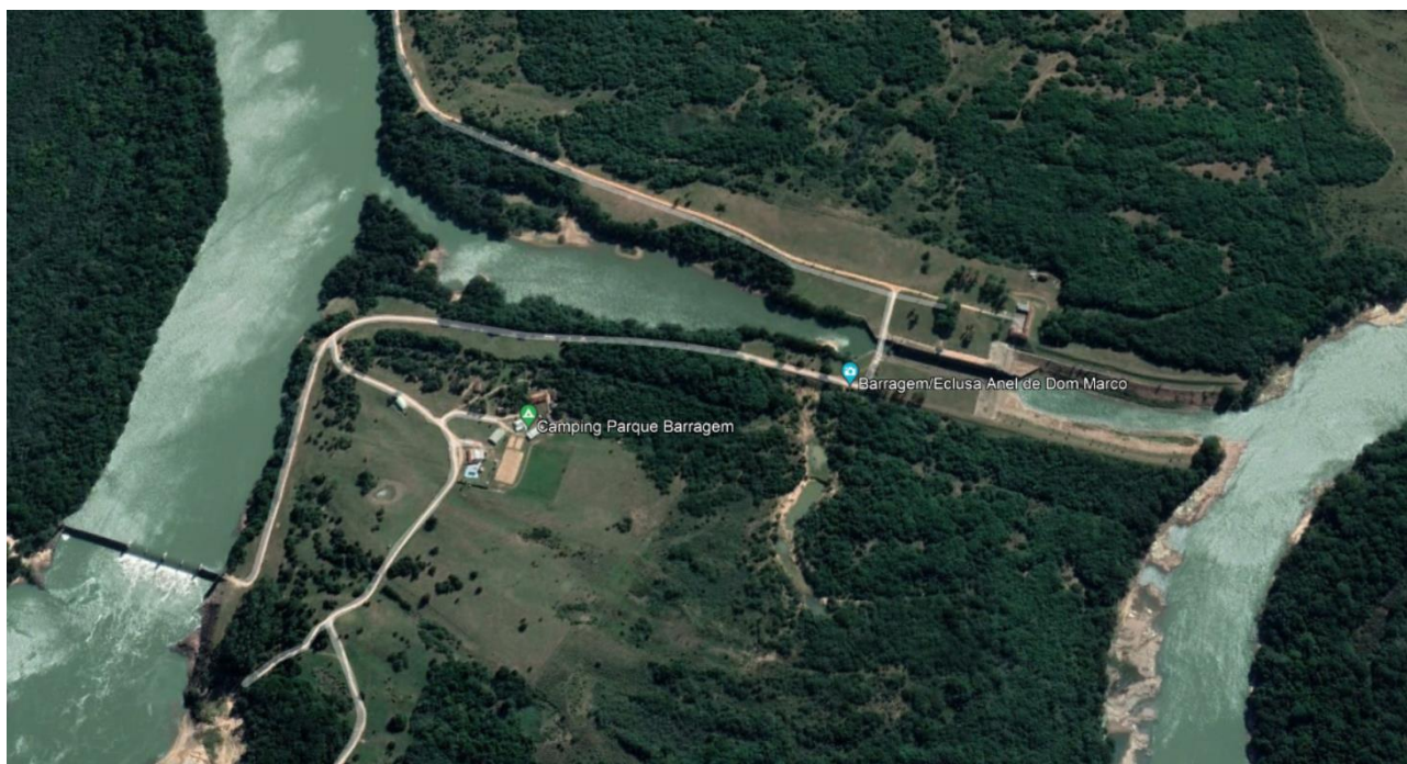
Figura 1: Visão aérea da Barragem e Eclusa do Anel de Dom Marco, no município de Rio Pardo – RS
