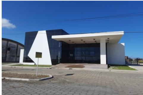
Vista frontal do Terminal de Passageiros do Porto de Maceió
