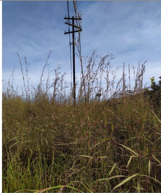
Foto 17 - Poste de Trilho - TR25 - 8 metros.
