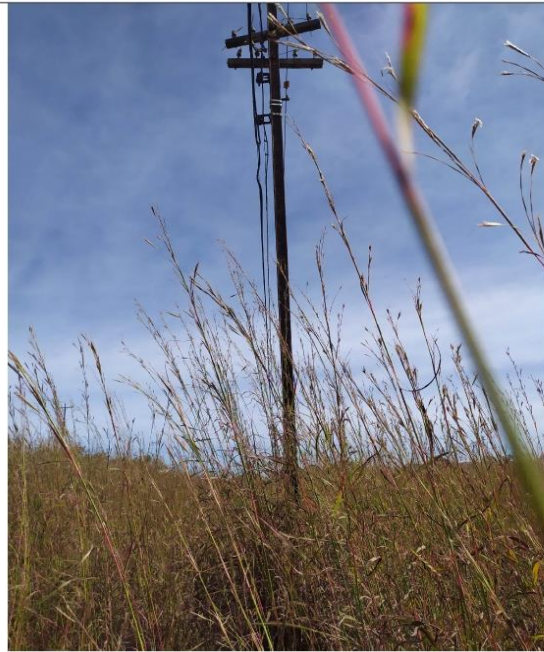
Foto 21 - Poste de Trilho - TR25 - 8 metros.
