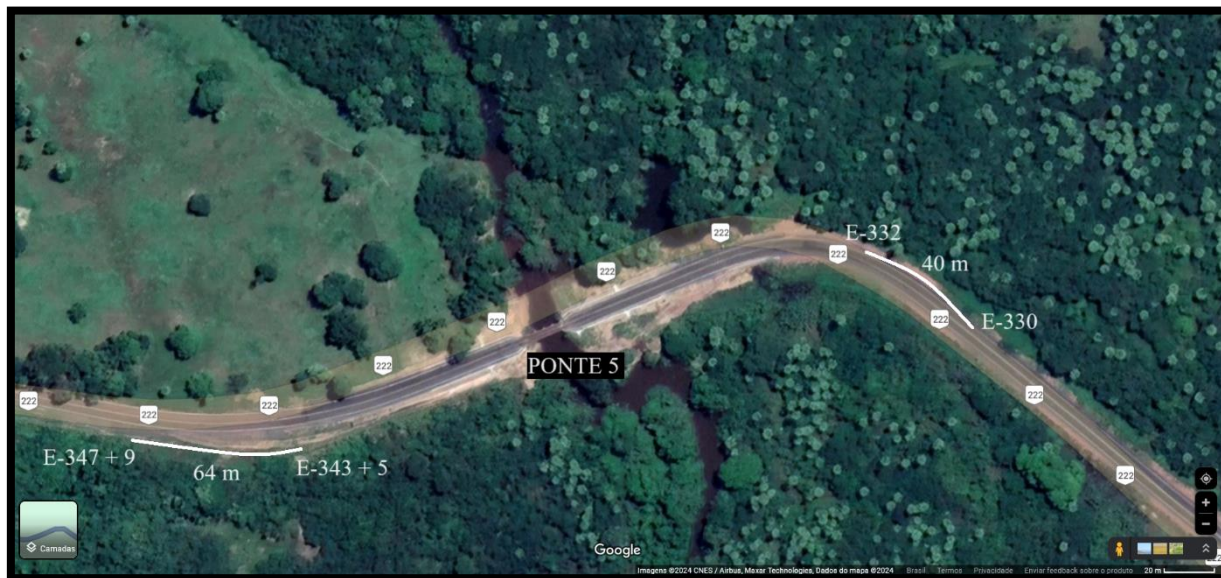
Figura 2. Prolongamento das defensas na ponte 5.
