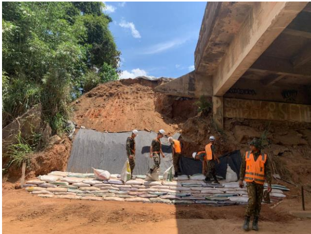
FOTO 01 – Contensão em “rip rap” executada pelo Exército para recuperação da cabeceira da ponte;
