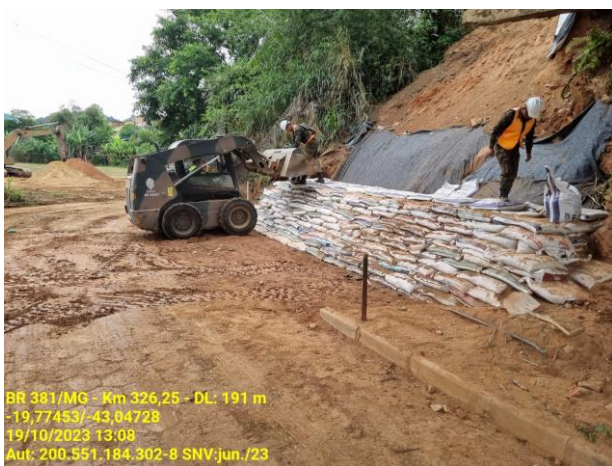
FOTO 03 - Contensão em “rip rap” executada pelo Exército para recuperação da cabeceira da ponte.
