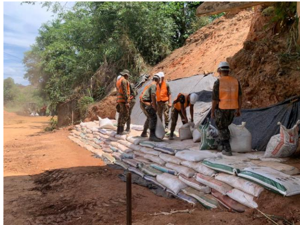
FOTO 02 – Contensão em “rip rap” executada pelo Exército para recuperação da cabeceira da ponte;
