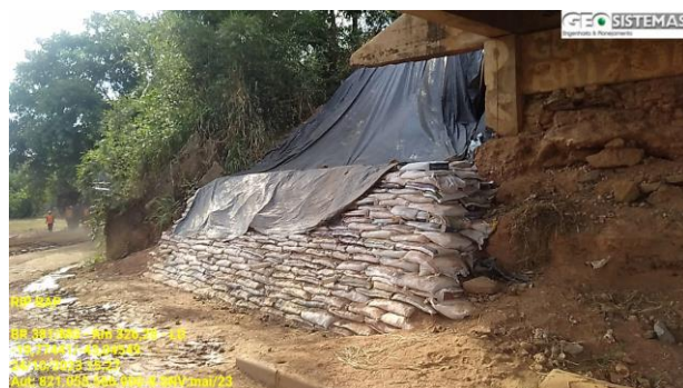
FOTO 04 - Contensão em “rip rap” executada pelo Exército para recuperação da cabeceira da ponte.
