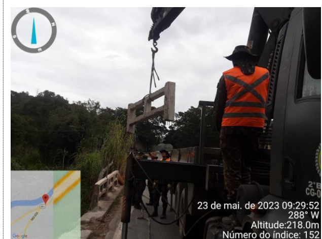
FOTO 11 – Recomposição e substituição de guarda-corpo;
