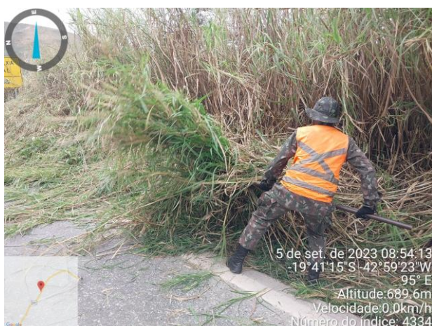
FOTO 17 – Limpeza de sarjeta;
