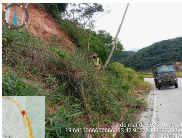
FOTO 35 – Remoção de árvore de grande porte;
