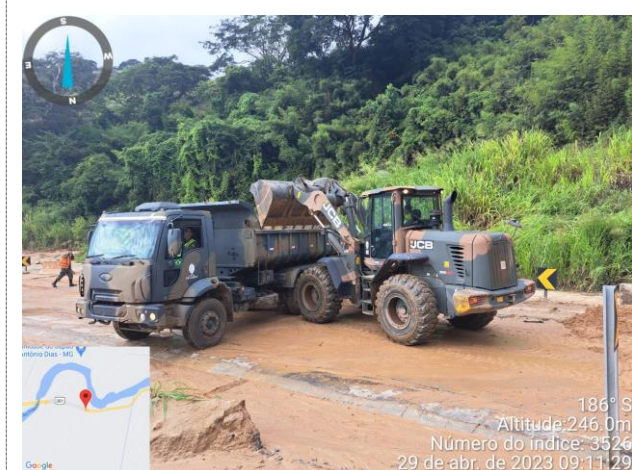
FOTO 41 – Remoção de barreira;
