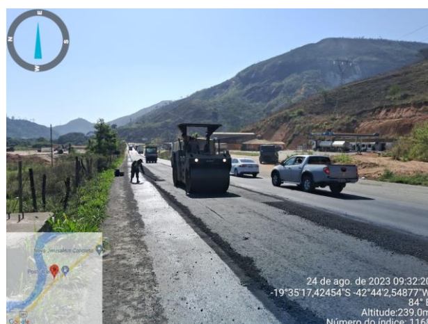
FOTO 04 – Aplicação de massa asfáltica, revitalização do pavimento;
