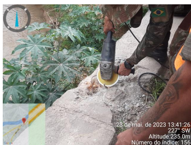
FOTO 12 – Recomposição e substituição de guarda-corpo;
