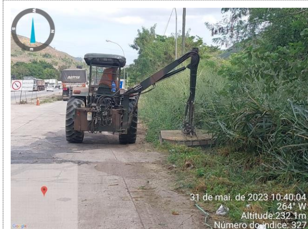
FOTO 09 – Roçada mecanizada;
