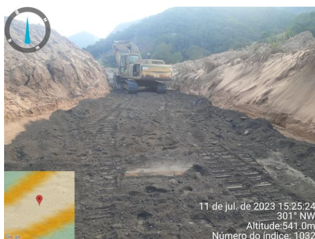
FOTO 21 – Manutenção de desvio de obra;
