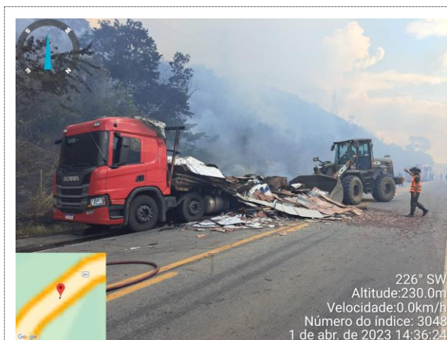
FOTO 37 – Remoção de carga e limpeza da pista;
