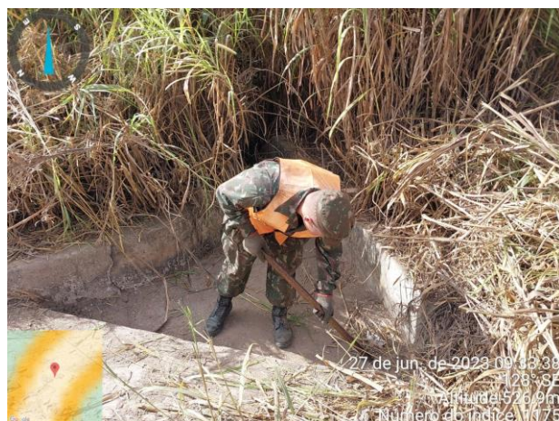
FOTO 16 – Limpeza de descida d'água;
