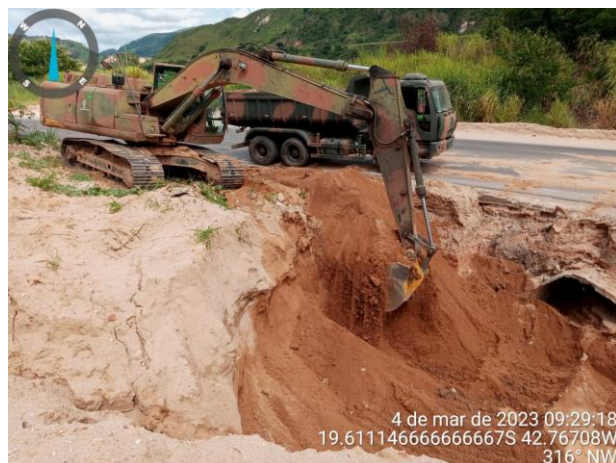
FOTO 14 – Desobstrução e limpeza de bueiros;
