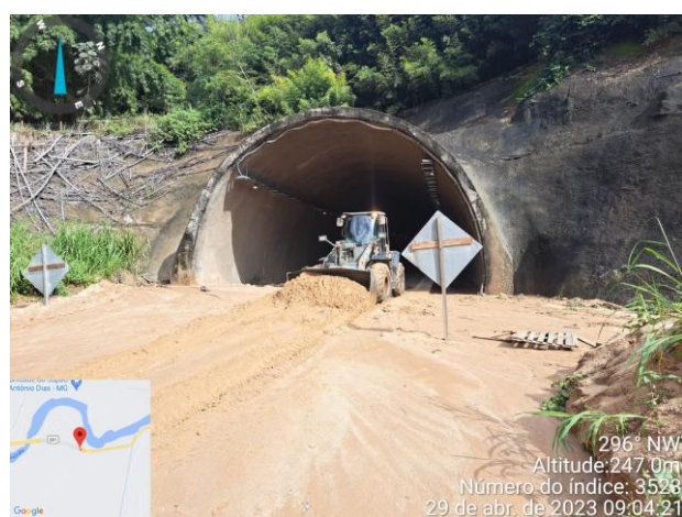
FOTO 40 – Remoção de barreira;
