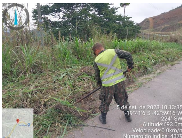
FOTO 18 – Limpeza de sarjeta;
