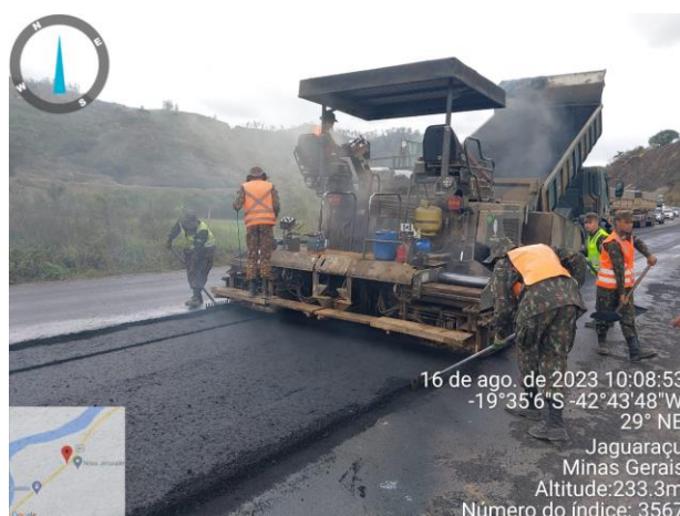
FOTO 03 – Aplicação de massa asfáltica, revitalização do pavimento;
