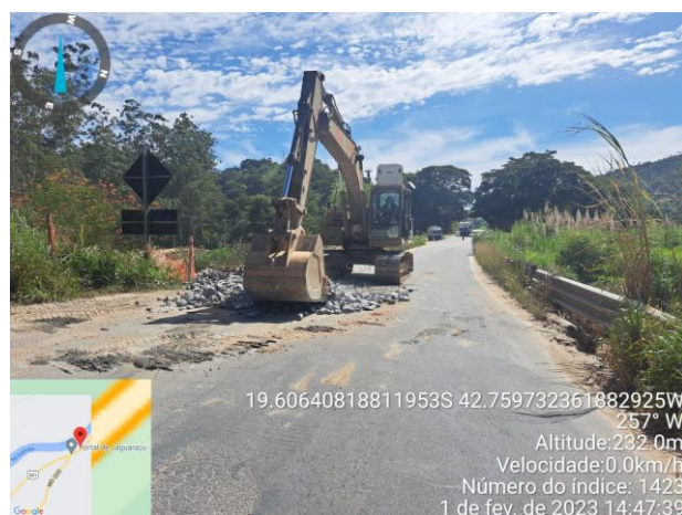
FOTO 28 – Enrocamento de pedra jogada;
