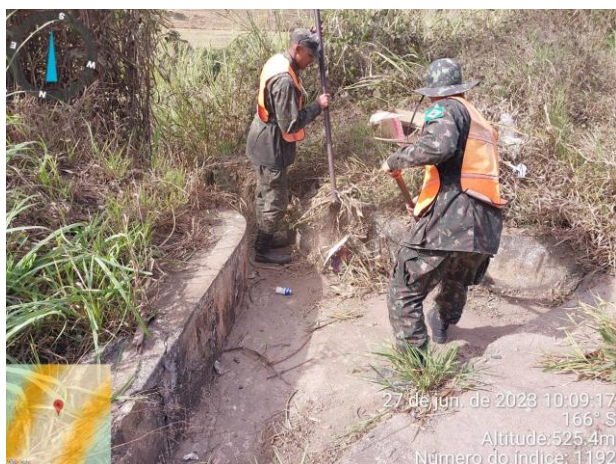
FOTO 15 – Limpeza de descida d'água;
