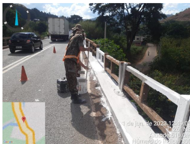
FOTO 05 – Caição das pontes;
