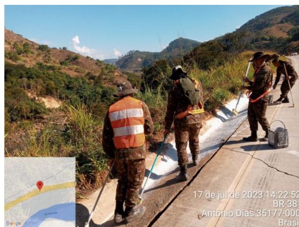
FOTO 06 – Caição dos dispositivos de drenagem;
