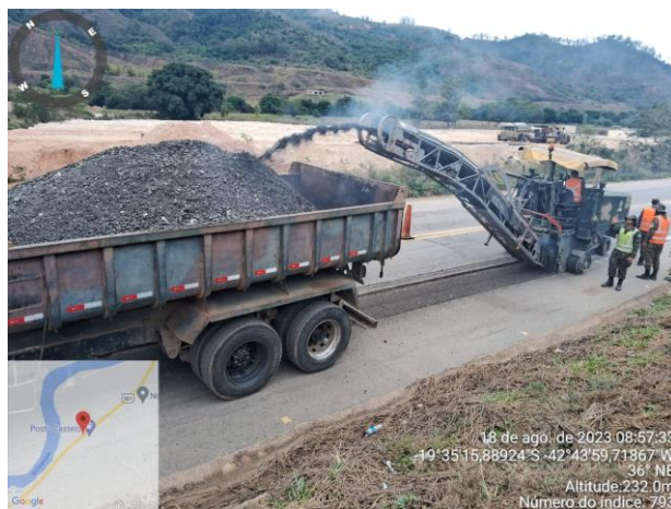
FOTO 01 – Fresagem do pavimento;
