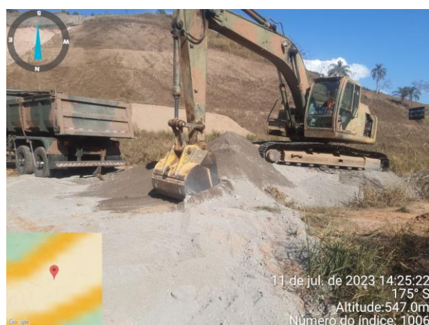
FOTO 22 – Manutenção de desvio de obra;
