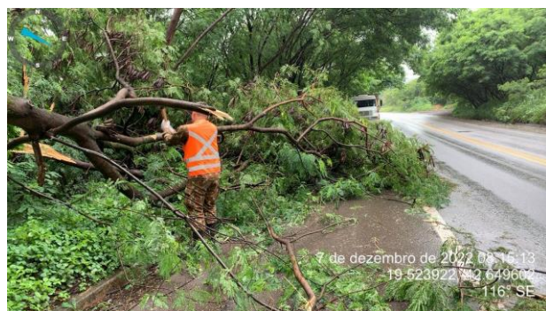
FOTO 36 – Remoção de árvore de grande porte;
