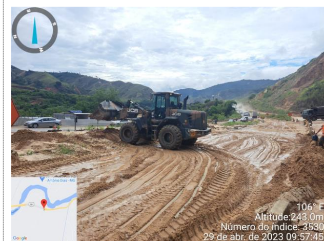
FOTO 39 – Remoção de barreira;
