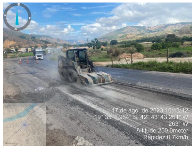
FOTO 02 – Fresagem do pavimento;
