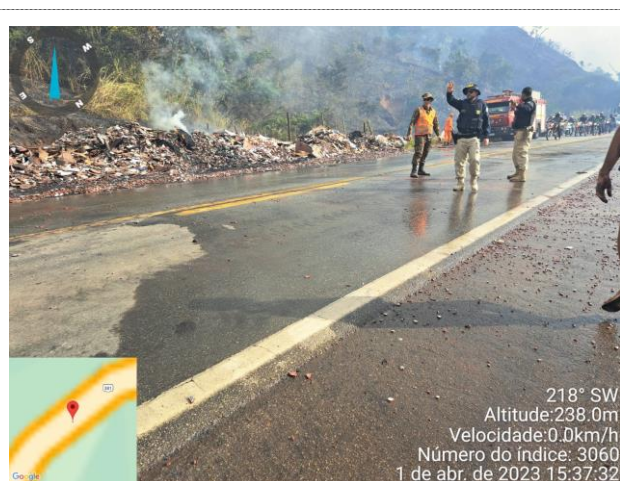
FOTO 38 – Remoção de carga e limpeza da pista;
