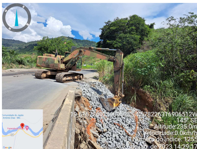
Figura 7 – Enrocamento de pedra jogada
