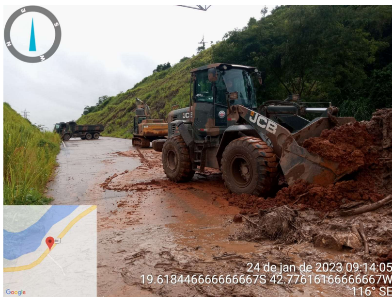
Figura 4 – Remoção mecanizada de barreira de solo
