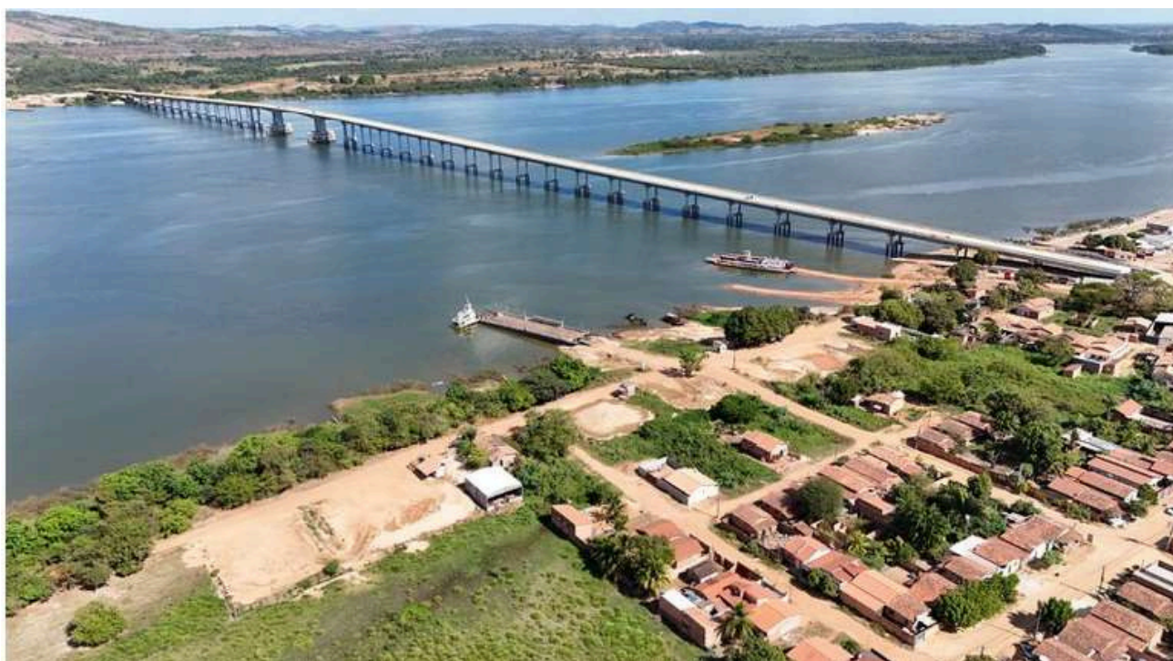
Figura 15 - Ponte sobre o Rio Araguaia
