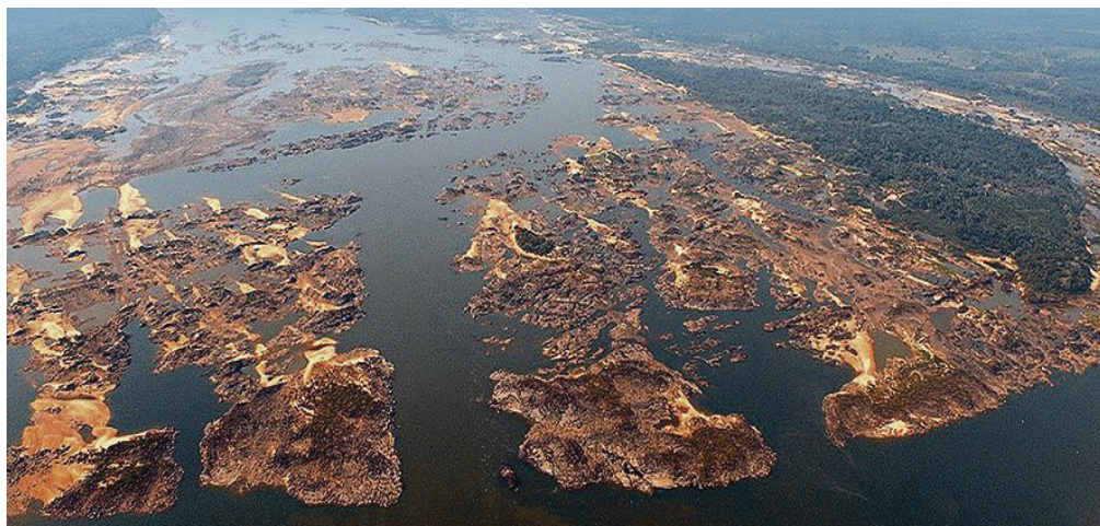
Figura 25 - Imagem aérea do Pedral do Lourenço
