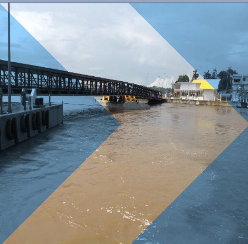
IP4 - Eirunepé/AM – Apoio das pontes metálicas
