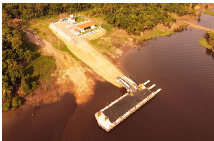
Figura 16 - Instalação Portuária de Anori
