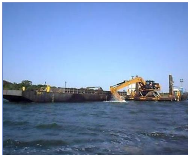
Figura 22 - Derrocamento do Canal de Nova Avanhandava
