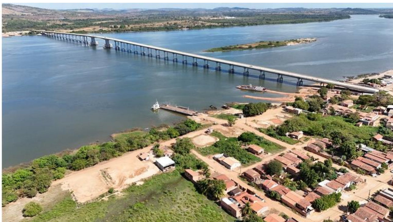
Figura 15 - Ponte sobre o Rio Araguaia
