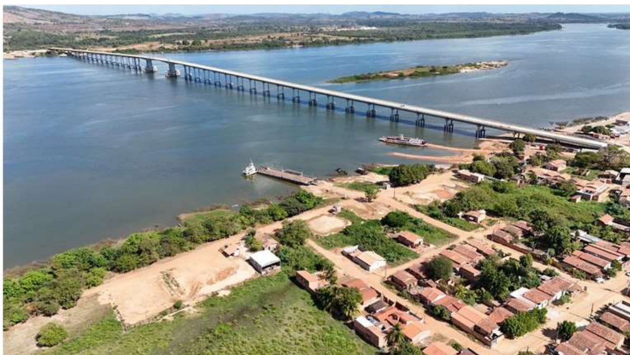
Figura 15 - Ponte sobre o Rio Araguaia
