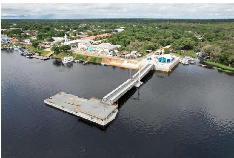
Figura 20 - Instalação Portuária de Barcelos/AM
