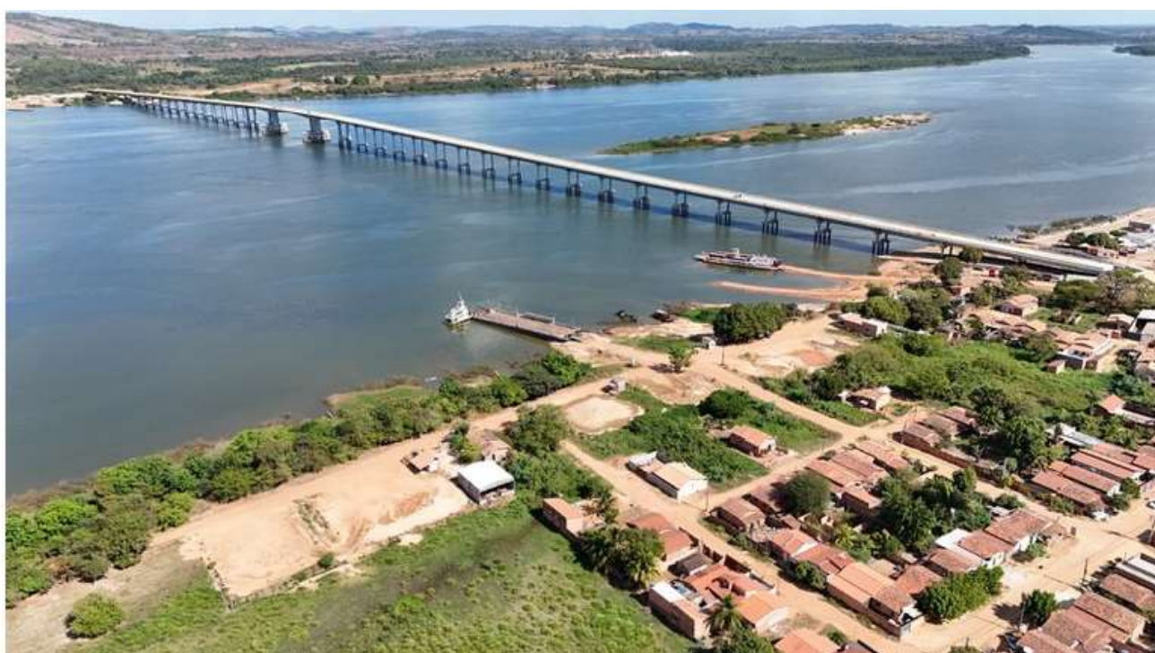
Figura 15 - Ponte sobre o Rio Araguaia
