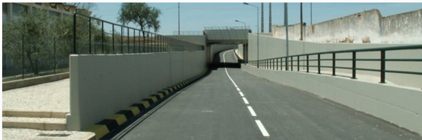
Construção de transposição da linha férrea no Município de Botucatu/SP
