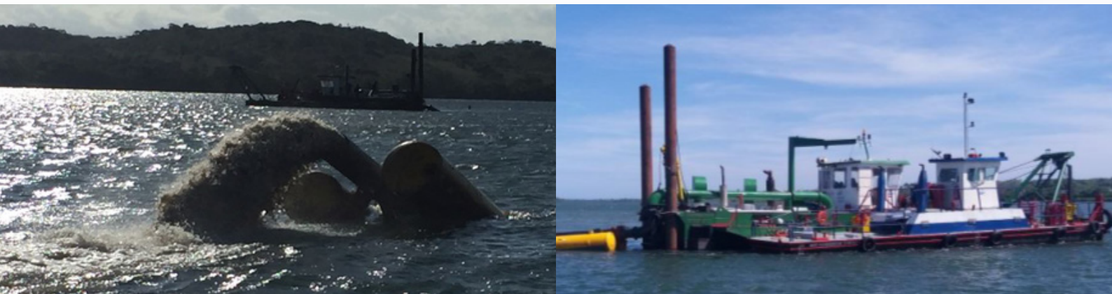
Dragagem da travessia entre as cidades de Penedo/AL e Neópolis/SE
