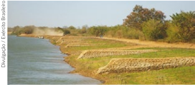
Recuperação ambiental das margens do Rio São Francisco pela Engenharia do EB.
