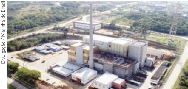
Laboratório de Geração de Energia Nucleoelétrica – Centro Industrial Nuclear de Aramar.
