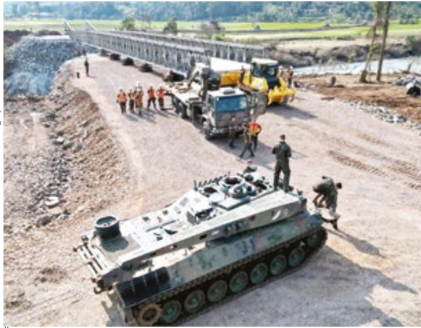
Lançamento de Ponte Logística, sobre o Rio Forqueta, por militares do EB por ocasião do apoio às enchentes do Rio Grande do Sul.
