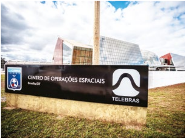
Centro de Operações Espaciais (COPE), Brasília (DF).
