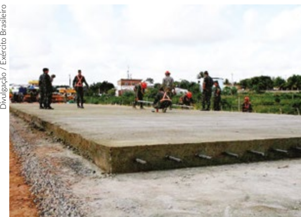
Engenharia do Exército pavimentando estrada.
