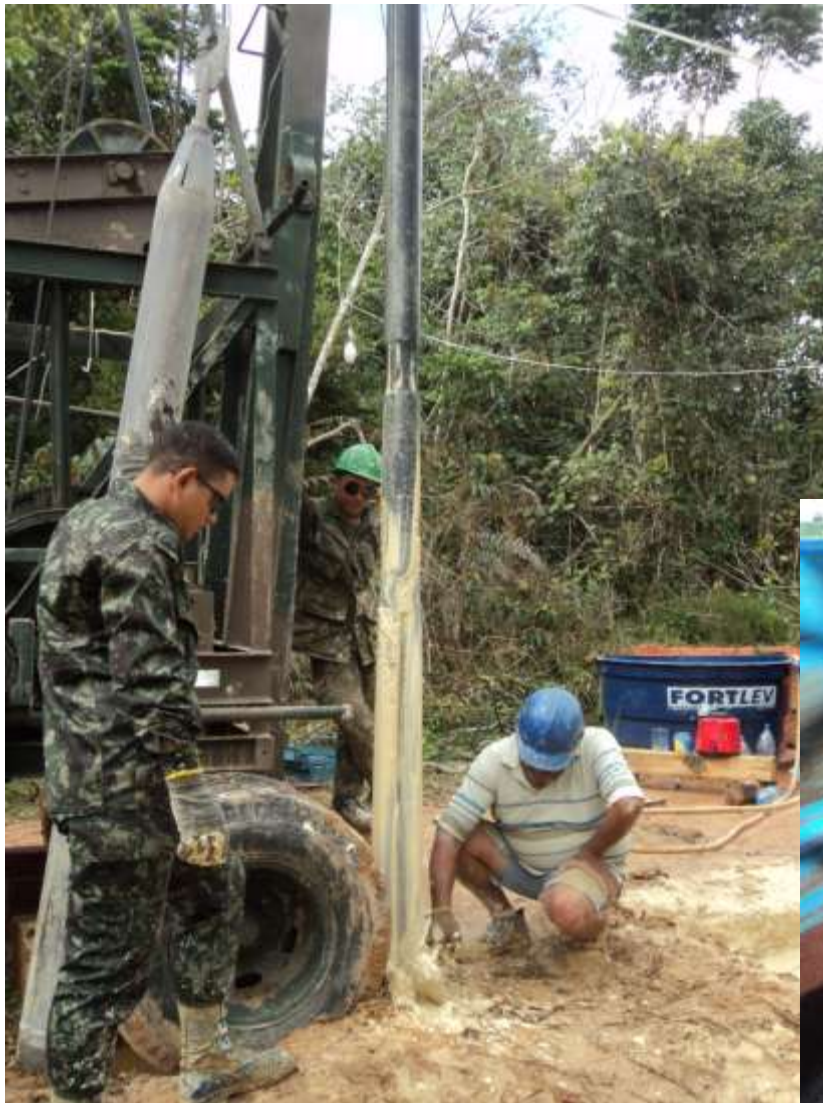
Perfuração de poço para água potável para militares e índios.
