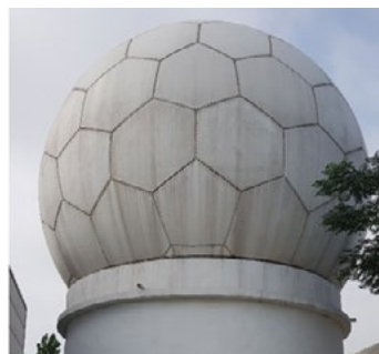
Site de Manaus: diâmetro de 7 metros, com capacidade de transmitir e receber dados de satélites ópticos e RADAR nas bandas X e S.
