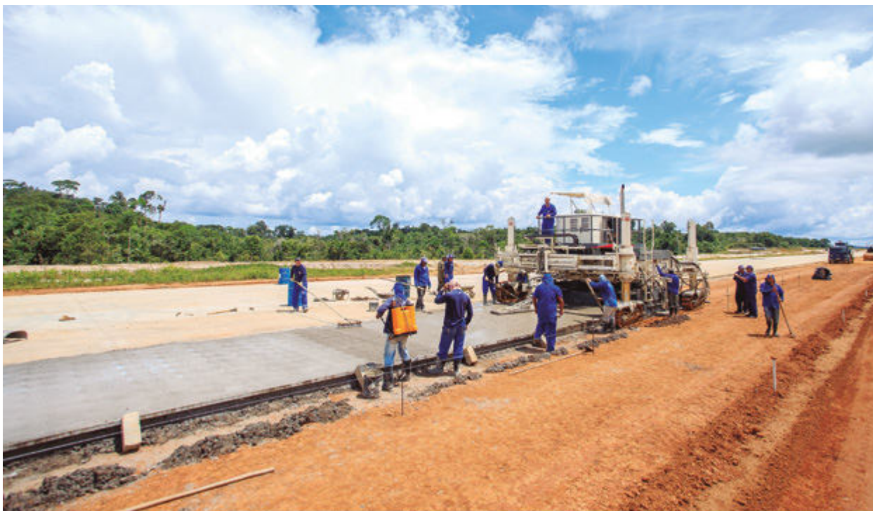
Construção de pista em Iauaretê, no Amazonas.
