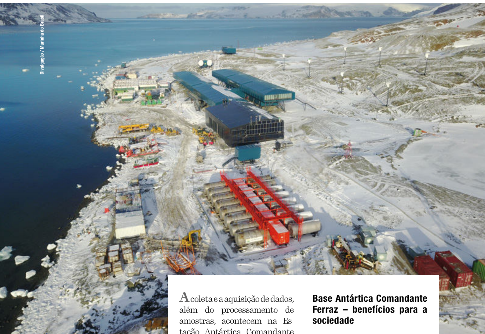
Instalações da Estação Antártica Comandante Ferraz.
