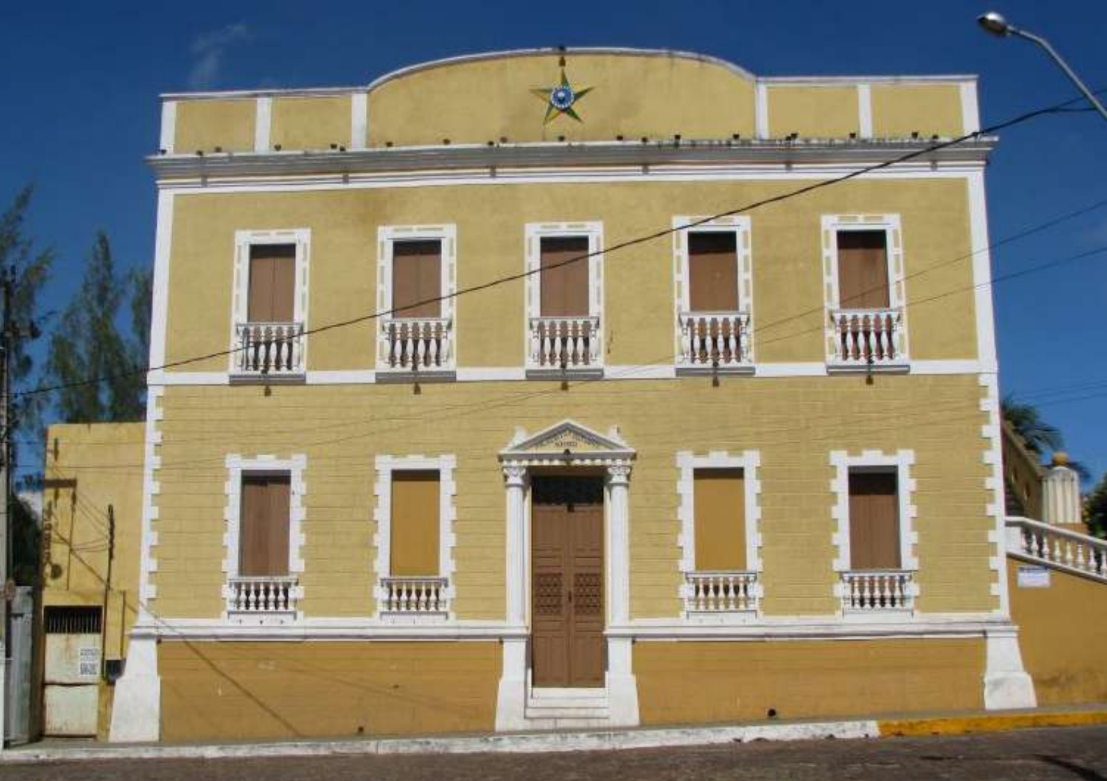
Fachada Escola de Saberes, Barbalha -CE. Fonte: https://boanoticia.org.br , 2021.
