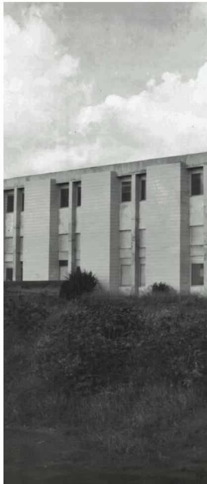
Ínicio da construção da construção do CTI em 1982
