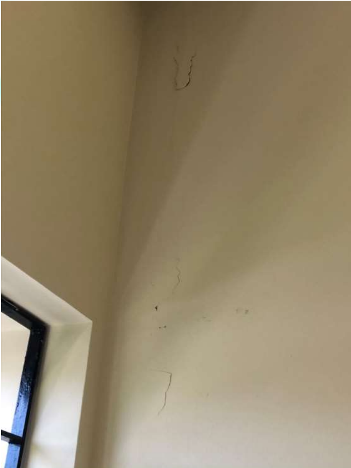
Figura 175 - Fissura longitudinal
