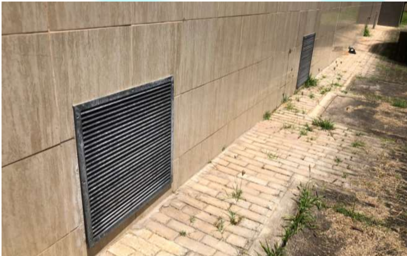
Figura 183 - Grelhas na fachada
