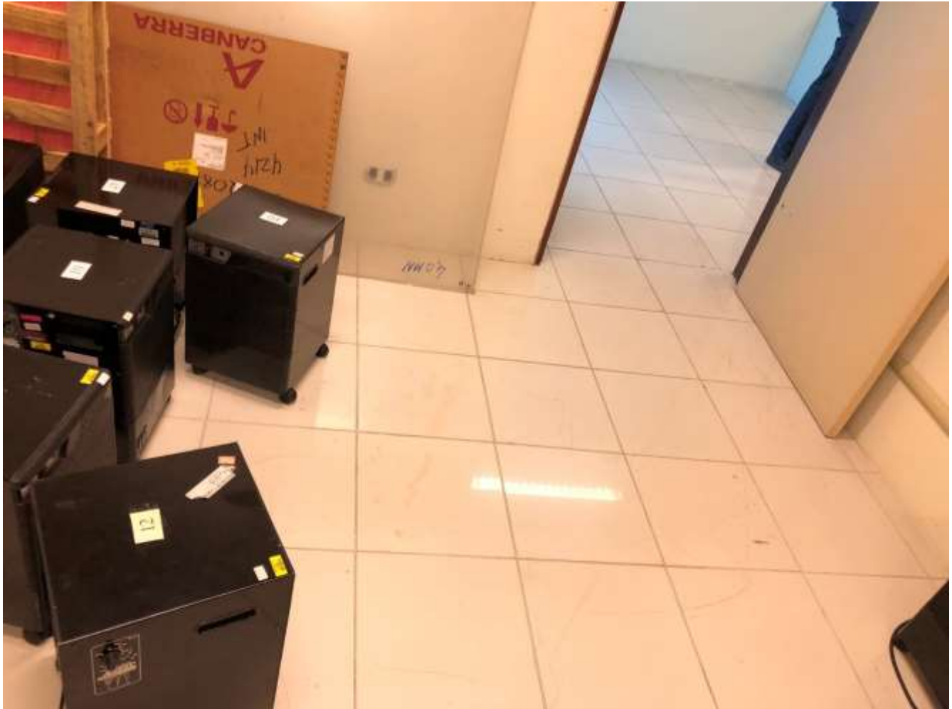
Figura 98 - Pedras de cerâmica arranhadas e manchadas
