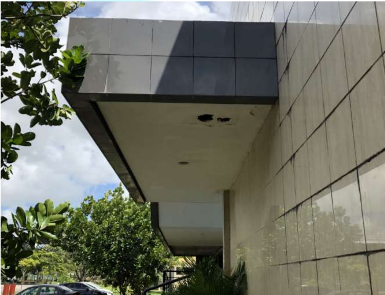
Figura 189 - Área para pintura da marquise
