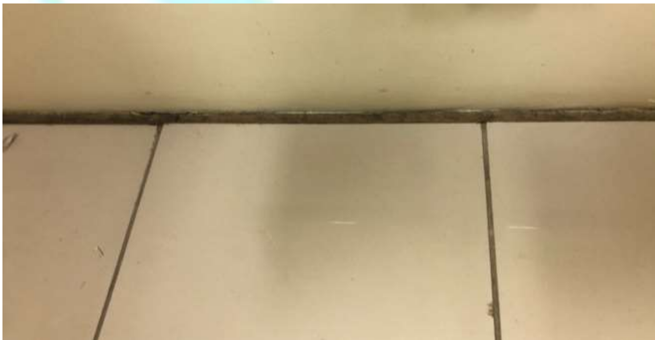
Figura 148 - Junta de dilatação no piso
