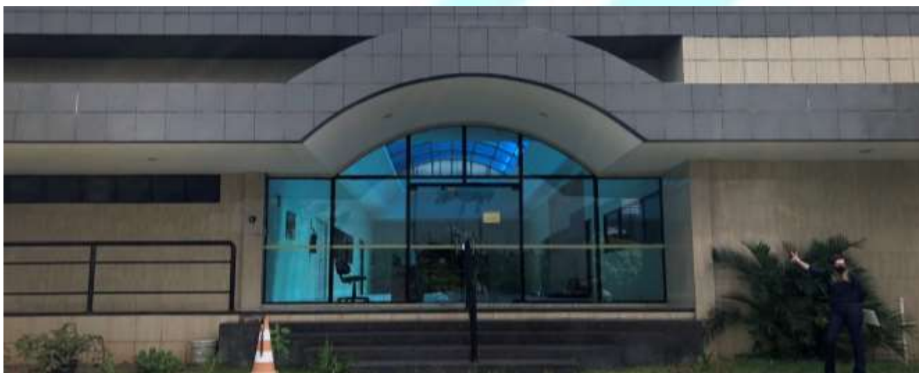
Figura 72 - Marquise, fachada frontal
