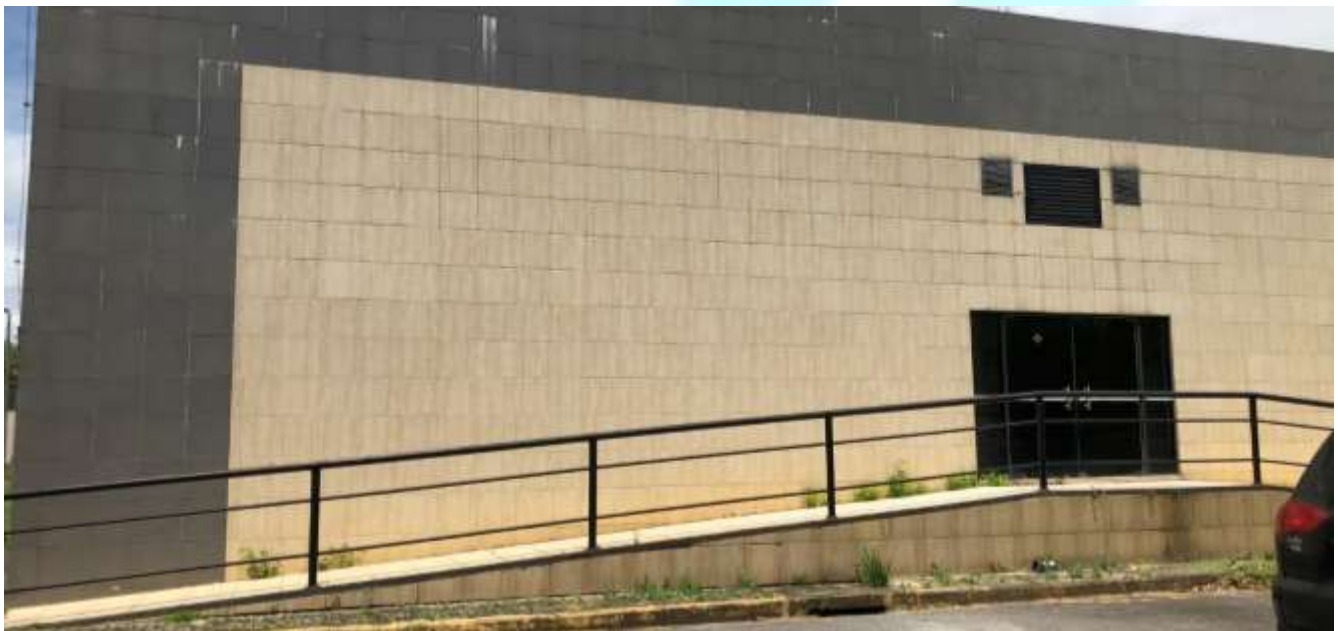
Figura 182 - Corrimãos fachada posterior
