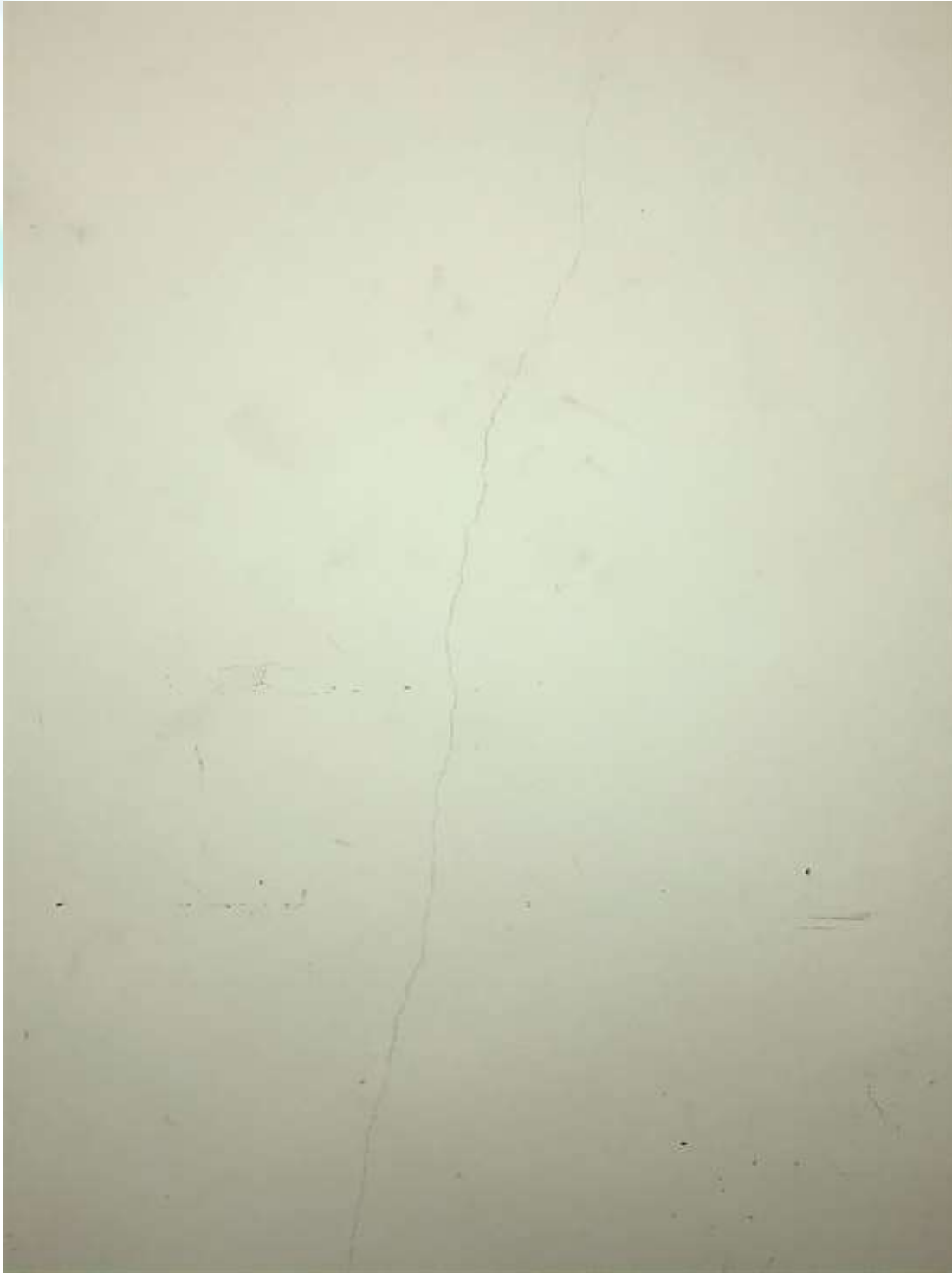
Figura 112 -Fissura longitudinal
