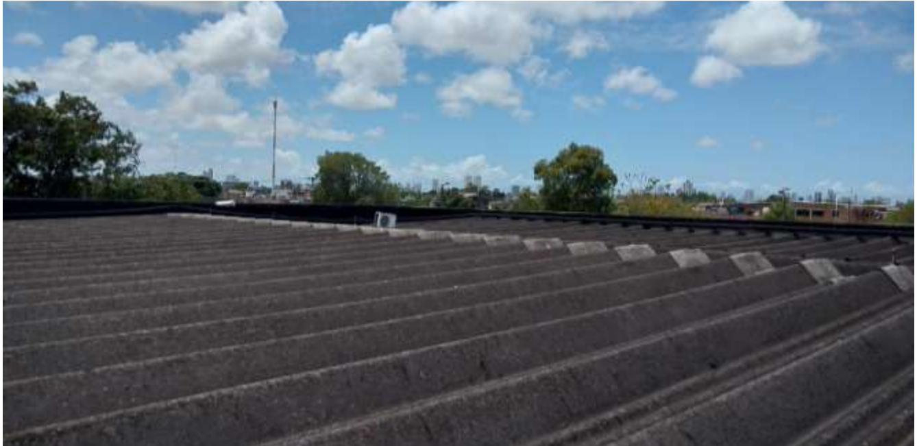
Figura 63 - Área de laje sob telha de fibrocimento
