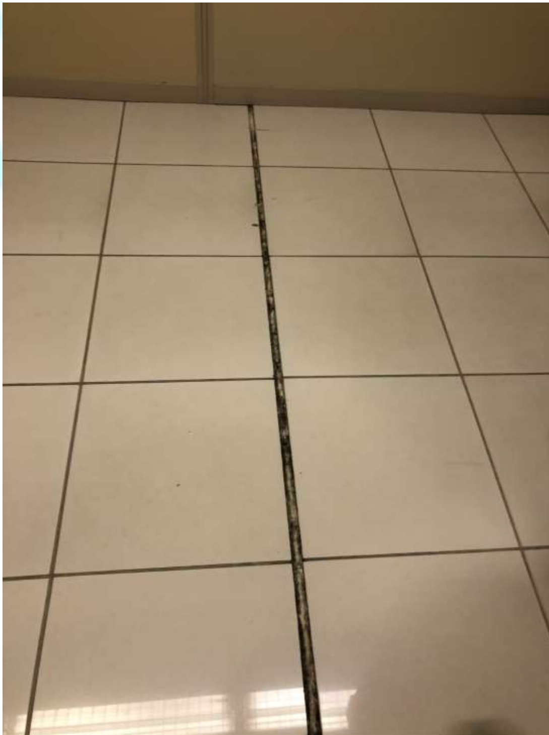
Figura 168 - Junta de dilatação no piso
