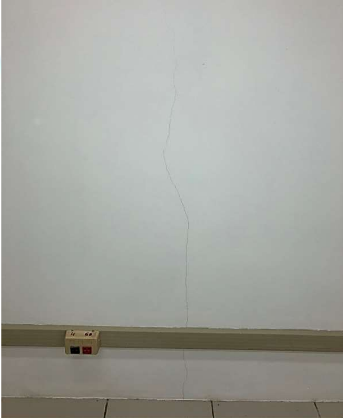
Figura 124 - Fissura longitudinal
