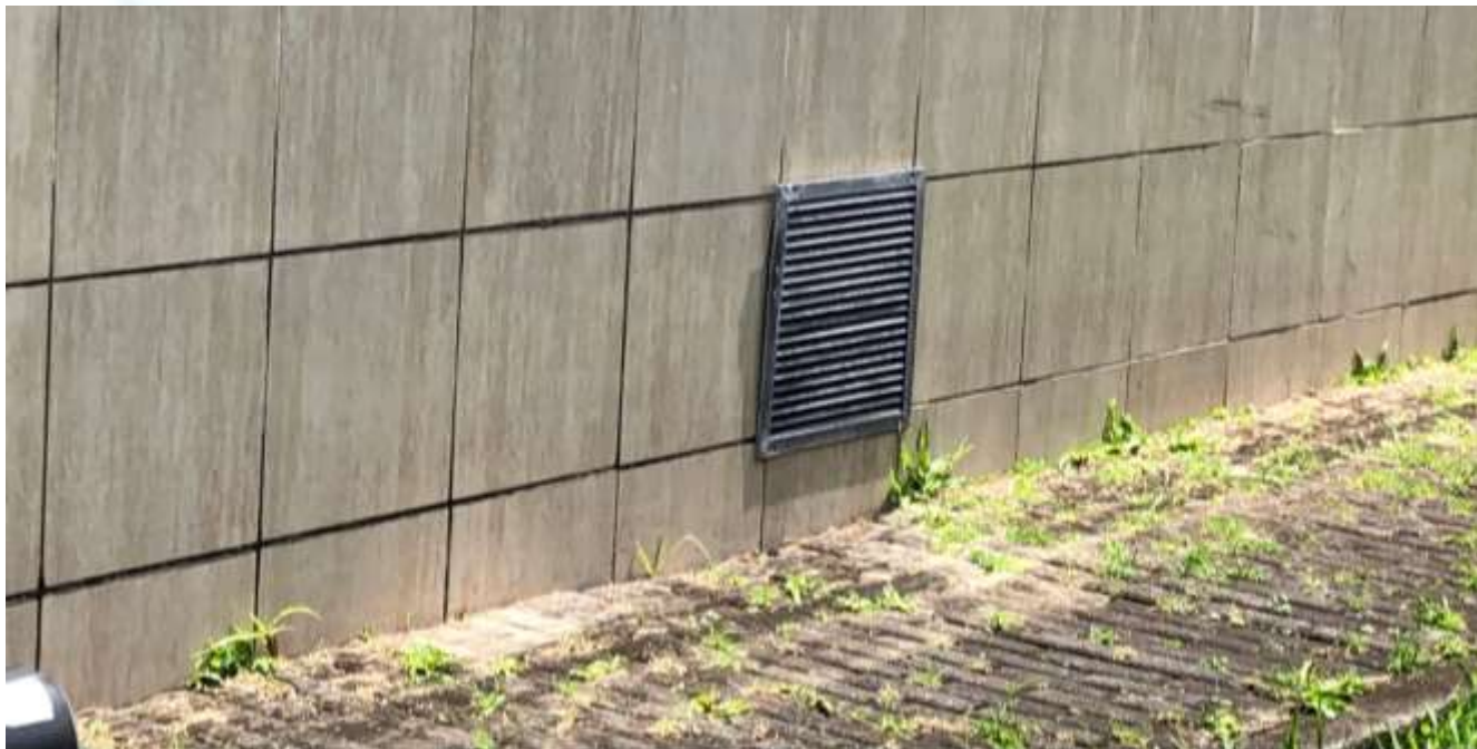
Figura 186 - Grelhas na fachada
