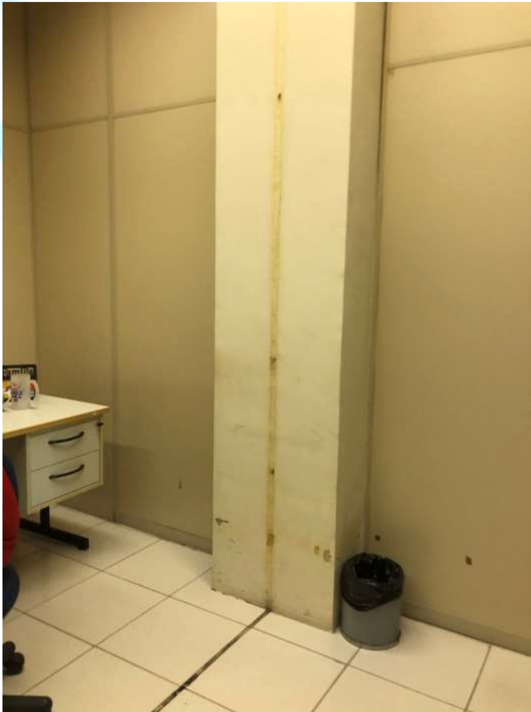
Figura 169 - Junta de dilatação dos pilares
