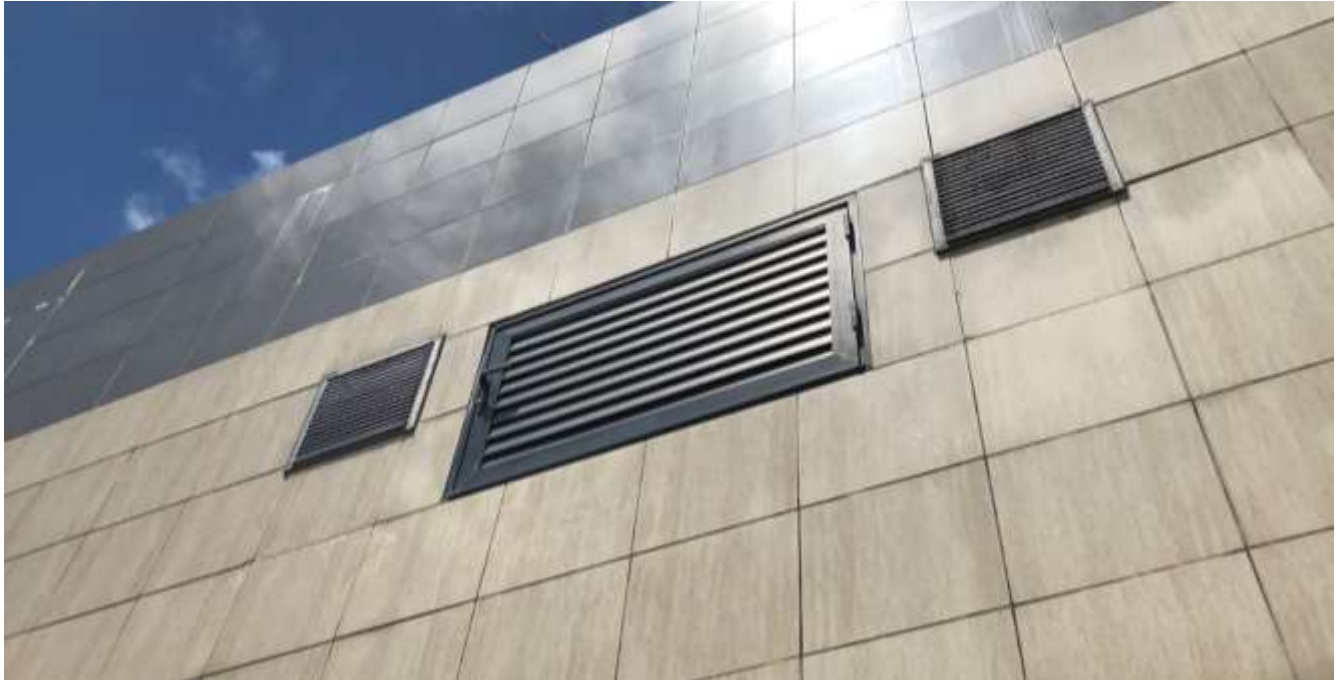
Figura 184 - Grelhas na fachada
