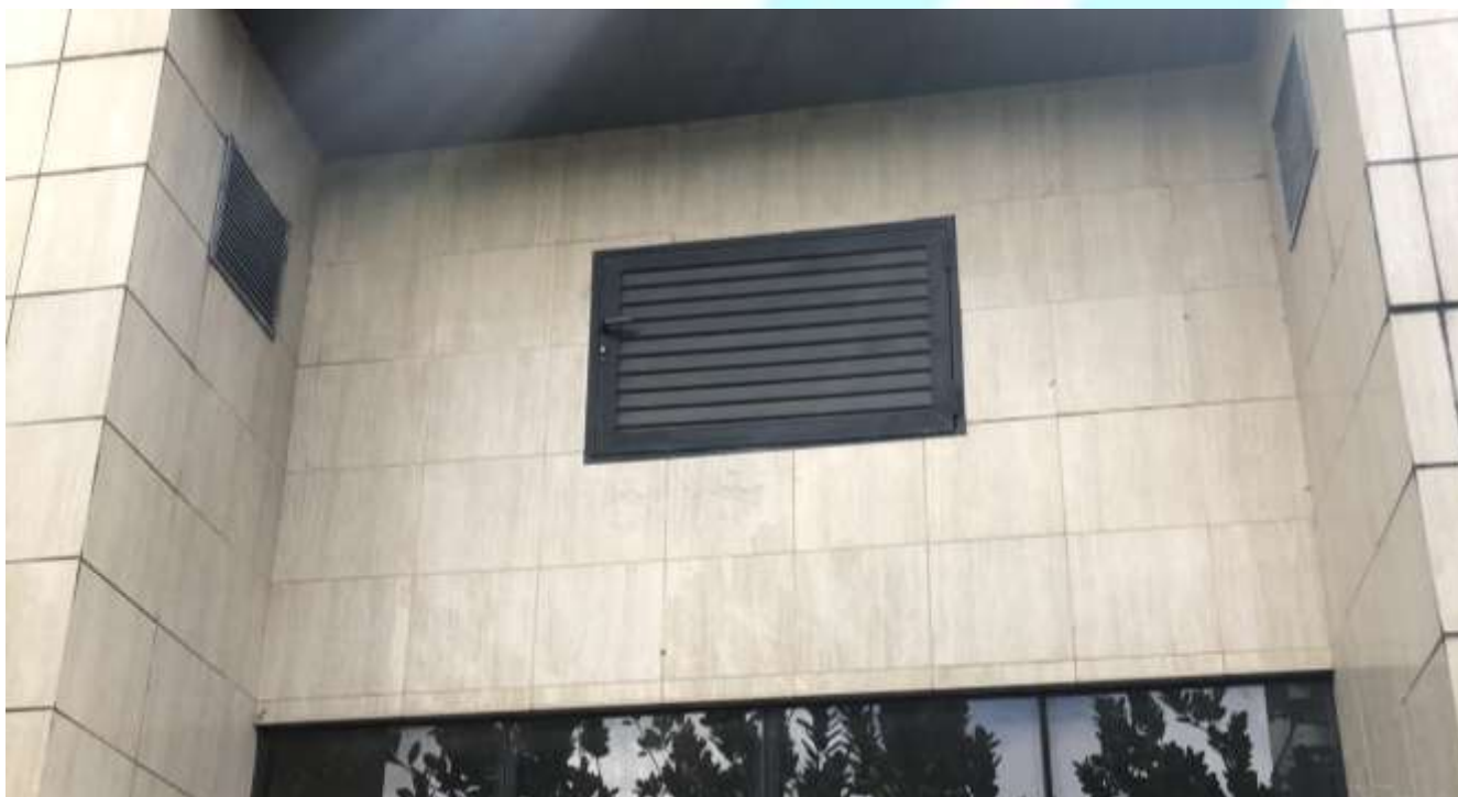
Figura 187 - Grelhas na fachada
