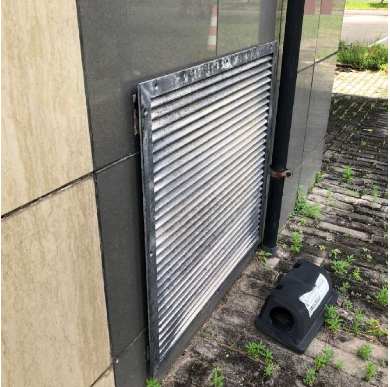
Figura 185 - Grelhas na fachada
