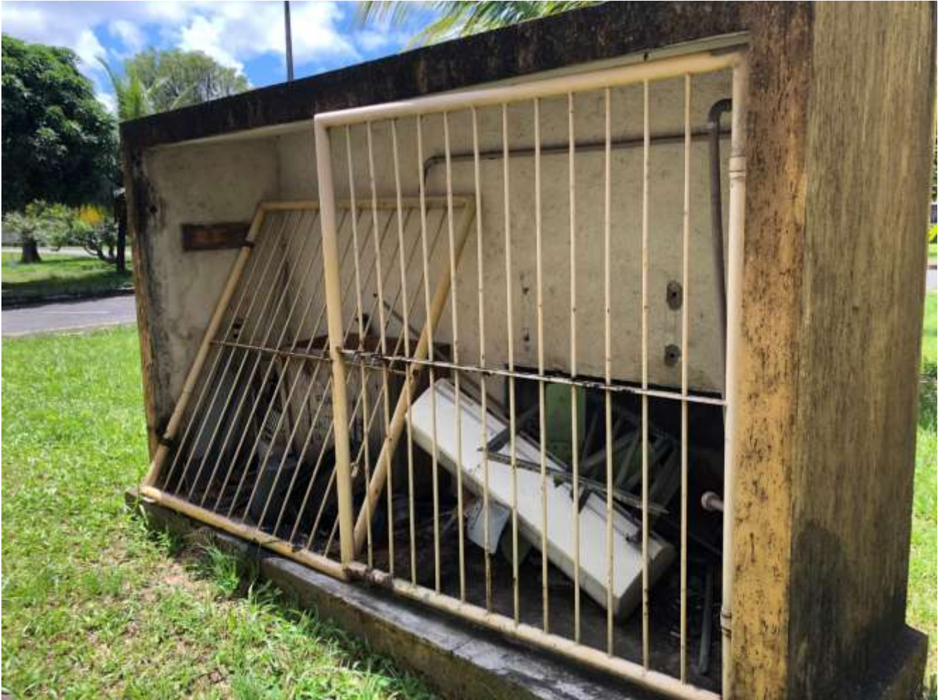
Figura 188 – Anexo do prédio
