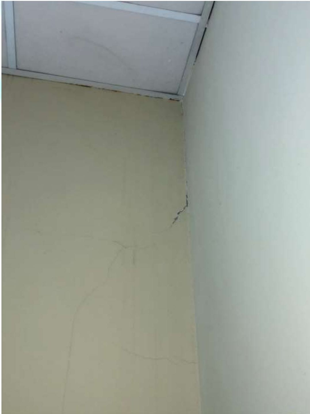
Figura 178 - Fissura longitudinal
