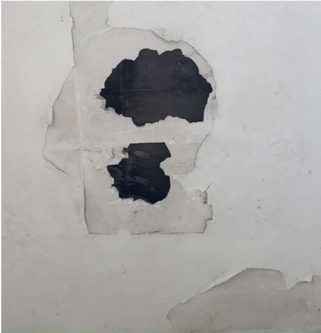
Figura 192- Forro danificado
