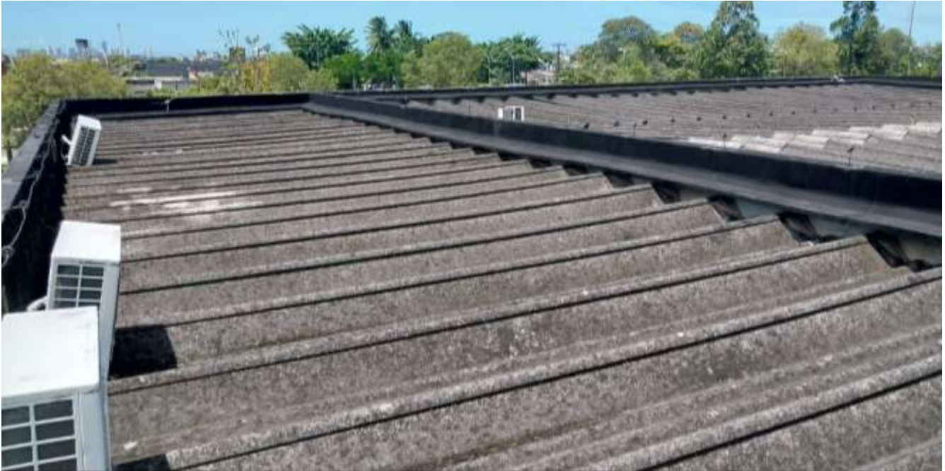
Figura 65 - Platibandas e algeroz impermeabilizados com manta asfáltica
