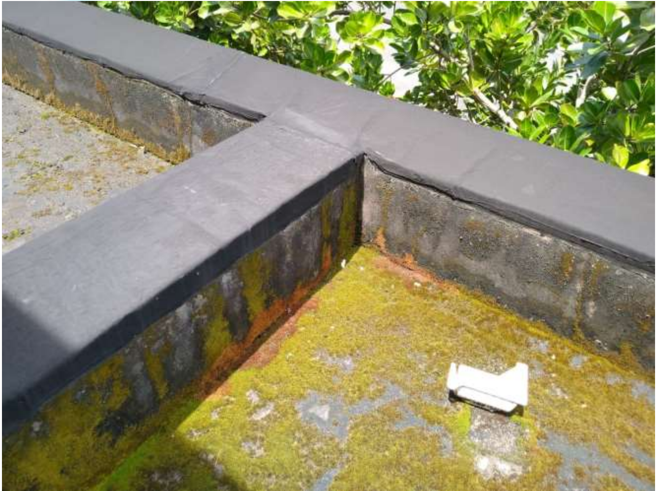
Figura 75 - Manta asfáltica no cume das platibandas e divisórias
