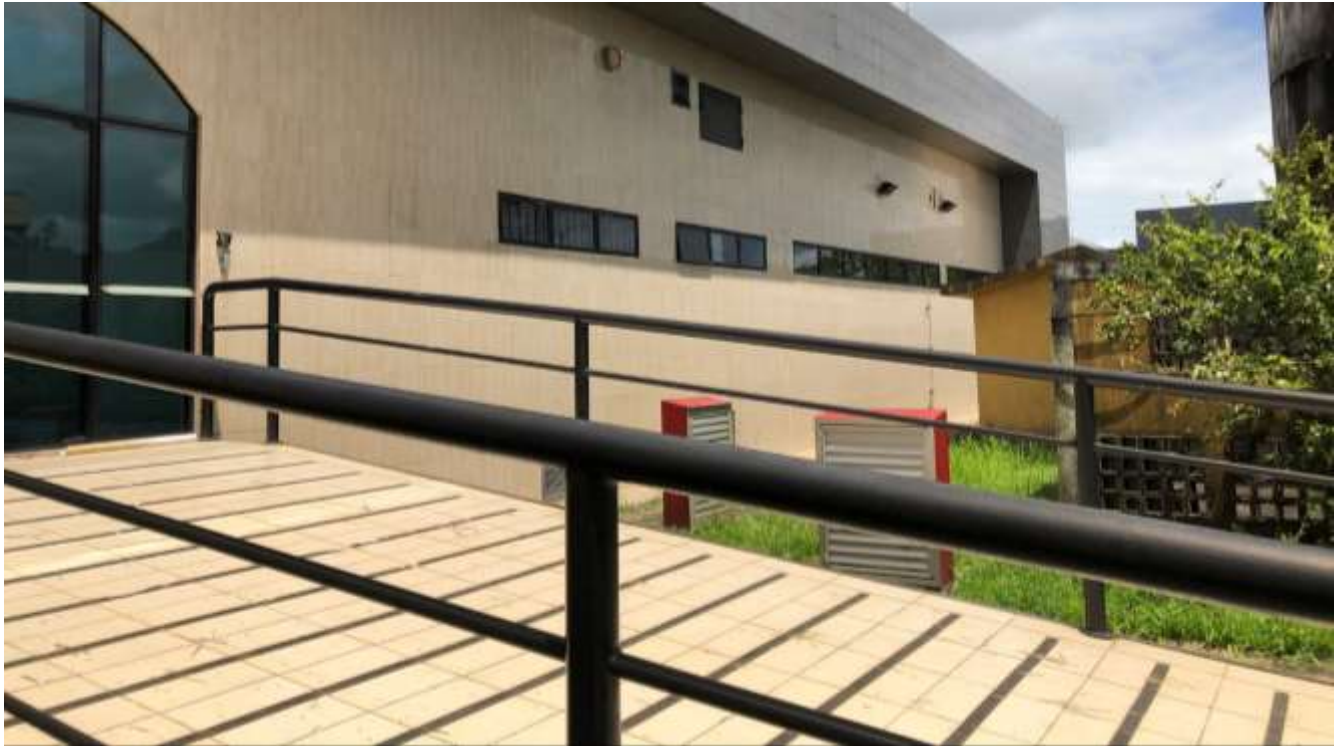
Figura 181 - Corrimãos fachada posterior
