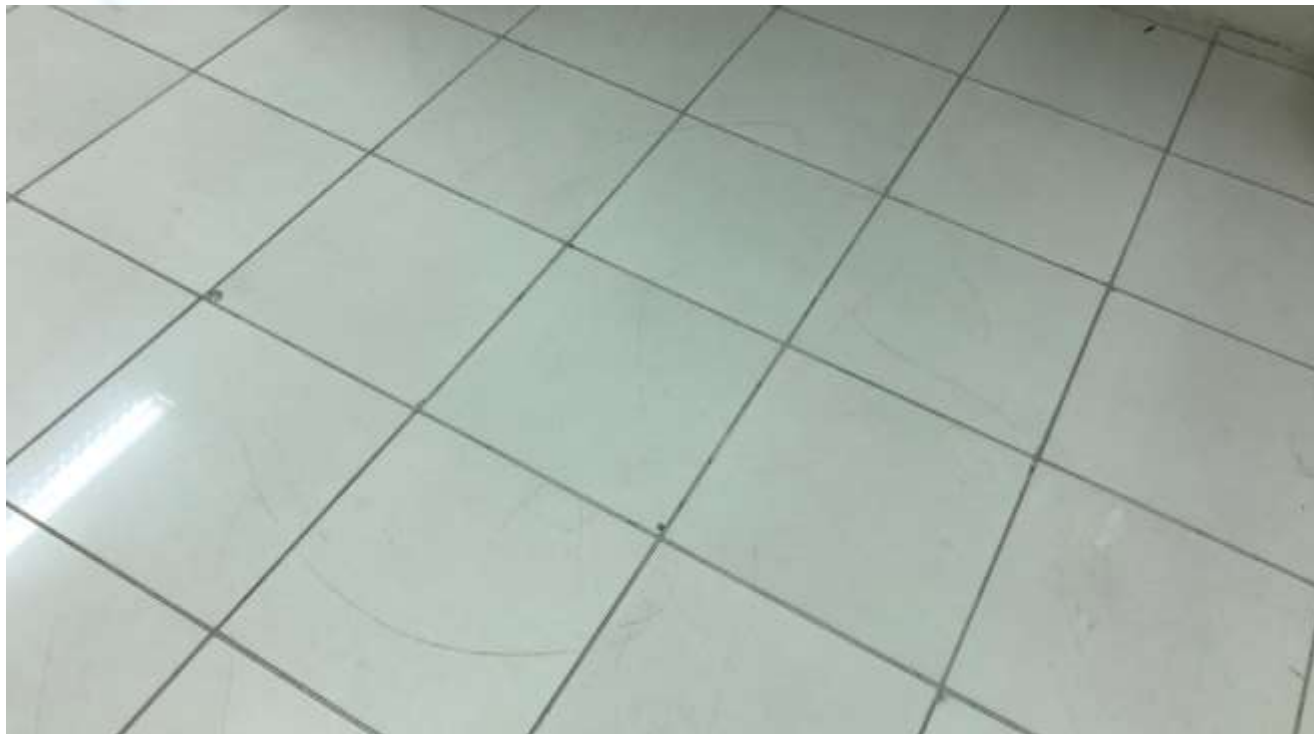
Figura 107 - Cerâmicas arranhadas
