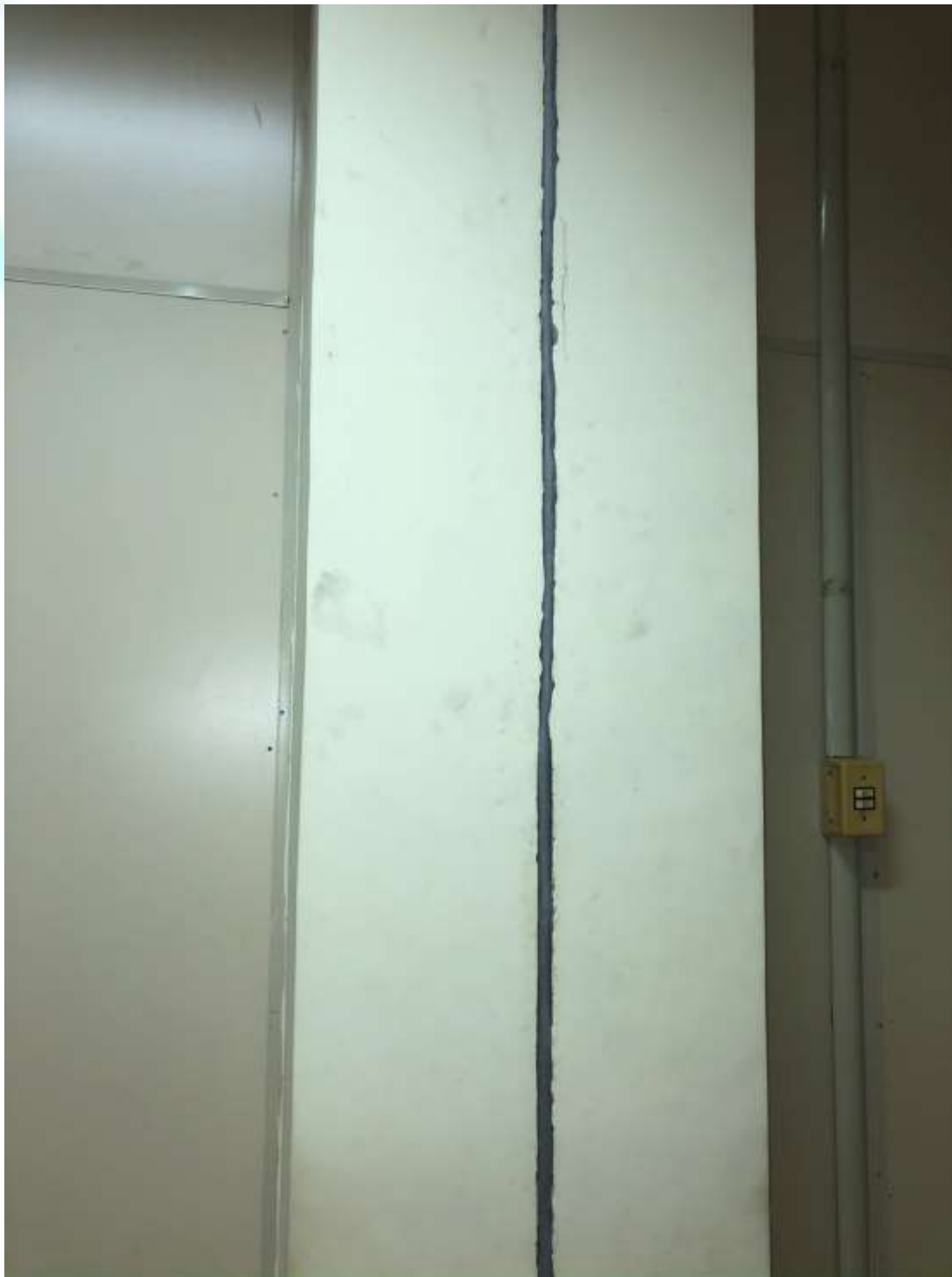
Figura 163 - Junta de dilatação do pilar
