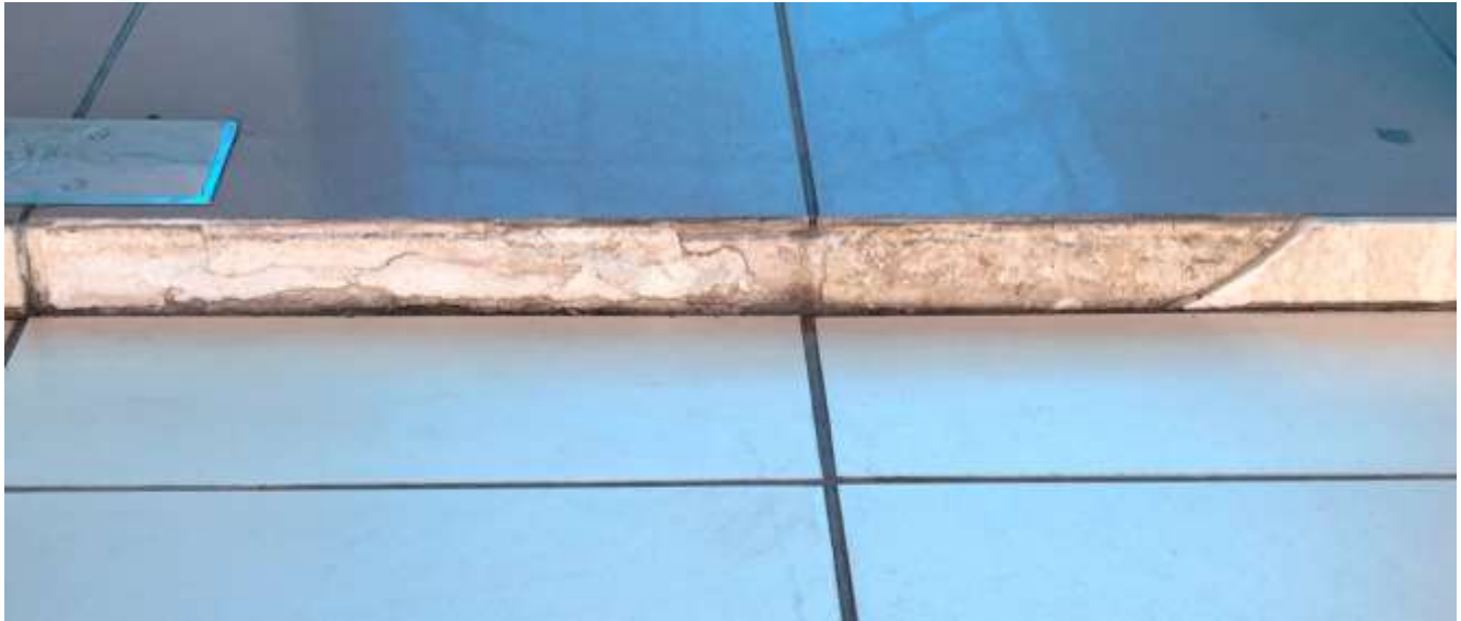
Figura 8 - Trechos do rodapé sem cerâmicas
