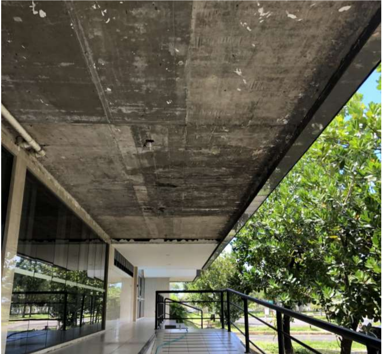
Figura 190 - Área de aplicação de forro de gesso e pintura
