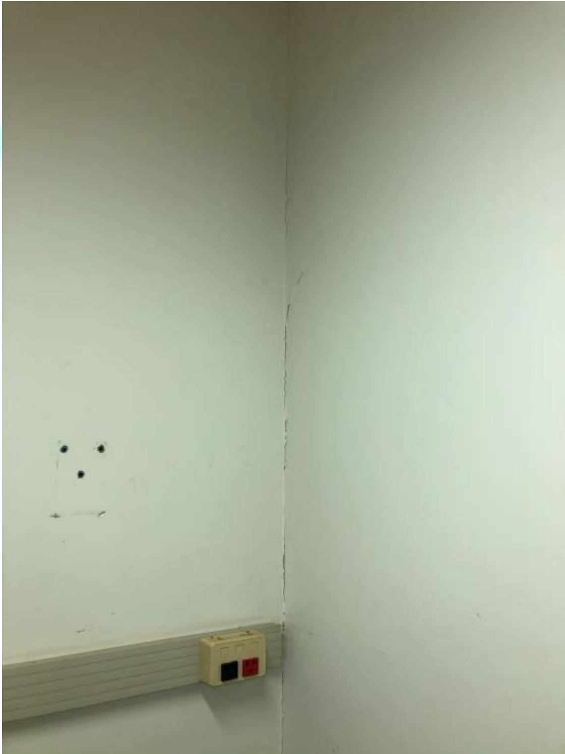
Figura 103 - Fissura vertical
