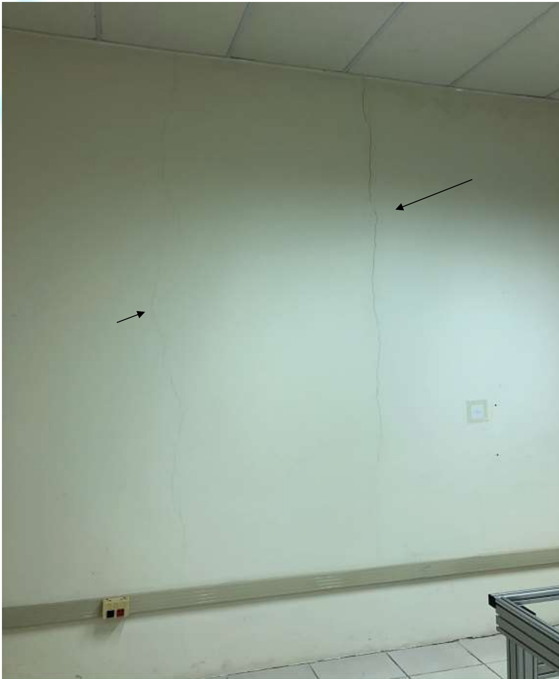
Figura 138 - Fissuras verticais
