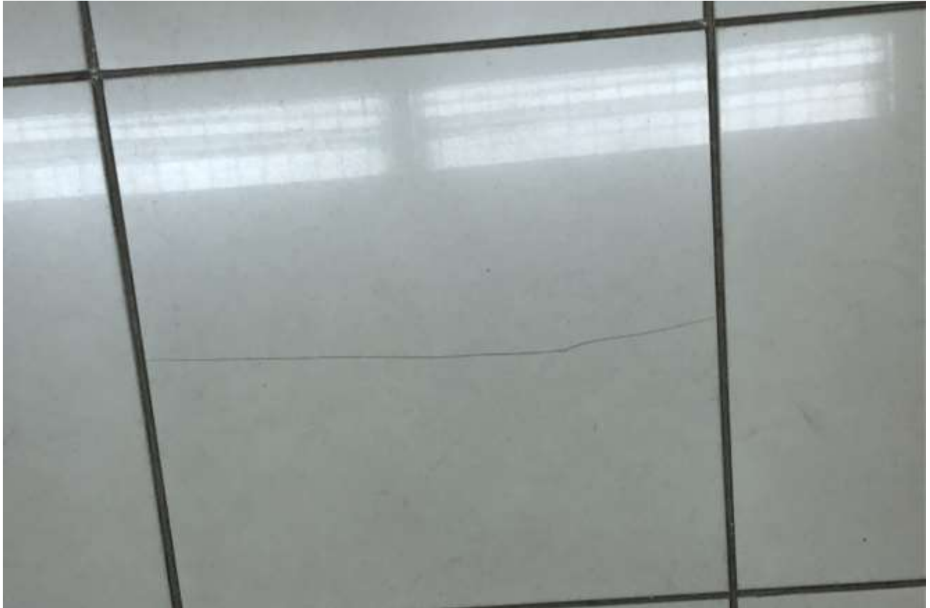
Figura 161 - Cerâmica fissurada
