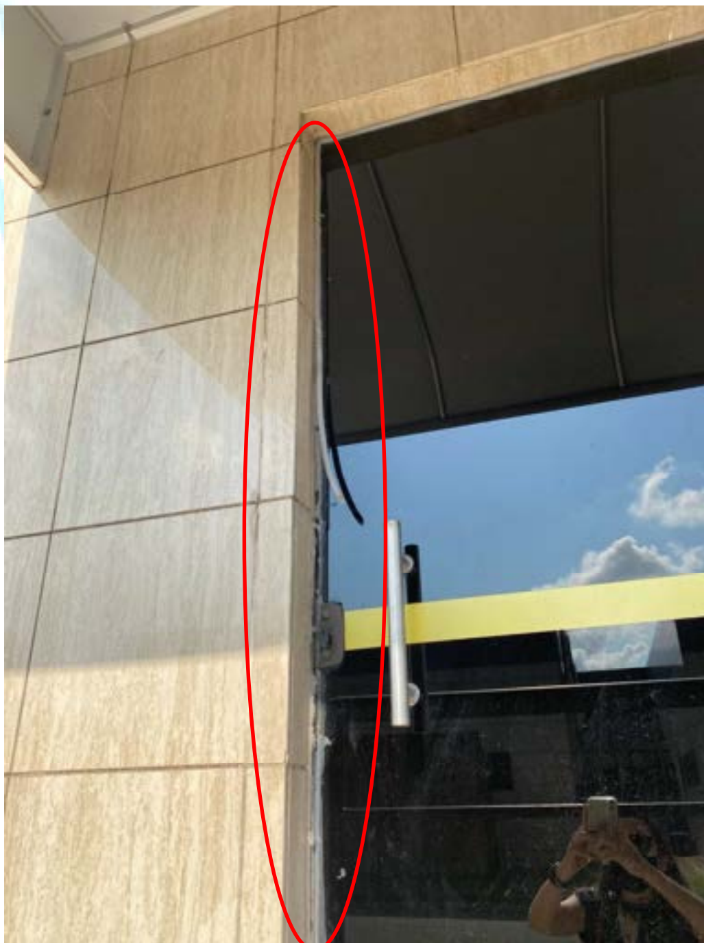
Figura 37 - Porta apresentando silicone lateral gasto
