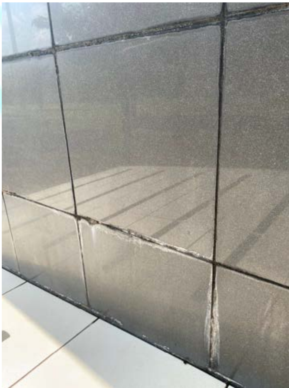
Figura 5 – Pontos de sujidades e eflorescência no revestimento
