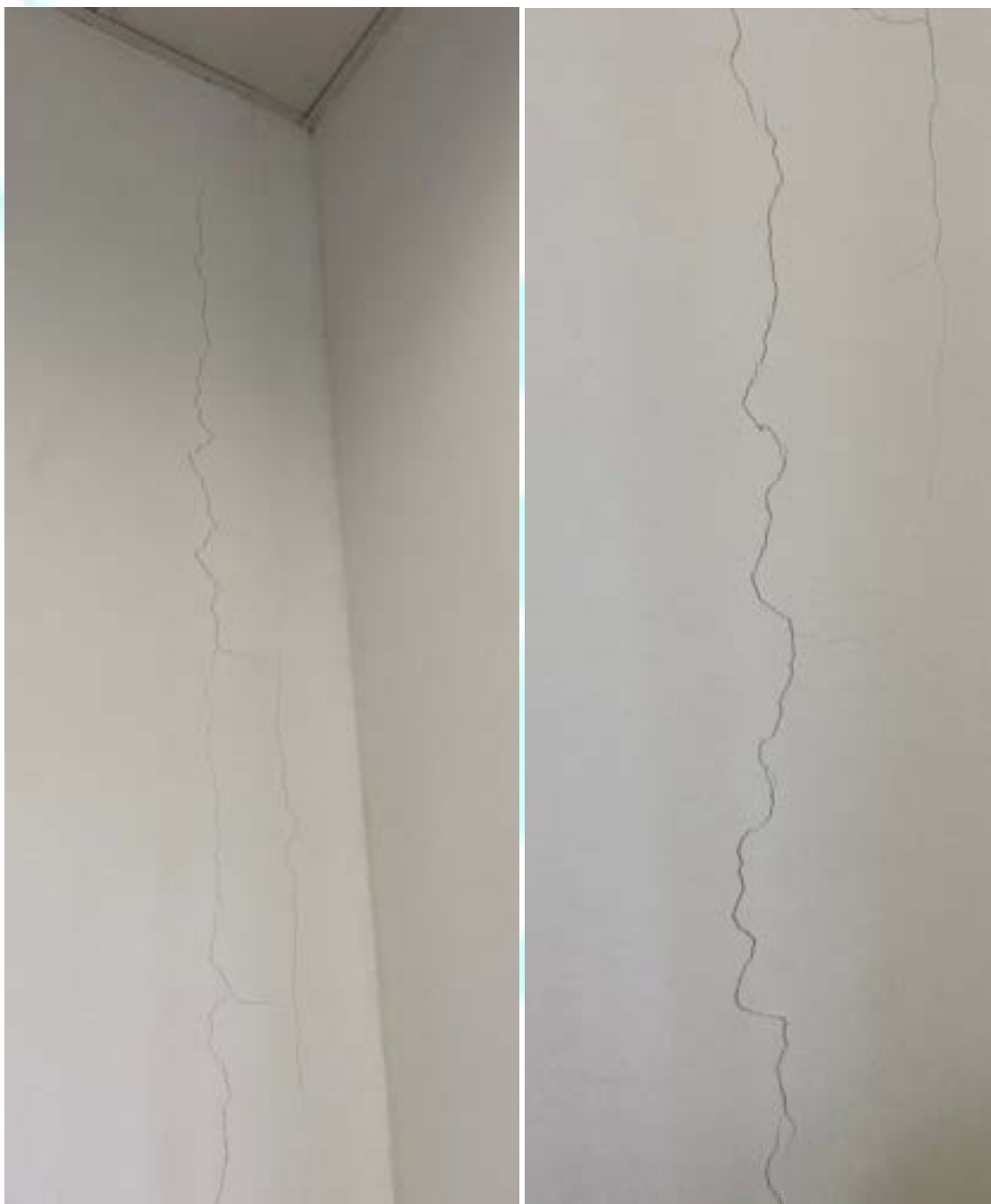
Figura 199 – Fissura longitudinal na parede da sala 02C
