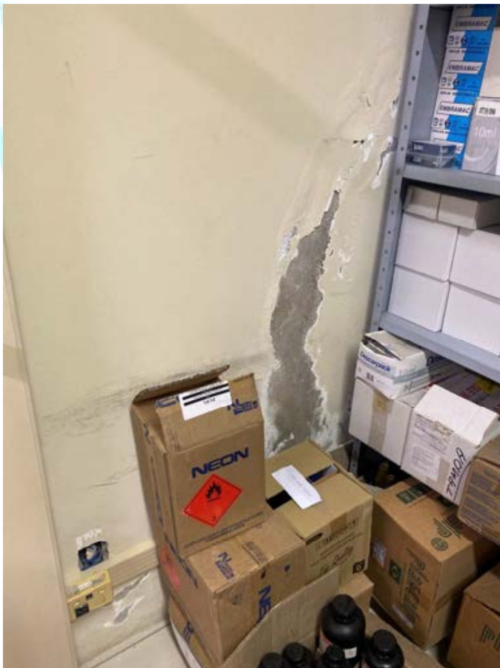
Figura 161 – Deterioração na parede
