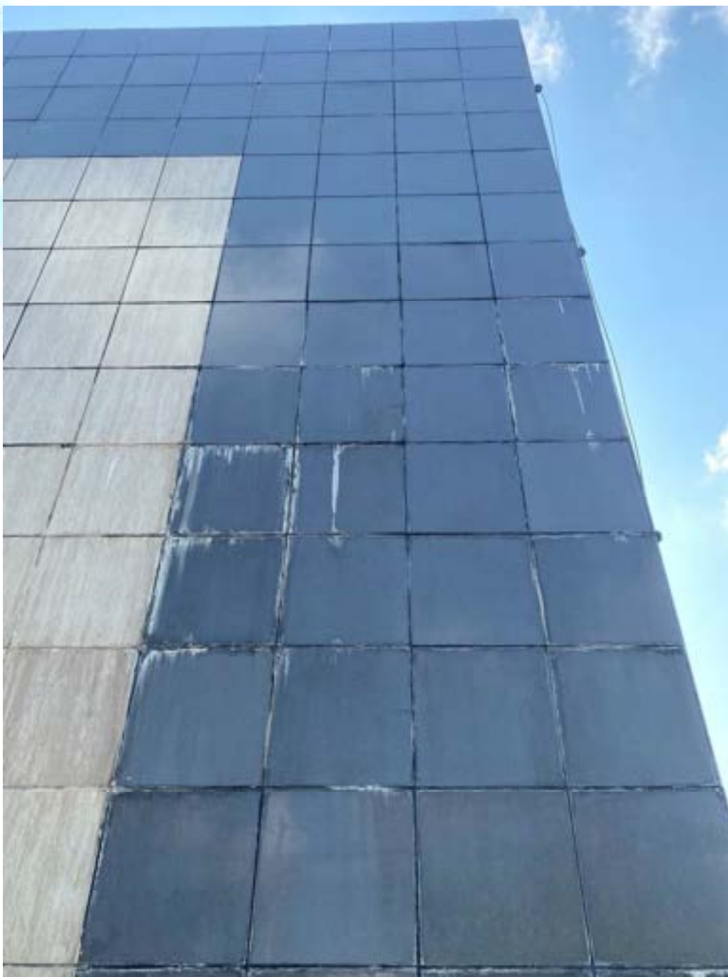
Figura 48 – Revestimento apresentando eflorescência, sujidades e trincas
