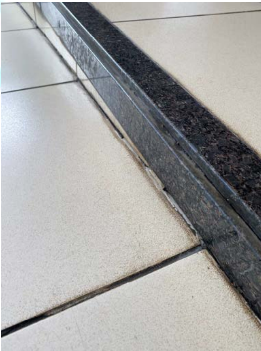
Figura 16 – Deterioração do rejunte entre revestimento e granito da rampa
