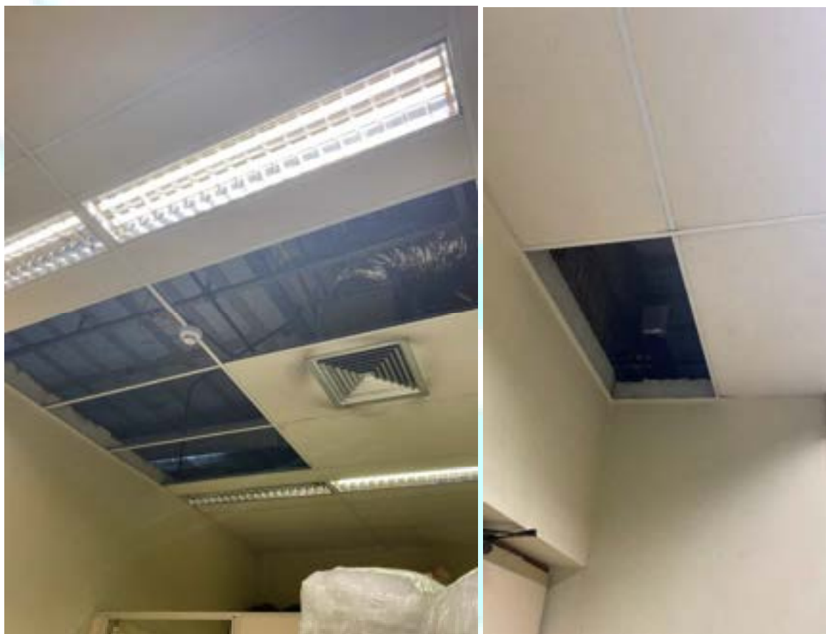
Figura 155 – Ausência das tampas de forro
