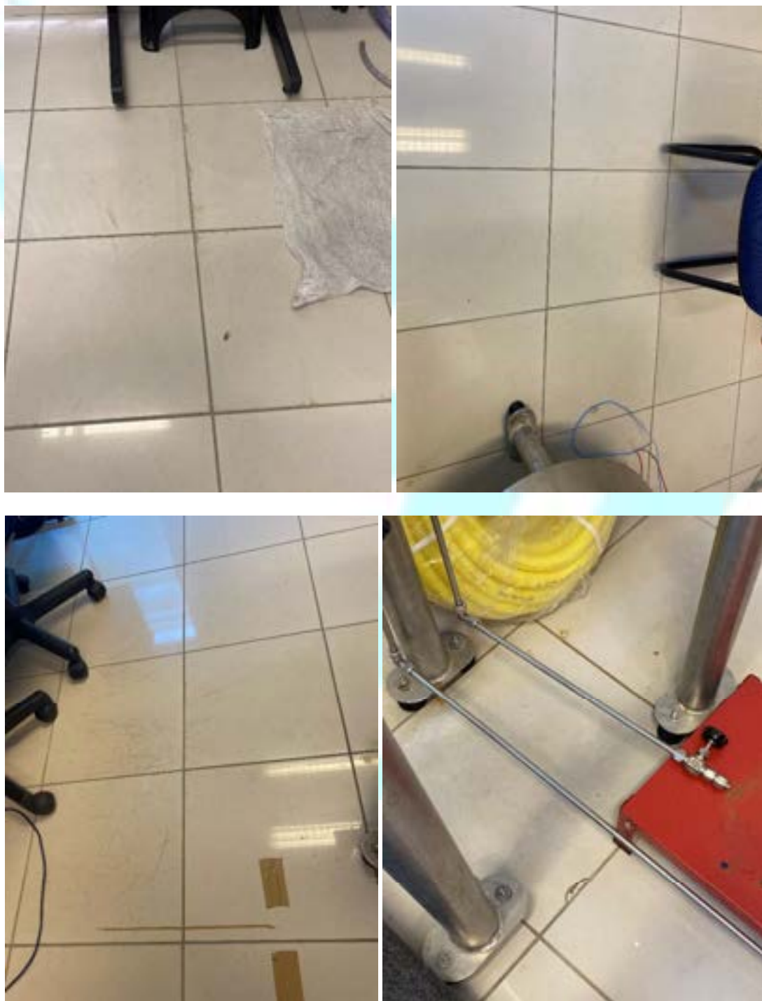
Figura 289 – Revestimentos do piso danificados
