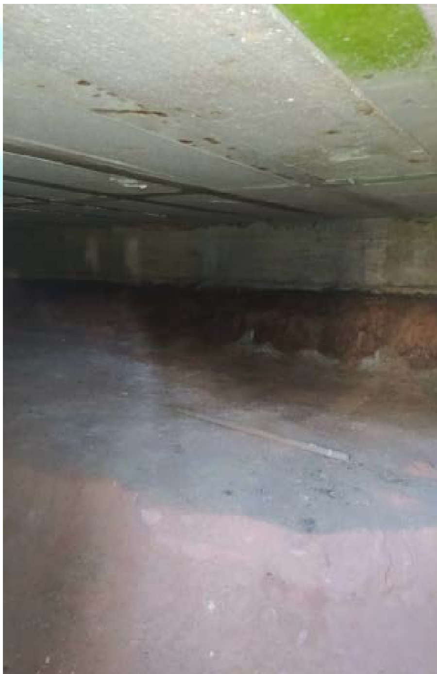
Figura 117 – Área da fundação – Pontos de oxidação
