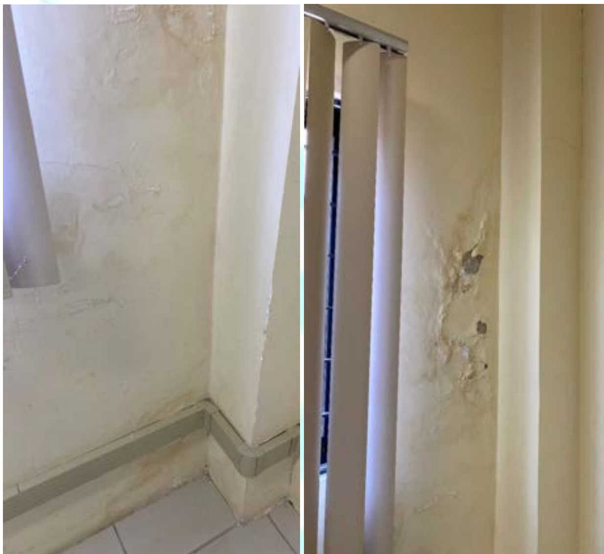
Figura 262 – Umidade e afofamento na parede na sala 08A
