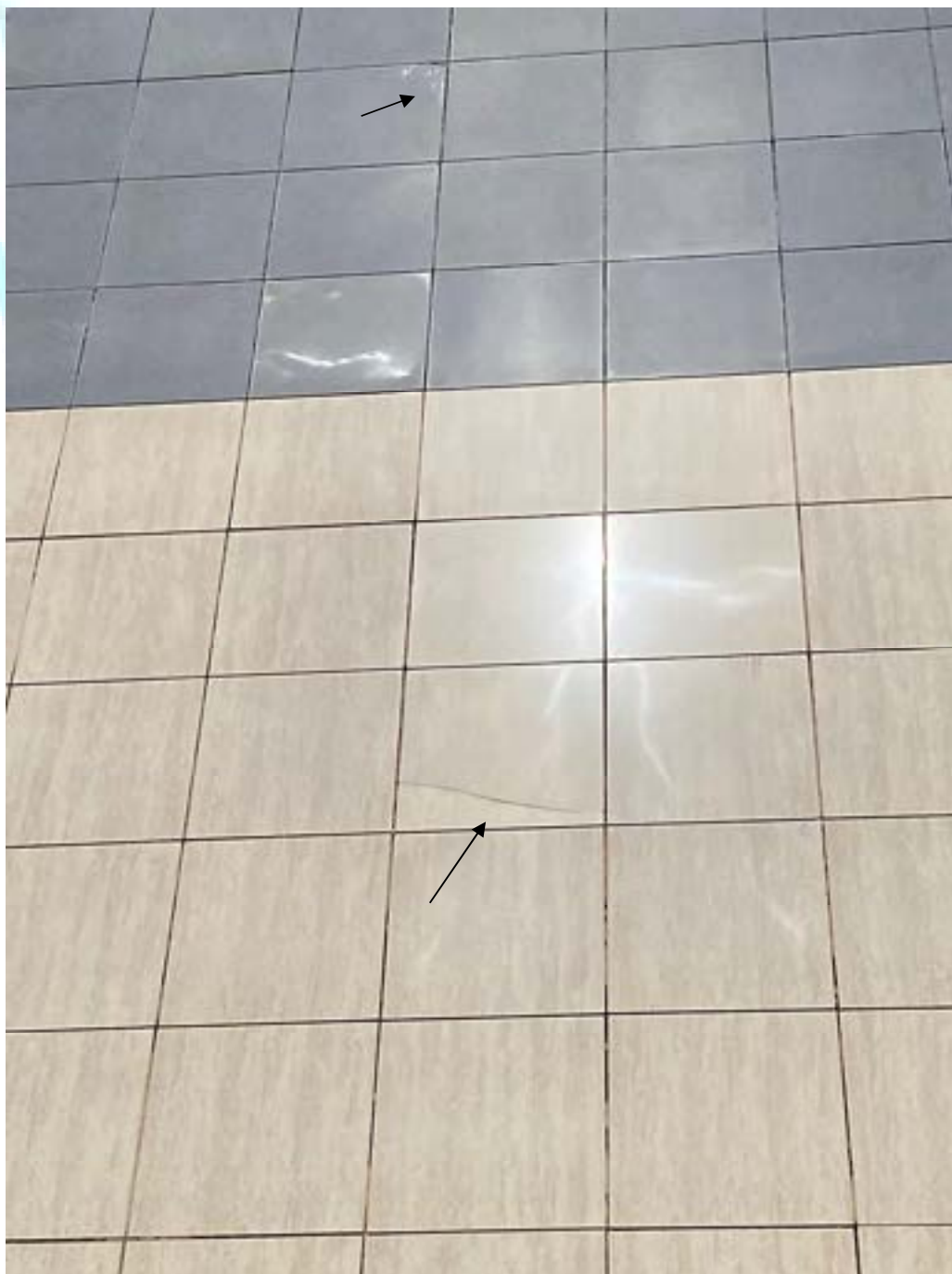
Figura 25 – Revestimento apresentando trinca e ponto de eflorescência
