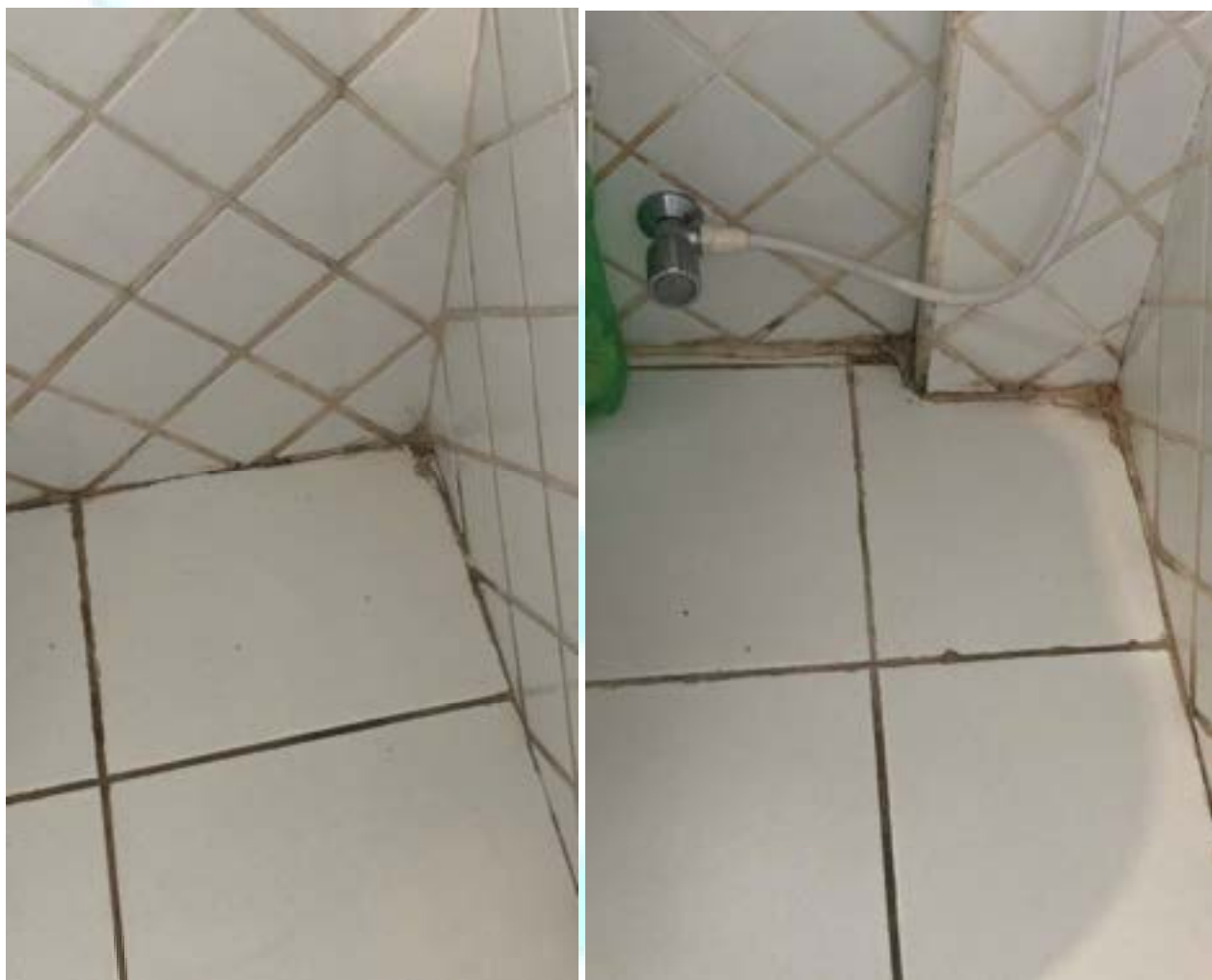
Figura 177 - deterioração do rejunte no encontro do piso com a parede do banheiro feminino
