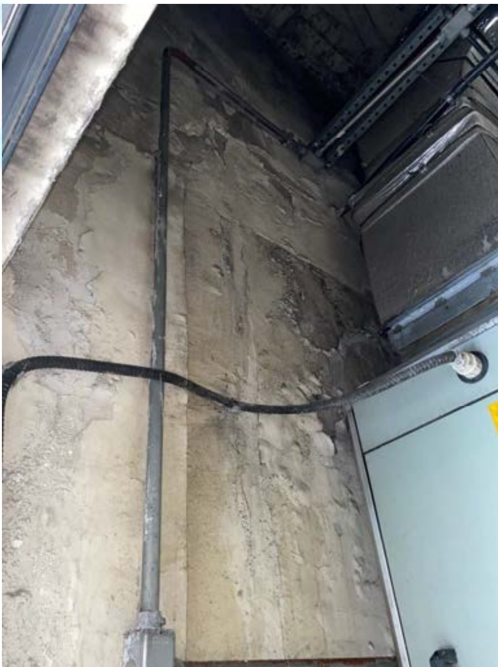
Figura 81 - Deterioração do emboço
