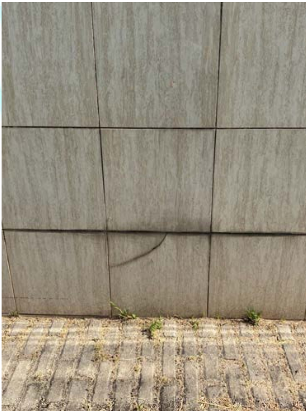
Figura 44 - Revestimento cerâmico com trinca ausência de rejunte
