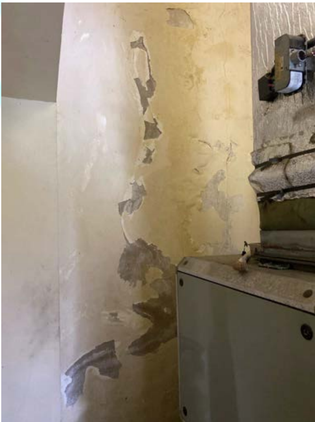
Figura 75 - Degradação do emboço interno
