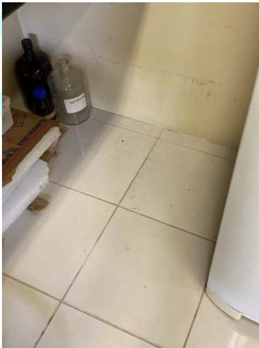
Figura 284 – Sujidades na parede e revestimentos do piso danificados
