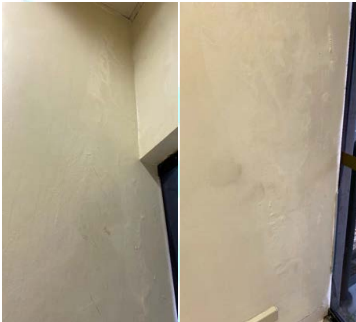
Figura 265 – Parede apresentando afafamento
