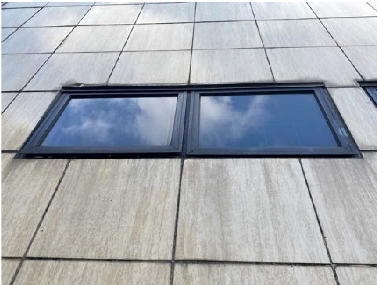
Figura 56 - deterioração do silicone da esquadria
