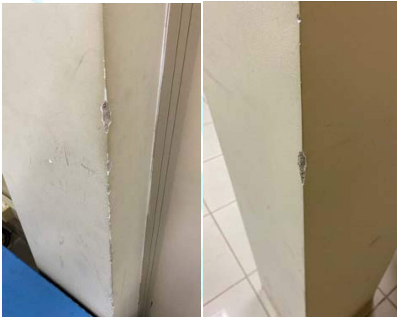
Figura 235 – Deterioração na quina do pilar
