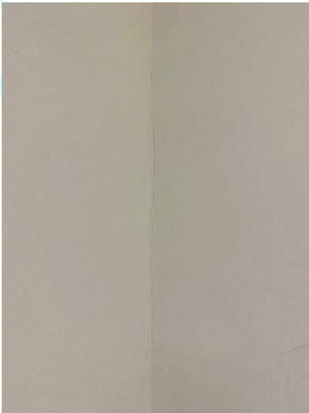
Figura 149 – Fissura no encontro das alvenarias na sala do hall posterior direito
