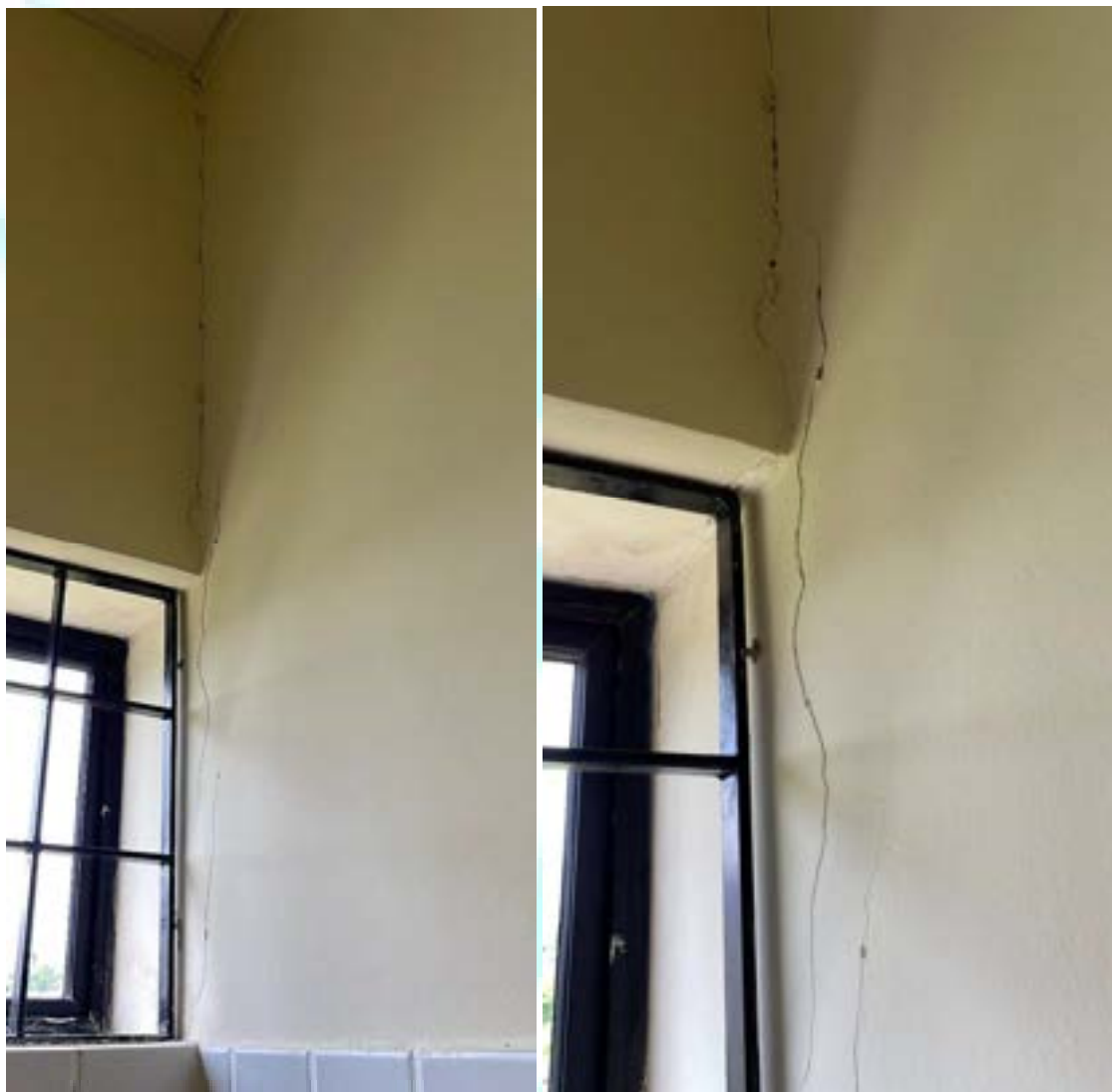
Figura 269 – Fissura no encontro das alvenarias
