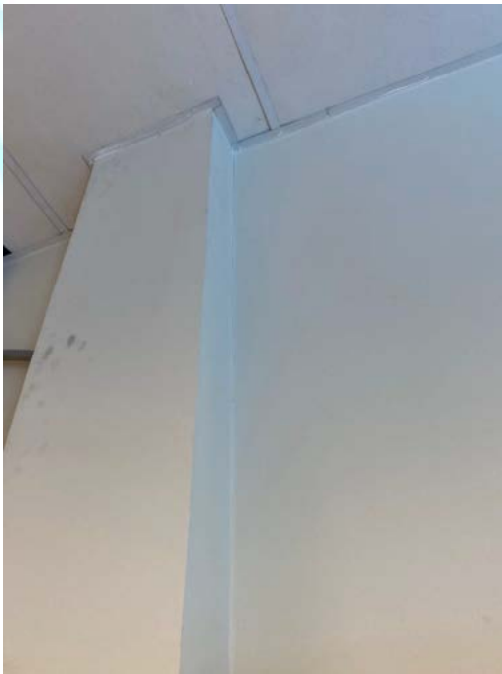
Figura 258 – Fissura no encontro do pilar com a alvenaria na sala 08
