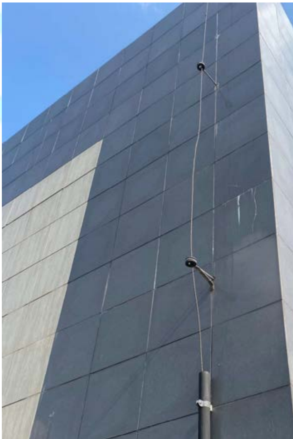
Figura 40 – Pontos de sujidades e eflorescência no revestimento
