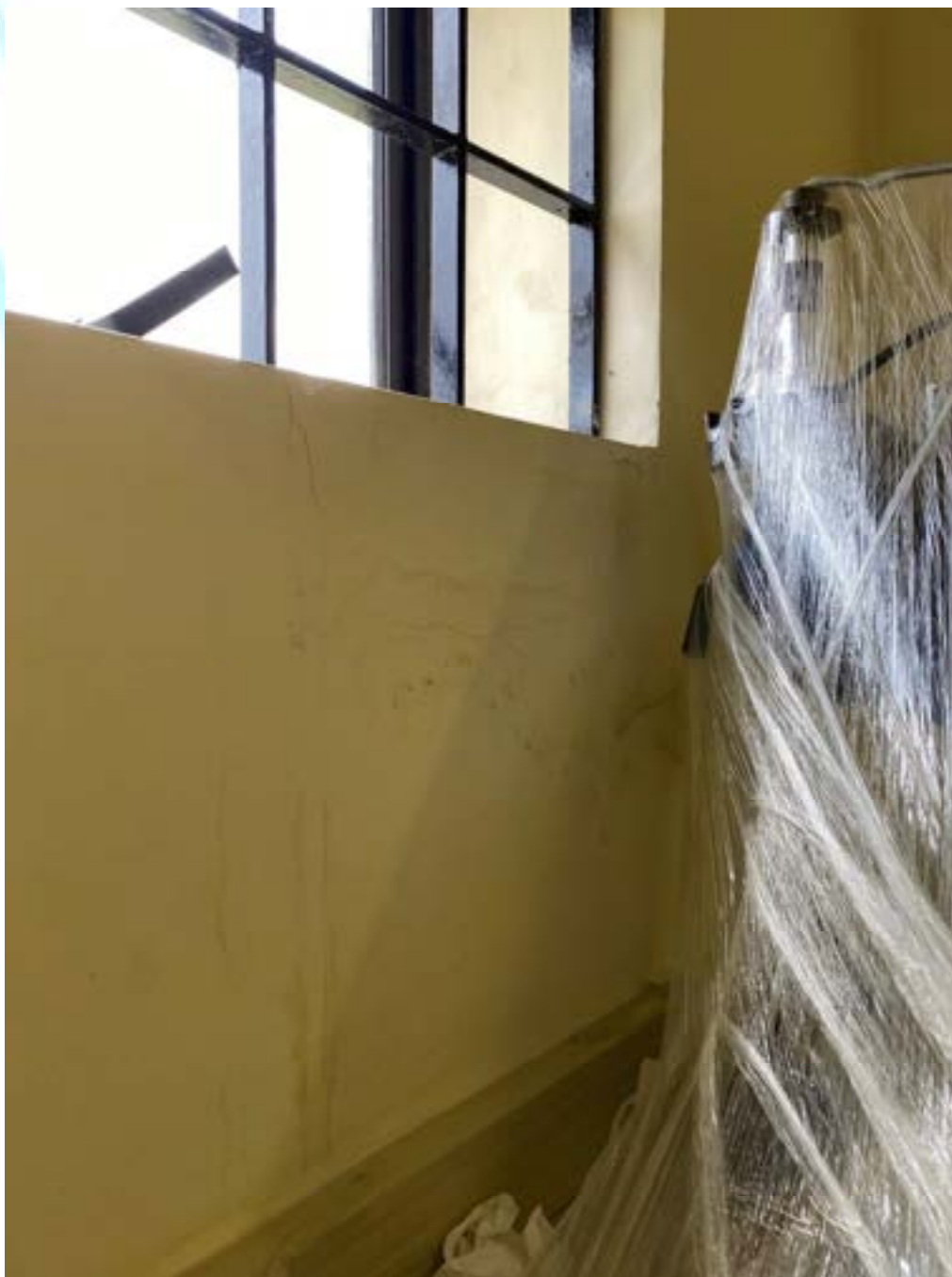
Figura 270 – Fissura e umidade na parede
