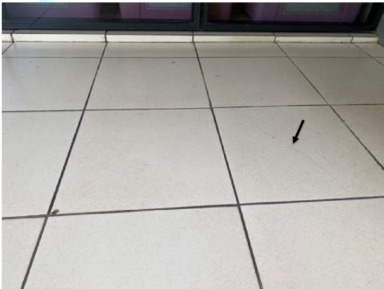
Figura 10 – Fissura no revestimento do piso
