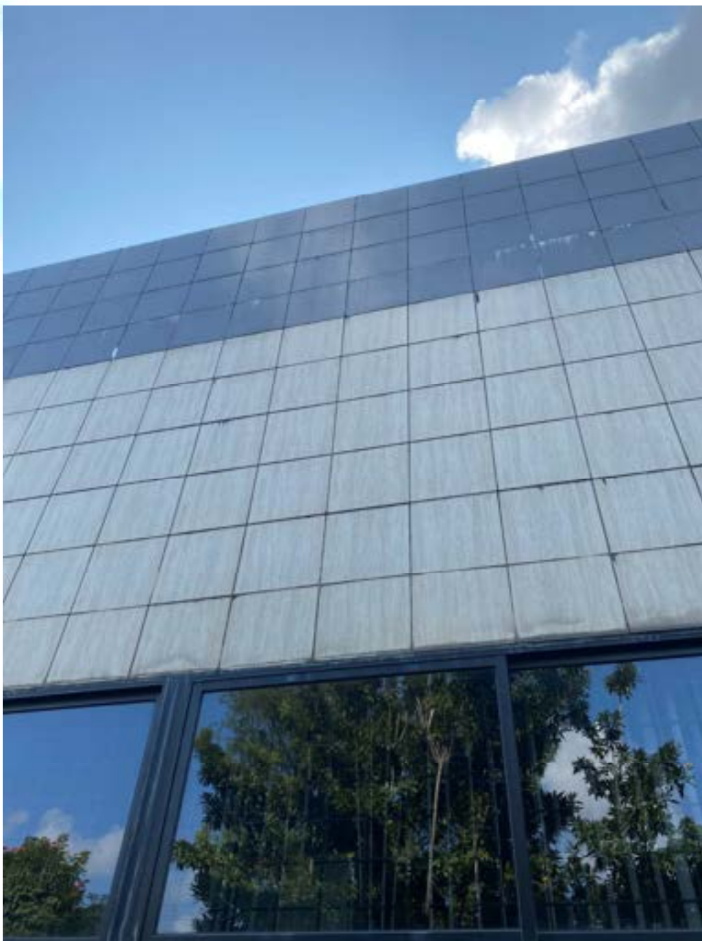
Figura 62 – Revestimento apresentando eflorescência e sujidades
