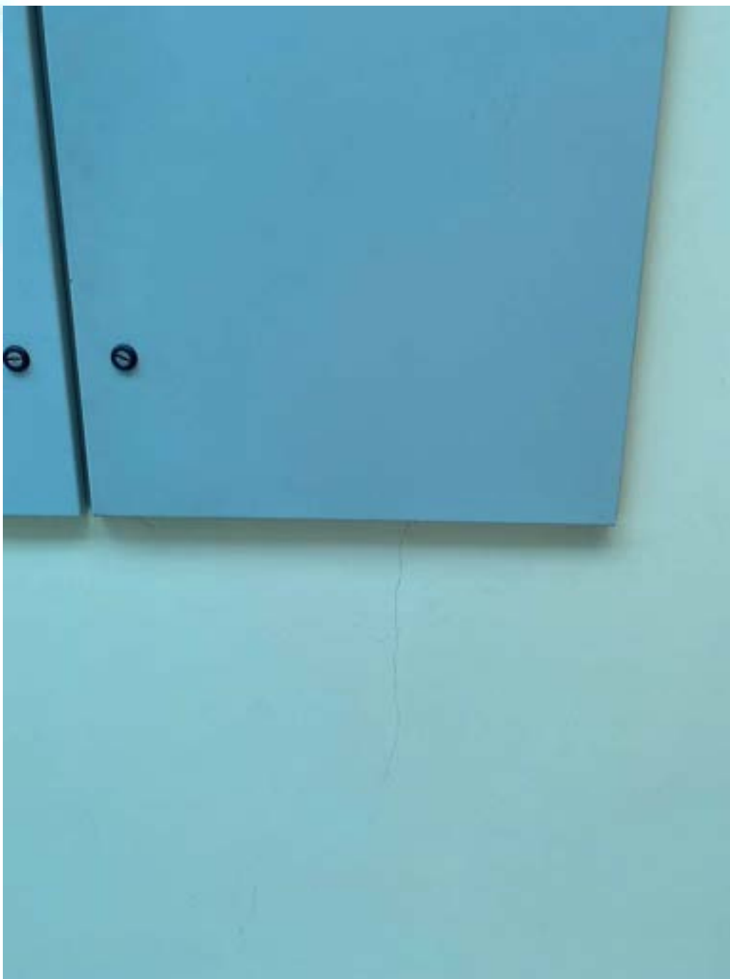
Figura 129 – Fissura na parede
