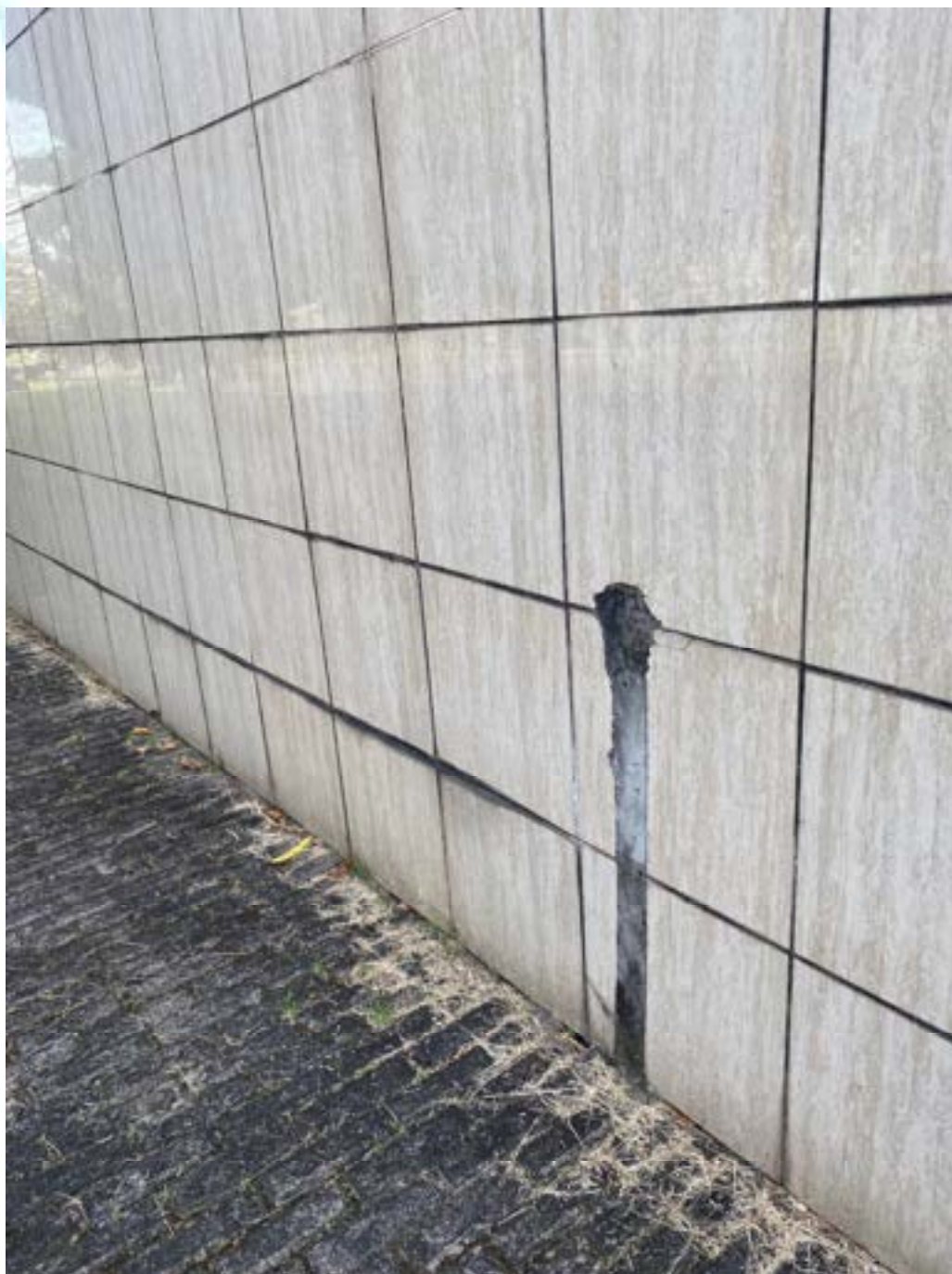
Figura 54 – Cerâmicas danificadas por reparo para intervenção hidráulica
