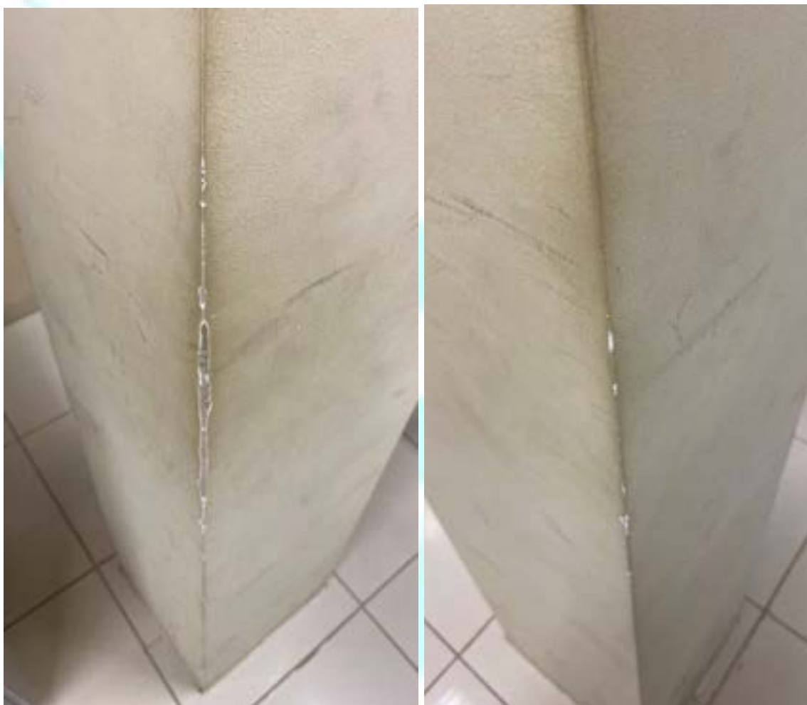
Figura 234 – Deterioração na quina do pilar
