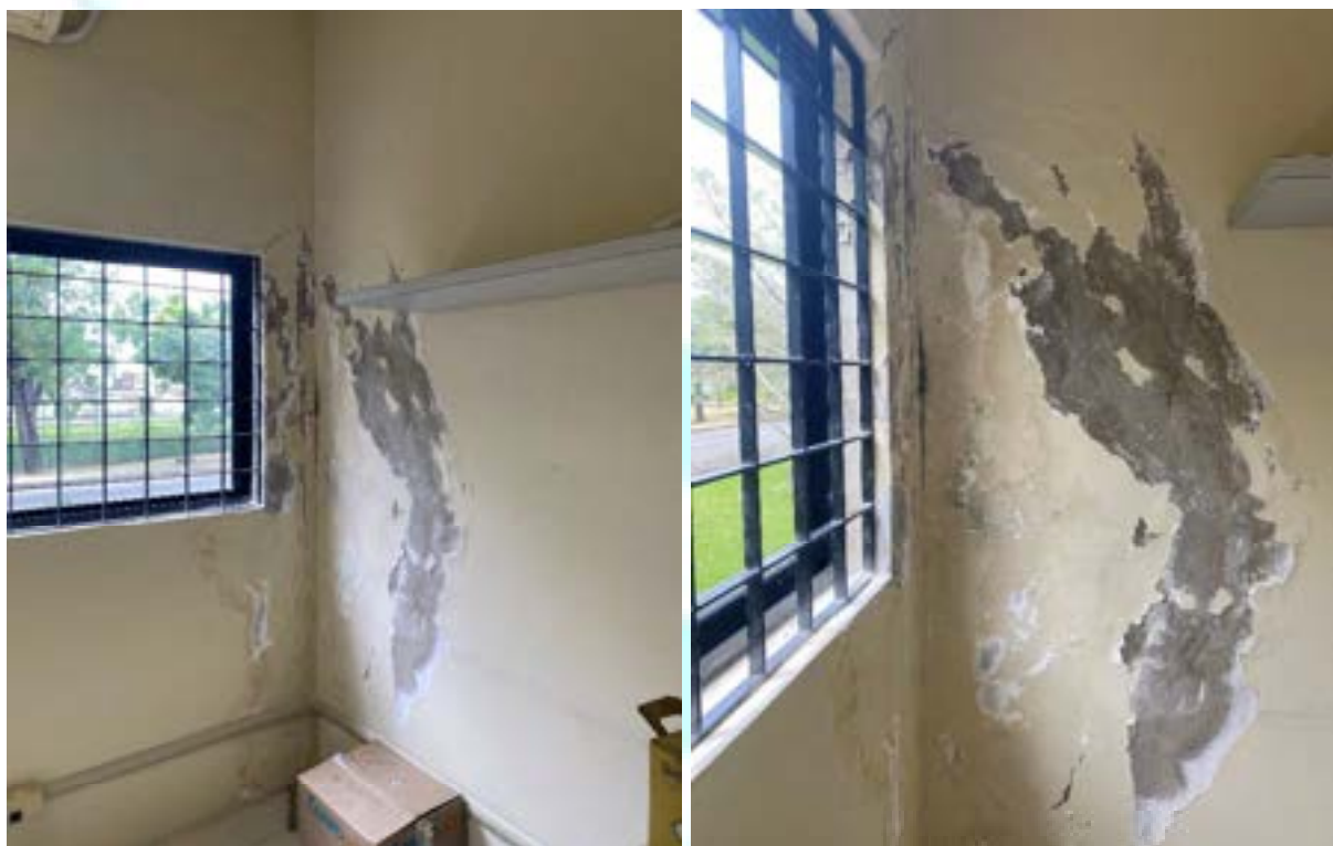
Figura 168 – Afofamento e degradação na parede
