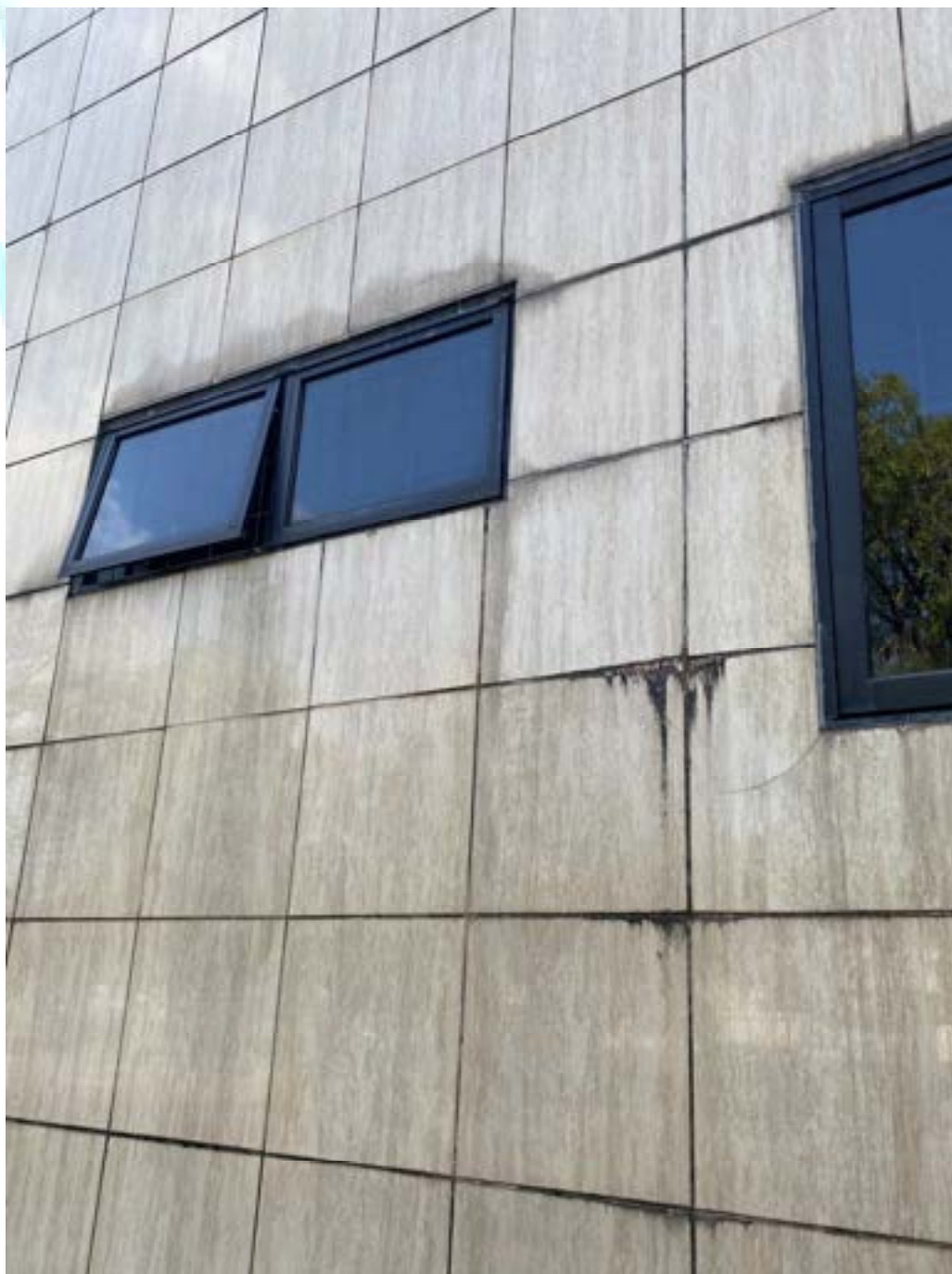
Figura 64 – Fissura na quina inferior da janela e sujidades nos revestimentos
