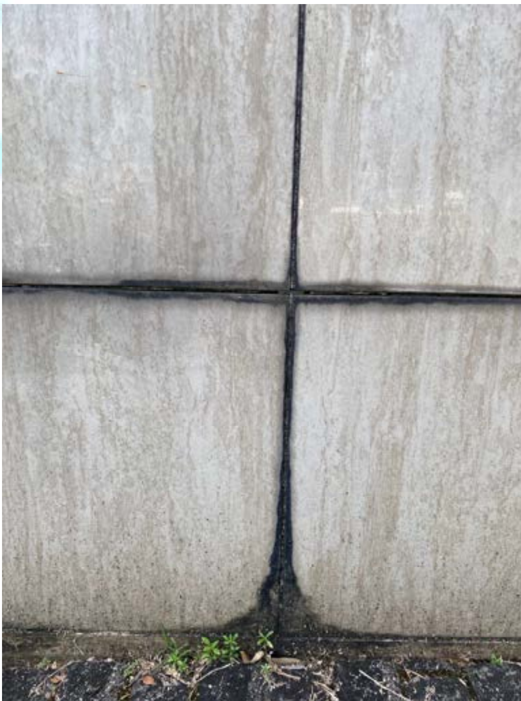
Figura 65 – Sujidades e ausência de rejunte no revestimento
