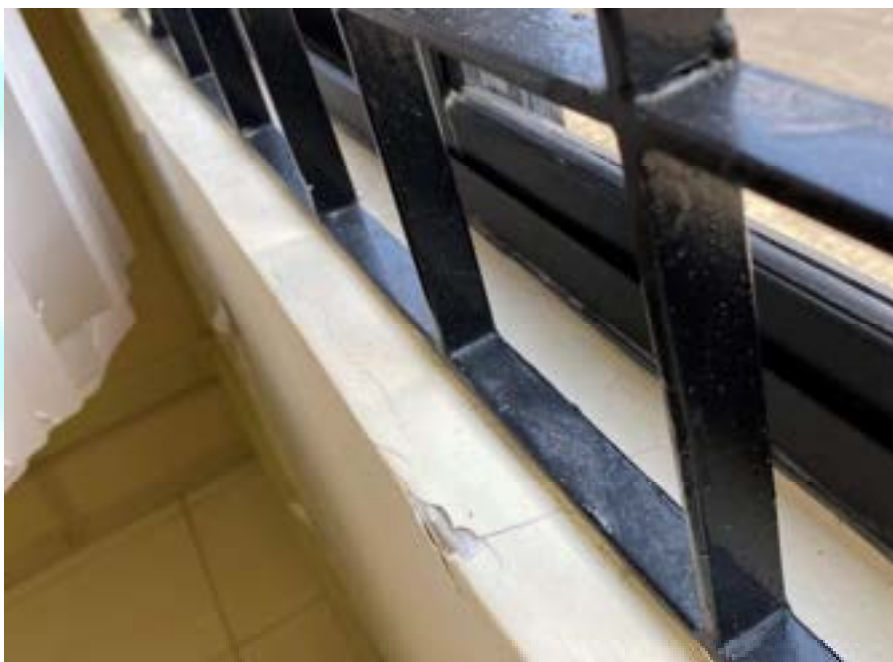
Figura 260 – Descamação no peitoril da sala 08A
