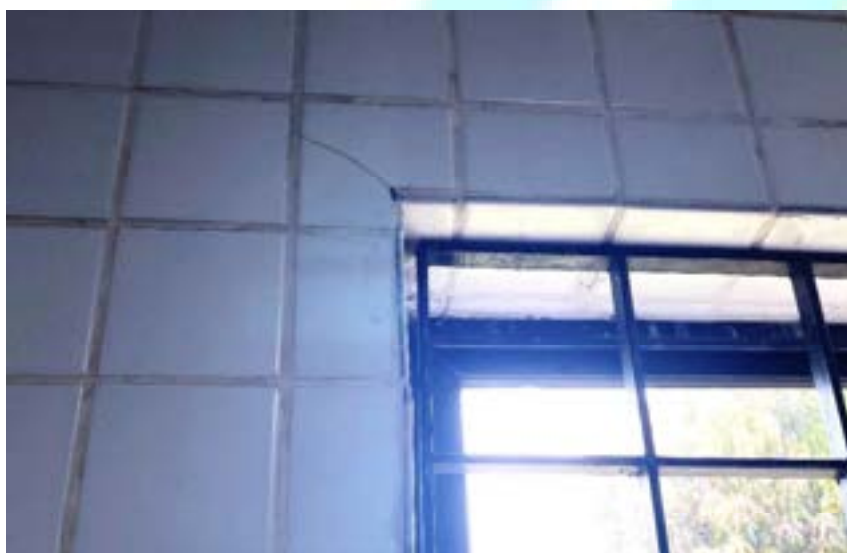
Figura 188 – Fissura no revestimento da parede no banheiro feminino
