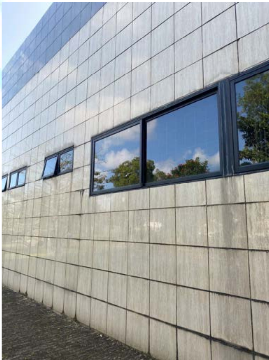
Figura 63 – Revestimento apresentando eflorescência e sujidades
