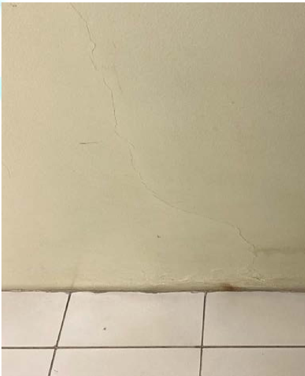
Figura 154 – Fissura na parede
