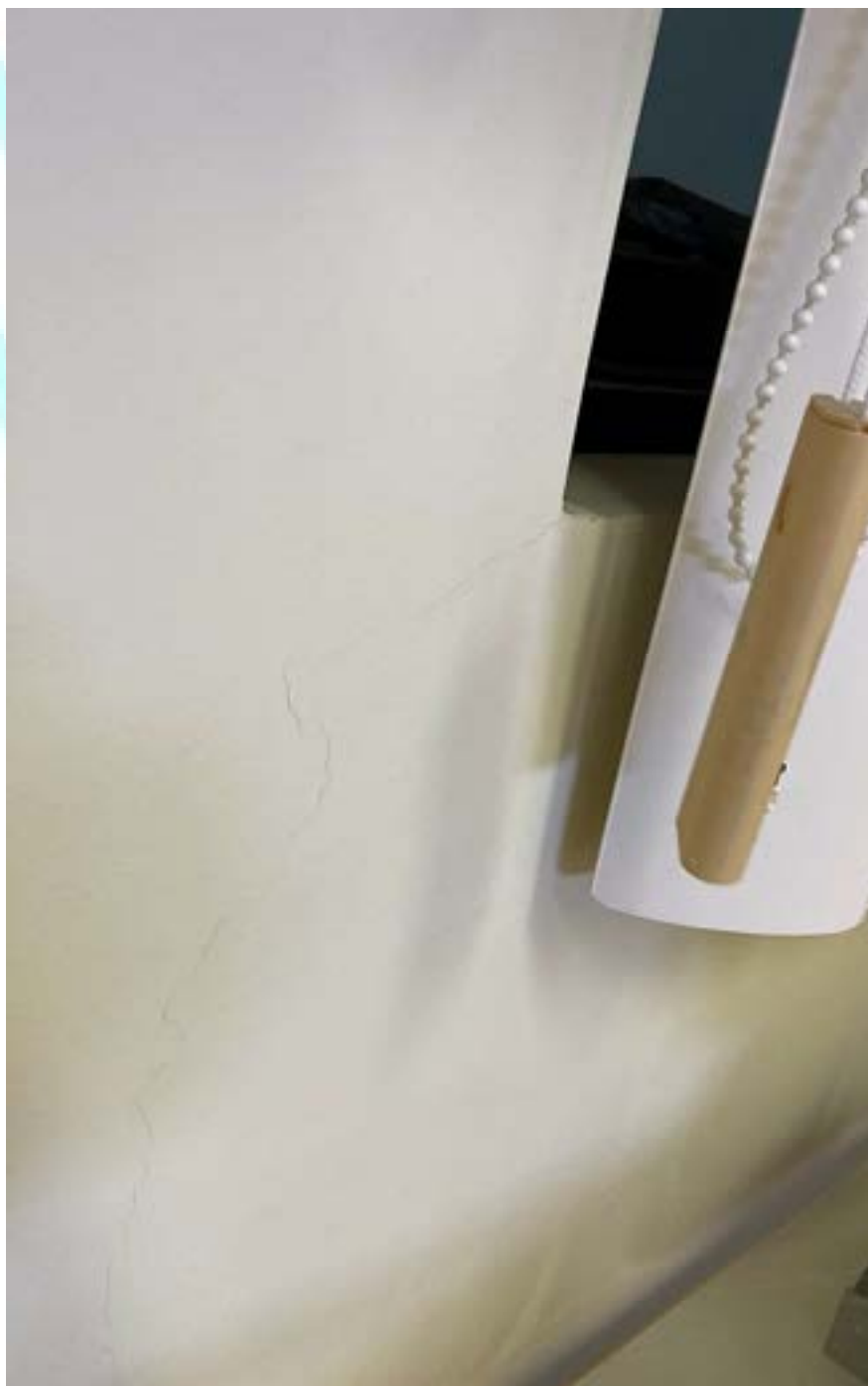
Figura 271 – Fissura na parede
