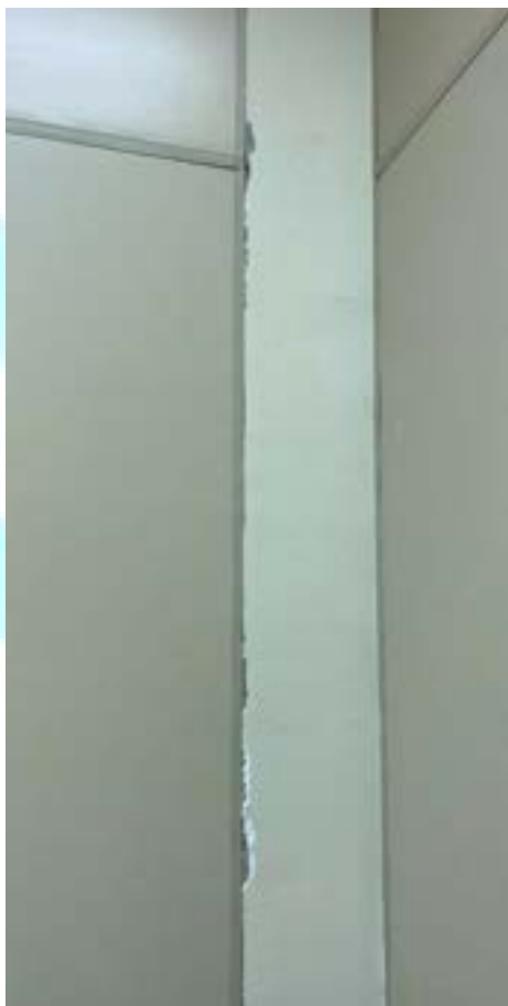
Figura 219 – Deterioração na quina do pilar na sala 03B
