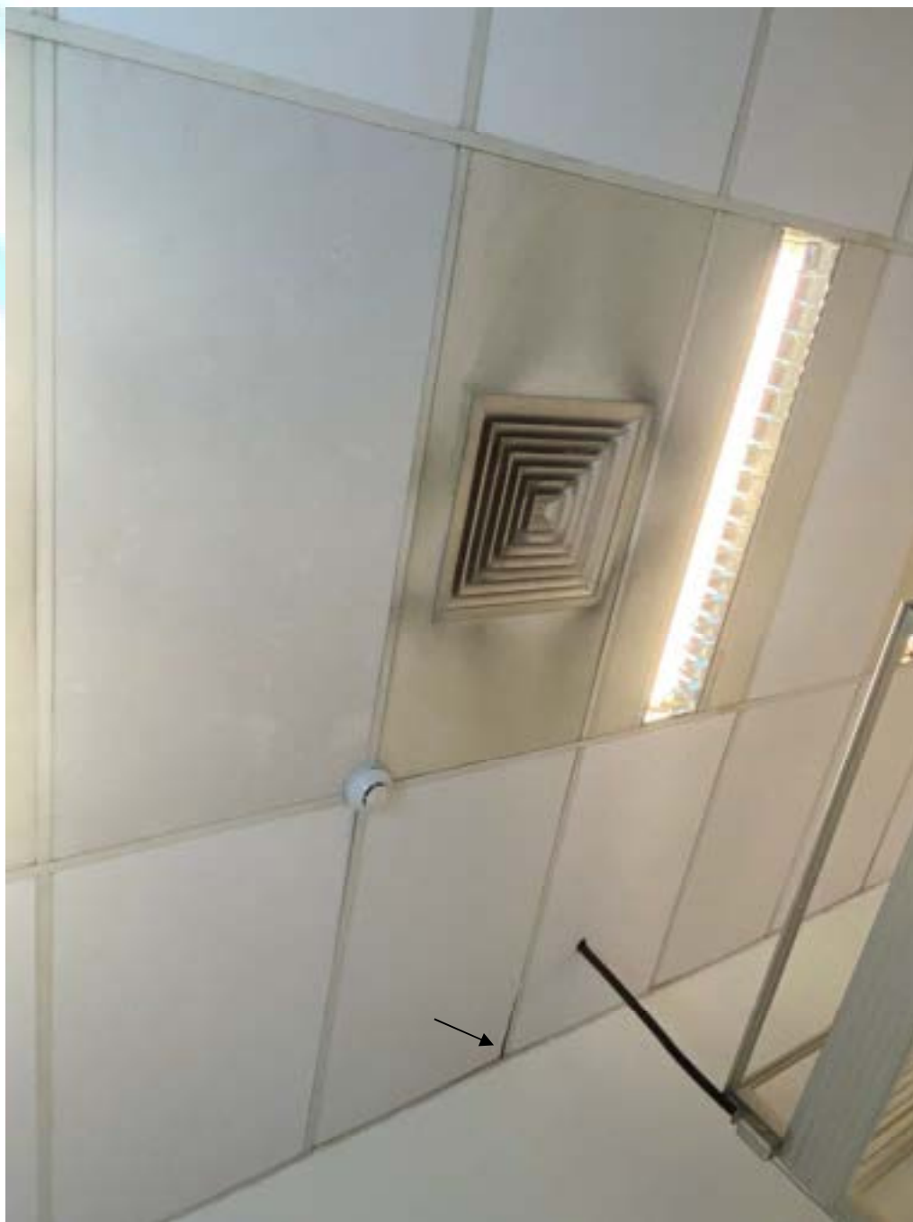
Figura 285 – Sujidades no forro e tampa do forro desencaixada
