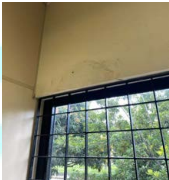
Figura 169 – Umidade na parede
