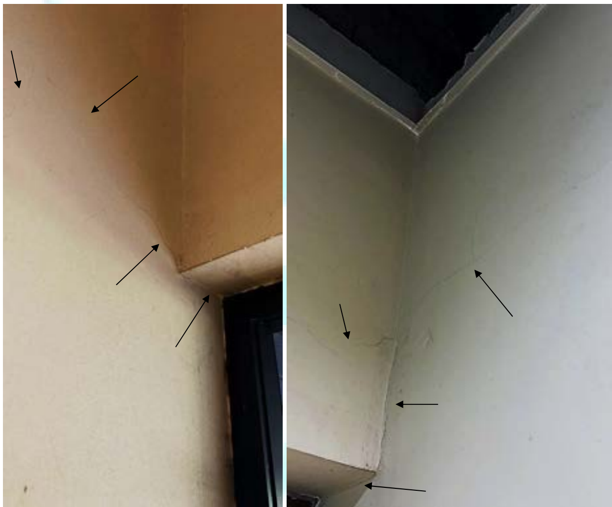
Figura 156 – Fissuras na parede
