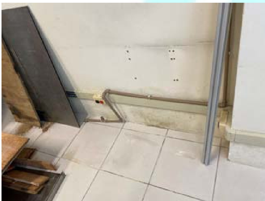
Figura 256 – Sujidades na parede e manchas no piso na sala 08
