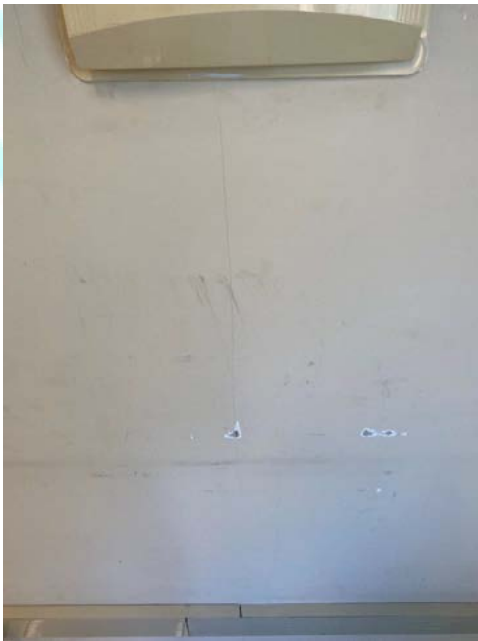
Figura 255 – Fissura na parede da sala 08
