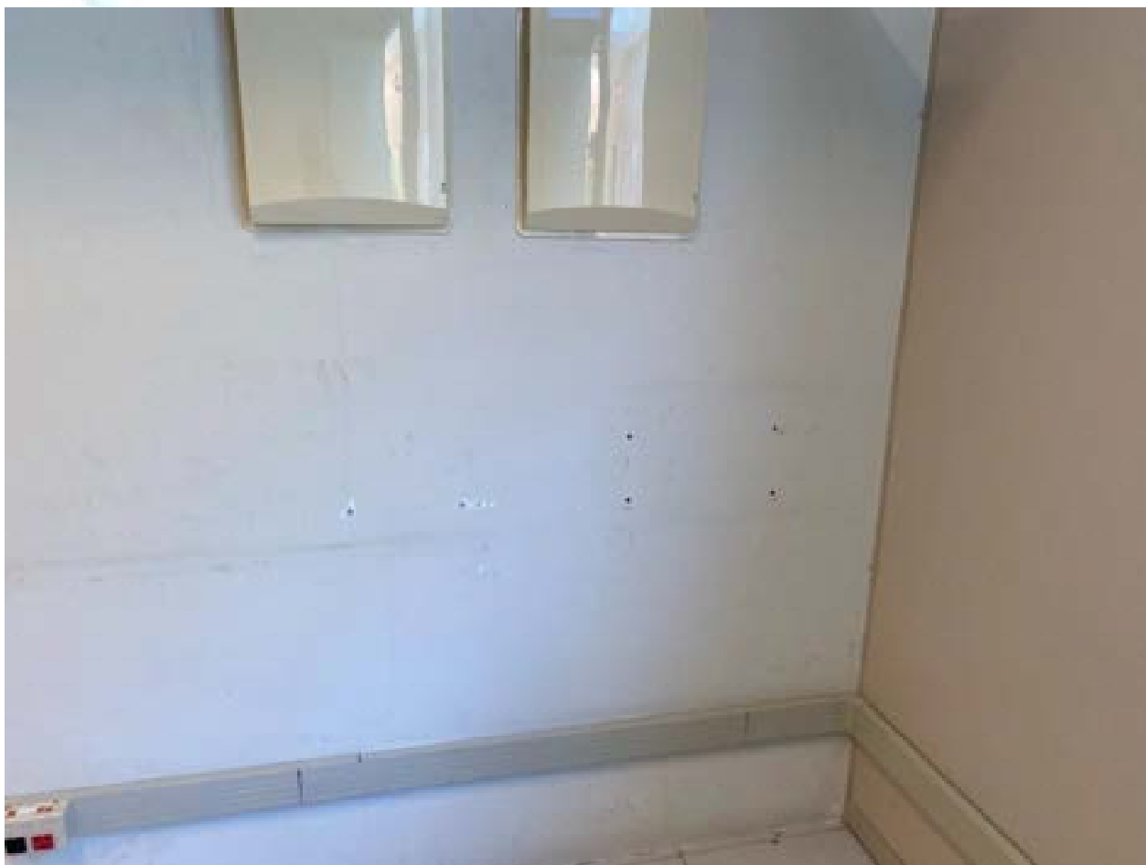
Figura 254 – Perfurações e sujidades na parede da sala 08
