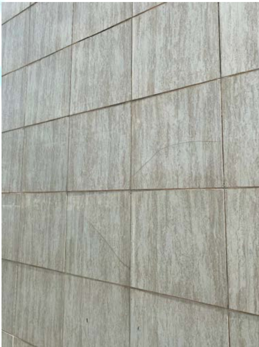
Figura 45 – Fissuras no revestimento e ausência de rejunte
