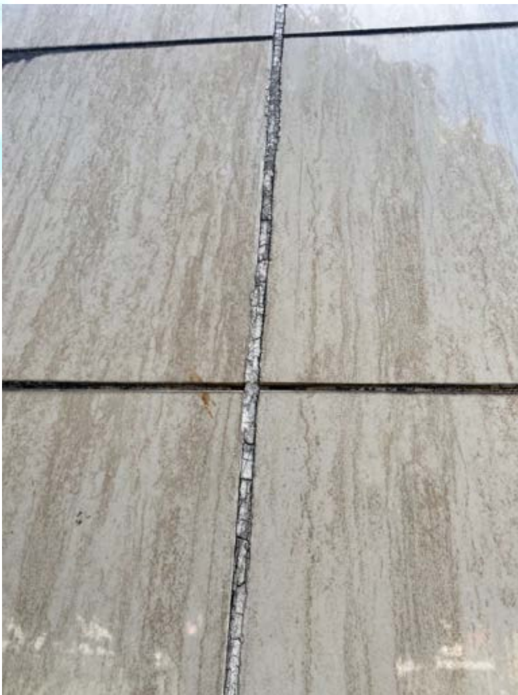
Figura 58 - junta de dilatação degradada, necessitando de substituição
