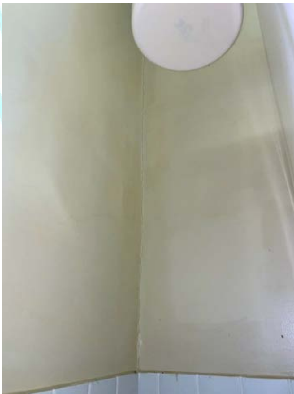
Figura 282 – Fissura no encontro das alvenarias
