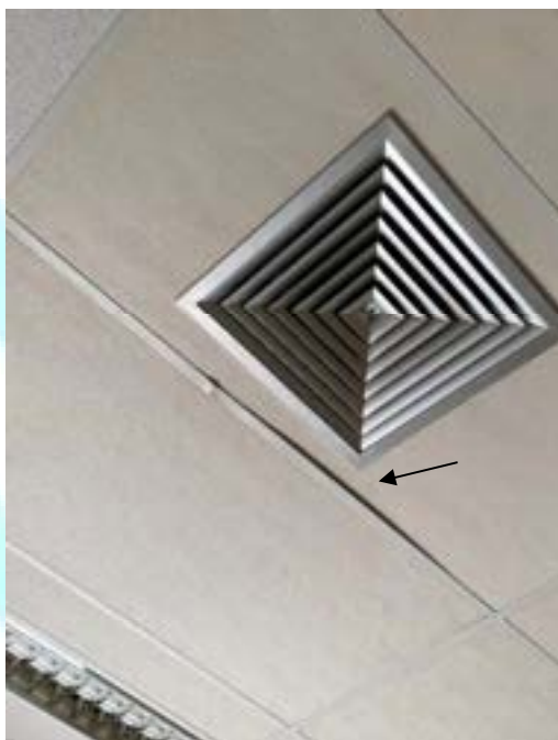
Figura 215 – Degradação do perfil de sustentação de placas de forro
