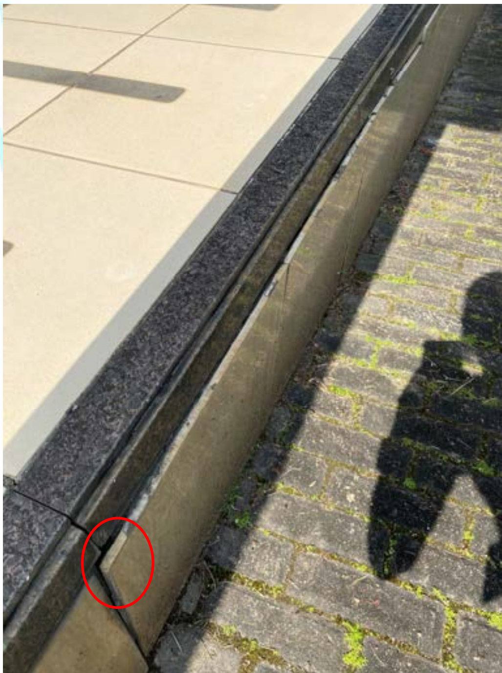
Figura 20 – Deslocamento do revestimento e ausência de revestimento na lateral da rampa
