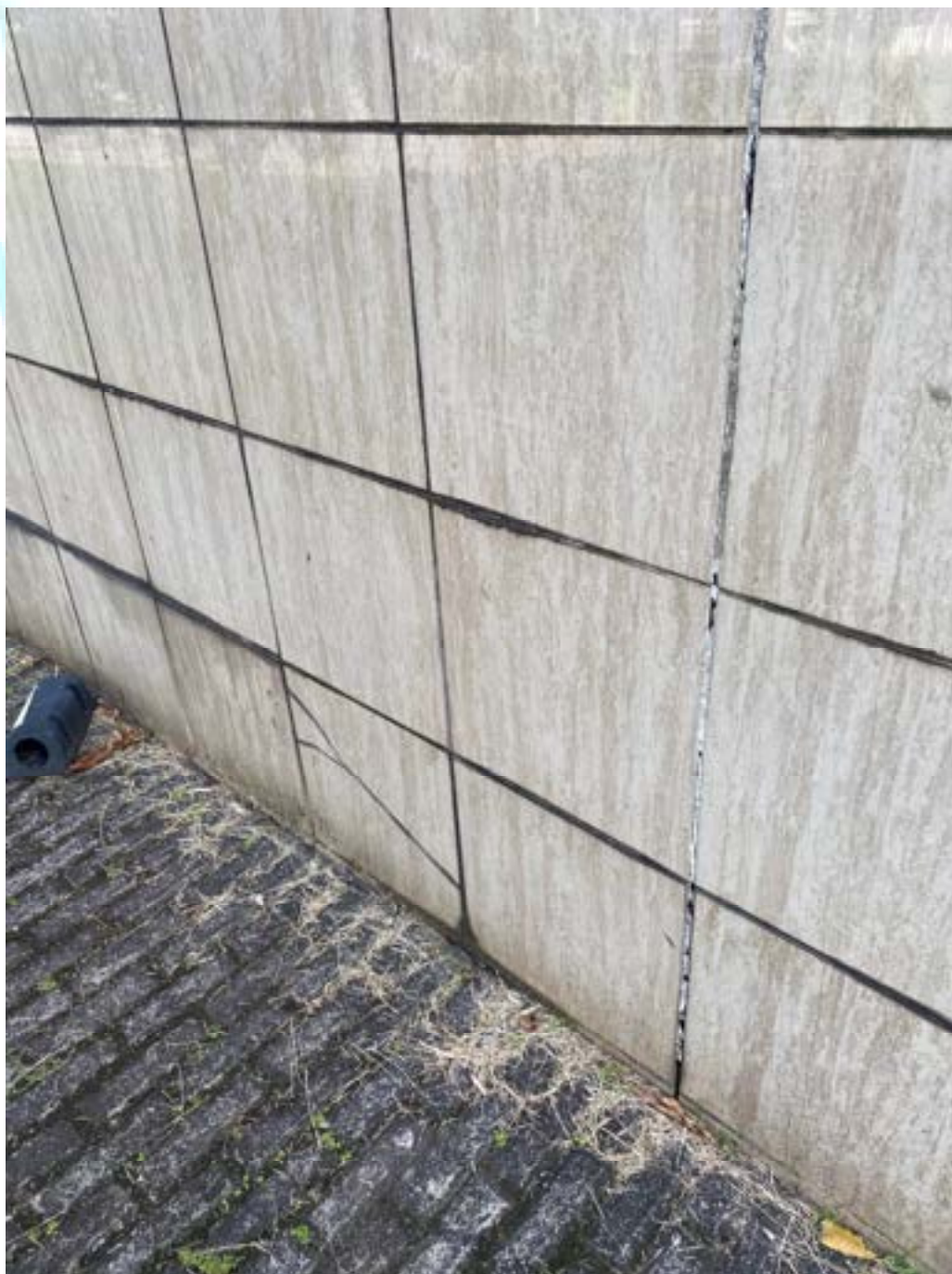
Figura 57 – Revestimento apresentando eflorescência, sujidades e trincas
