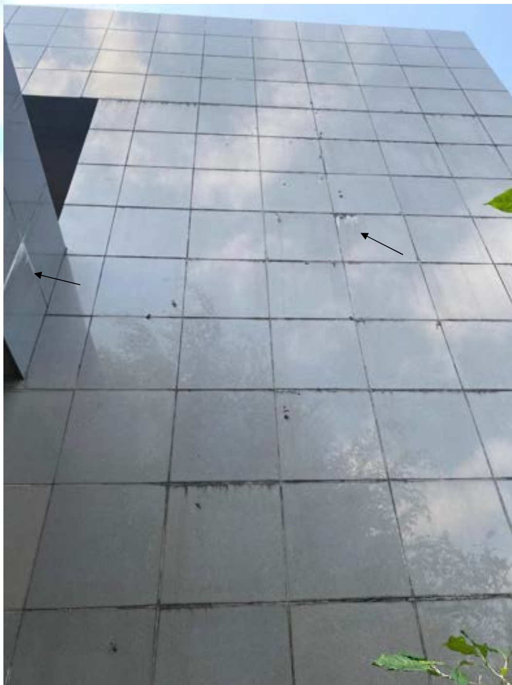
Figura 3 – Pontos de sujidades e eflorescência no revestimento
