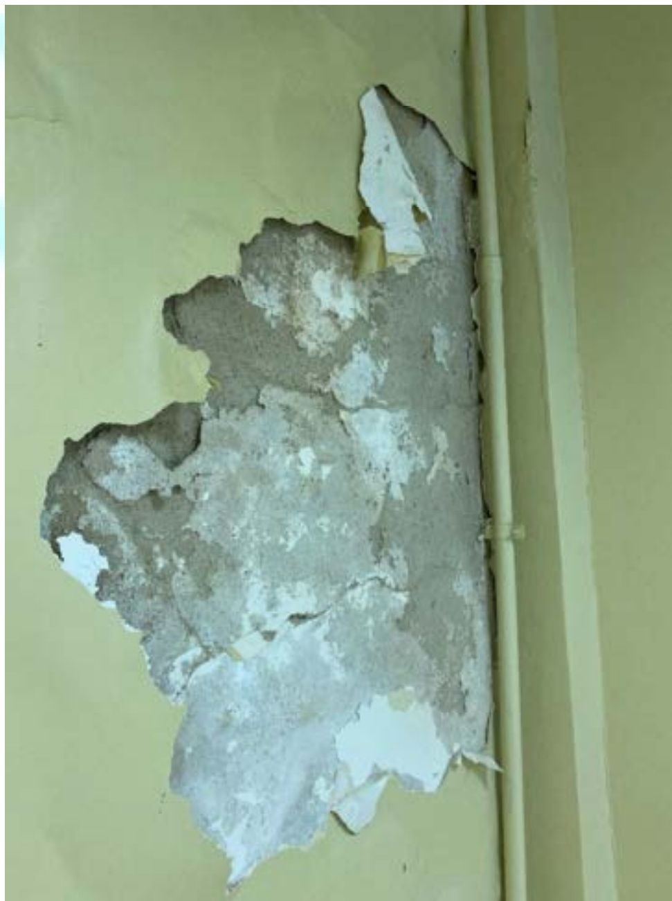
Figura 142 – Afofamento e degradação na parede
