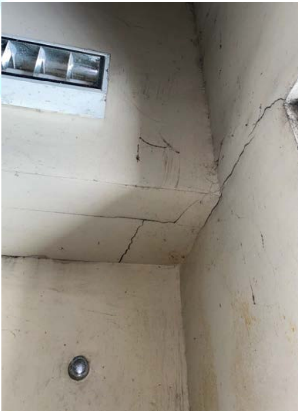
Figura 80 – Fissura na alvenaria
