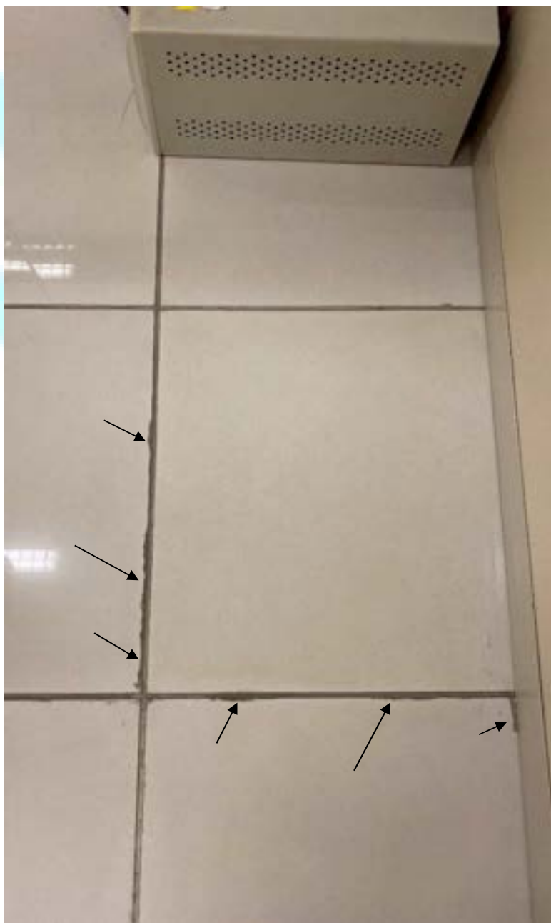
Figura 210 – Revestimentos do piso danificados da sala 02F
