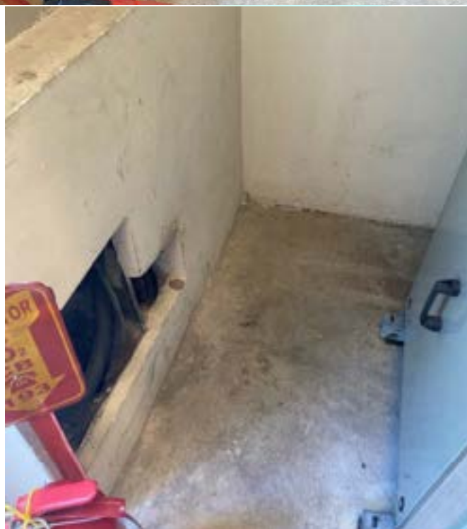
Figura 294 – Fissura no piso
