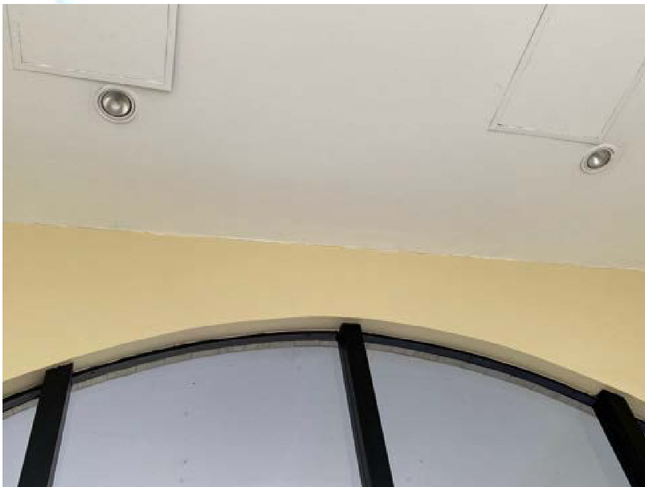
Figura 128 – Fissura no encontro da alvenaria com forro
