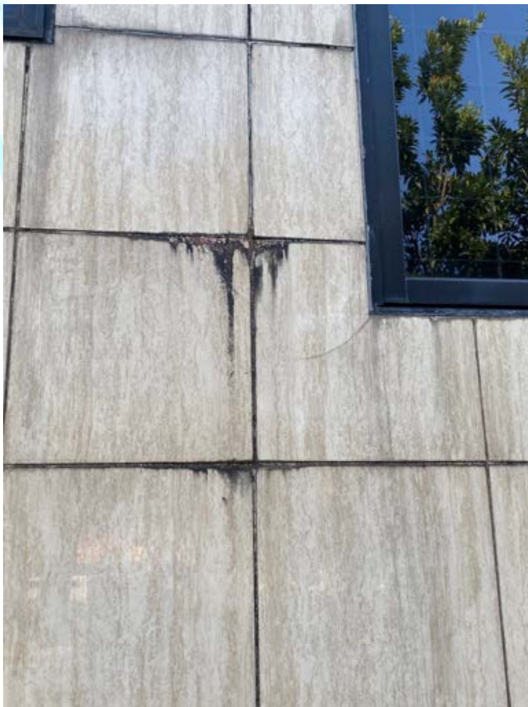
Figura 67 – Fissura na quina inferior da janela e sujeidade no revestimento
