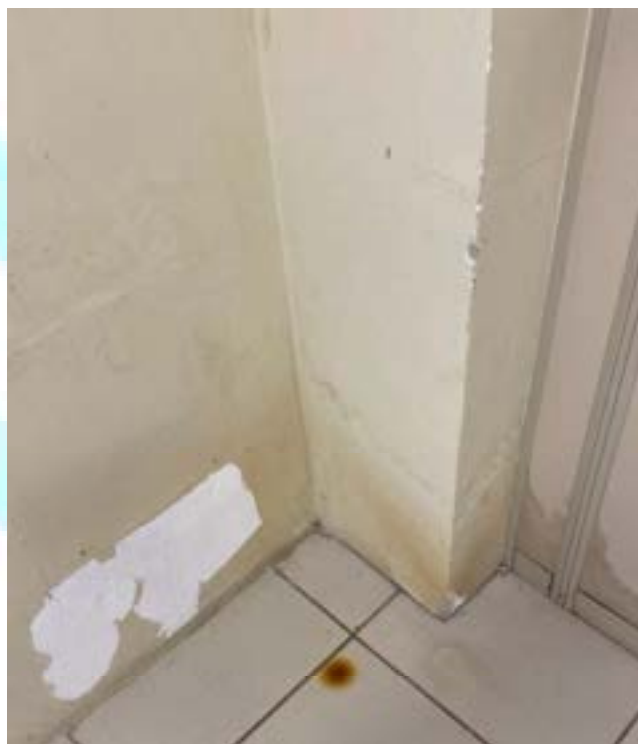
Figura 228 - Degradação na quina do pilar, umidade e sujidades na parede na sala 03E
