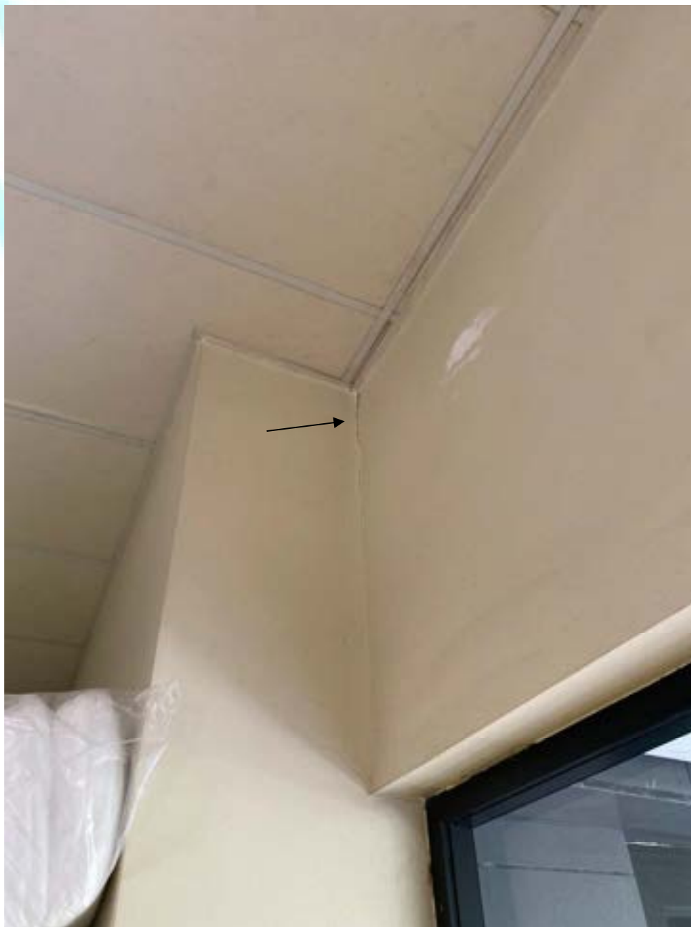
Figura 157 – Fissura no encontro das alvenarias
