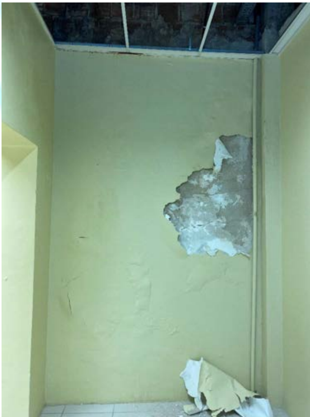
Figura 141 – Afofamento e degradação na parede e ausência das tampas do forro
