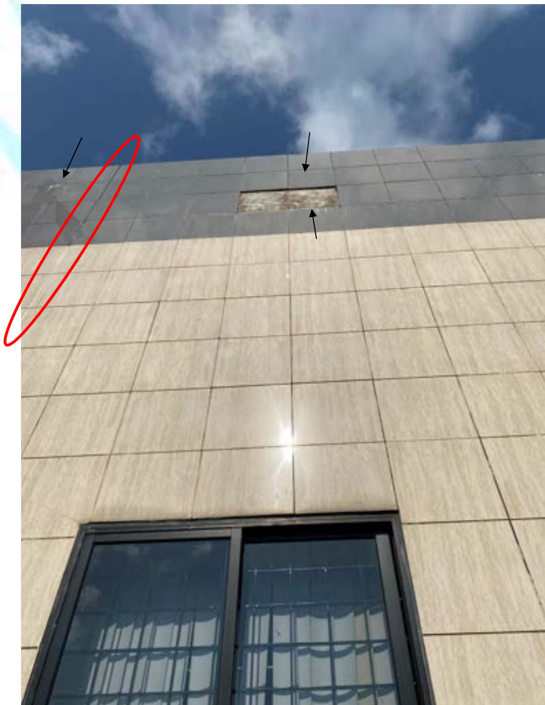
Figura 29 – Ausência de revestimento, pontos de eflorescências, sujidades no rejunte e deterioração da junta de dilatação
