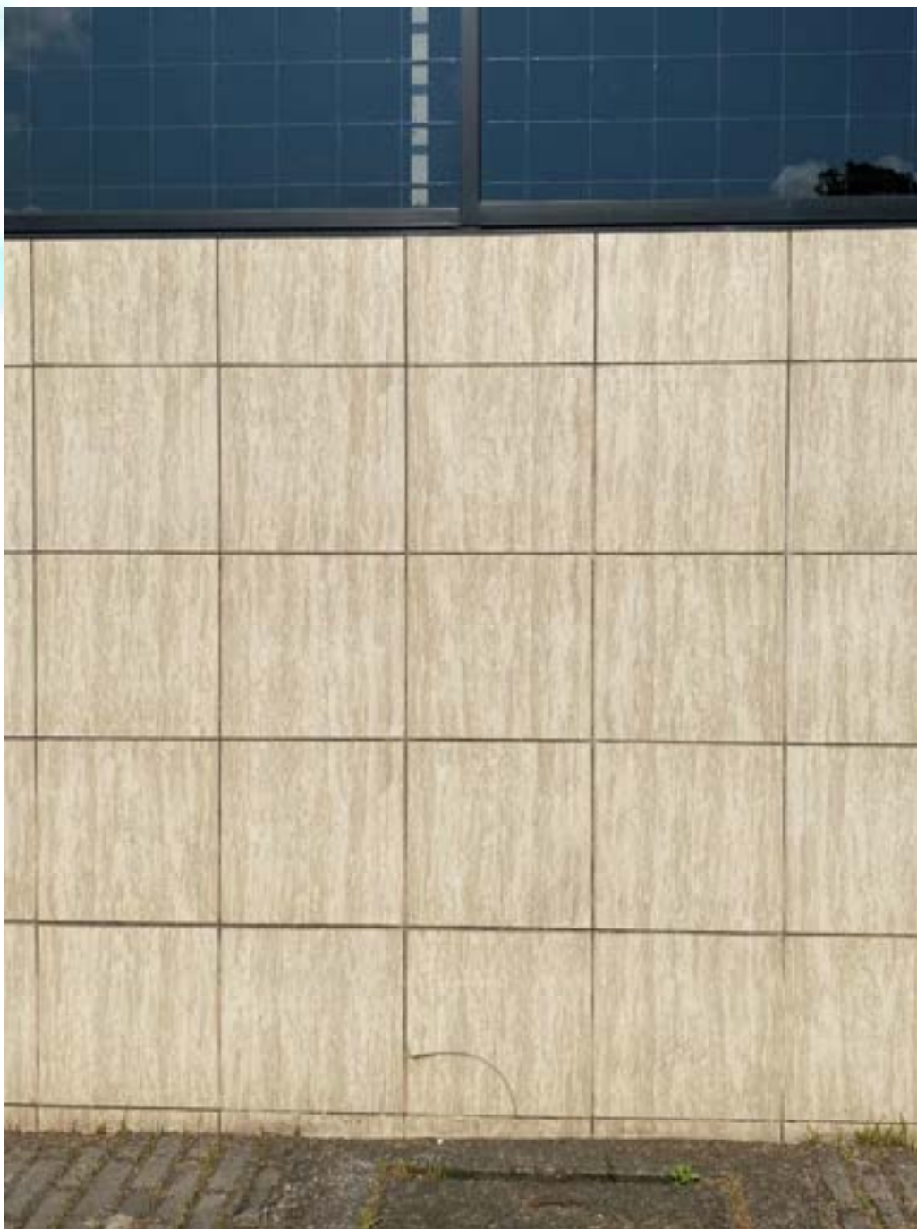
Figura 27 – Trinca em revestimento e sujidades nos rejuntas dos revestimentos
