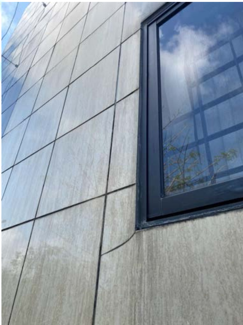
Figura 70 – Fissura na quina inferior da janela
