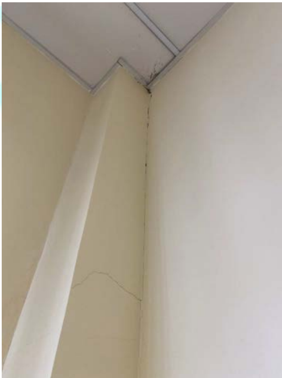
Figura 263 – Fissura no pilar e no encontro da parede com o pilar na sala 08A
