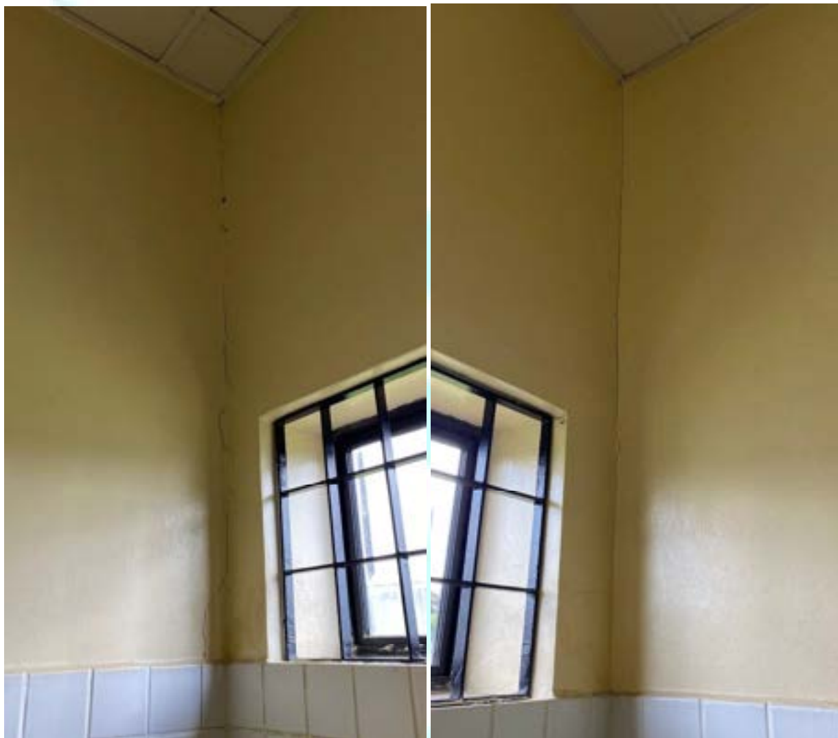
Figura 276 – Fissura no encontro das alvenarias
