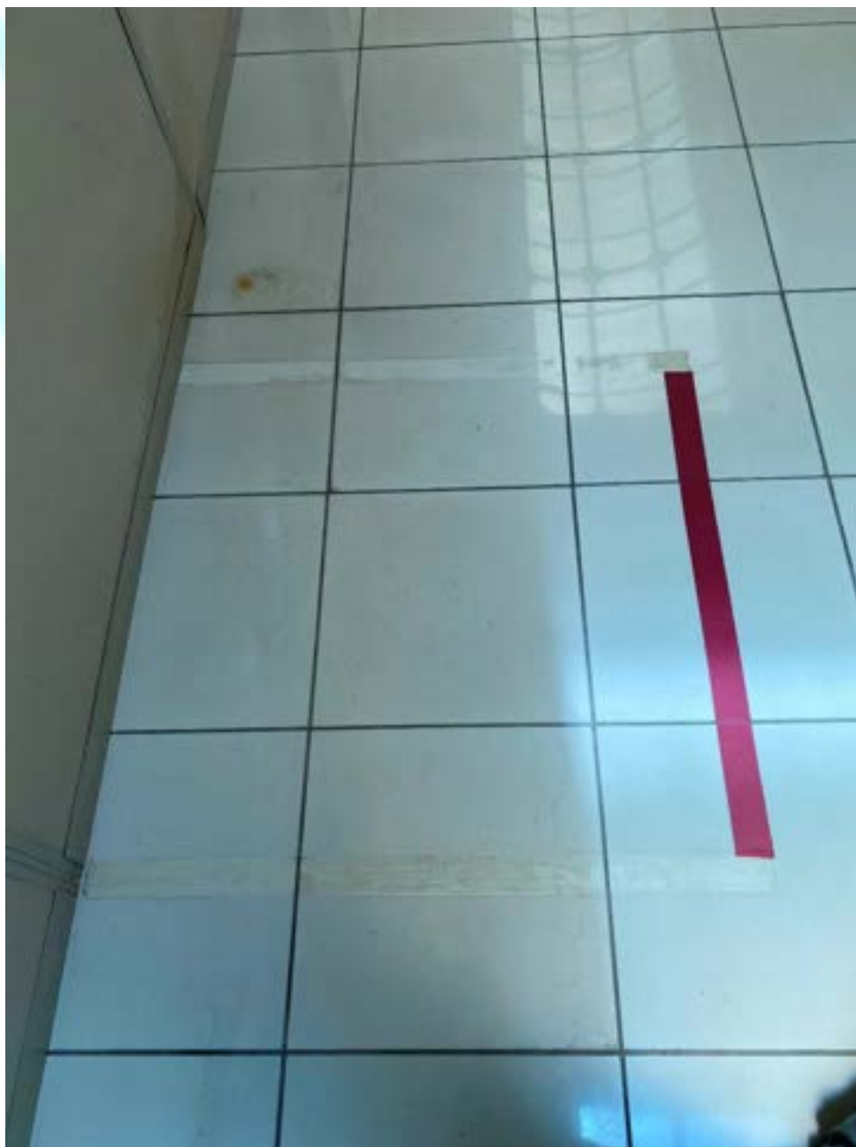
Figura 138 – Ausência da fita de demarcação no piso de extintor e sujidades nos revestimentos do piso
