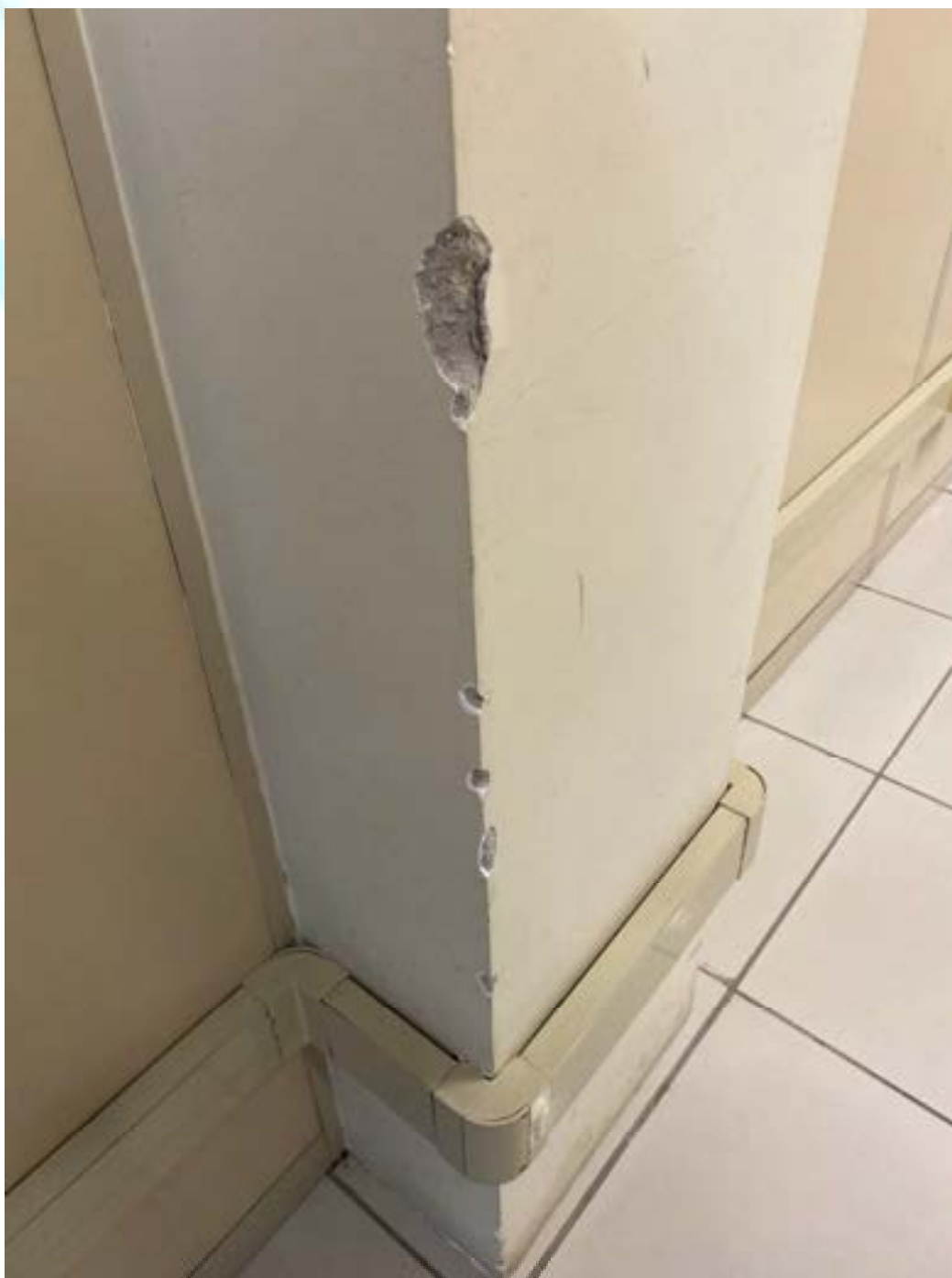
Figura 248 – Deterioração na quina do pilar na sala 07
