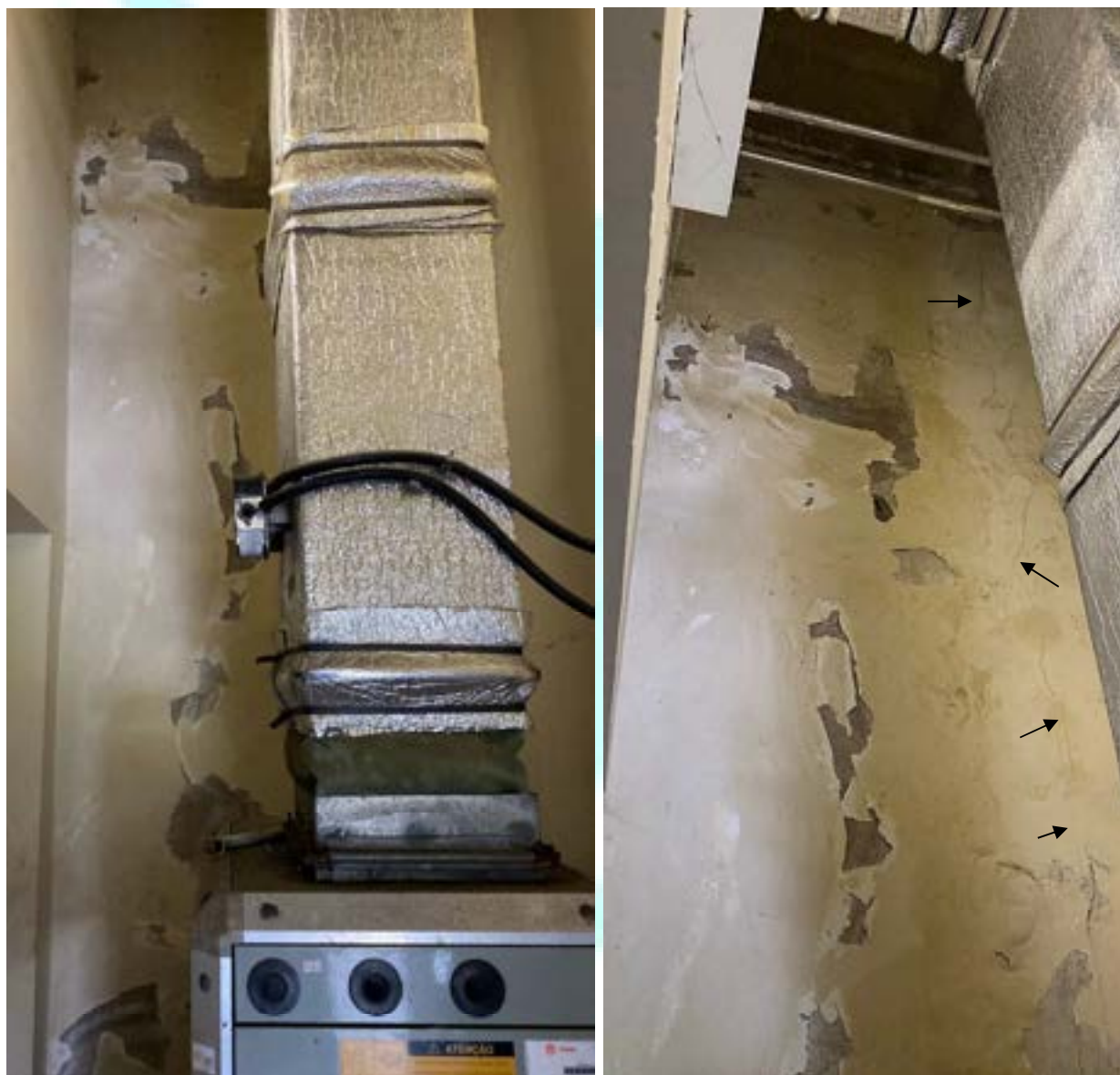
Figura 74 - Degradação do emboço interno e fissuras longitudinais
