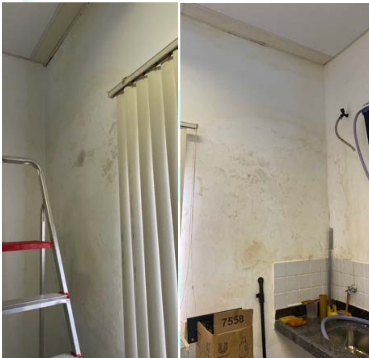
Figura 286 – Infiltração na parede
