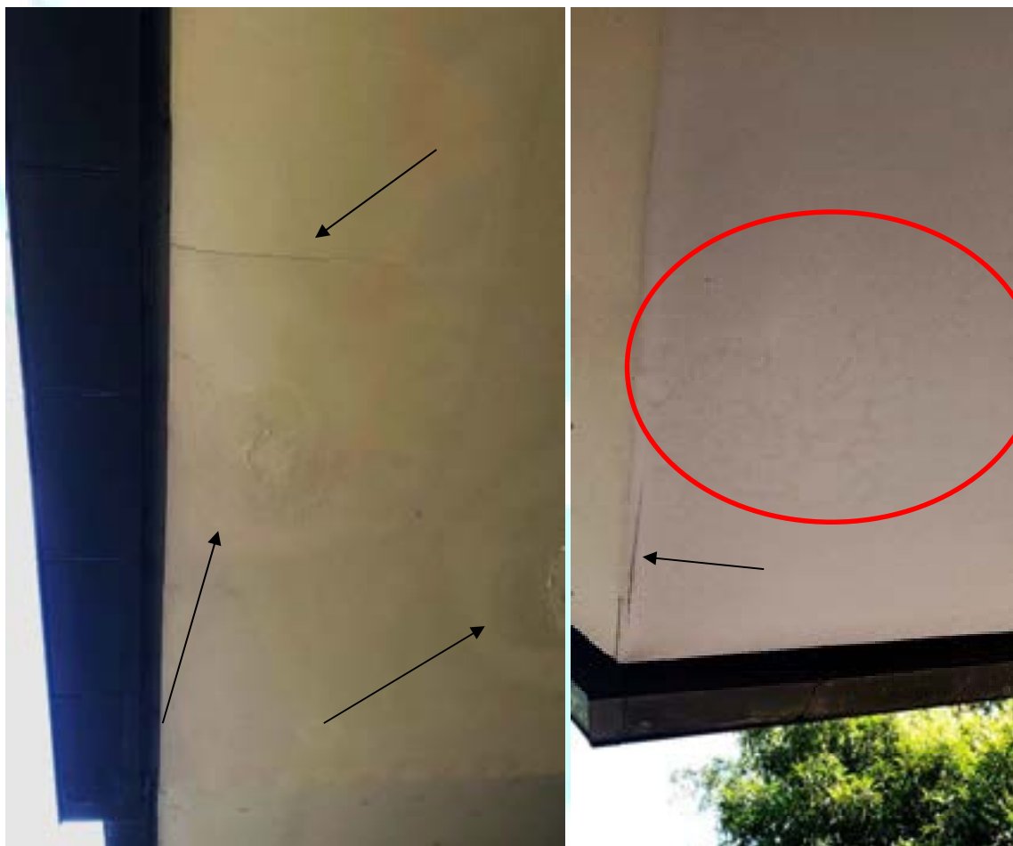
Figura 108 – Fissura e infiltração no forro de gesso da marquise
