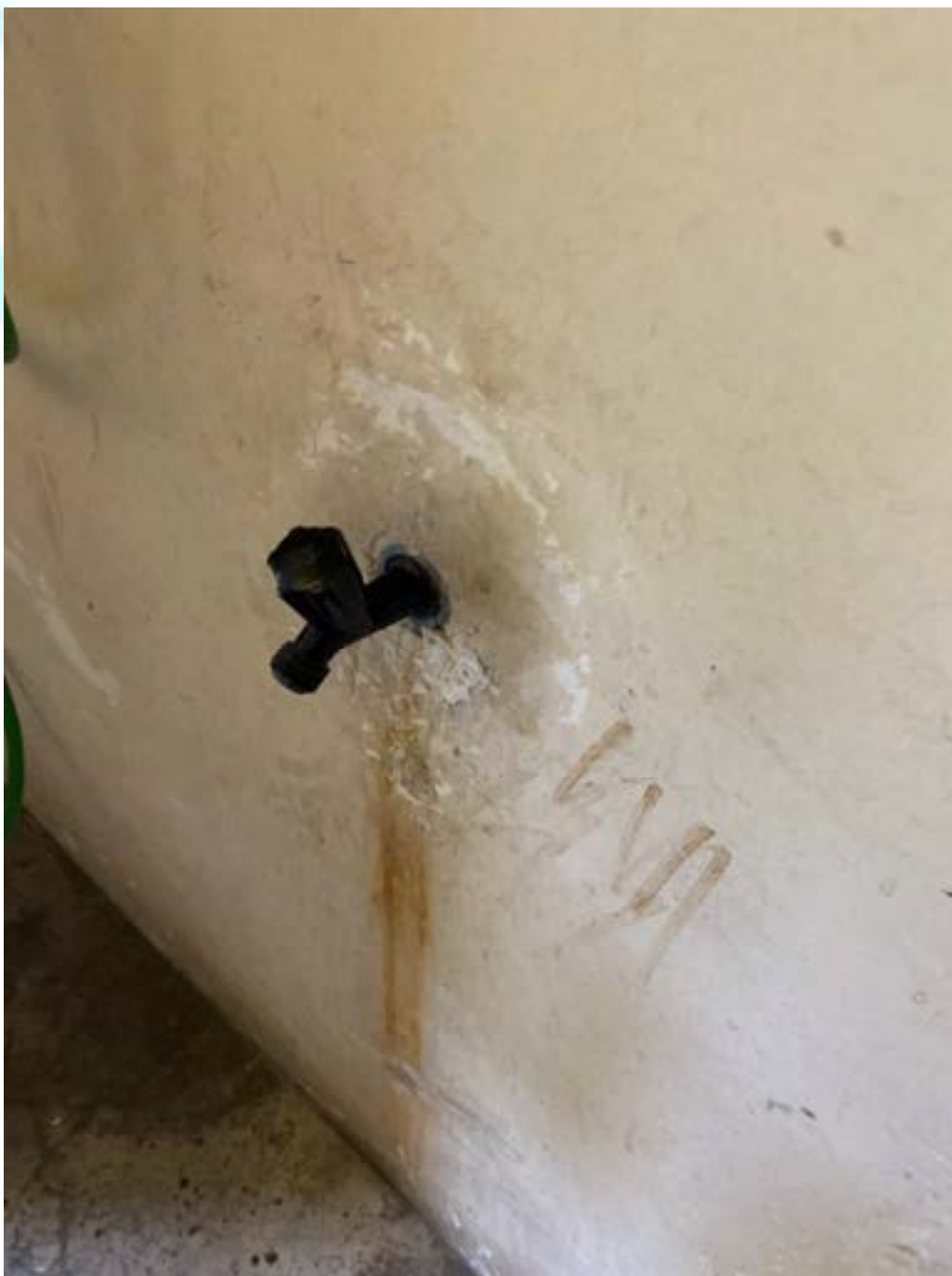
Figura 77 - Ponto de infiltração proveniente da torneira
