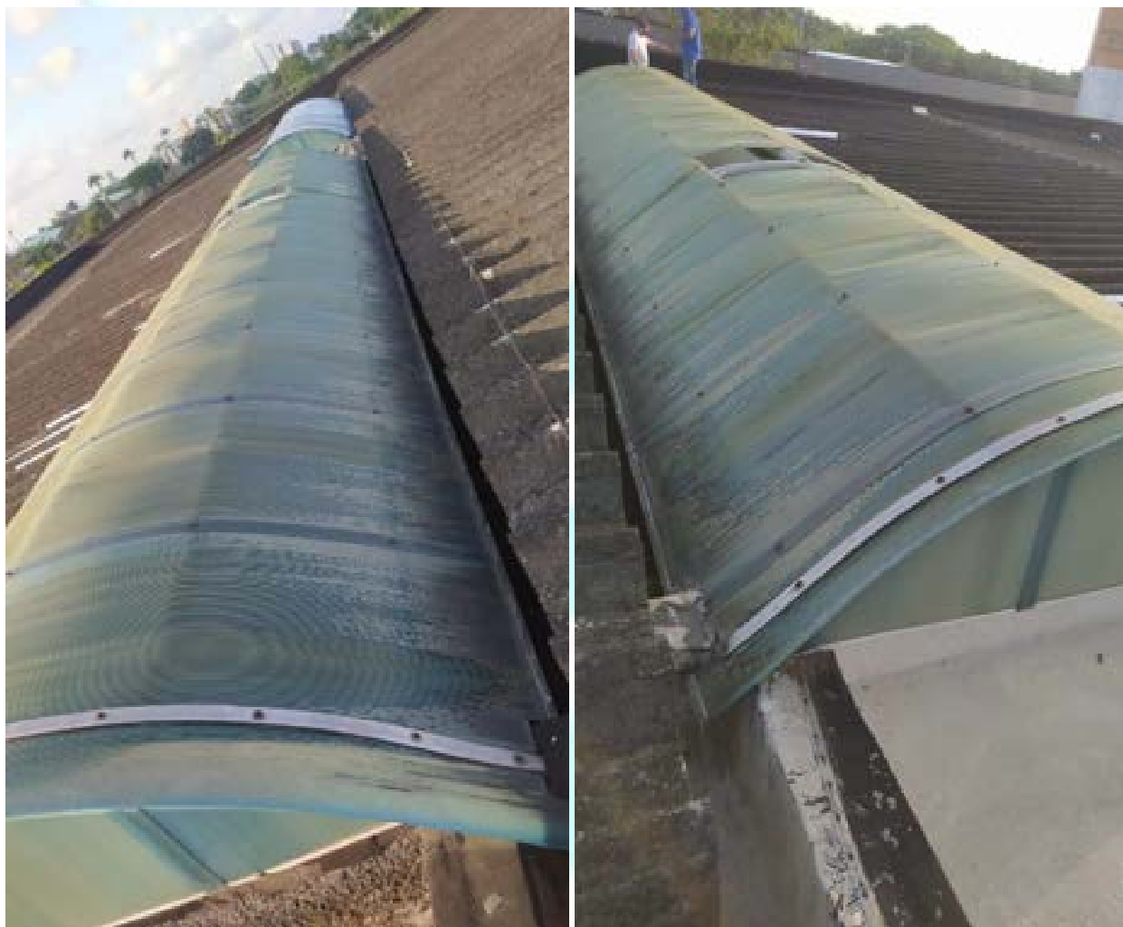
Figura 86 - Área da coberta com telhado em telha tipo Policarbonato
