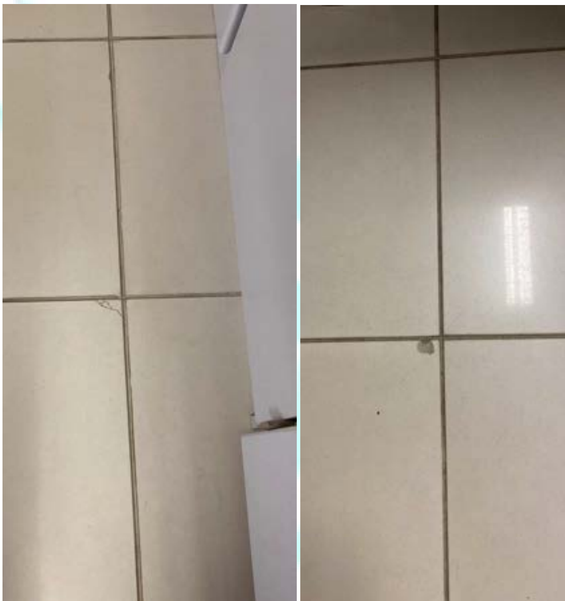
Figura 209 – Revestimentos do piso danificados da sala 02E
