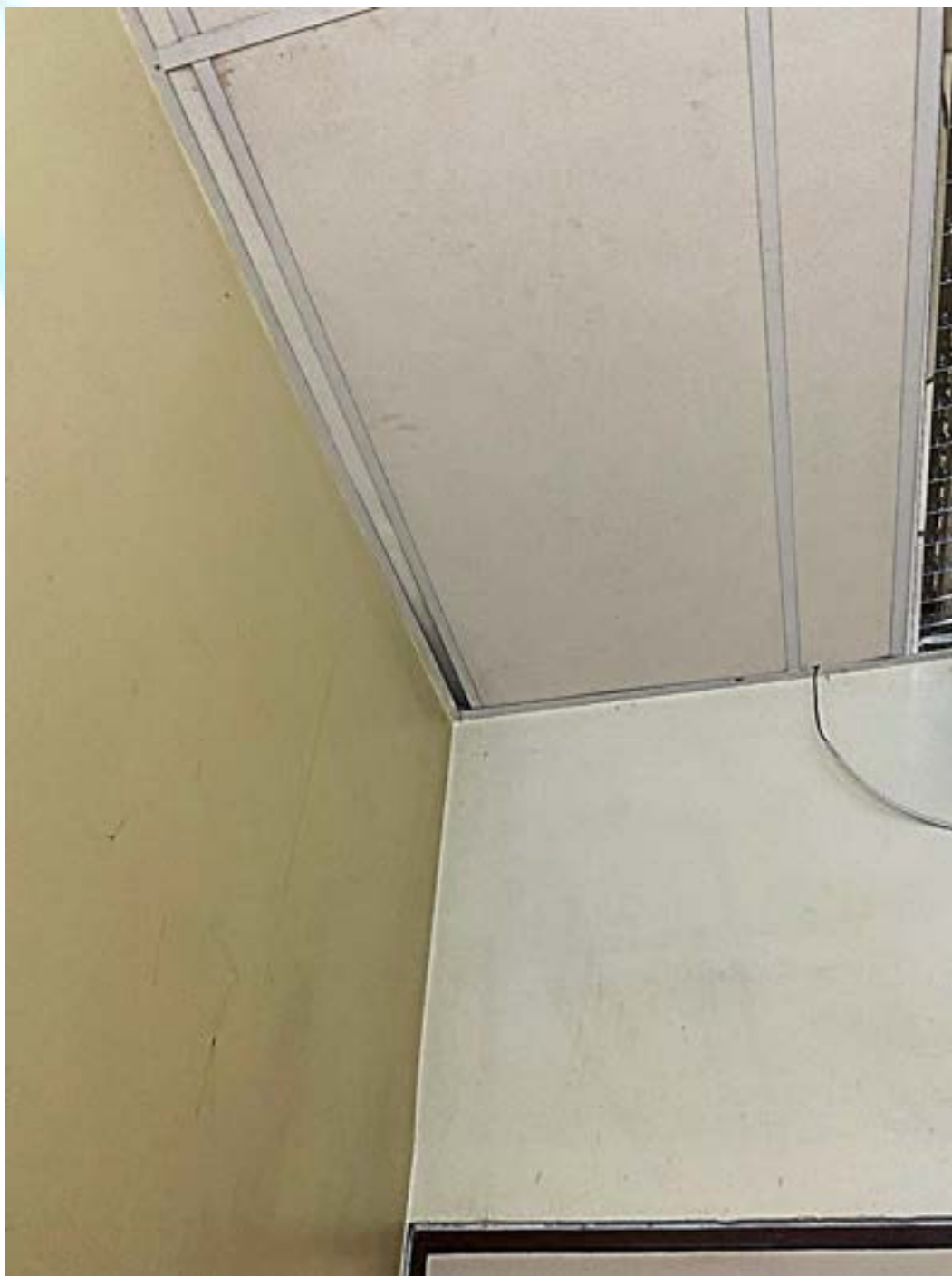
Figura 153 - Degradação do perfil de sustentação de placas de forro e sujeidade na parede
