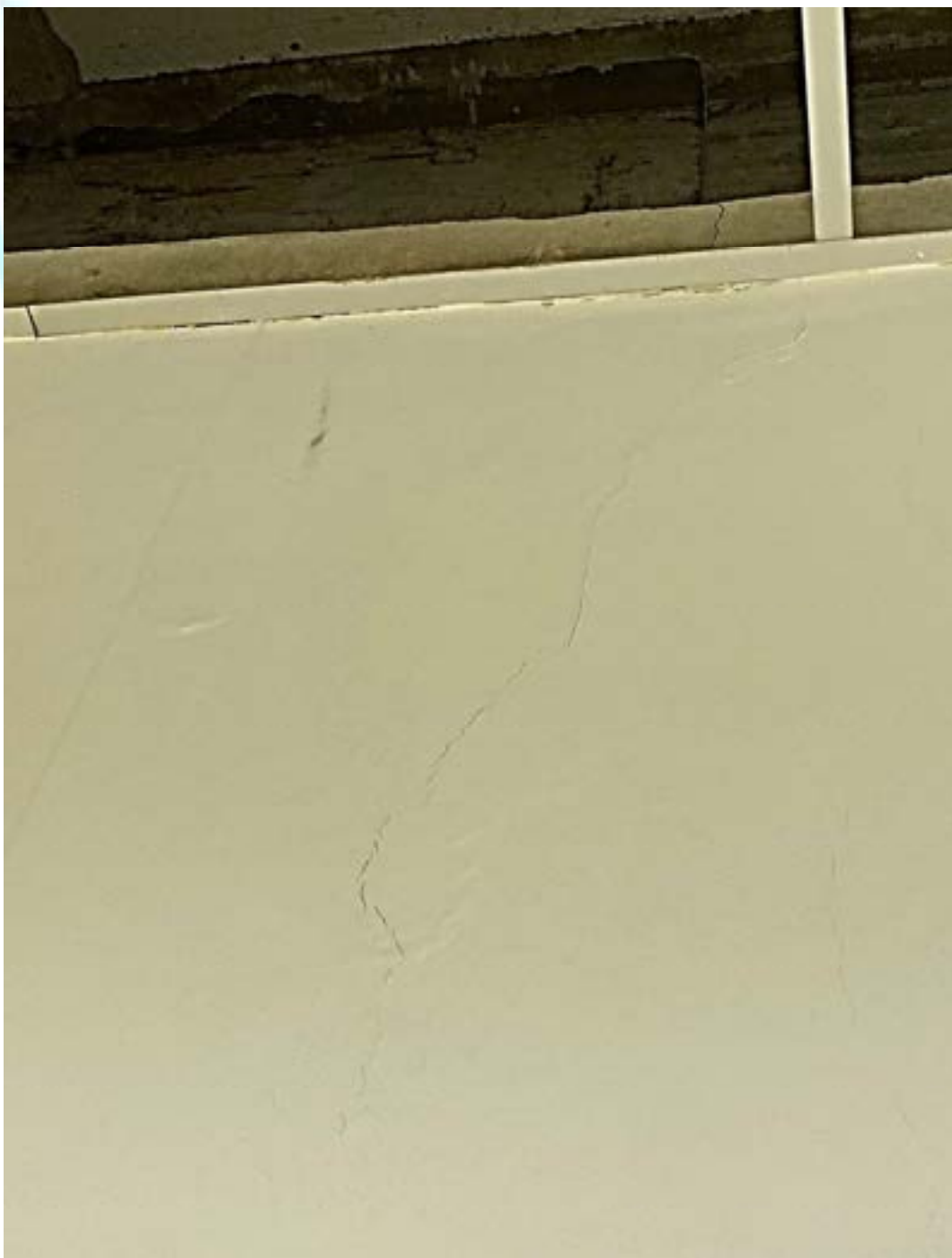
Figura 150 – Fissura na parede na sala do hall posterior direito
