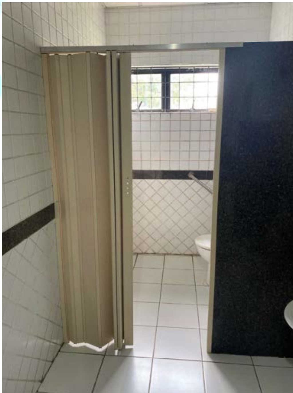
Figura 184 – Porta necessitando de substituição
