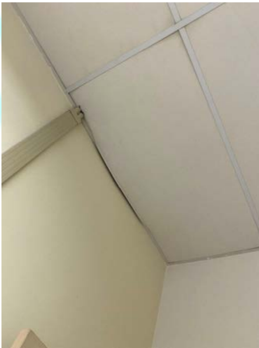
Figura 267 – Tampa do forro desencaixada
