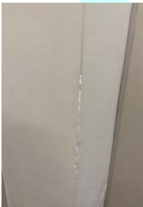
Figura 216 – Deterioração na quina do pilar da sala 03A
