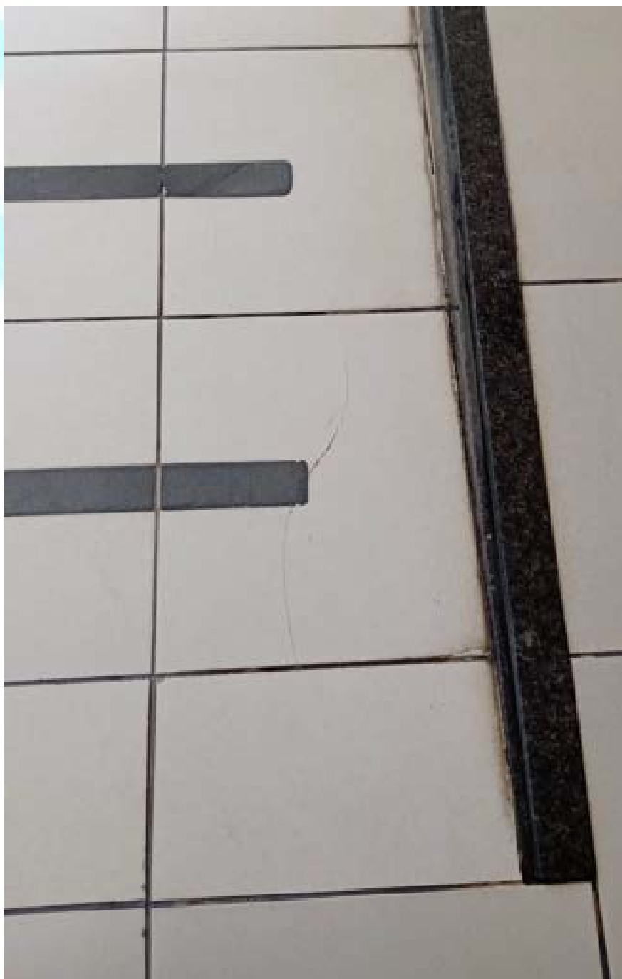
Figura 18 – Fissura no revestimento do piso da rampa
