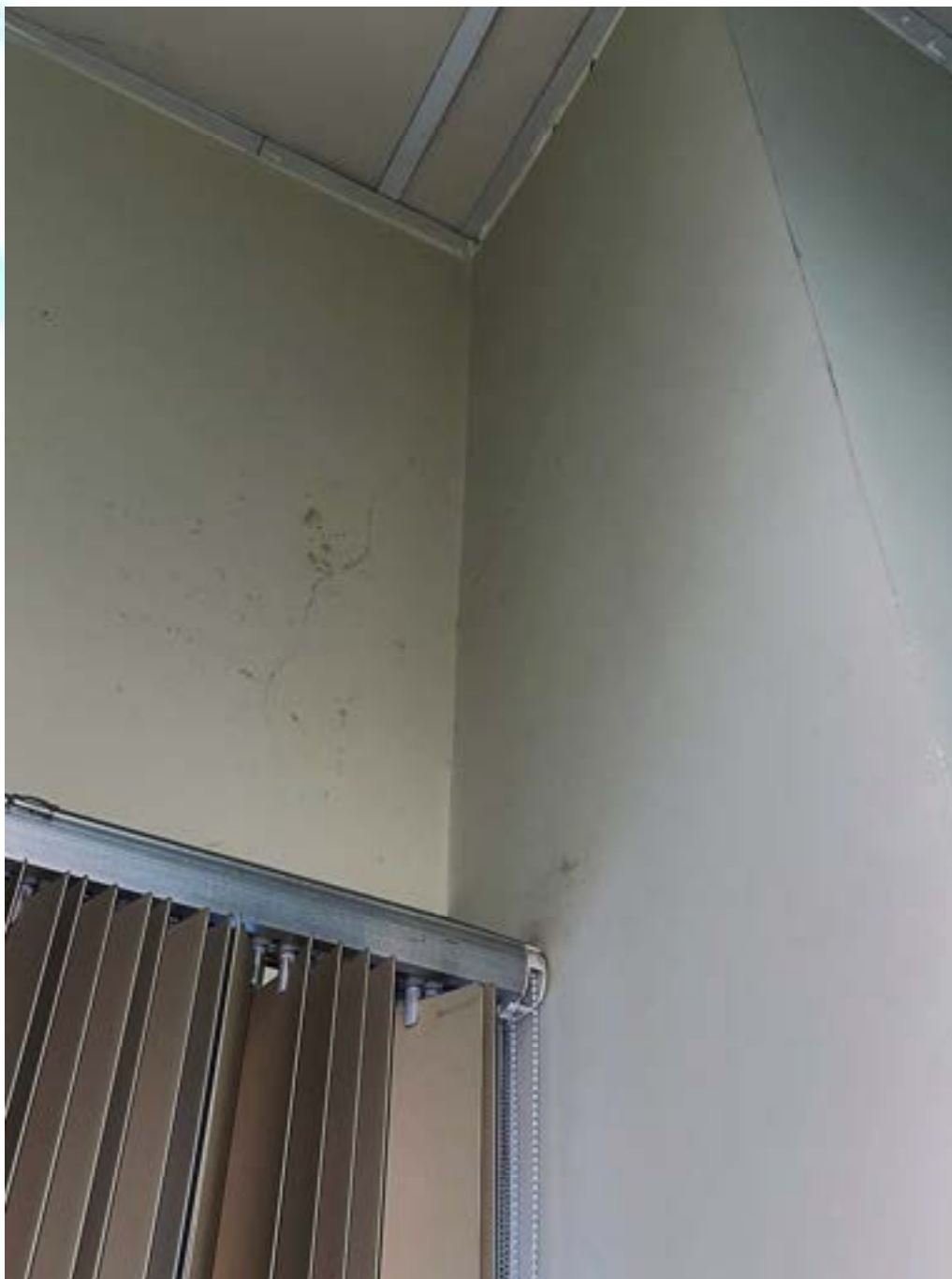
Figura 197 – Fissura na parede na sala 02A
