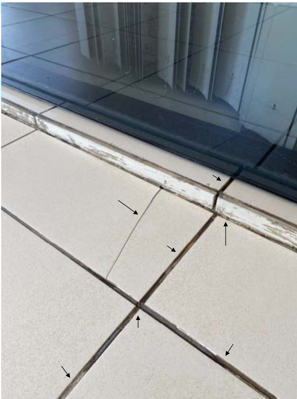
Figura 13 – Trinca no revestimento do piso, rodapé danificado e deterioração do rejunte do rodapé e piso
