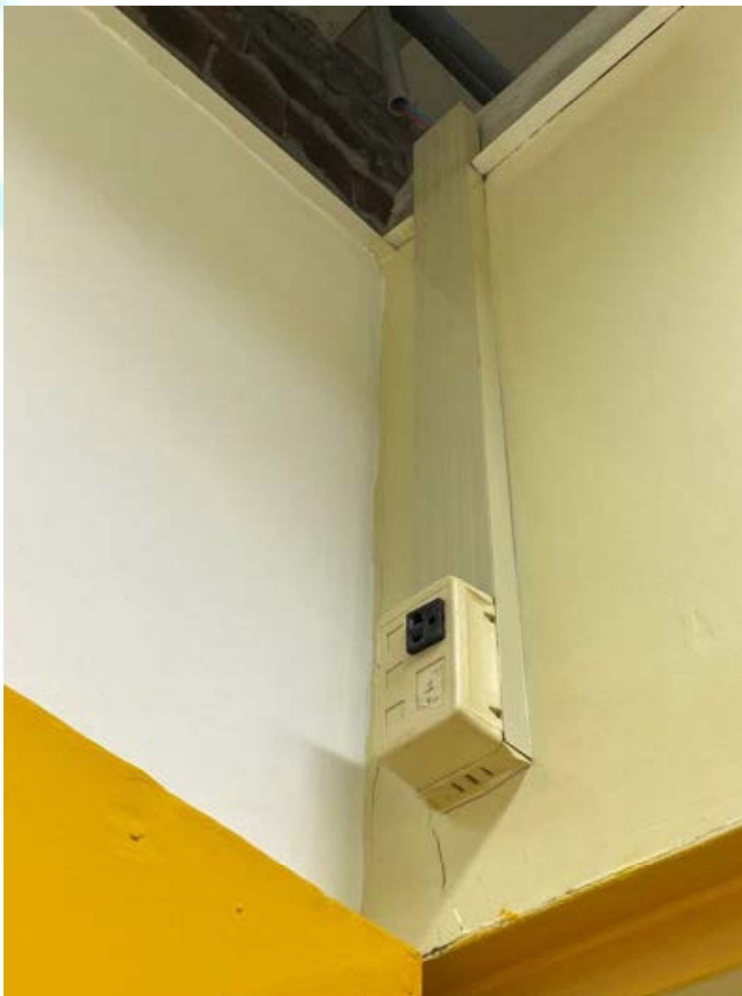
Figura 151 – Fissura na parede na sala do hall posterior direito
