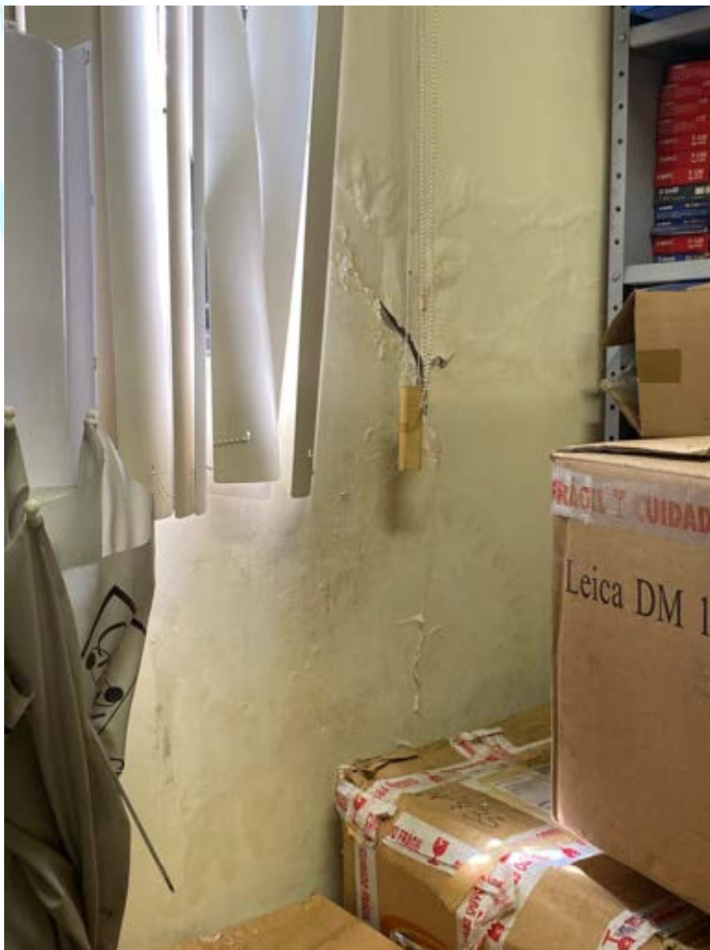
Figura 160 – Afofamento e degradação na parede
