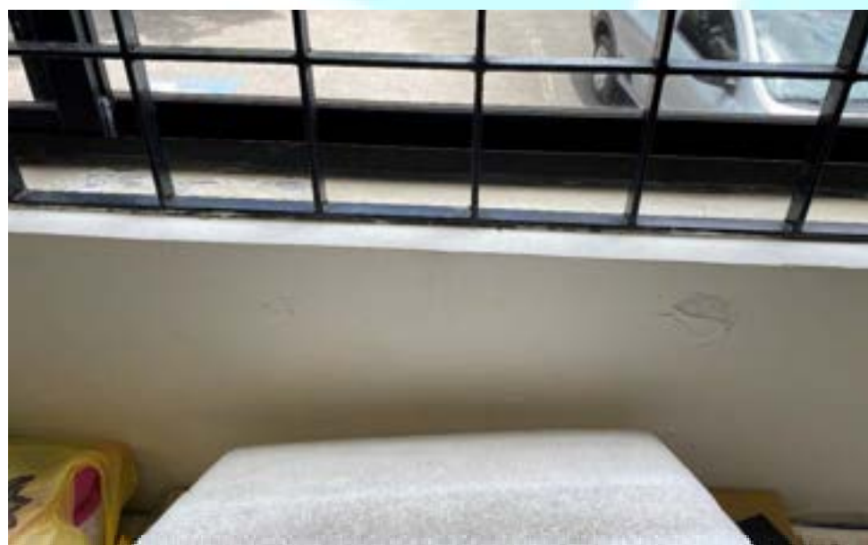
Figura 206 - Descamação no peitoril na sala 02D
