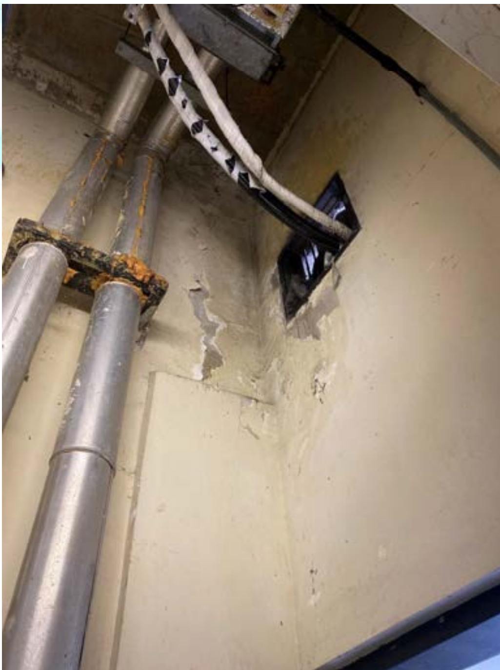
Figura 76 - Degradação do emboço interno
