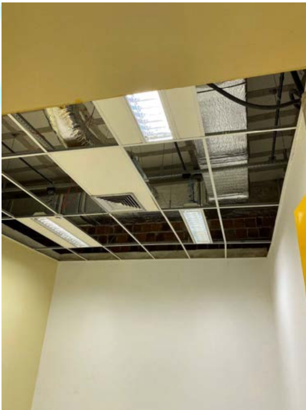
Figura 145 – Ausência das tampas do forro na sala do hall posterior direito
