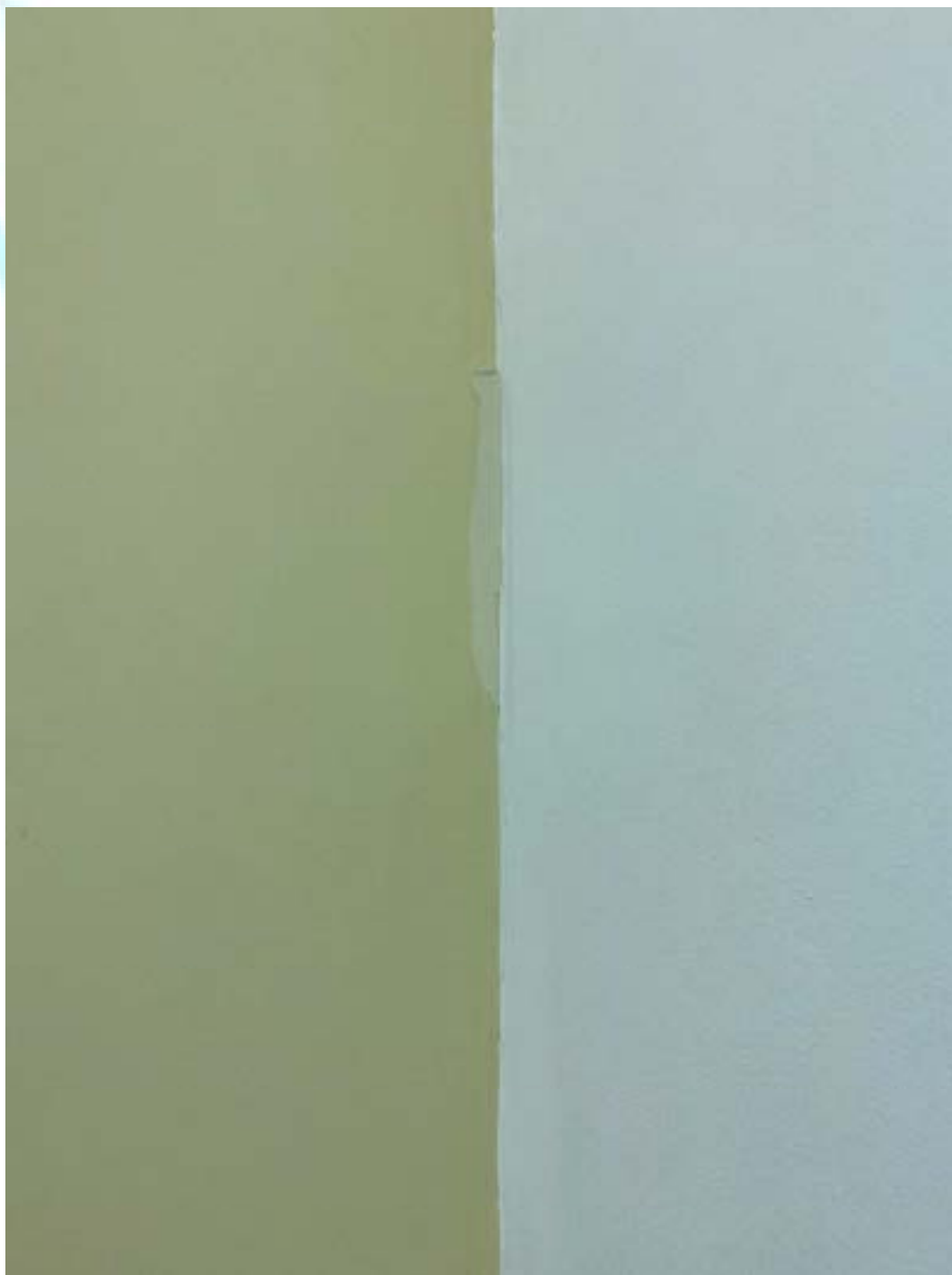
Figura 148 – Descamação na parede na sala do hall posterior direito
