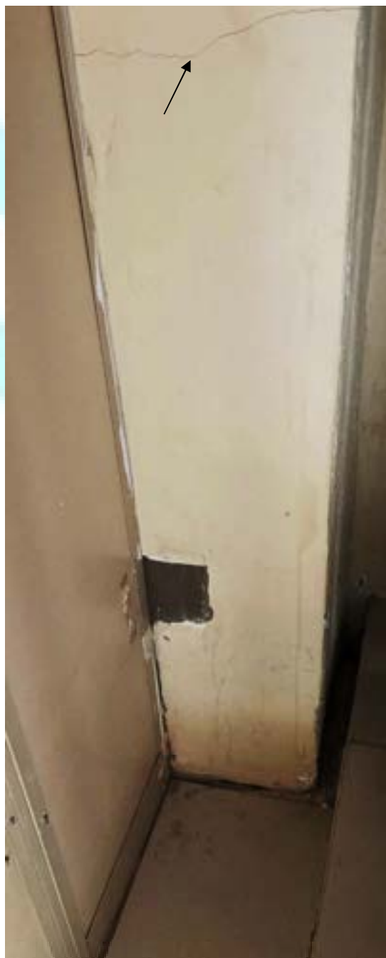
Figura 223 – Fissura no pilar na sala 03D
