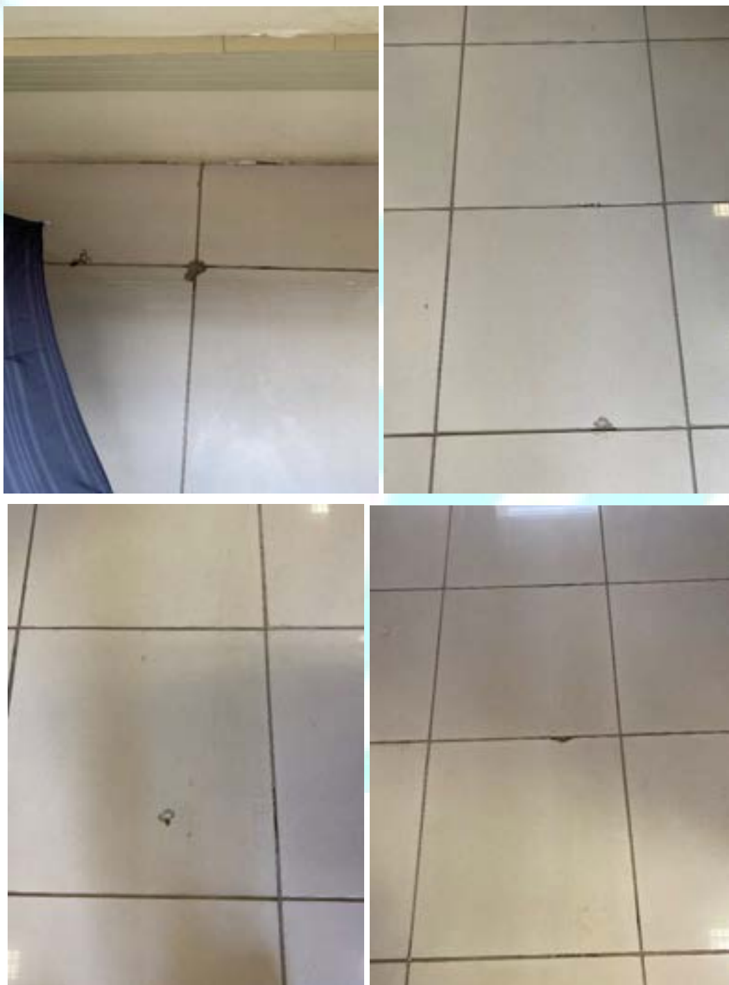
Figura 213 – Revestimentos do piso danificados da sala 03
