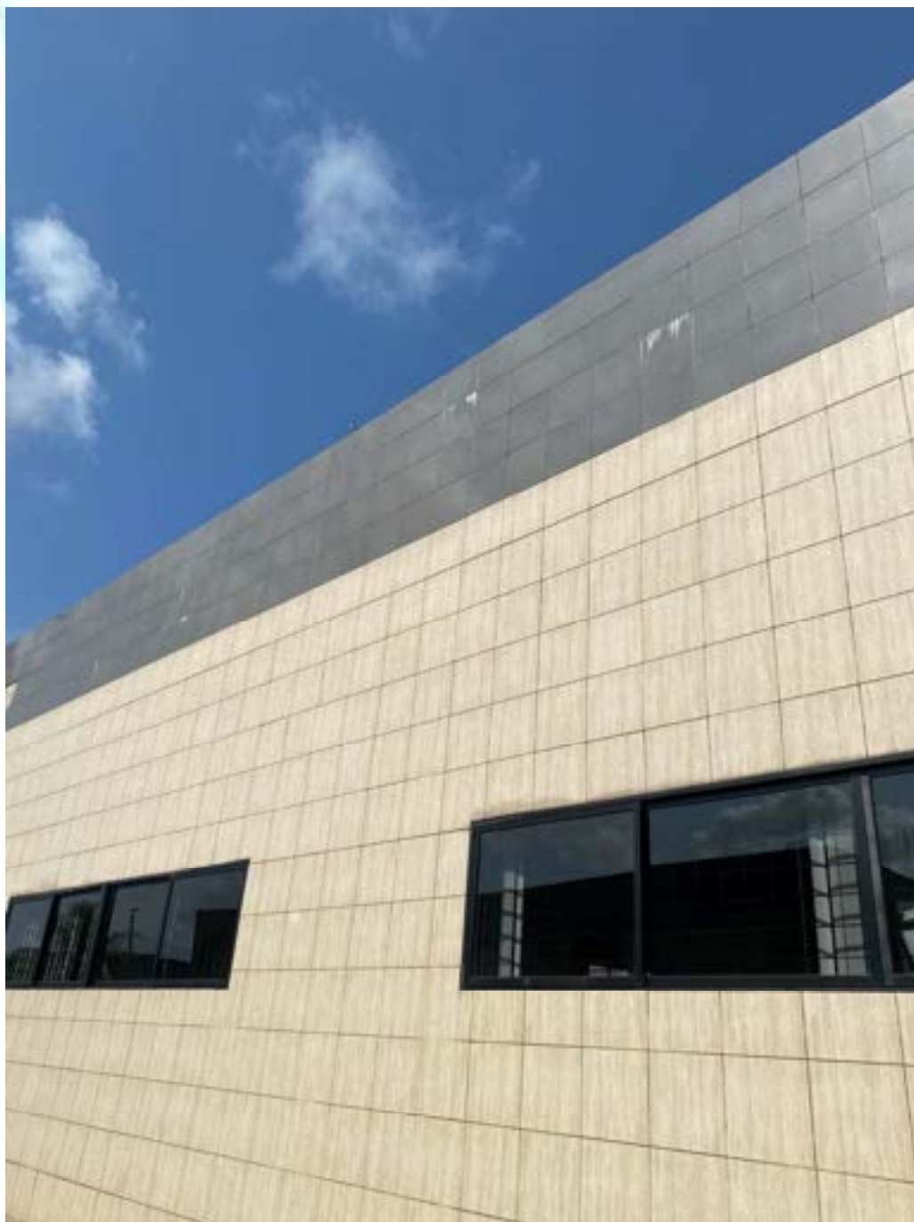
Figura 26 – Revestimento apresentando pontos de eflorescência e sujidades nos rejuntas
