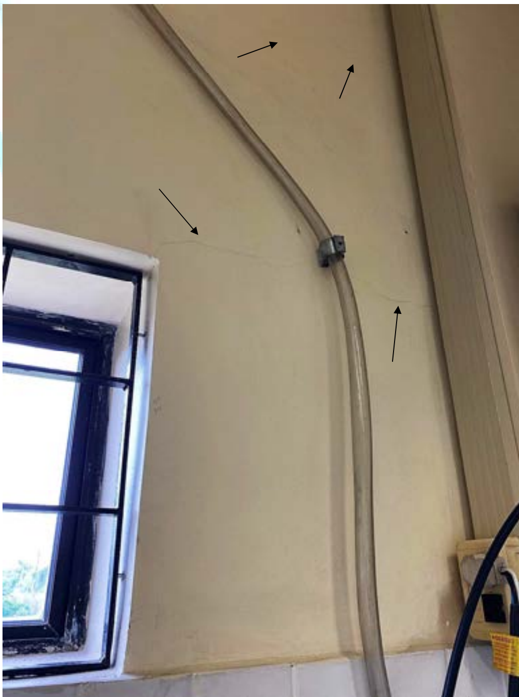
Figura 283 – Fissuras na parede
