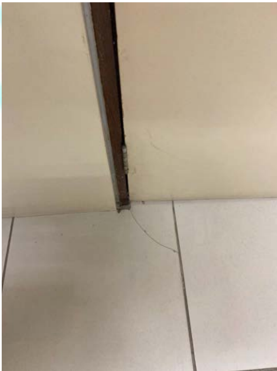
Figura 164 – Revestimento do piso fissurado
