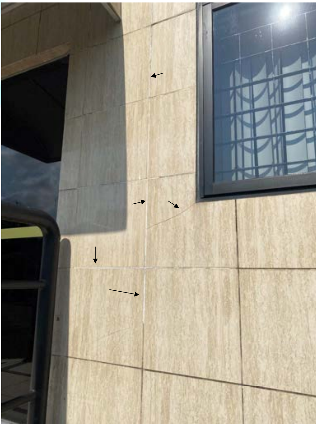
Figura 34 - Trinca no revestimento, eflorescência e deterioração do rejunte
