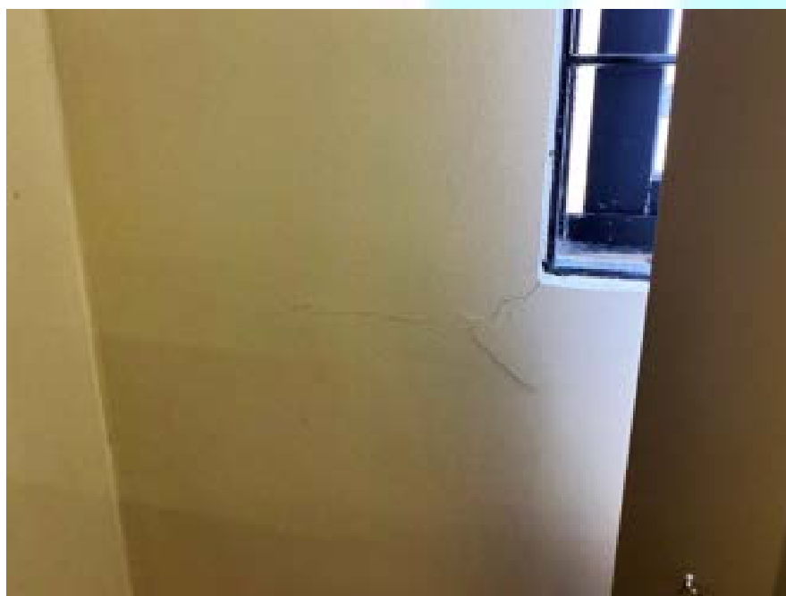
Figura 239 – Fissura na parede
