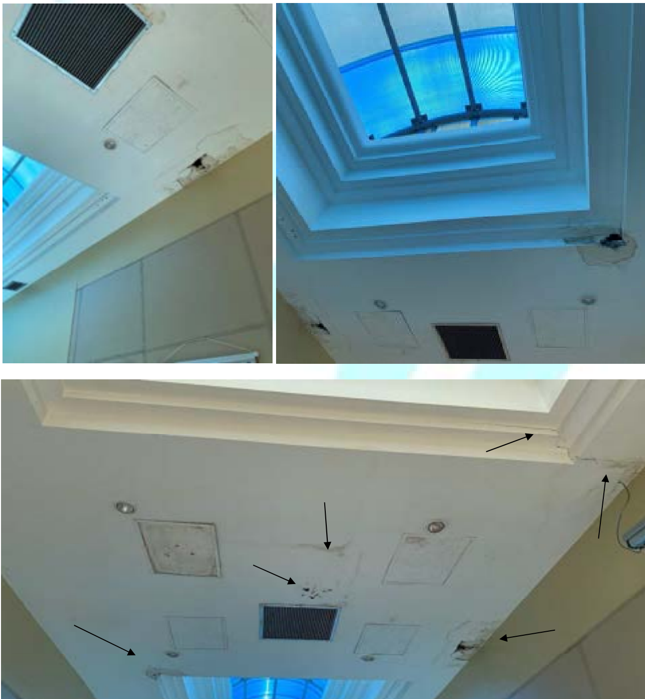
Figura 125 – Fissura, deterioração e infiltração no forro de gesso
