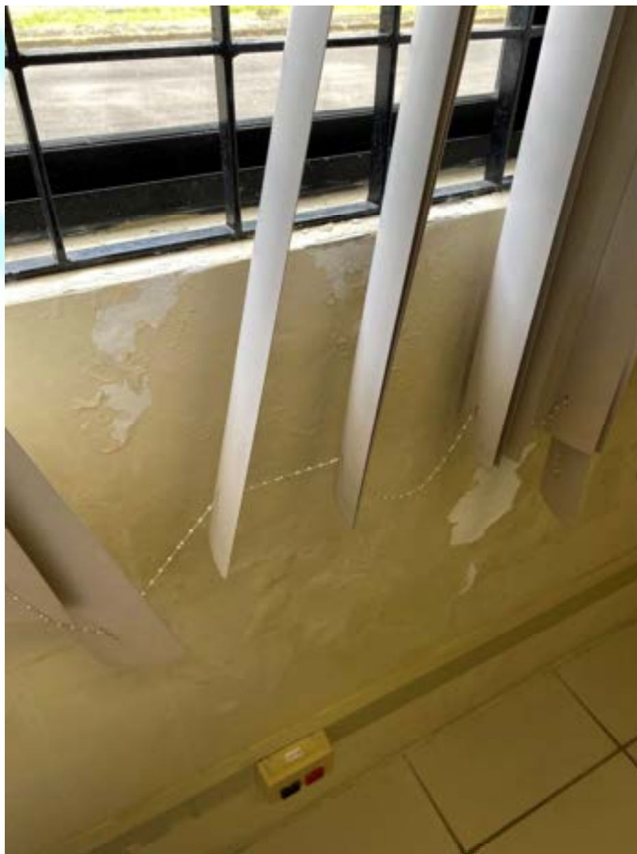
Figura 227 – Umidade no peitoril na sala 03E
