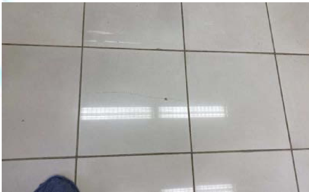
Figura 274 – Revestimento do piso fissurado
