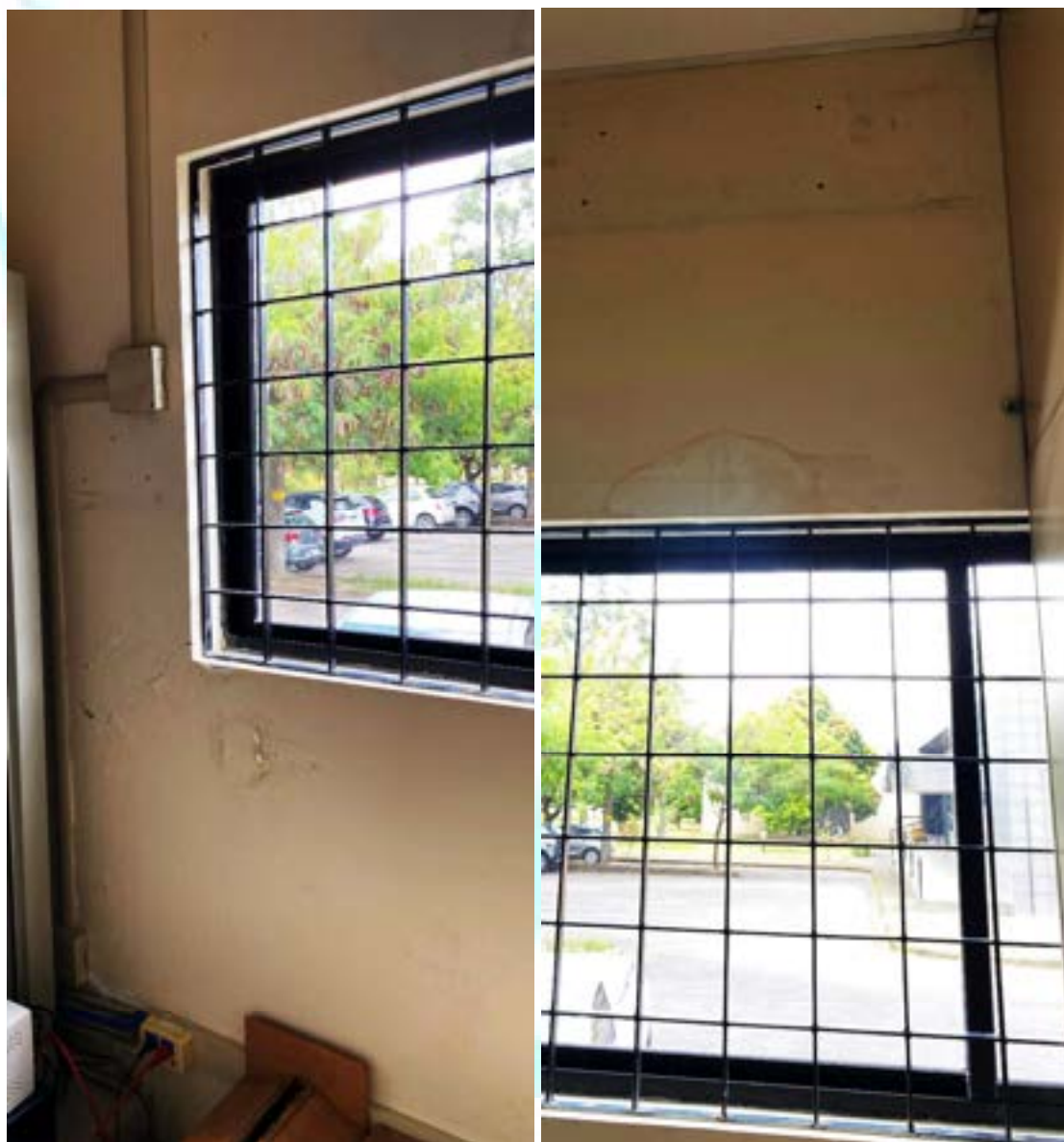
Figura 222 – Umidade na parede da sala 03D
