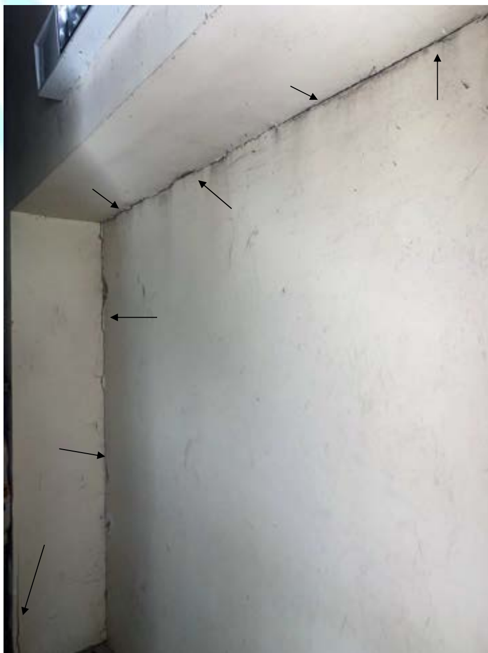
Figura 79 – Fissura no encontro das alvenarias
