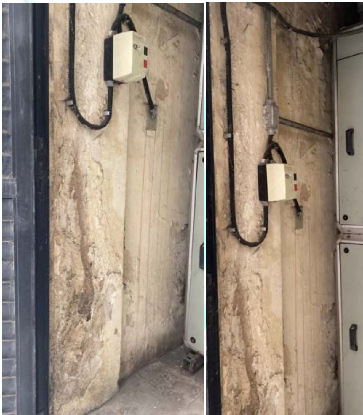
Figura 82 – Deterioração do emboço
