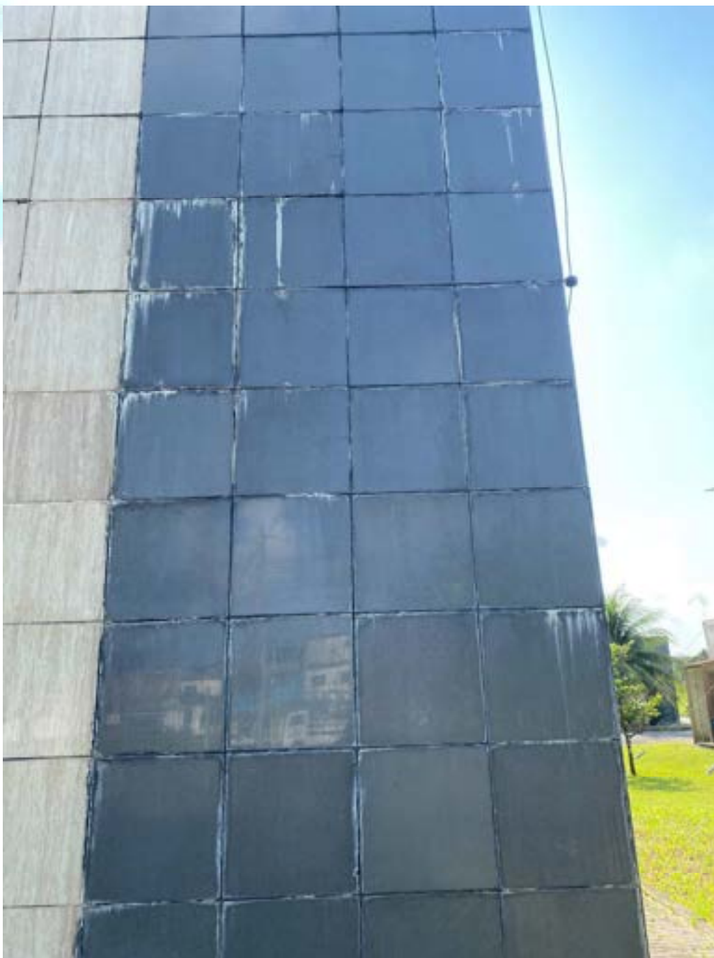
Figura 49 - Revestimento apresentando eflorescência, sujidades e trincas
