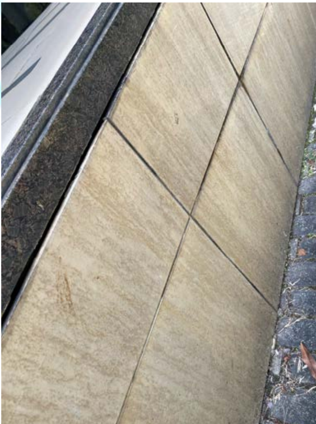
Figura 21 – Ausência de rejunte na lateral da rampa entre revestimento e granito
