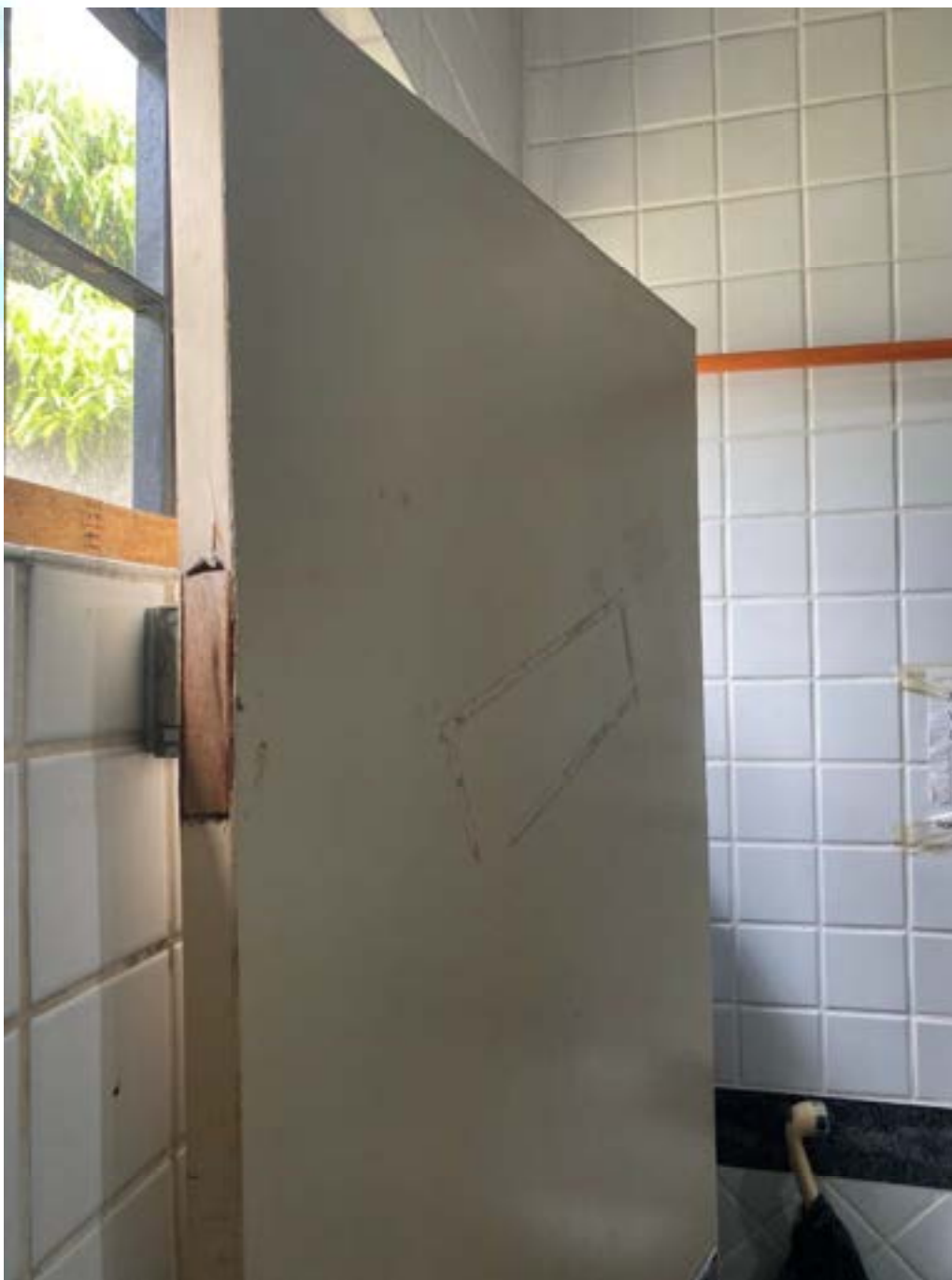
Figura 189 – Porta necessitando de substituição no banheiro feminino
