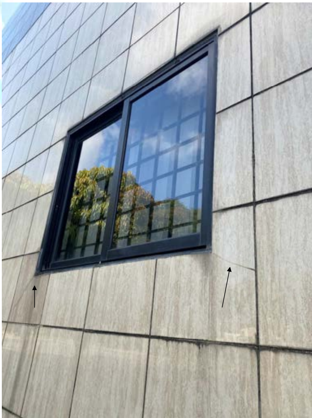
Figura 53 – Fissuras nas quinas inferiores da janela e sujidades no revestimento
