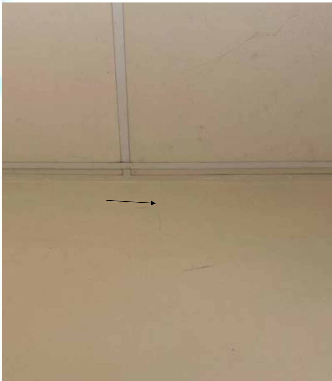
Figura 158 – Fissura na parede
