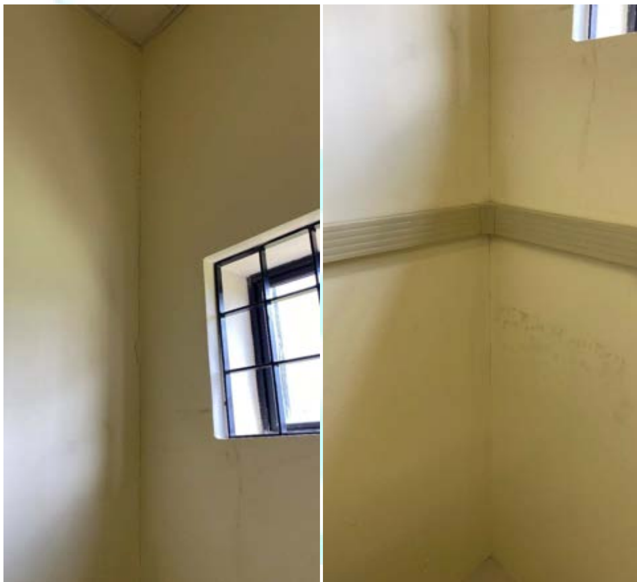
Figura 268- Fissura no encontro das alvenarias
