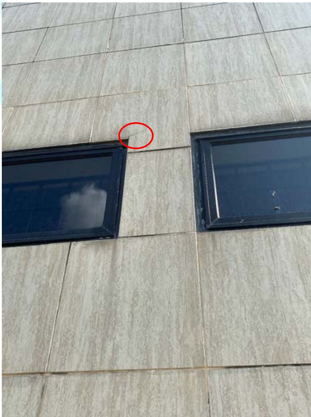
Figura 43 - Revestimento cerâmico com trinca na quina superior da janela e rejunte indicando sujidades e eflorescência
