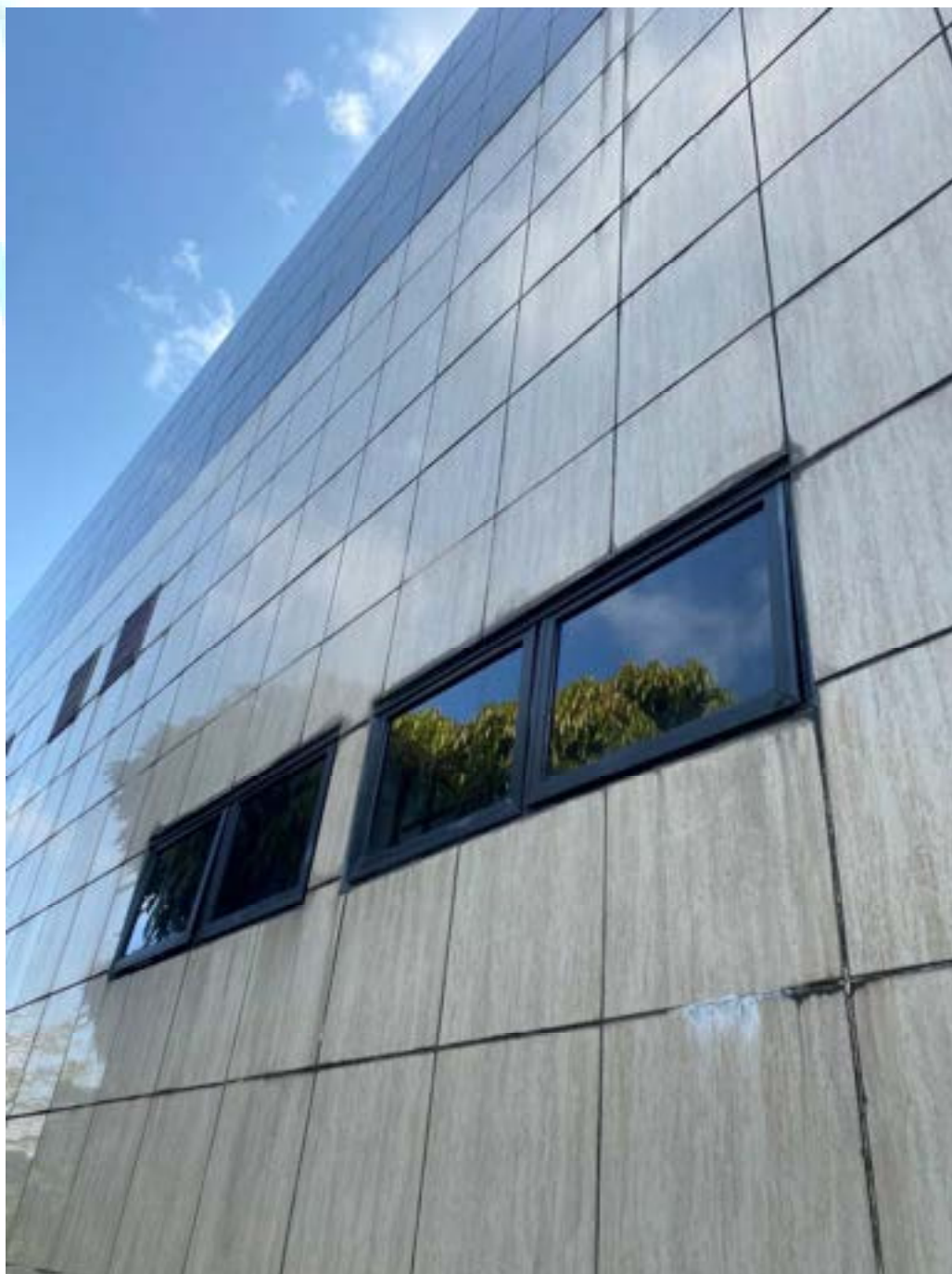
Figura 55 – Revestimento apresentando eflorescência e sujidades
