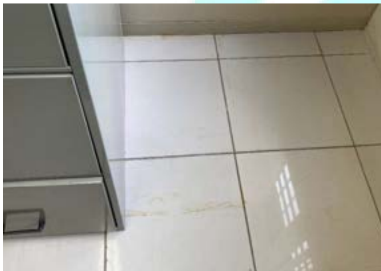
Figura 229 – Revestimentos do piso danificados da sala 03E
