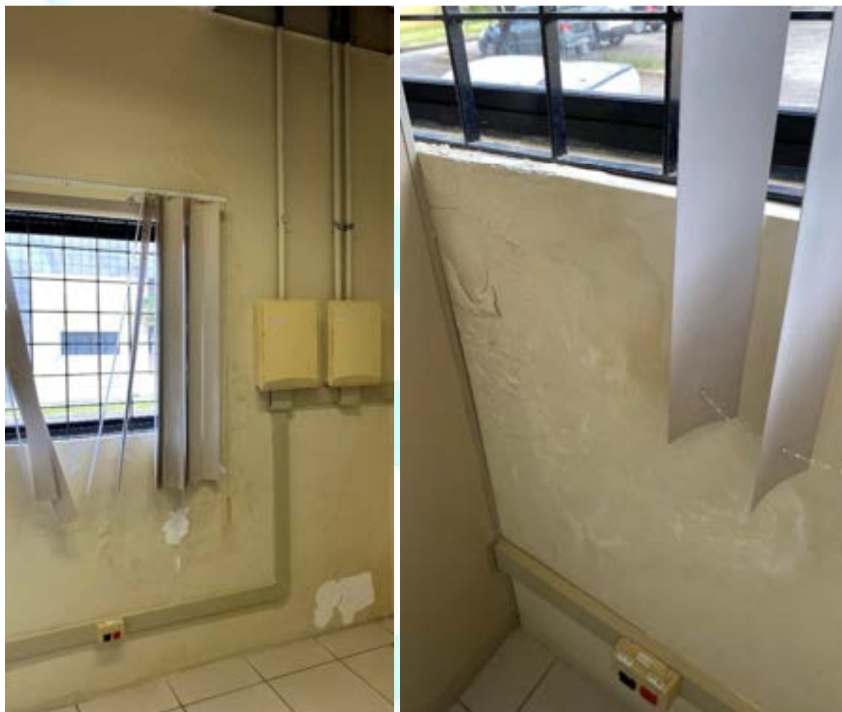
Figura 226 – Umidade na parede e no peitoril na sala 03E
