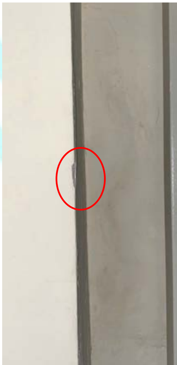
Figura 224 – Deterioração na quina do pilar da sala 03D
