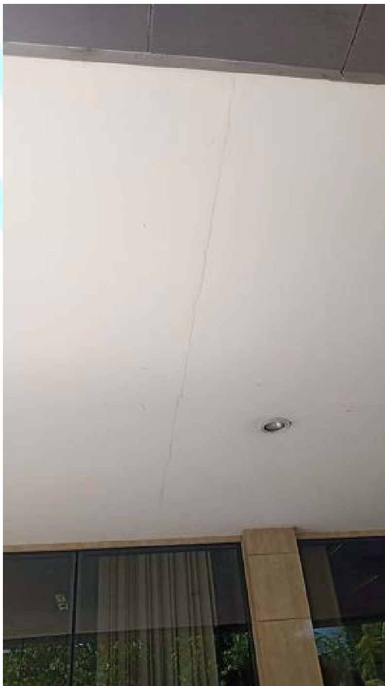
Figura 112 – Fissura longitudinal no forro de gesso
