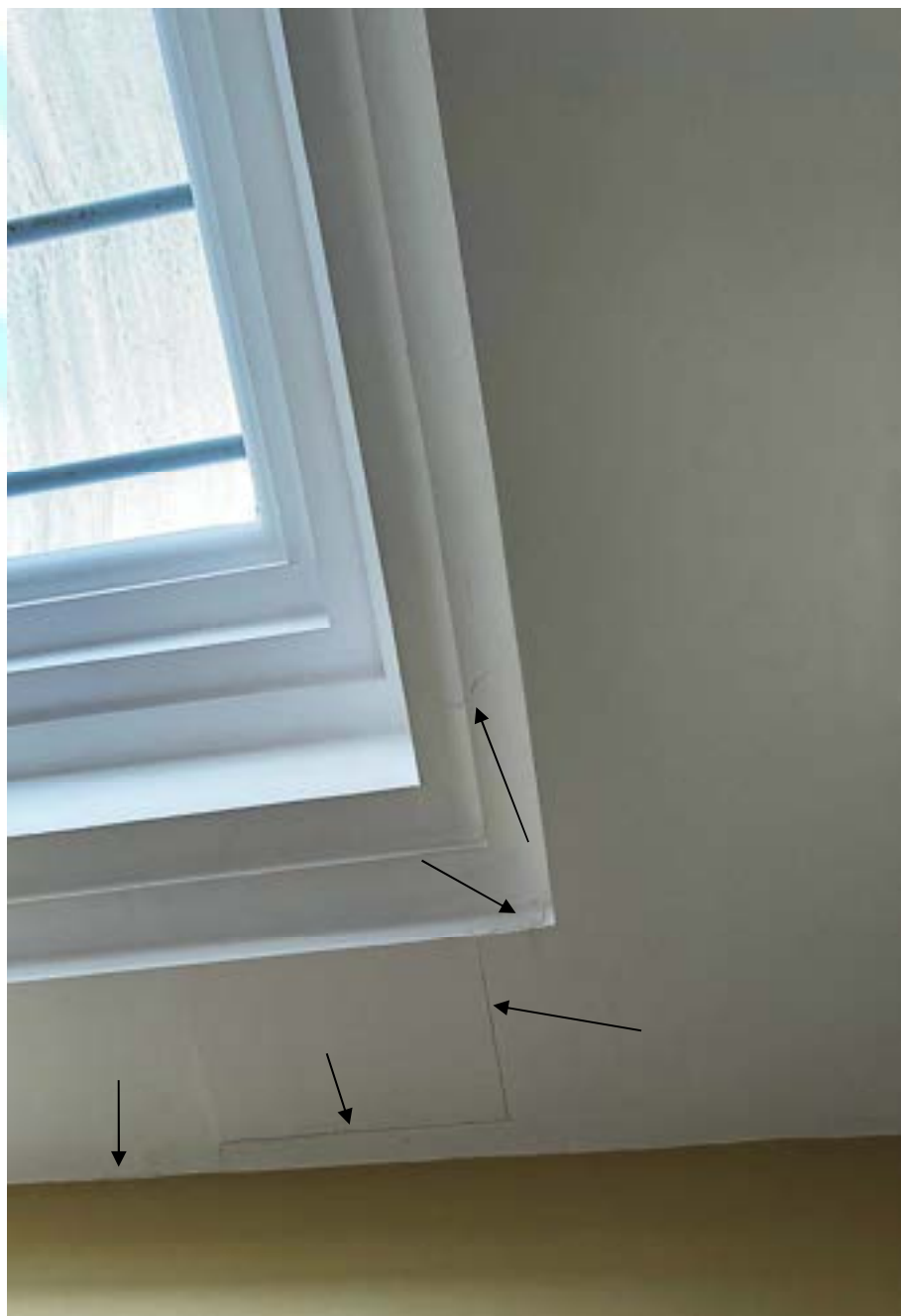
Figura 124 – Fissura no forro de gesso
