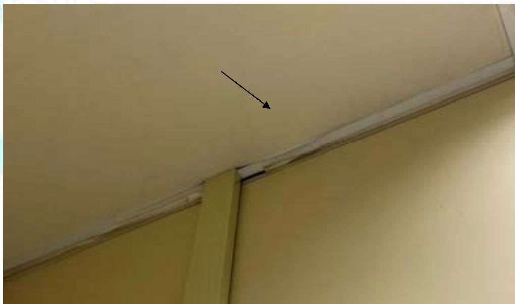
Figura 220 - Degradação do perfil de sustentação de placas de forro na sala 03B
