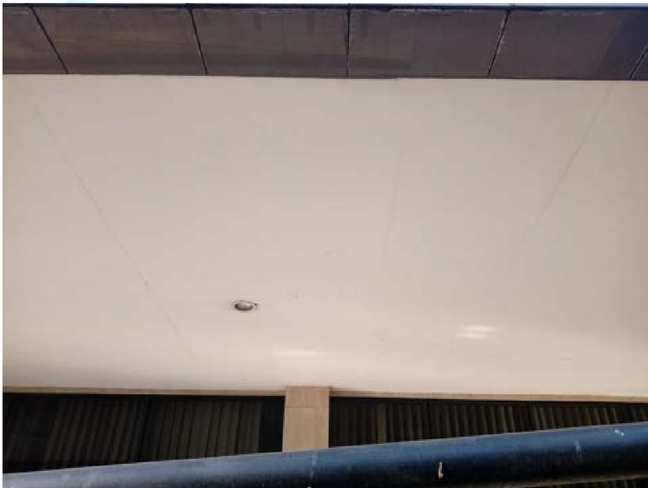
Figura 111 – Fissuras longitudinal no forro de gesso
