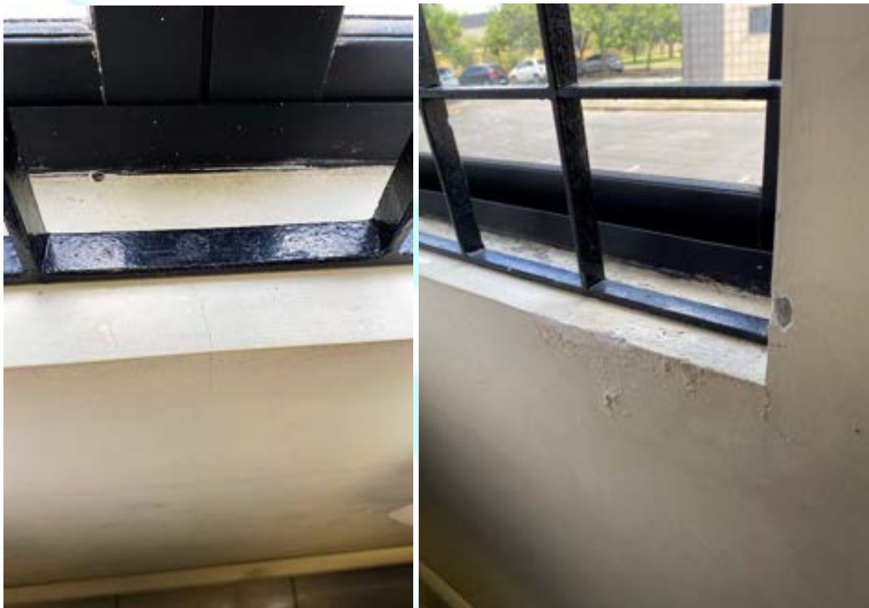
Figura 251 – Fissura e descamação no peitoril da sala 07A
