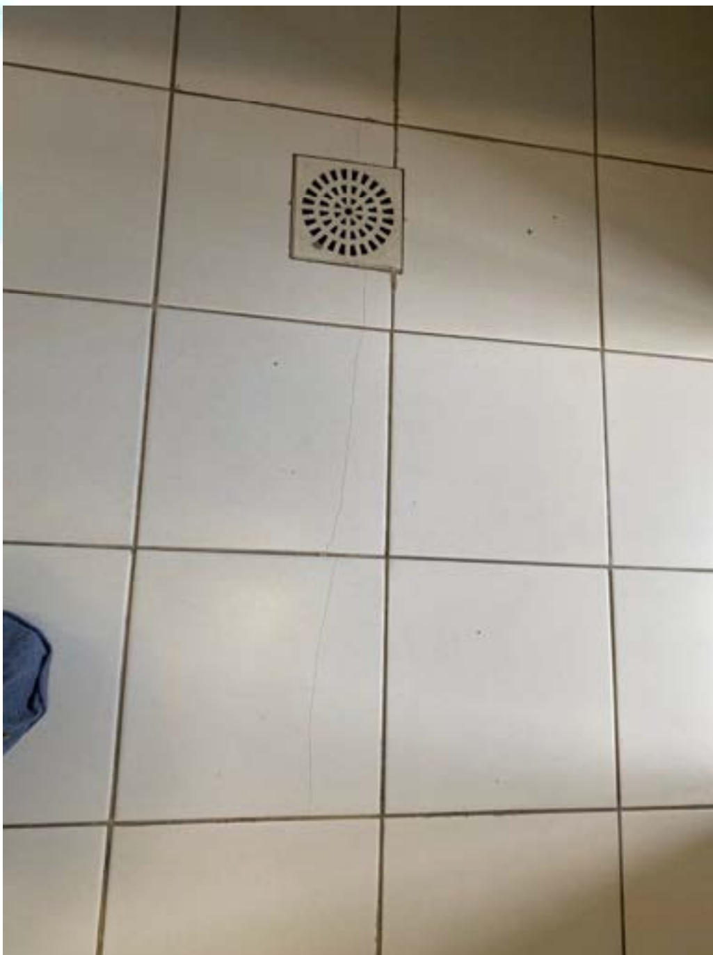
Figura 176 – Fissuras do piso danificado no banheiro Feminino
