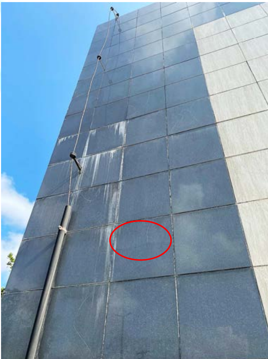
Figura 46 – Revestimento apresentando eflorescência, sujidades e trinca
