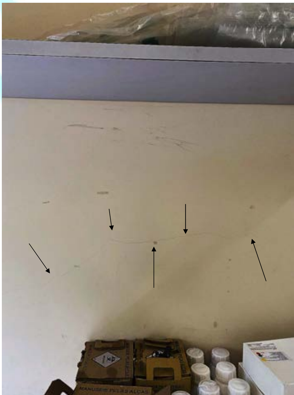
Figura 171 – Fissura longitudinal na parede
