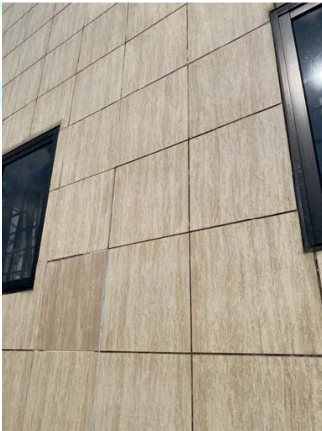
Figura 33 - Eflorescência e deterioração do rejunte
