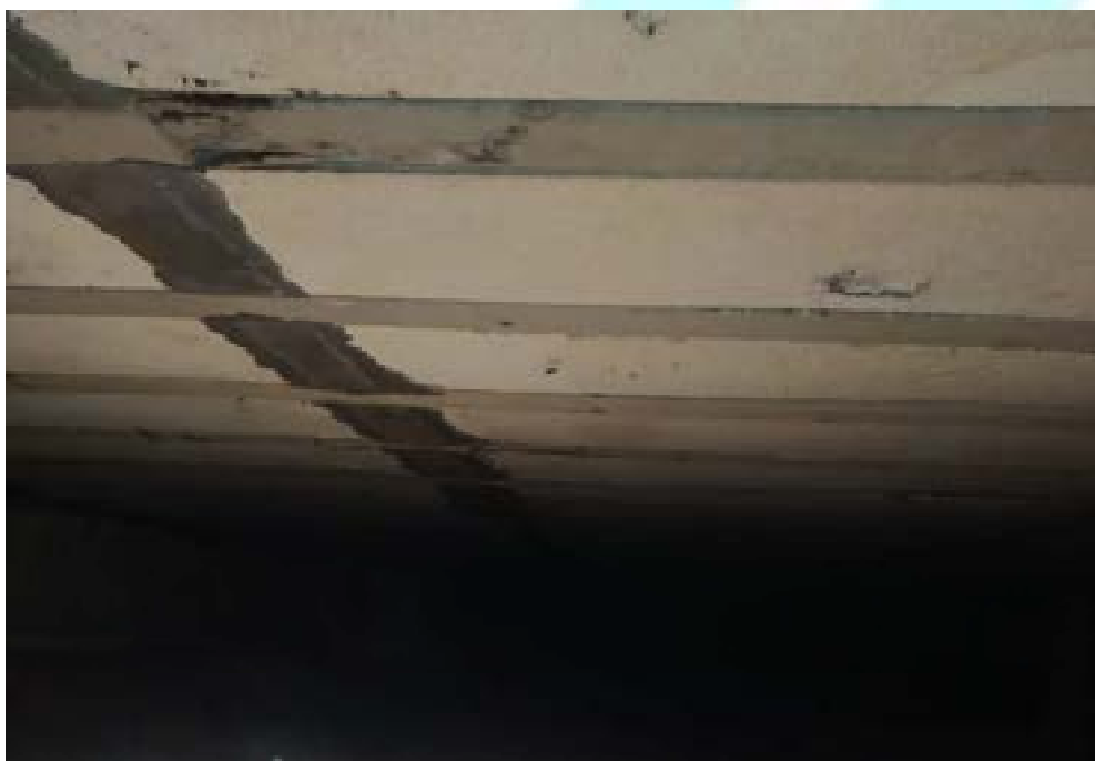
Figura 119 - Área da fundação – Pontos de oxidação
