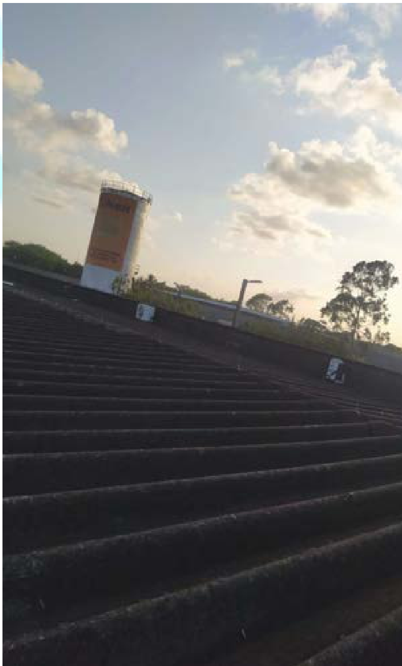
Figura 84 – Área da coberta com telhado em telha tipo Kalhetão
