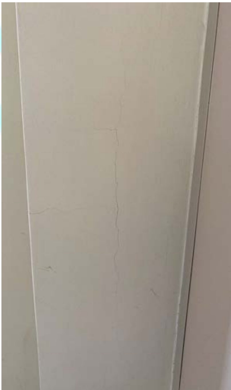
Figura 244 – Fissura no pilar
