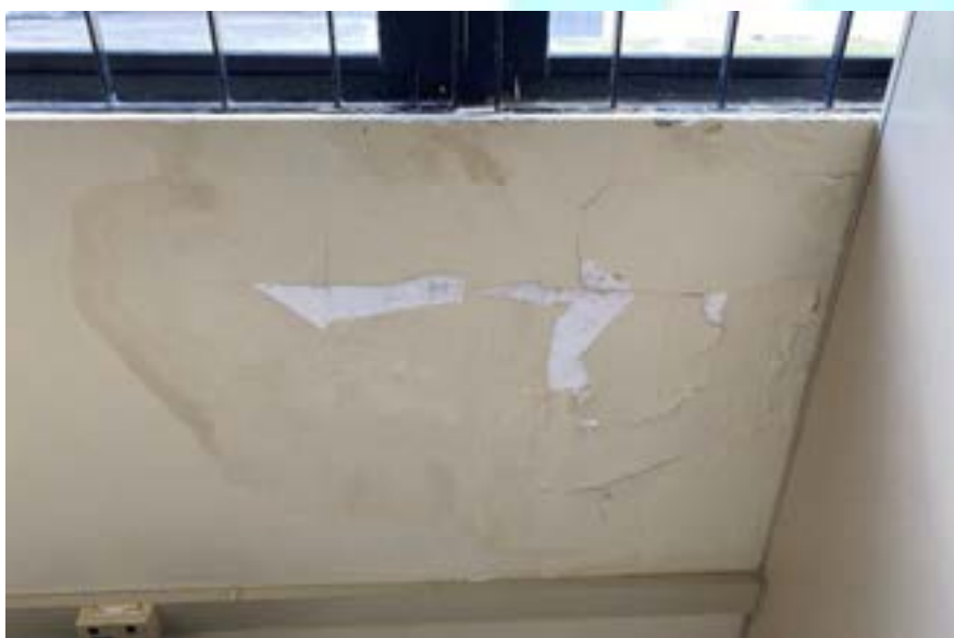
Figura 212 – Umidade e descamação no peitoril
