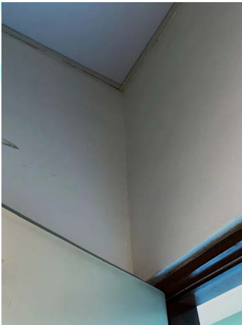
Figura 288 – Fissura superficial no encontro das alvenarias
