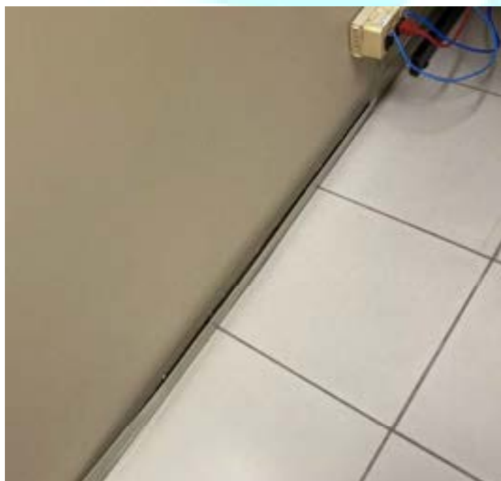
Figura 231 – Rodapé da divisória danificado na sala 03F
