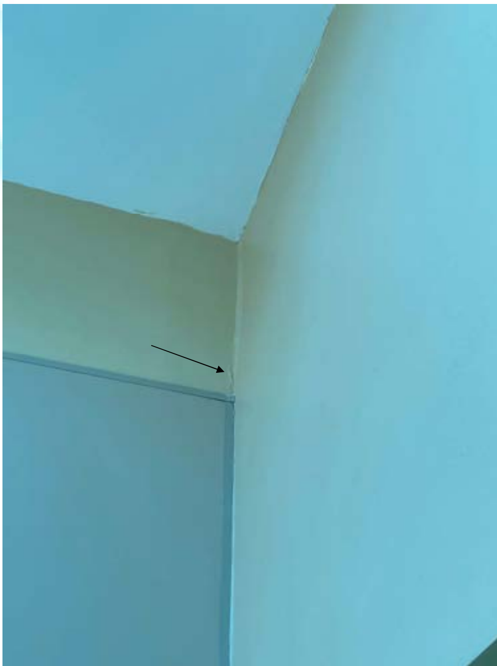
Figura 134 – Fissura na parede
