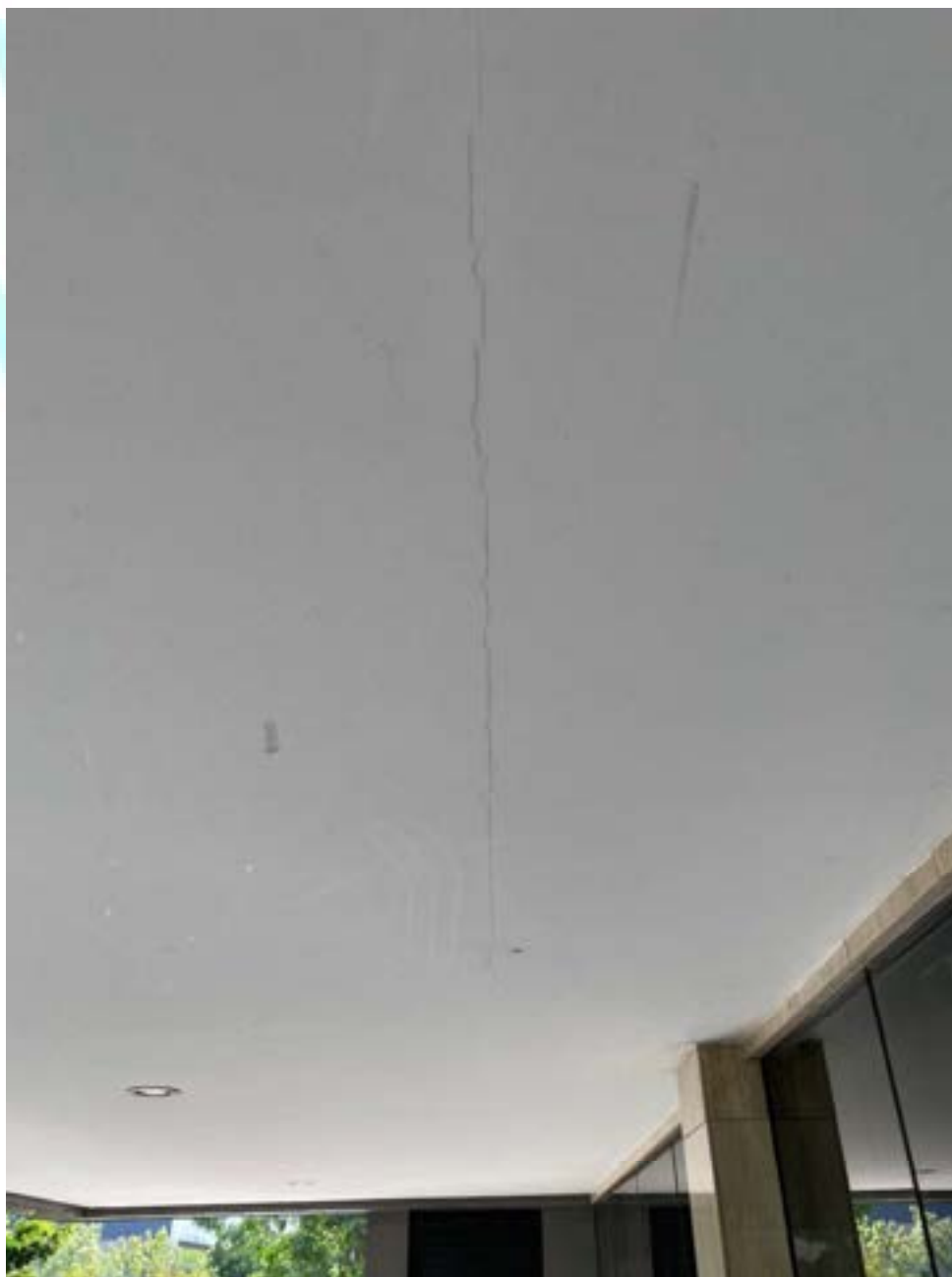
Figura 110 – Fissura longitudinal no forro de gesso
