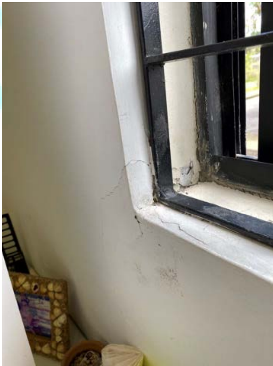
Figura 200 – Descamação no peitoril e parede da sala 02C
