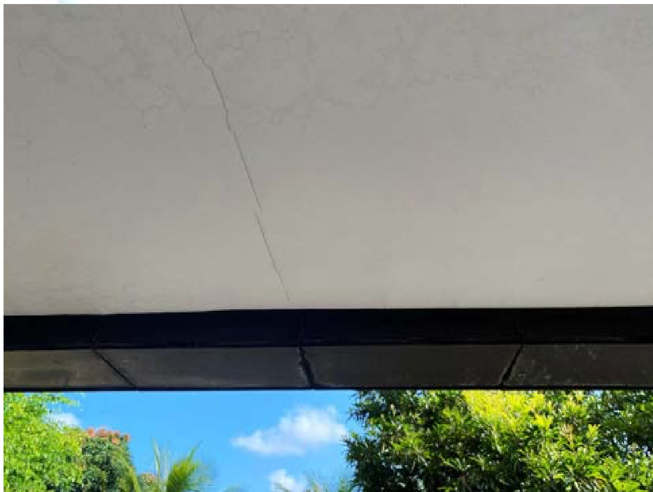
Figura 109 – Fissura e infiltração no forro de gesso da marquise
