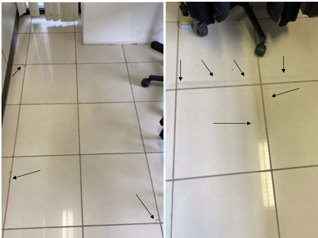
Figura 203 – Revestimentos do piso danificados na sala 02C
