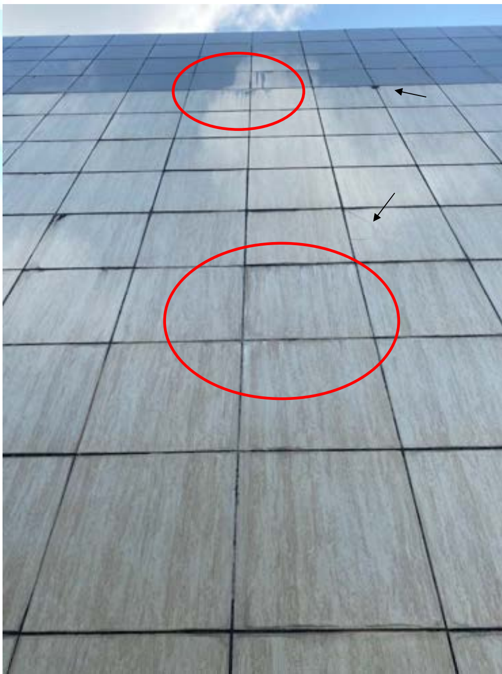
Figura 52 – Revestimento apresentando eflorescência, sujidades e trincas
