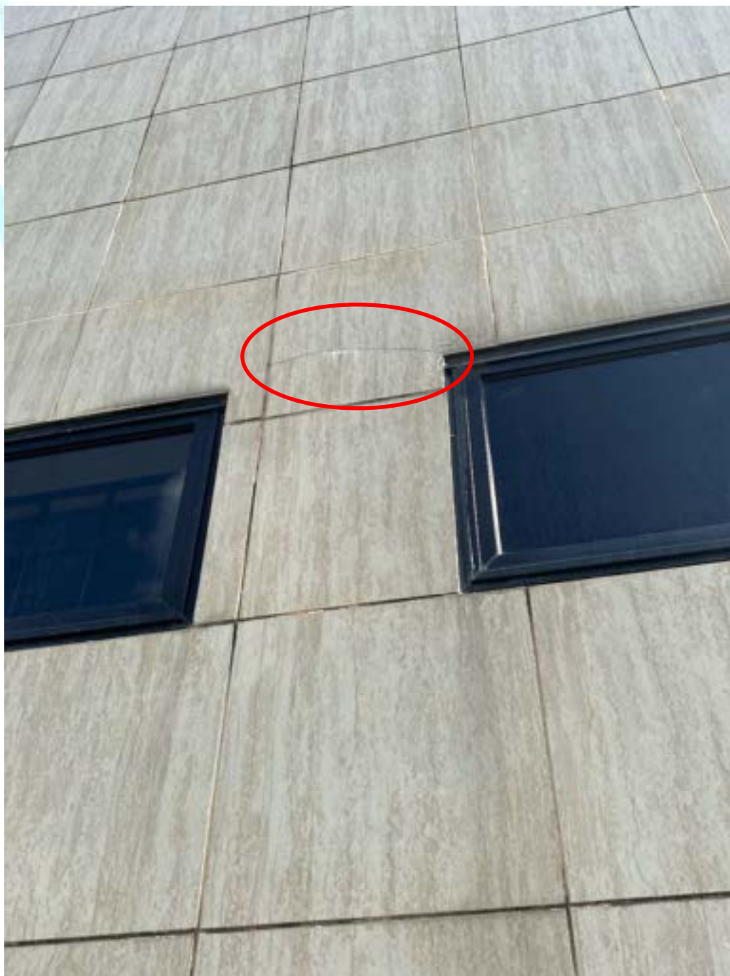
Figura 42 – Revestimento cerâmico com trinca na quina superior da janela e rejunte indicando sujidades e eflorescência
