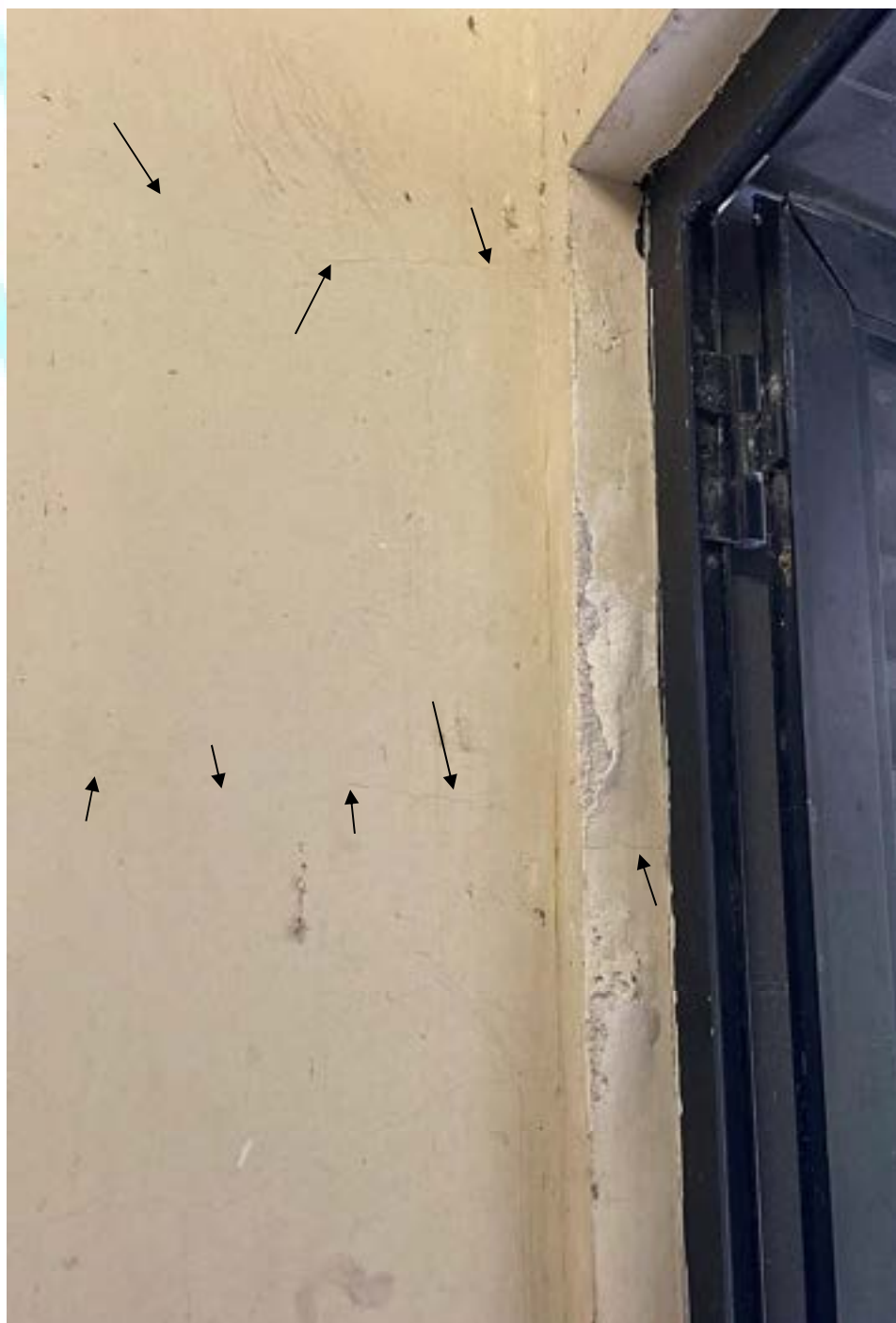
Figura 78 – Fissuras na parede e afofamento e degradação na alvenaria do vão da porta
