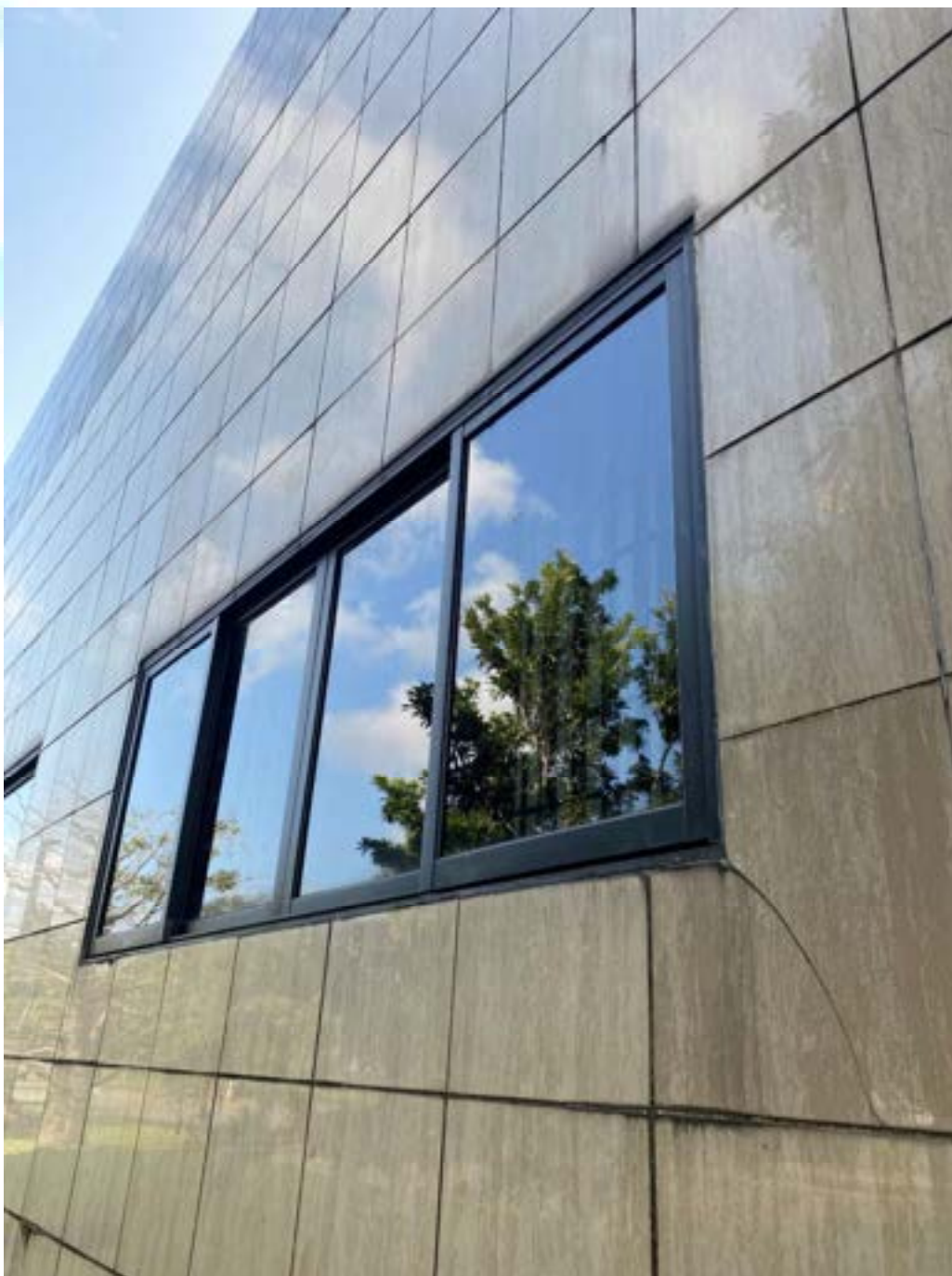
Figura 59 – Trinca na quina inferior da janela e sujeidades nos revestimentos
