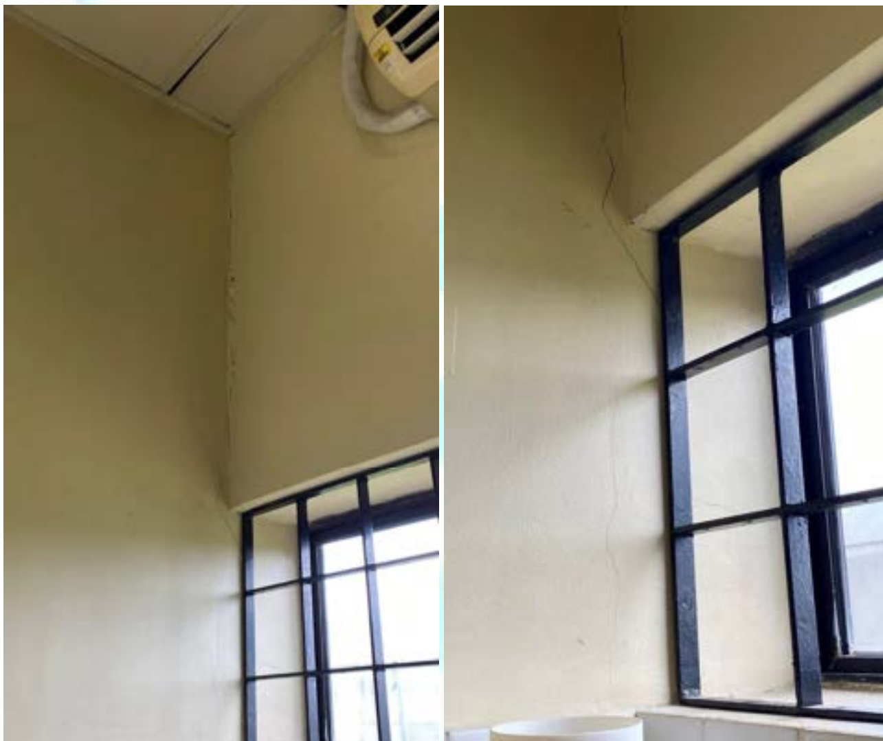
Figura 281 – Fissura no encontro das alvenarias e tampa do forro desencaixada
