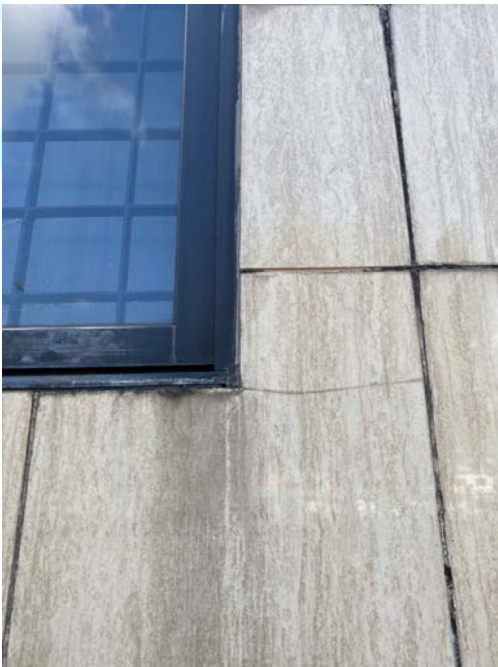
Figura 68 – Fissura na quina inferior da janela
