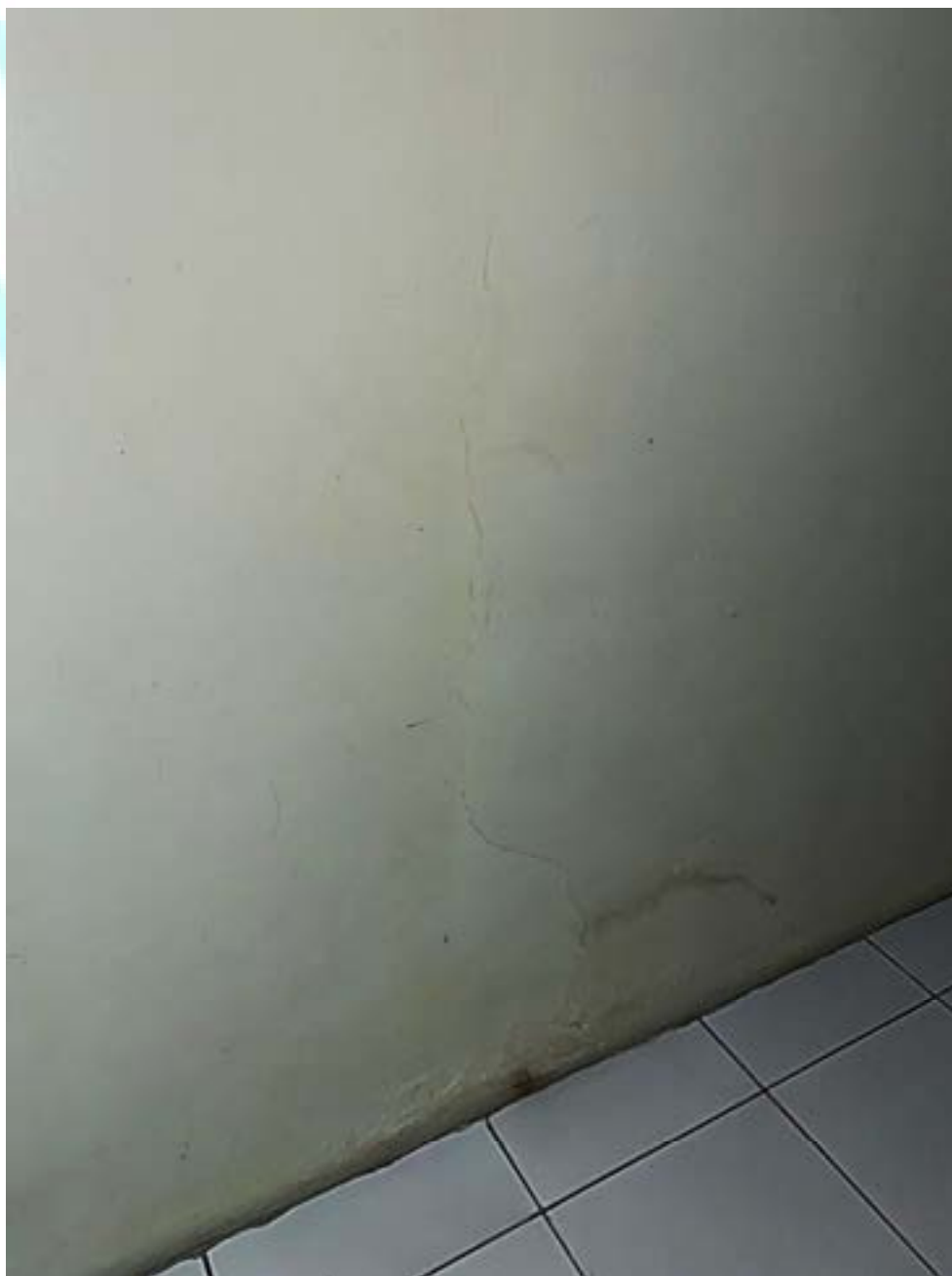
Figura 152 – Fissura longitudinal na parede
