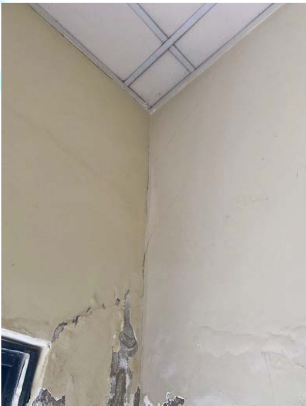
Figura 170 – Fissura no encontro das alvenarias
