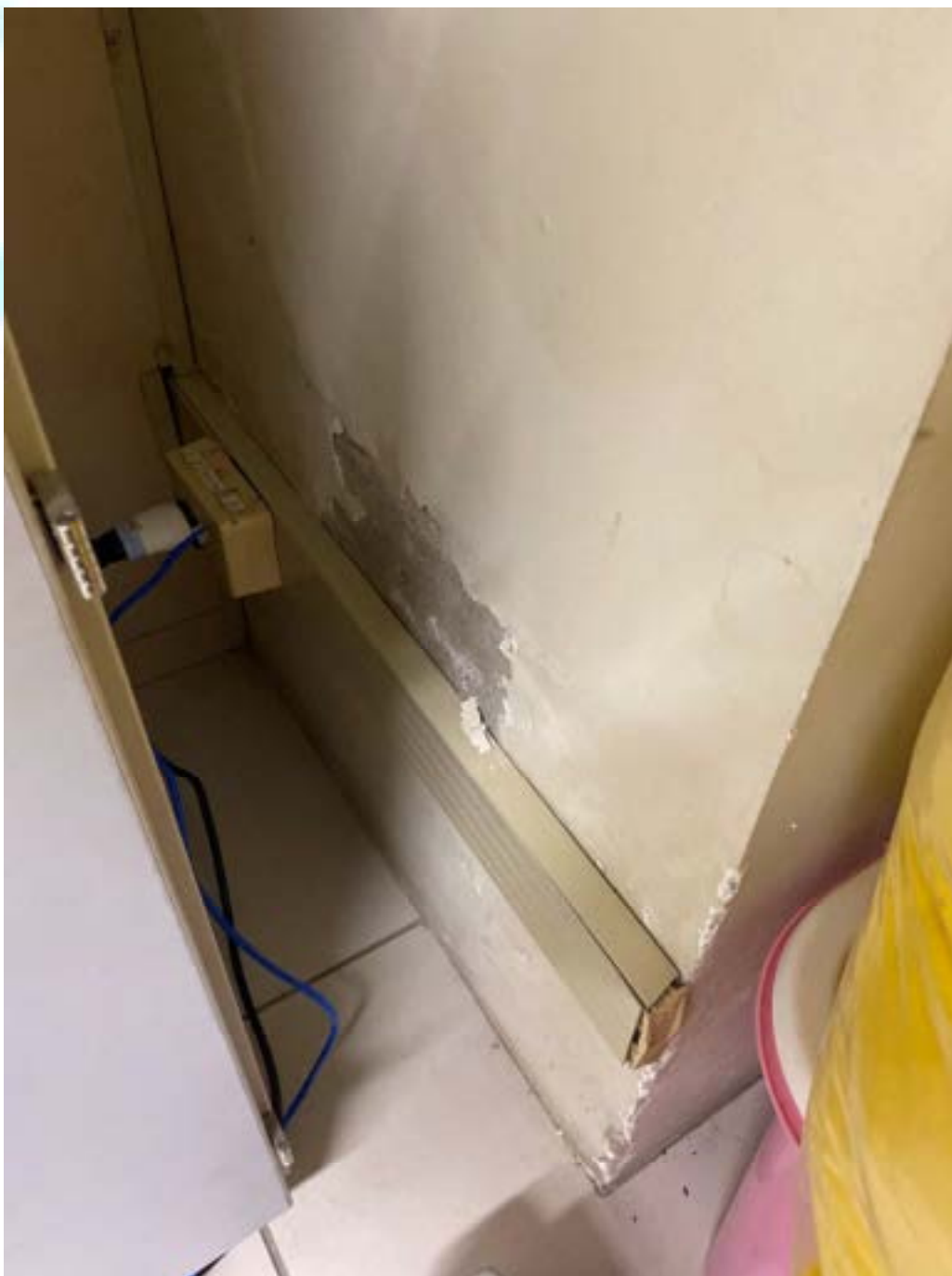
Figura 159 – Degradação na parede e deterioração na quina
