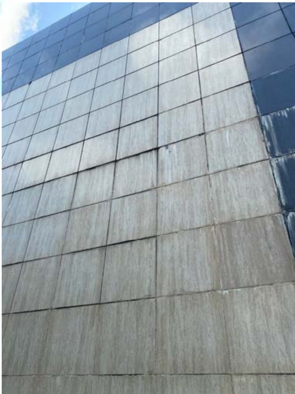
Figura 50 - Revestimento apresentando eflorescência, sujidades e trincas
