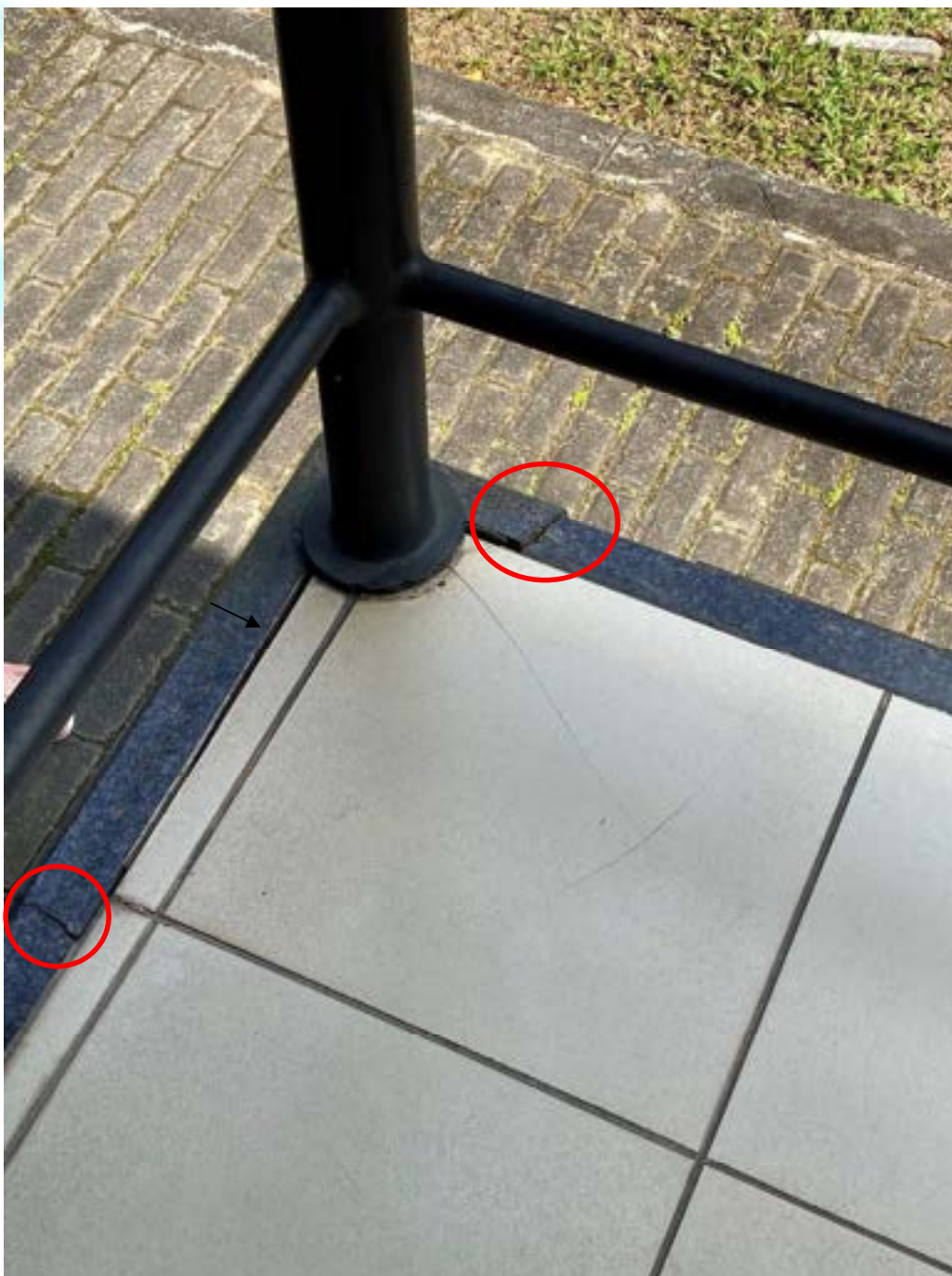
Figura 15 - Base do corrimão oxidada, fissura do revestimento do piso, deterioração do rejunte e trinca no granito da rampa
