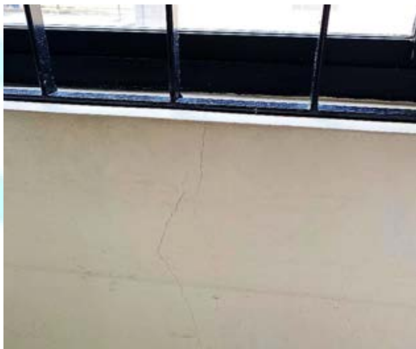
Figura 245 – Fissura no peitoril
