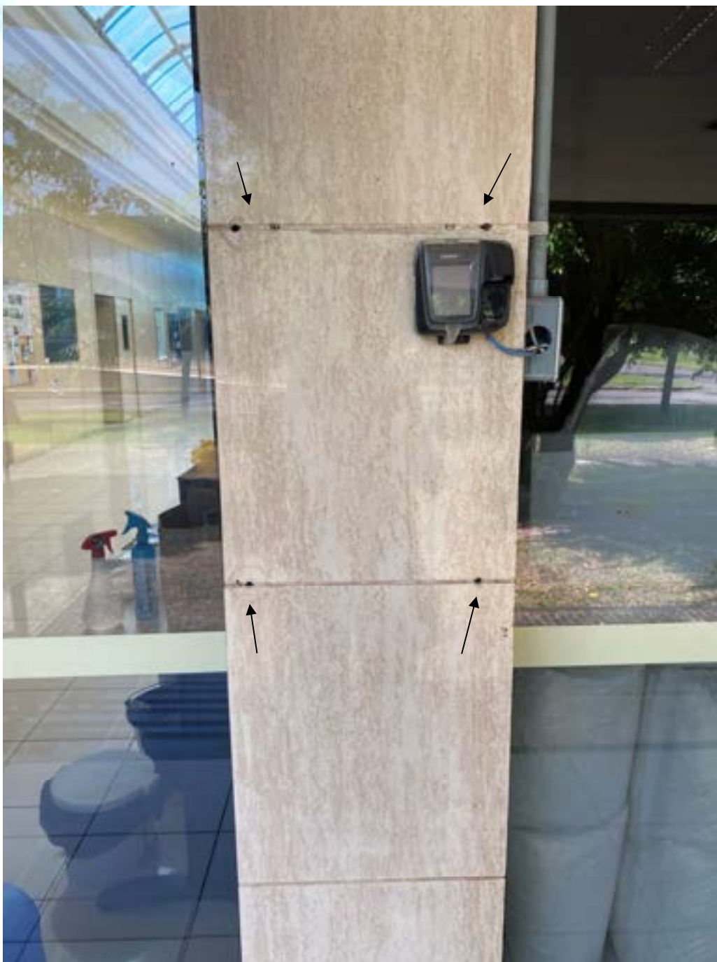
Figura 9 - Perfurações no rejunte do revestimento
