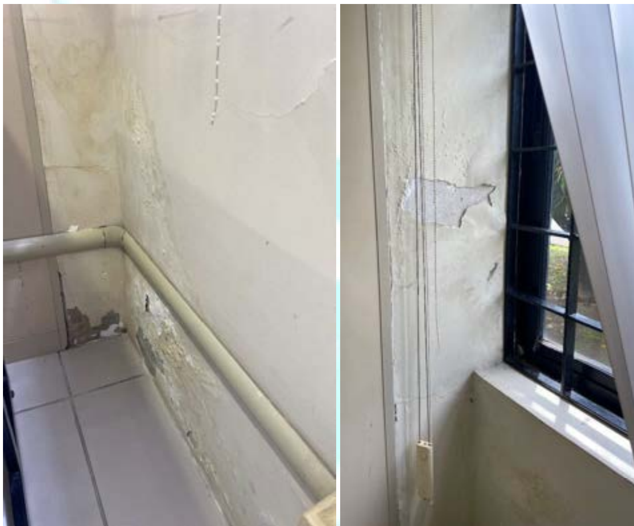
Figura 300 – Infiltração na parede
