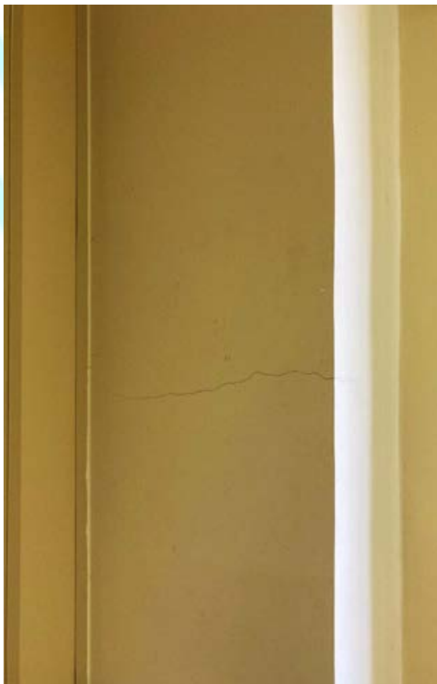
Figura 236 - Fissura no pilar
