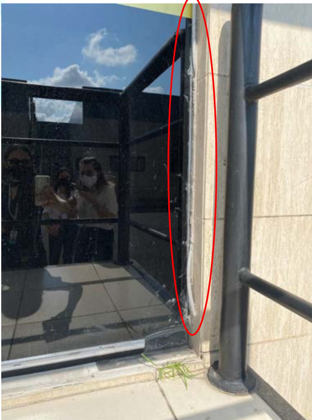
Figura 36 – Porta apresentando silicone lateral gasto
