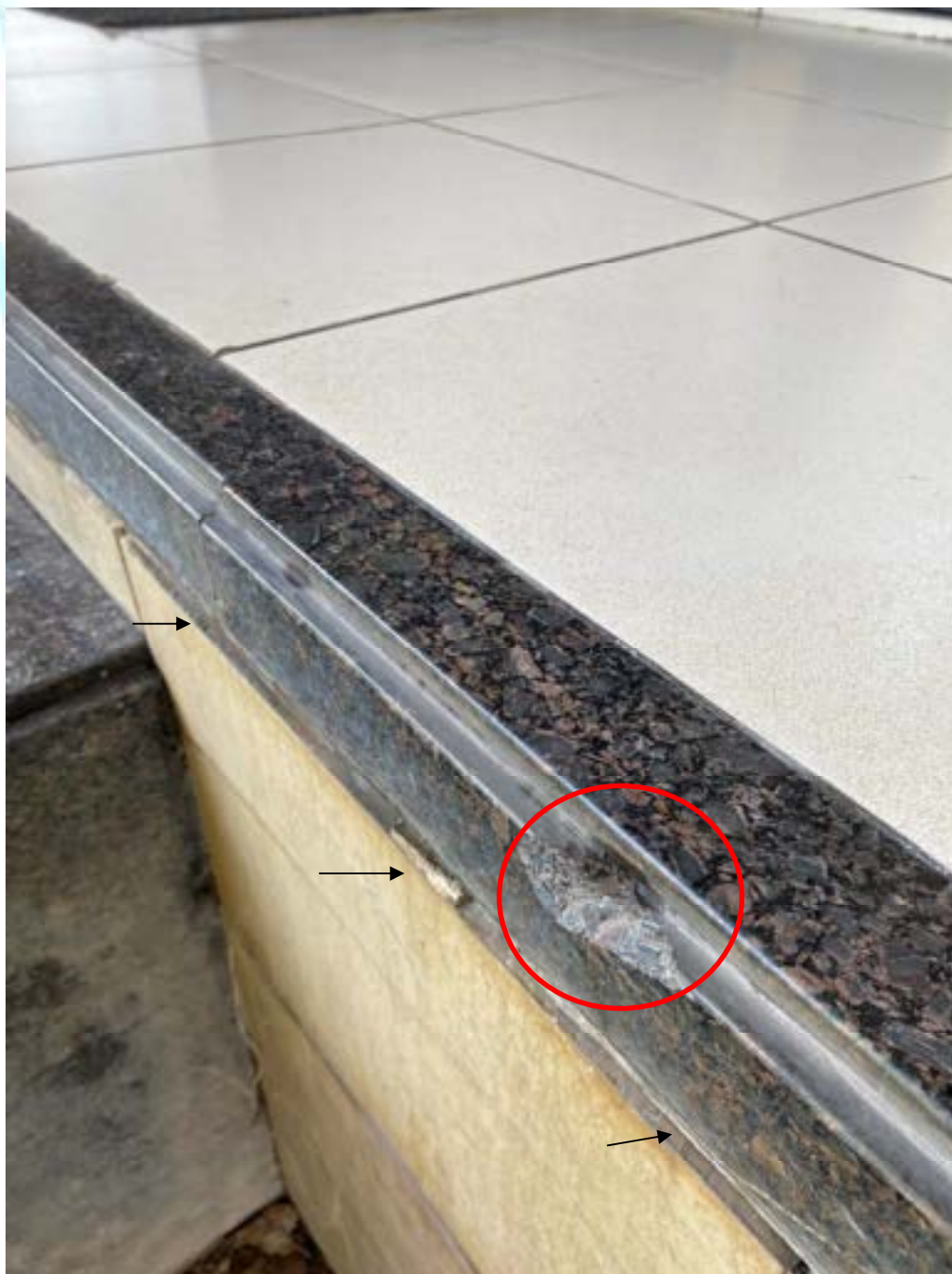
Figura 19 – Quebra na quina do acabamento em granito e deterioração do rejunte
