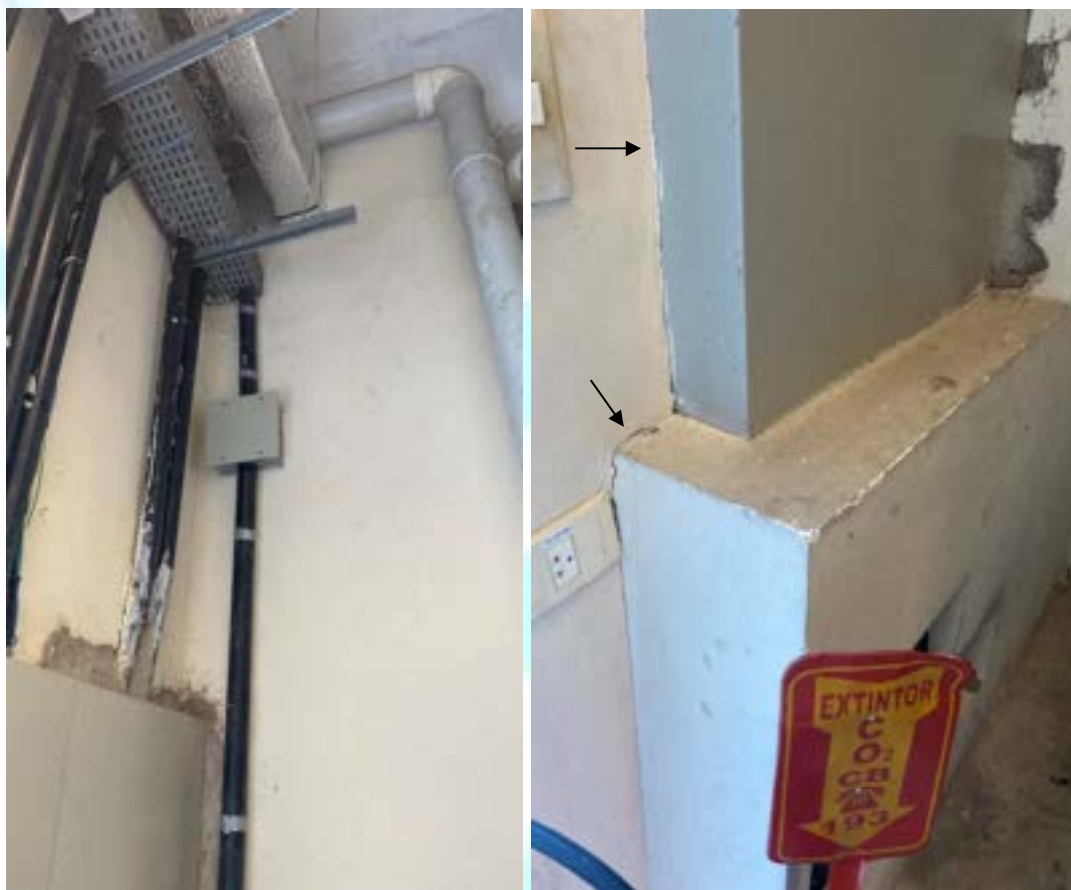
Figura 292 – Fissura e sujidades na parede
