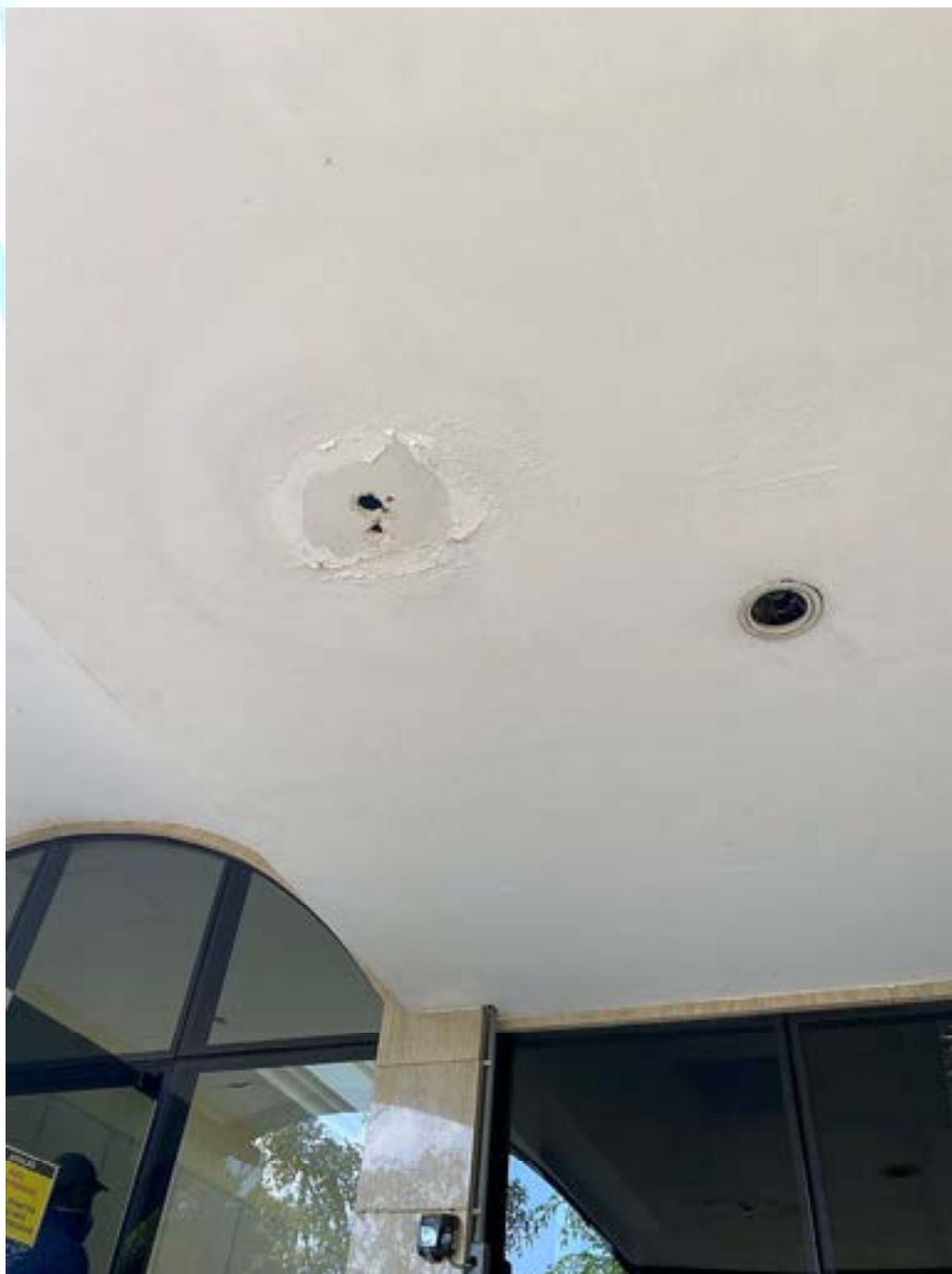
Figura 107 – Infiltração no forro de gesso da marquise
