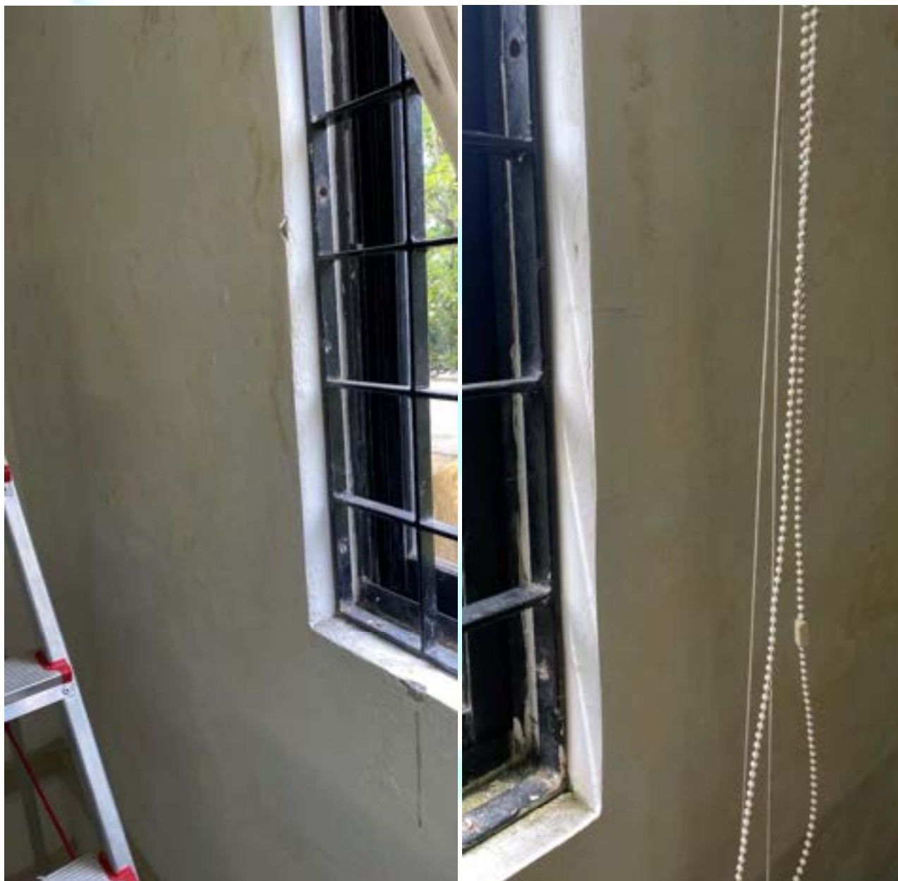
Figura 287 - Infiltração na parede
