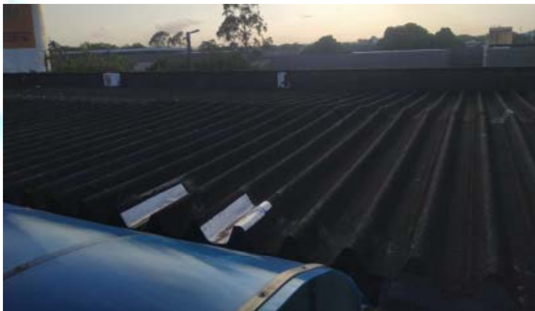
Figura 87 - Área da coberta com telhado em telha tipo Kalhetão
