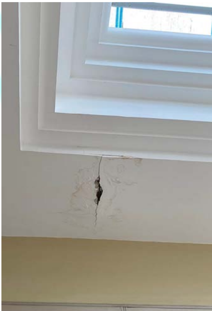
Figura 126 – Infiltração no forro de gesso
