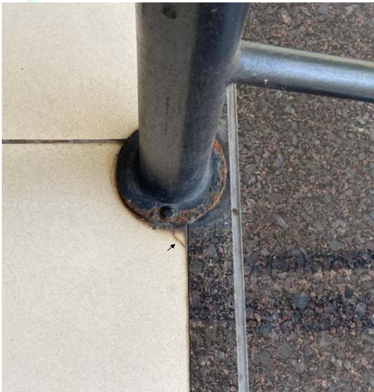
Figura 12 – Base do corrimão oxidada e quebra na quina do revestimento
