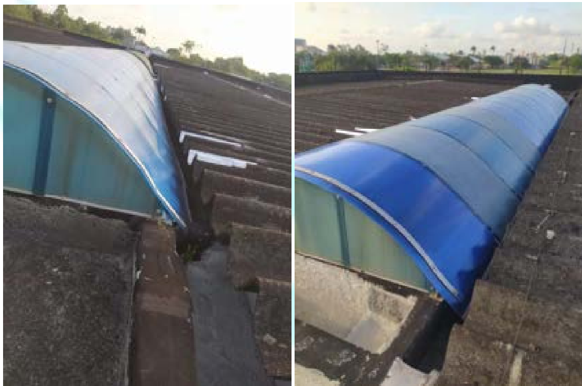
Figura 88 - Área da cobertura com telhado em telha tipo Kalhetão e Policarbonato
