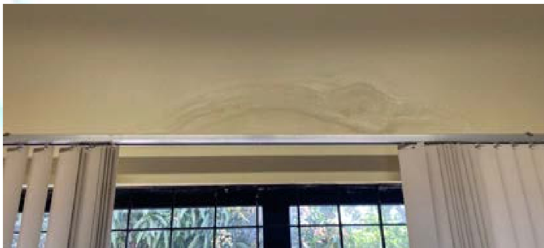
Figura 296 – Afofamento e umidade na parede
