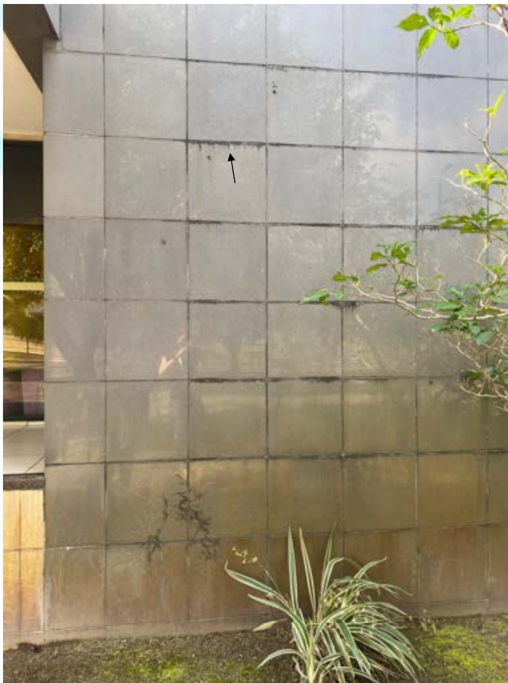
Figura 2 – Pontos de sujidades e eflorescência no revestimento
