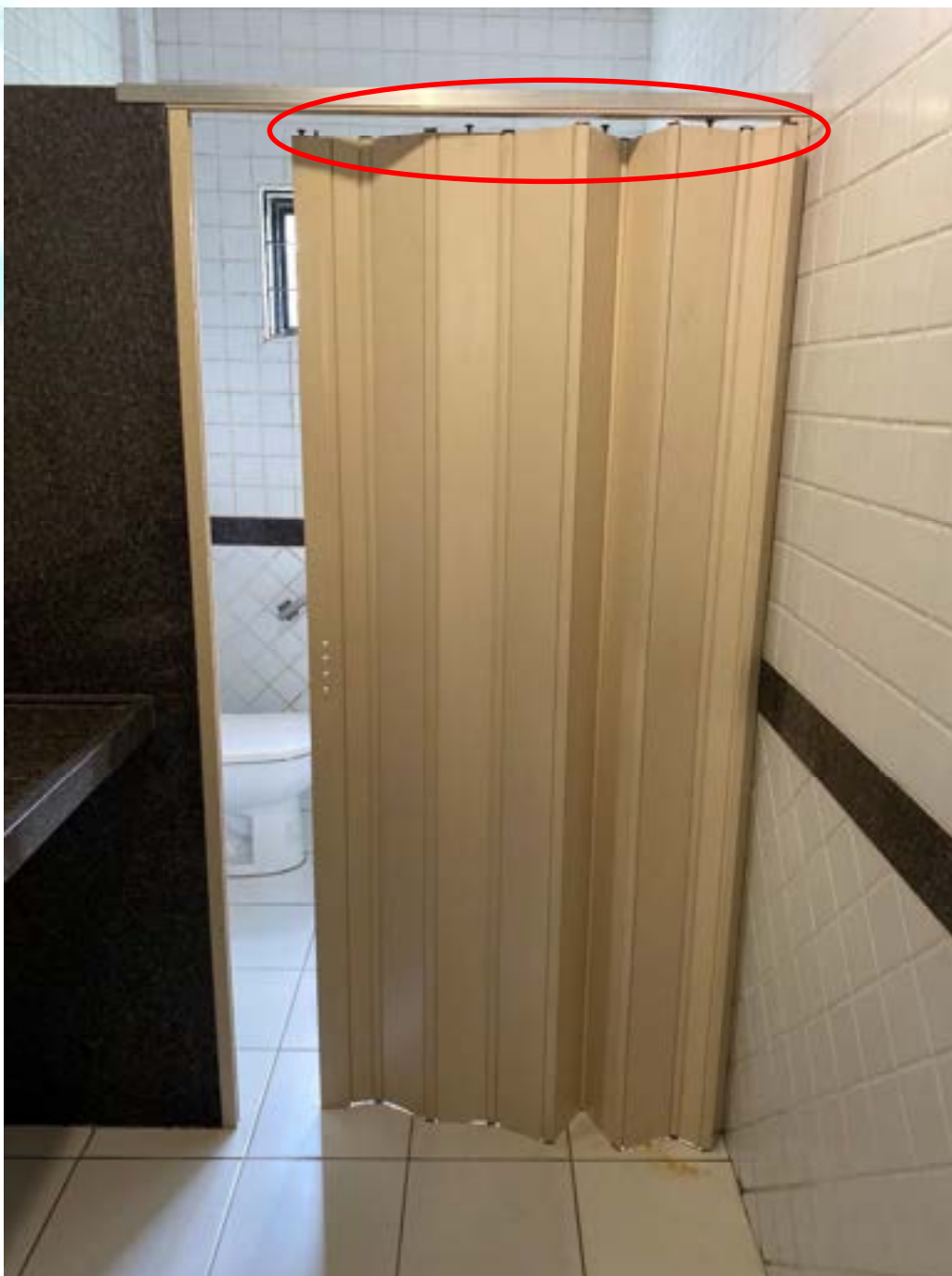
Figura 178 – Porta necessitando de substituição e revestimentos do piso danificados no banheiro feminino
