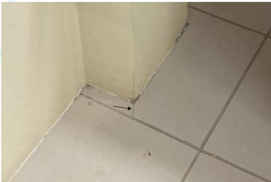
Figura 272 – Revestimento do piso fissurado
