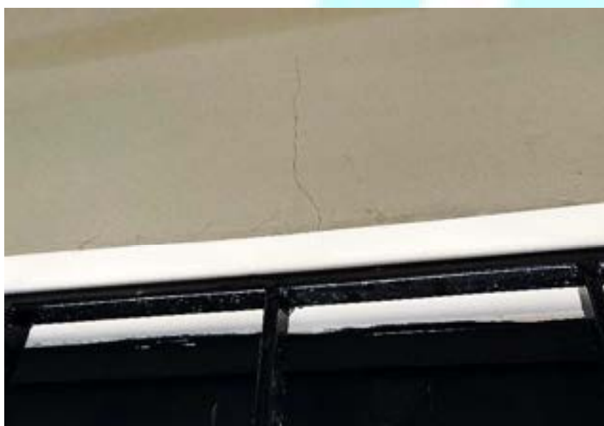
Figura 246 – Fissura na parede
