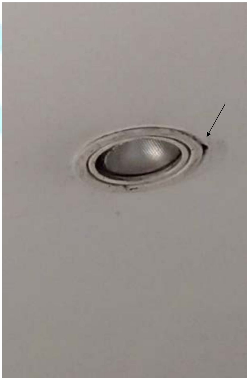
Figura 113 – Deterioração do forro de gesso circundante a luminária
