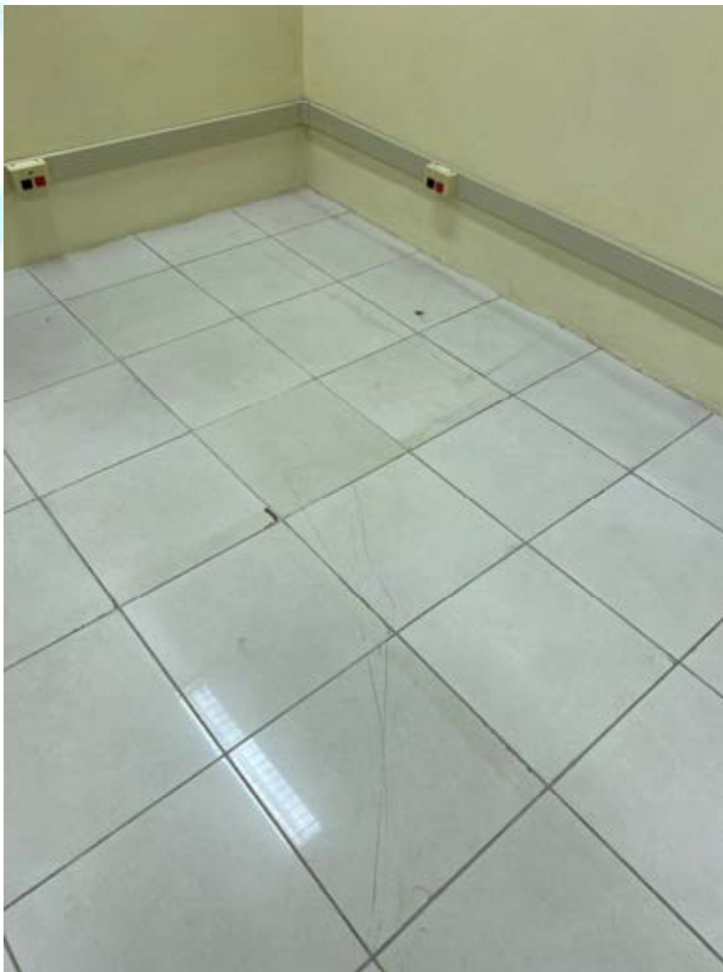
Figura 147 – Revestimentos do piso danificados na sala do hall posterior direito
