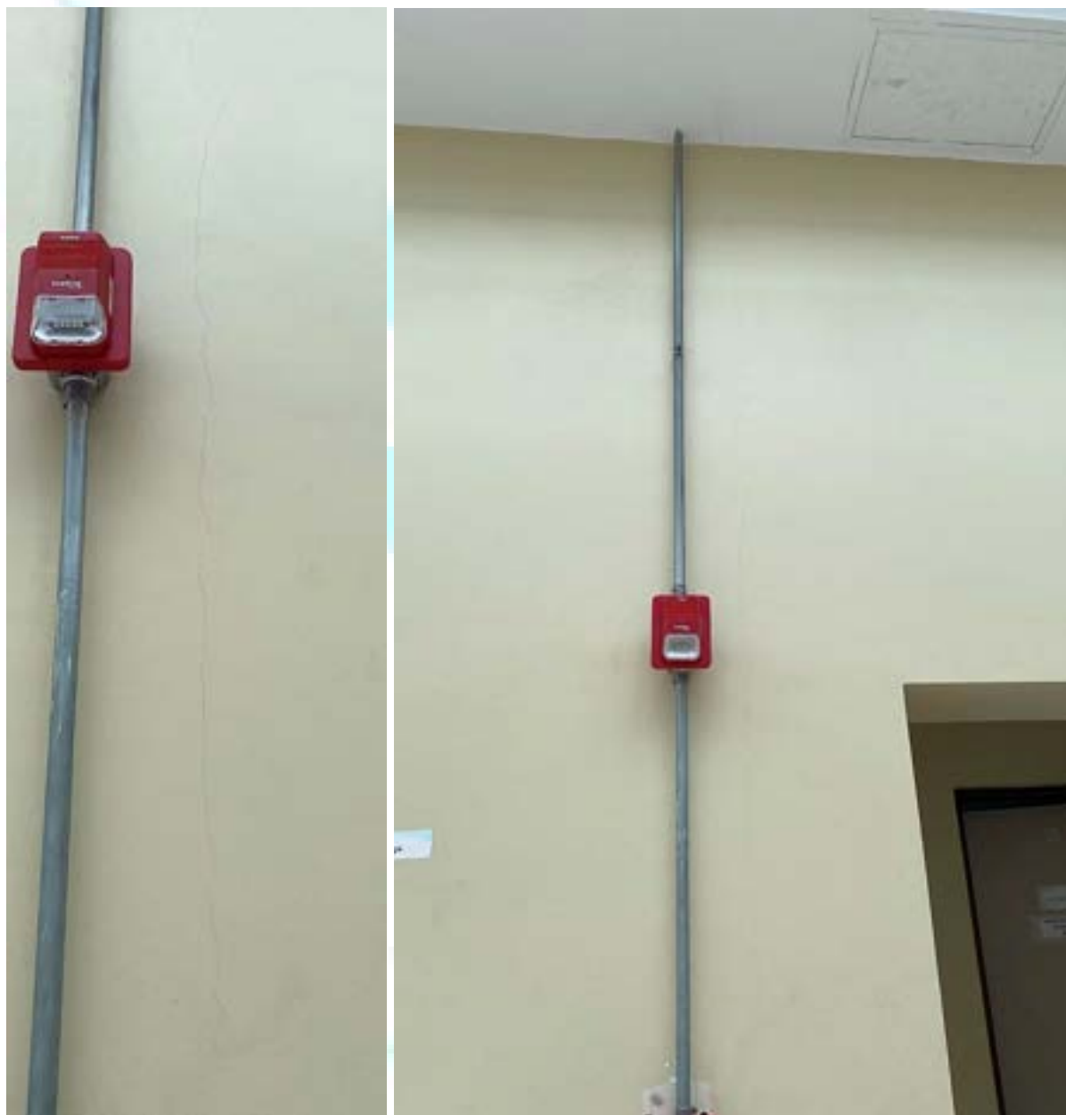
Figura 132 – Fissura longitudinal na parede
