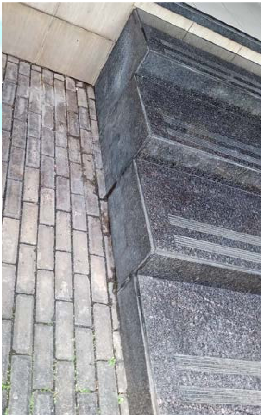
Figura 23 – Escada apresentando ausência de rejunte
