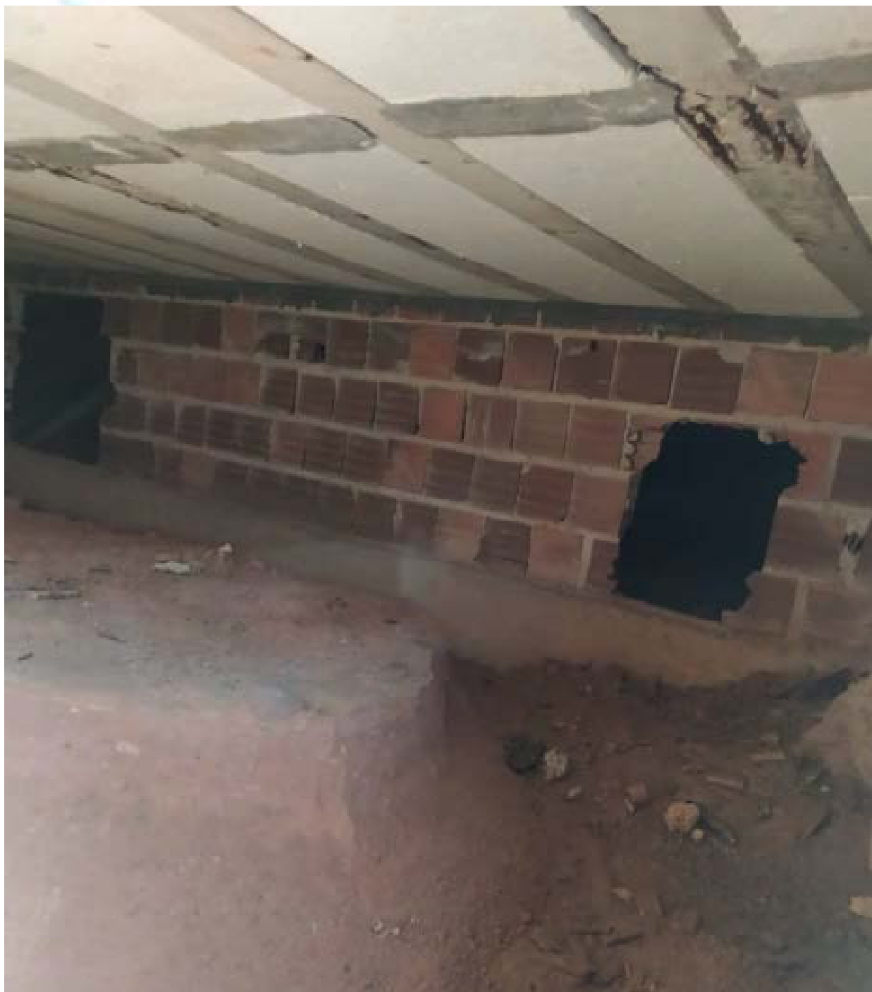
Figura 122 - Área da fundação – Pontos de oxidação
