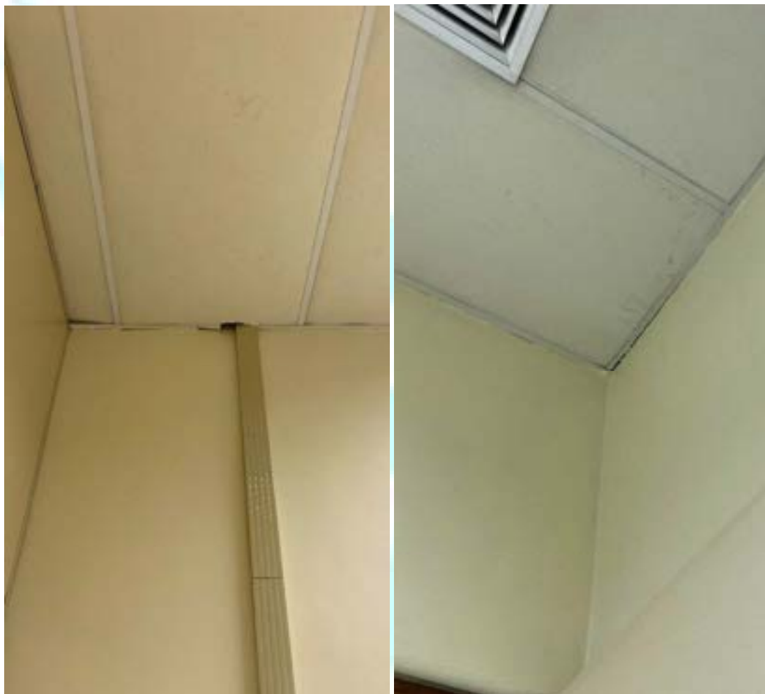
Figura 264 – Sujidades no forro e degradação do perfil de sustentação de placas de forro
