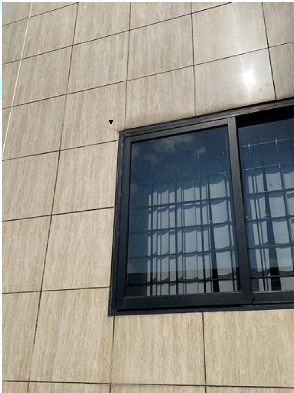
Figura 28 – Revestimento apresentando trinca na quina superior da janela e sujidades nos rejuntas
