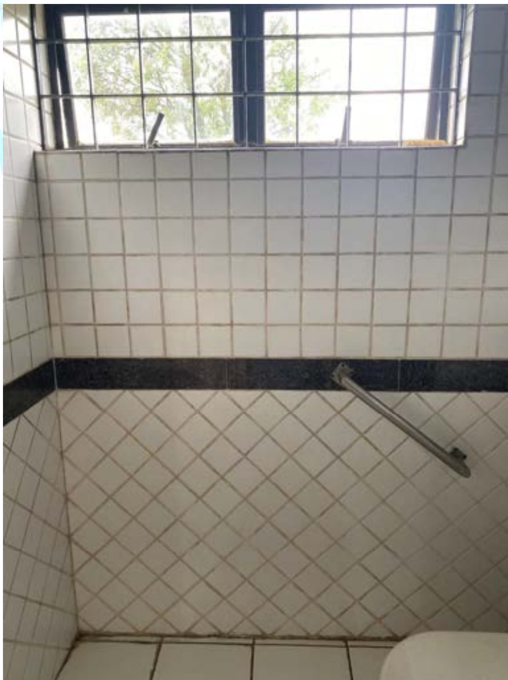
Figura 183 - Sujidades nos rejuntos da parede no banheiro masculino
