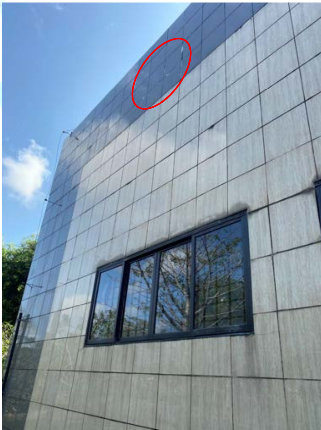
Figura 66 – Revestimento apresentando eflorescência, sujidades e trincas
