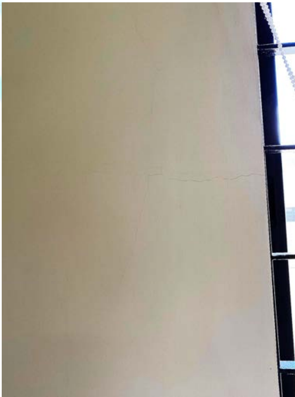
Figura 242 – Fissura na parede
