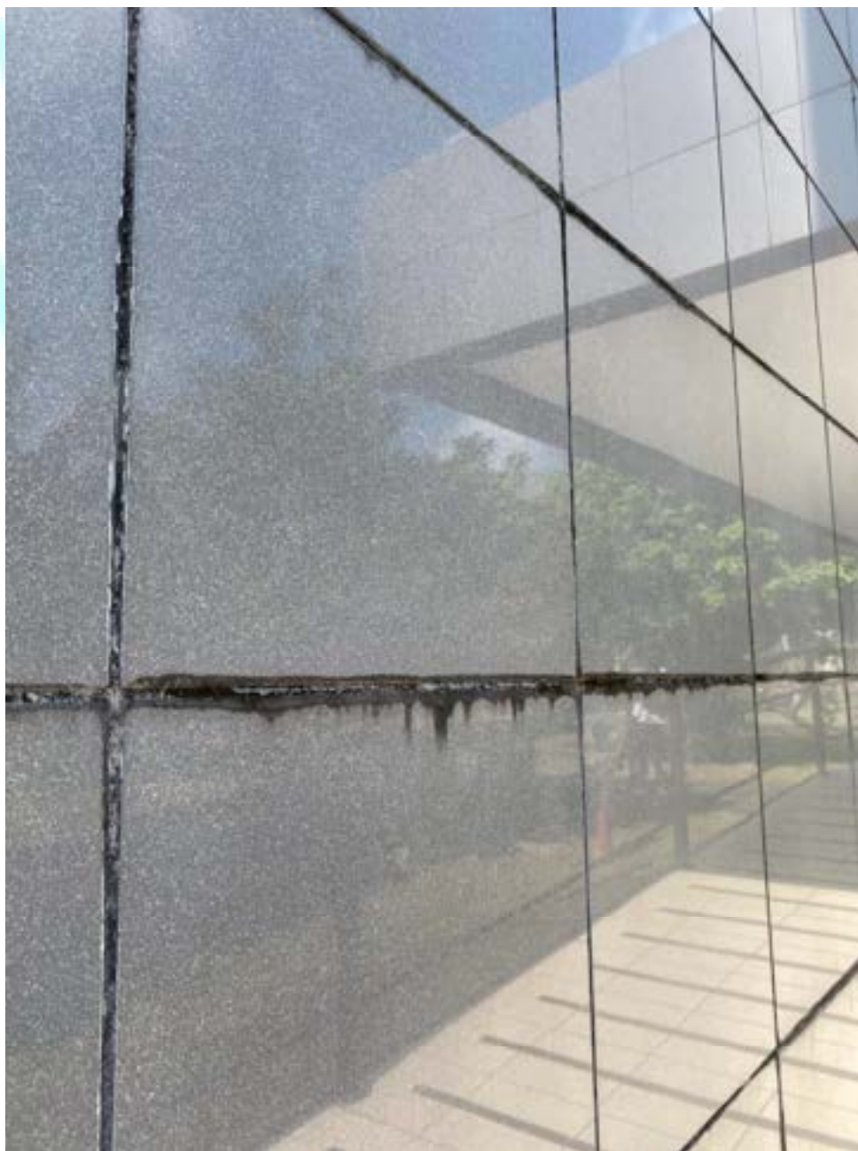
Figura 6 – Pontos de sujidades e eflorescência no revestimento
