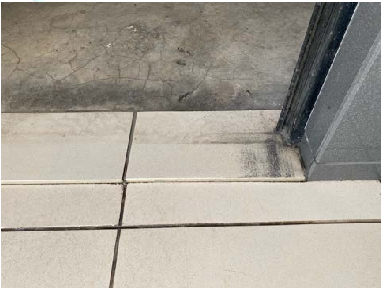
Figura 83 – Deterioração do rejunte e sujeidade no revestimento
