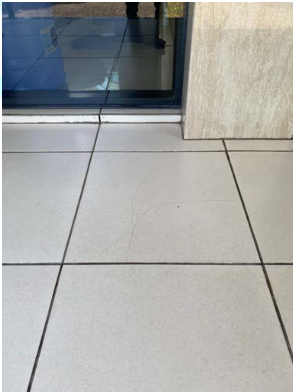
Figura 11 – Fissuras no revestimento do piso
