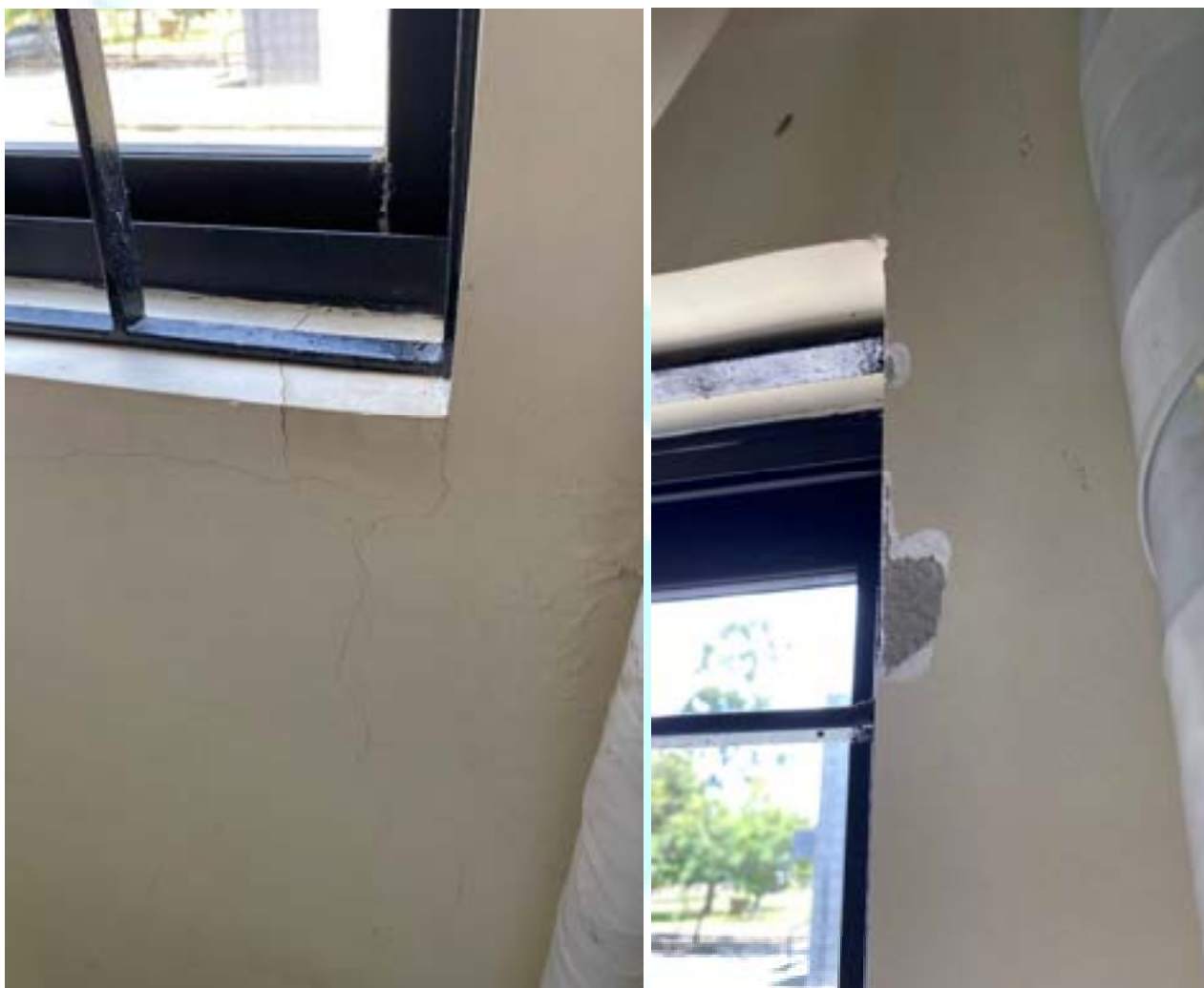
Figura 243 – Descamação e degradação na parede
