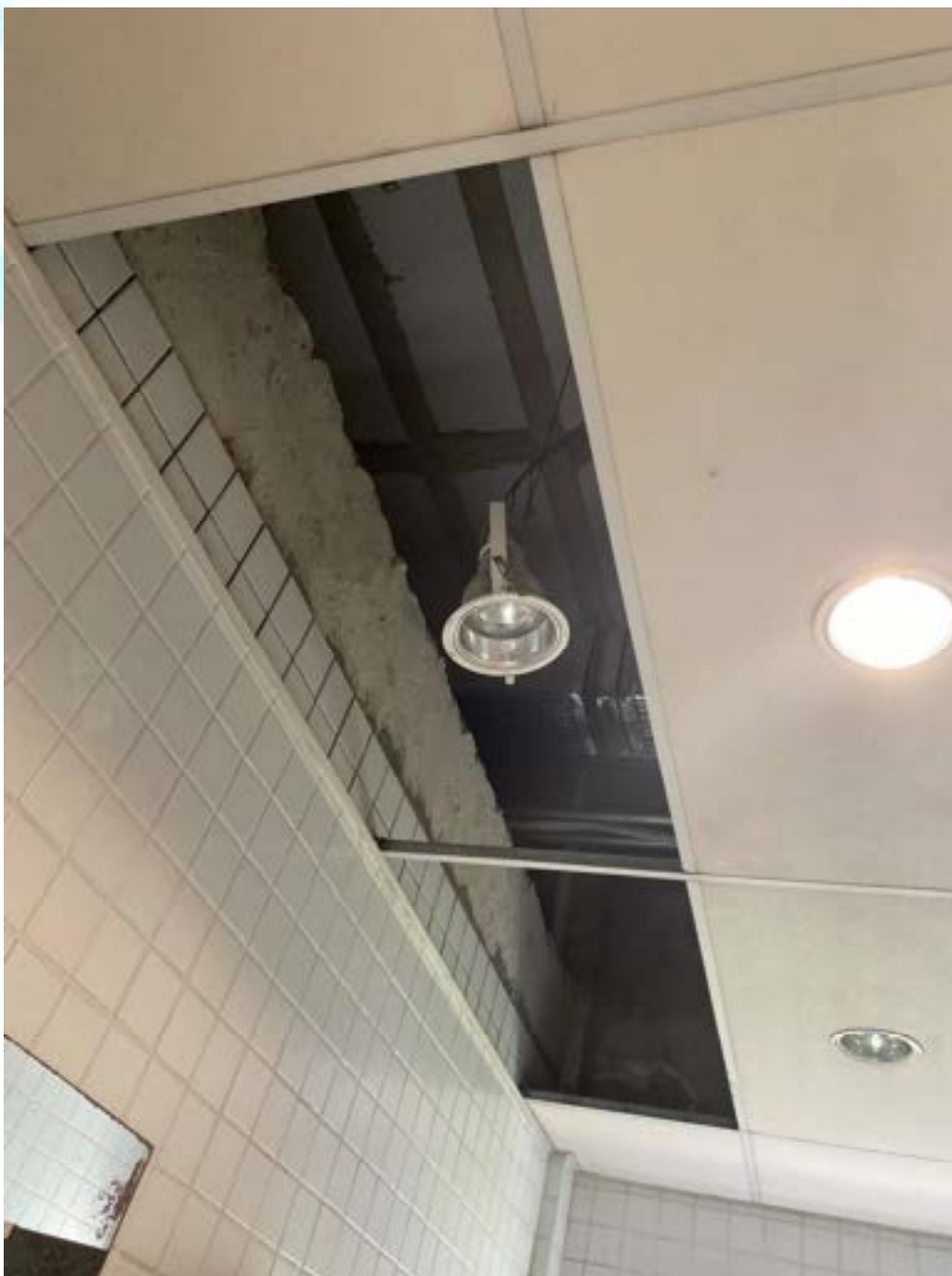
Figura 175 – Ausência das tampas do forro no banheiro Feminino
