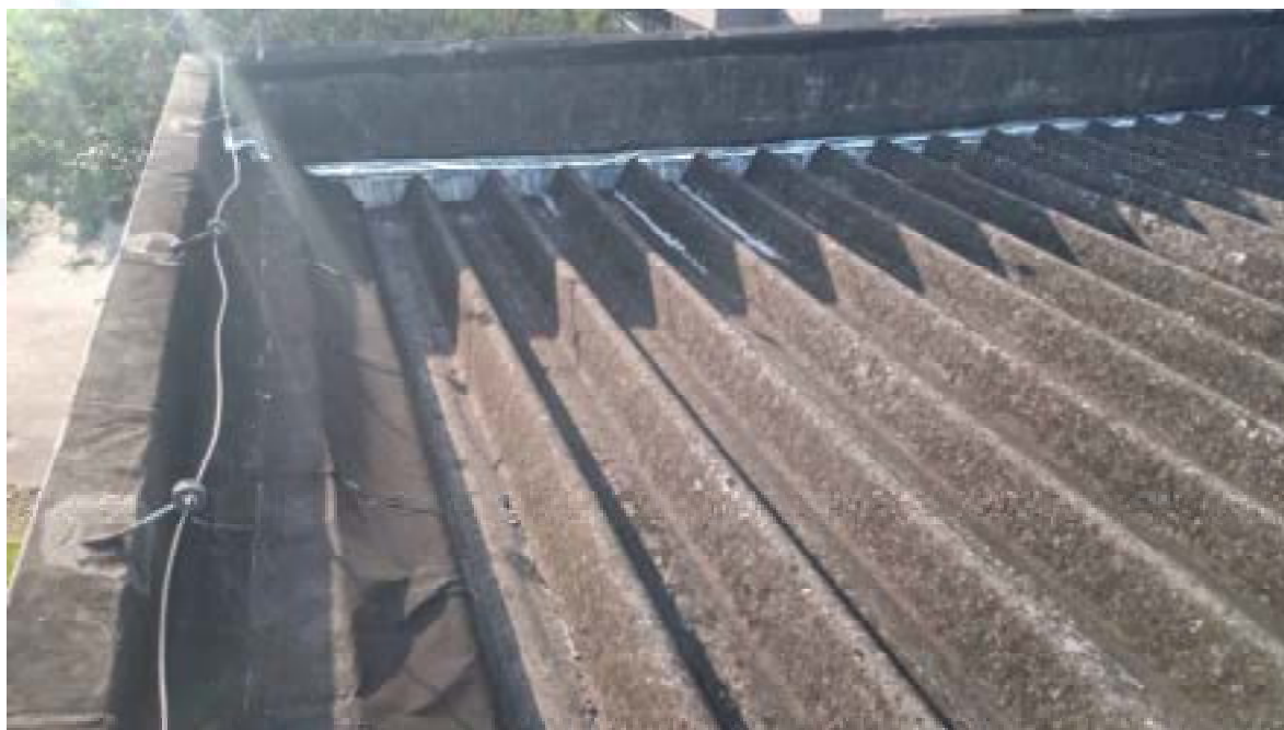
Figura 85 - Área da cobertura com telhado em telha tipo Kalhetão
