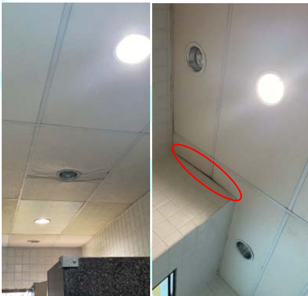
Figura 186 – Forro danificado no banheiro feminino
