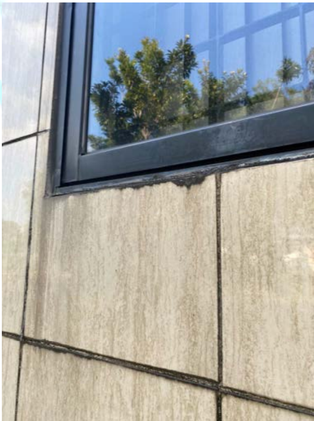
Figura 60 – Revestimento apresentando eflorescência e sujidades
