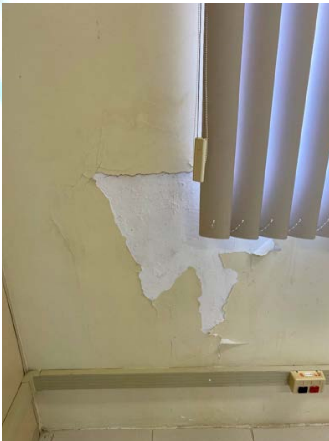
Figura 261 – Descamação na parede da sala 08A
