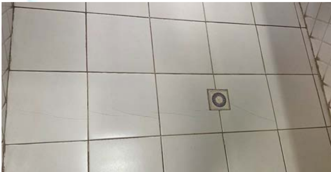
Figura 181 – Revestimentos do piso danificados no banheiro masculino
