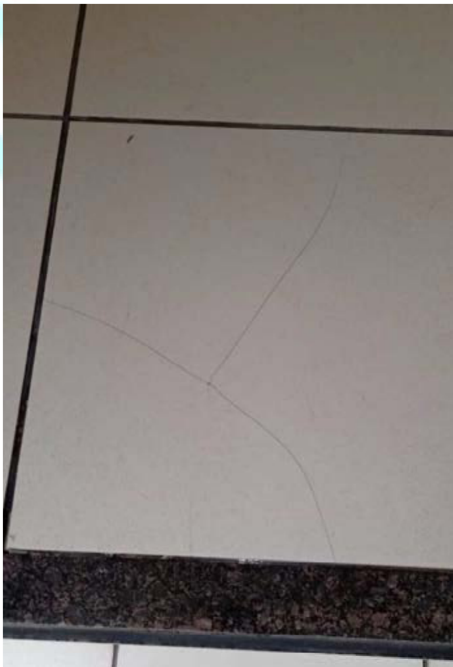
Figura 14 – Fissura no revestimento do piso
