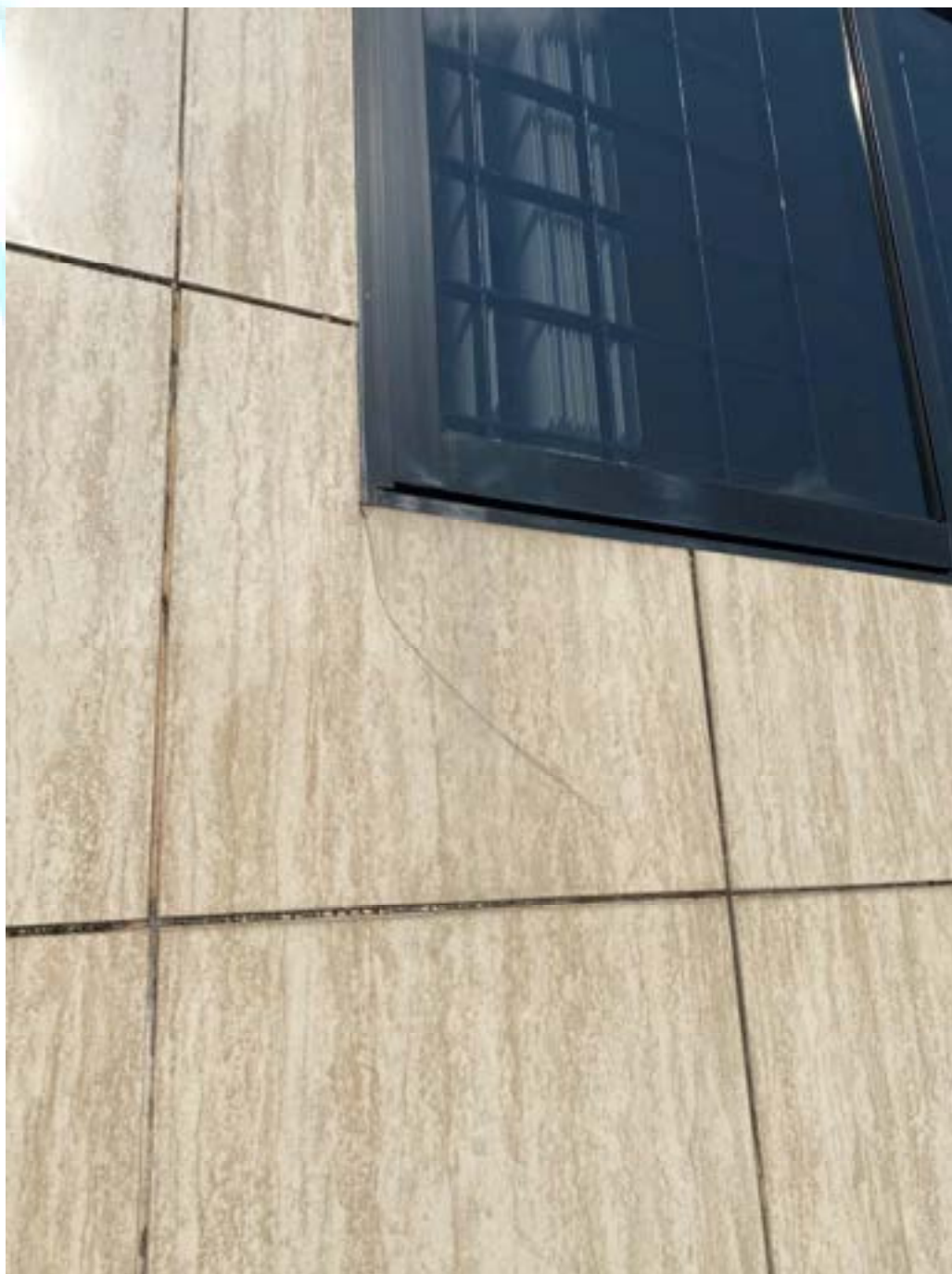
Figura 32 - Trinca no revestimento, eflorescência e deterioração do rejunte
