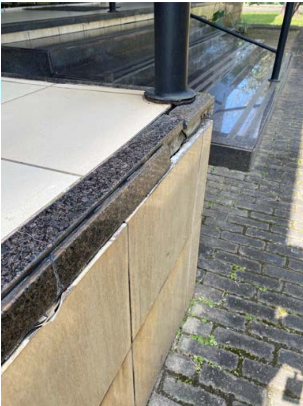
Figura 22 - Pedras de granito e cerâmica quebradas na margem da rampa
