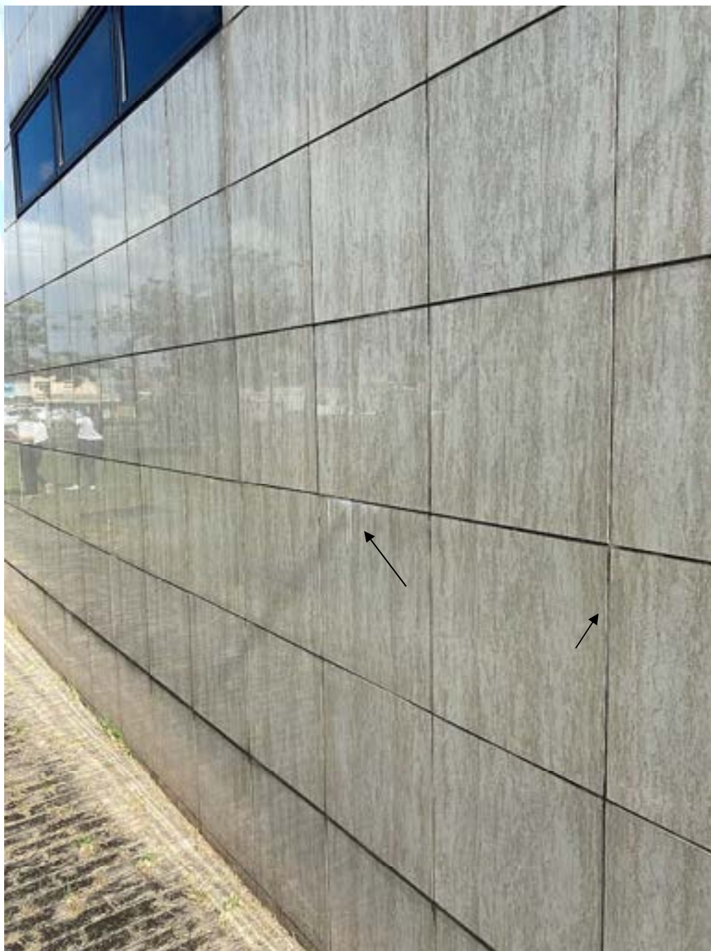
Figura 41 – Pontos de sujidades e eflorescência no revestimento
