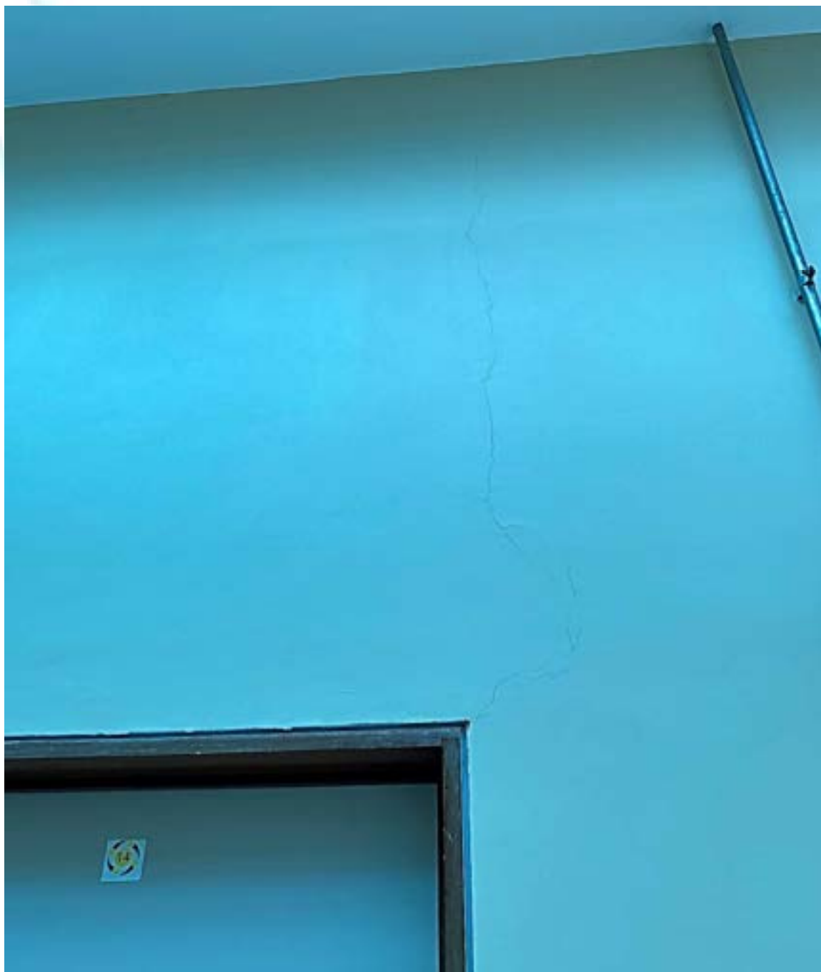
Figura 130 – Fissura longitudinal na parede
