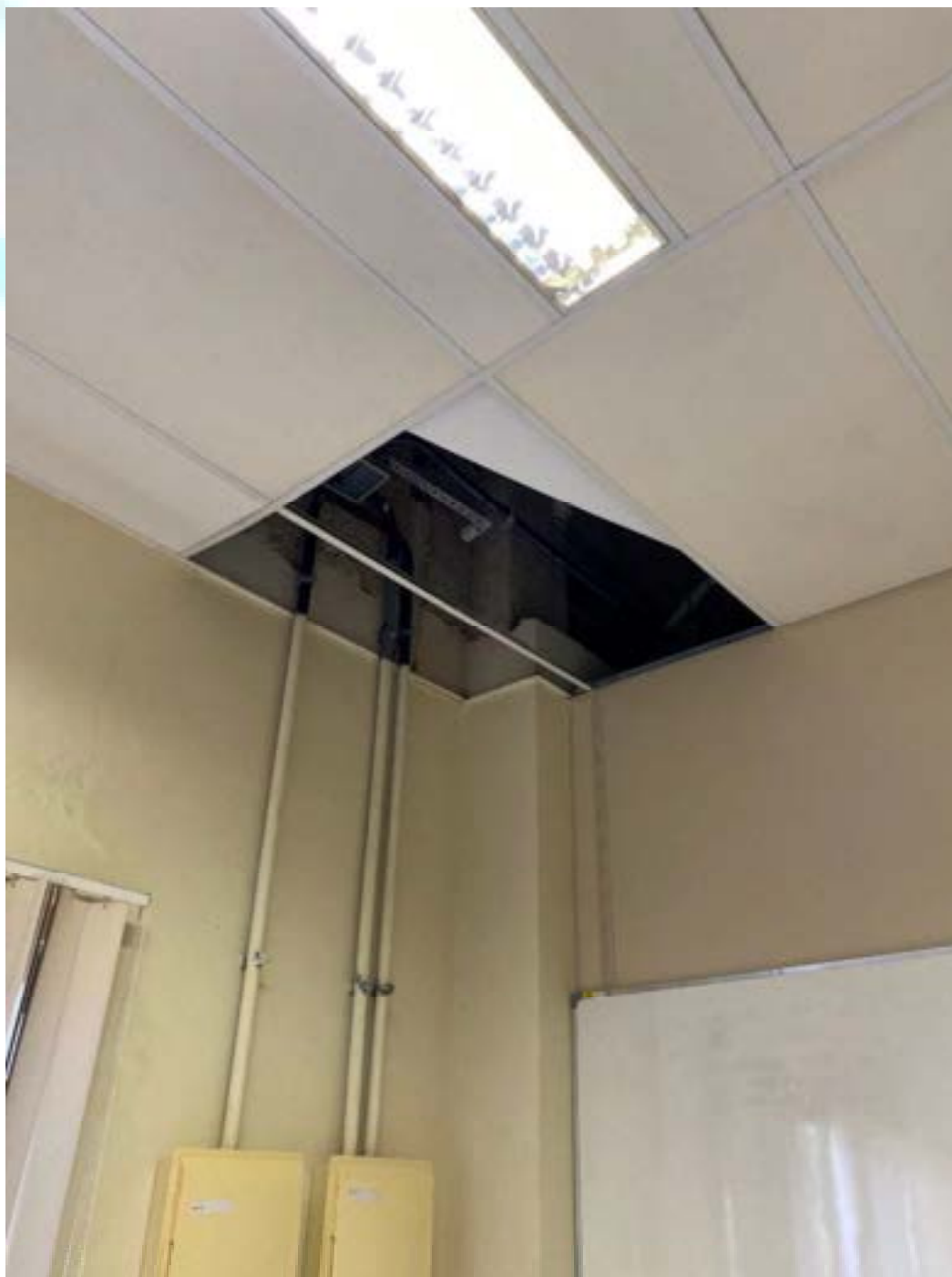
Figura 225 – Ausência da tampa do forro da sala 03E
