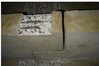
Figura 02: Exemplo de delimitação no concreto
