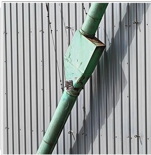
2.5. Nas atividades rotineiras de armazenagem de grãos tem-se as operações de transbordo, na qual é realizada a remoção de grãos dos fundos das células de armazenagem por meio de dutos e conexões. Esse processo é abrasivo e gerou furos nos dutos e suas conexões. Os vazamentos nos dutos geram perdas dos grãos e prejudicam a segurança dos operadores, que normalmente ficam próximo ao caminhão, na parte inferior dos dutos de transbordo.
