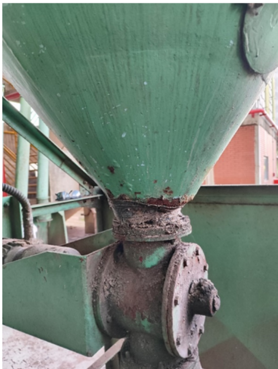
Fig. 6. Desgaste do funil de coleta de material particulado, com avançado grau de oxidação, causando derramamento do pó coletado nos ciclones.
