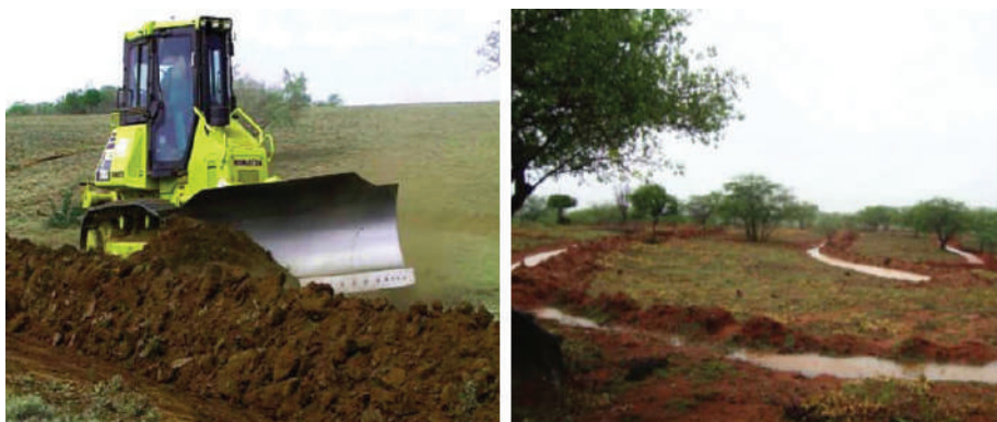
Figuras 31 e 32 – Construção de terraços e áreas terraceadas 21
