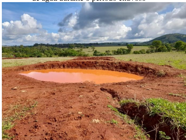
Figura 7 – Exemplo de barraginha com armazenamento de água durante o período chuvoso
