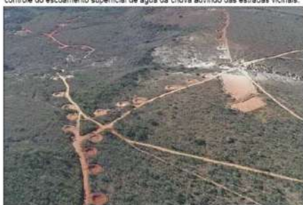
Figura 1: Área de recarga com intervenções técnicas (barraginhas) voltadas ao controle do escoamento superficial de água da chuva advindo das estradas vicinais.
