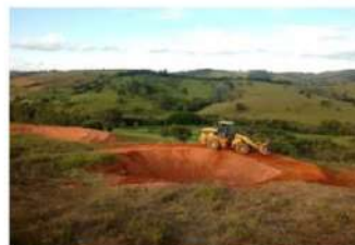
Fig. 2 – Construção de Barraginha - Município de Itaguara/ Sub-bacia Córrego Catuá (fonte: Codevasf, 2017).
