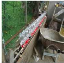
Foto 2. Construção utilizando garrafas pet
