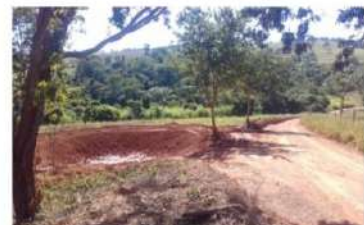
Fig. 3 – Readequação de estrada rural não pavimentada associada a uma barraginha – Município de São José da Varginha/Sub-bacia Cana o Reino (fonte: Codevasf, 2017)
